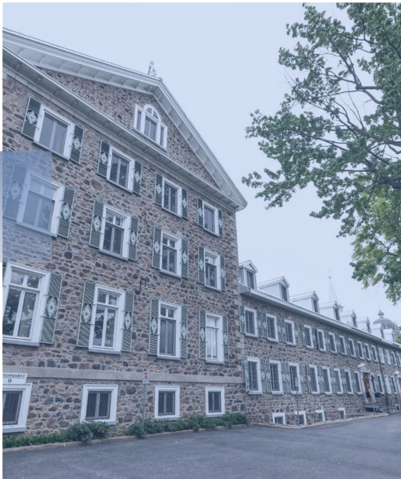
Maison des sœurs de Jésus Marie au Vieux-Longueuil Image tirée de Dostie, 2021 (Courrier du Sud)
