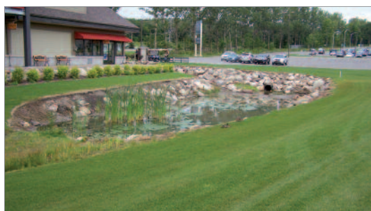
Figure 45 : Bassin dans un secteur commercial et institutionnel.
