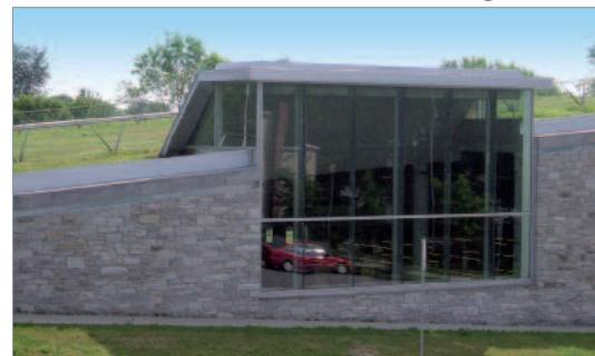
Figure 28 : Toiture de la bibliothèque de Charlesbourg, Québec.
