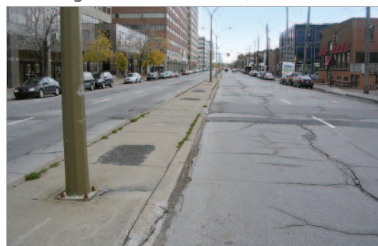
Figure 74 : Rue Chabanel, avant les travaux.
