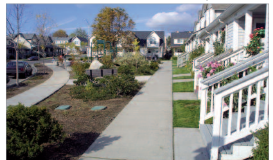
Figure 49 : Gouttières raccordées à une plate-bande.
