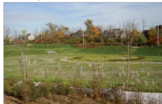
Figure 14-F : Bassin de rétention du Boisé.
