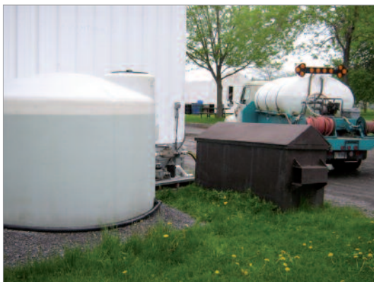
Figure 16-B : Récupération par camion-citerne.
