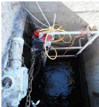
Figure 3.11 : Installation de la sonde de mesure du pH dans le regard d'effluent de la station de Sainte-Julie
