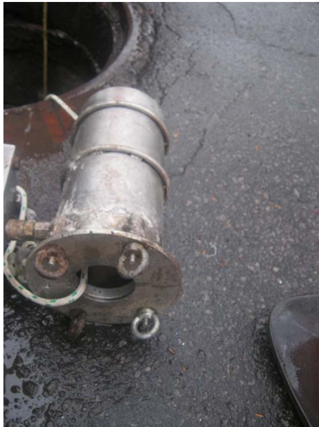
Figure 21 – Exemple d'obturateur utilisé à chacune des extrémités de la gaine
