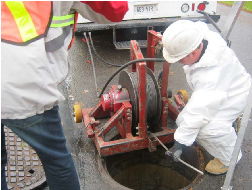
Figure 20 – Treuil utilisé pour tirer la gaine
