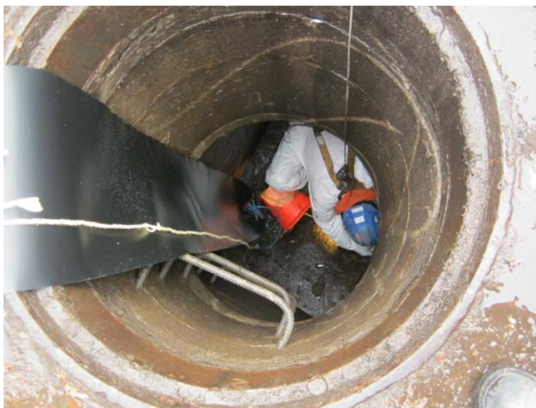
Figure 16 – Mise en place du polythène d'insertion
