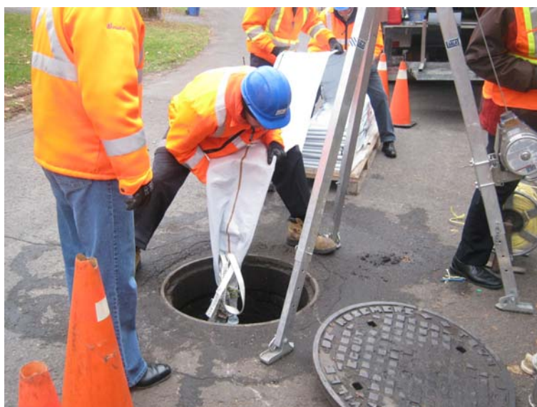
Figure 19 – Insertion de la gaine dans la conduite à réhabiliter
