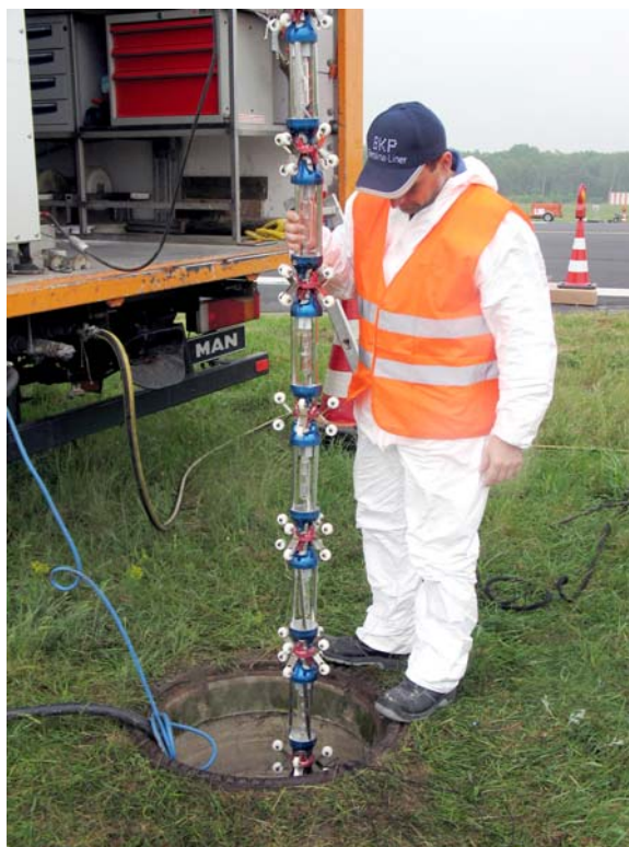
Figure 27 – Insertion du train de lumières UV (Source : BKP Berolina)
