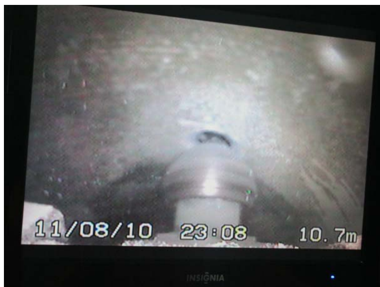
Figure 30 – Ouverture d'un raccordement à l'aide du robot (image tirée de la vidéo effectuée lors des travaux)
