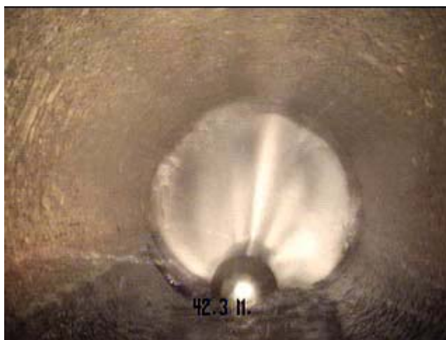
Figure 9 – Nettoyage de la section de conduite
