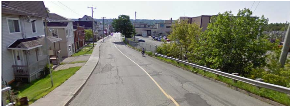
Figure 3 – Site des travaux, rue Principale Est, Magog
