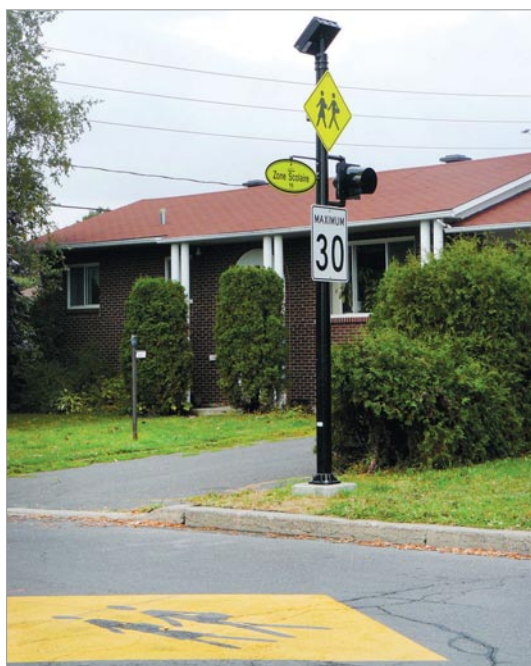
Figure 5-C : Marquage au sol et gendarme actif.
