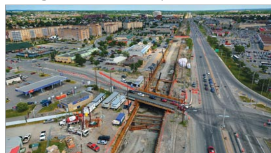
Figure 11-A : Voie de Rapibus en construction.
