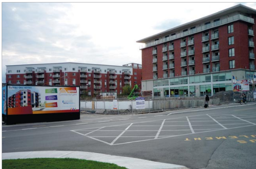
Figure 10-E : Logements en construction.
