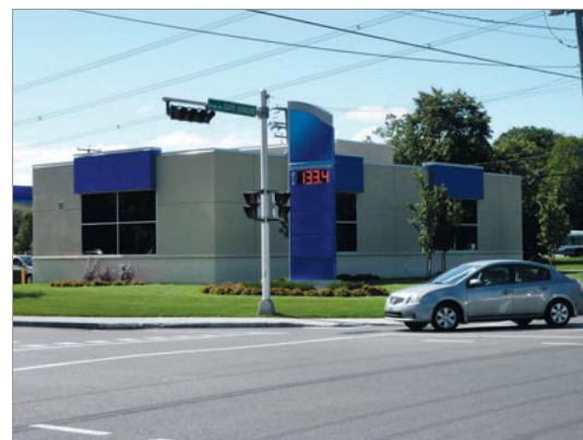
Figure 158 : Absence d'entrée sur la rue.
