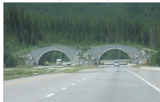
Figure 55 : Passage aérien, Alberta.
