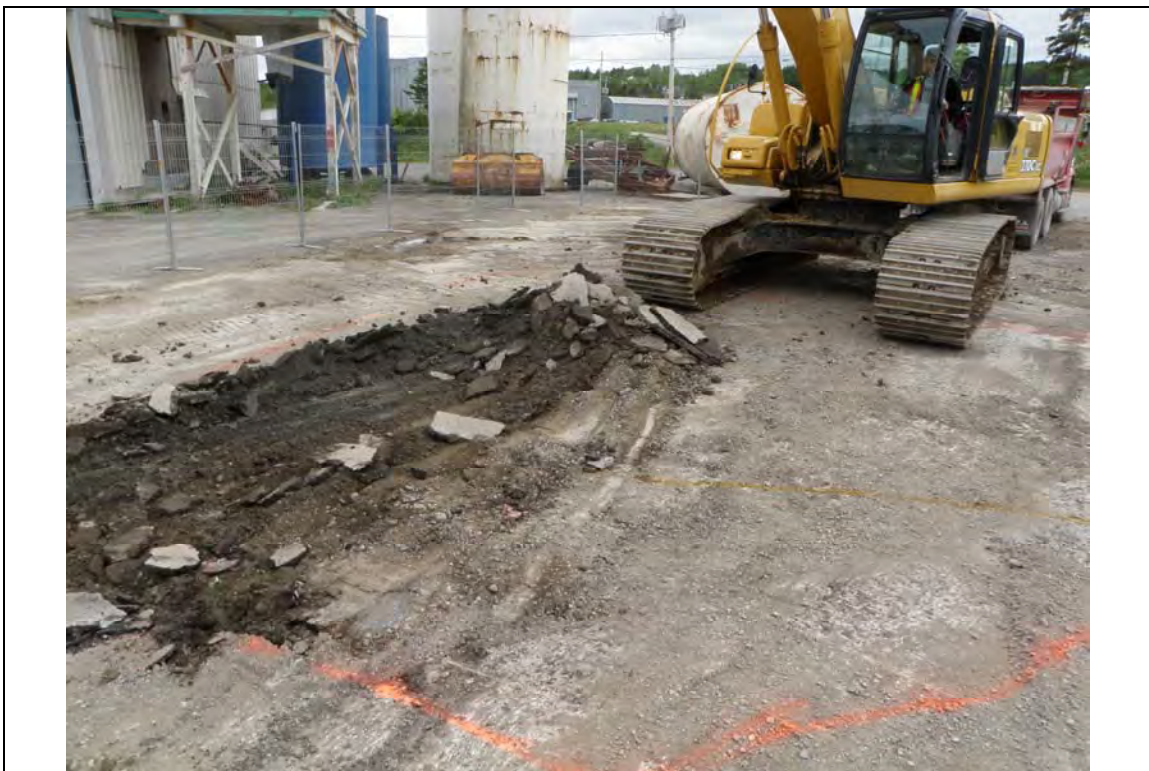
Photo No 2 – Enlèvement de l'asphalte.
