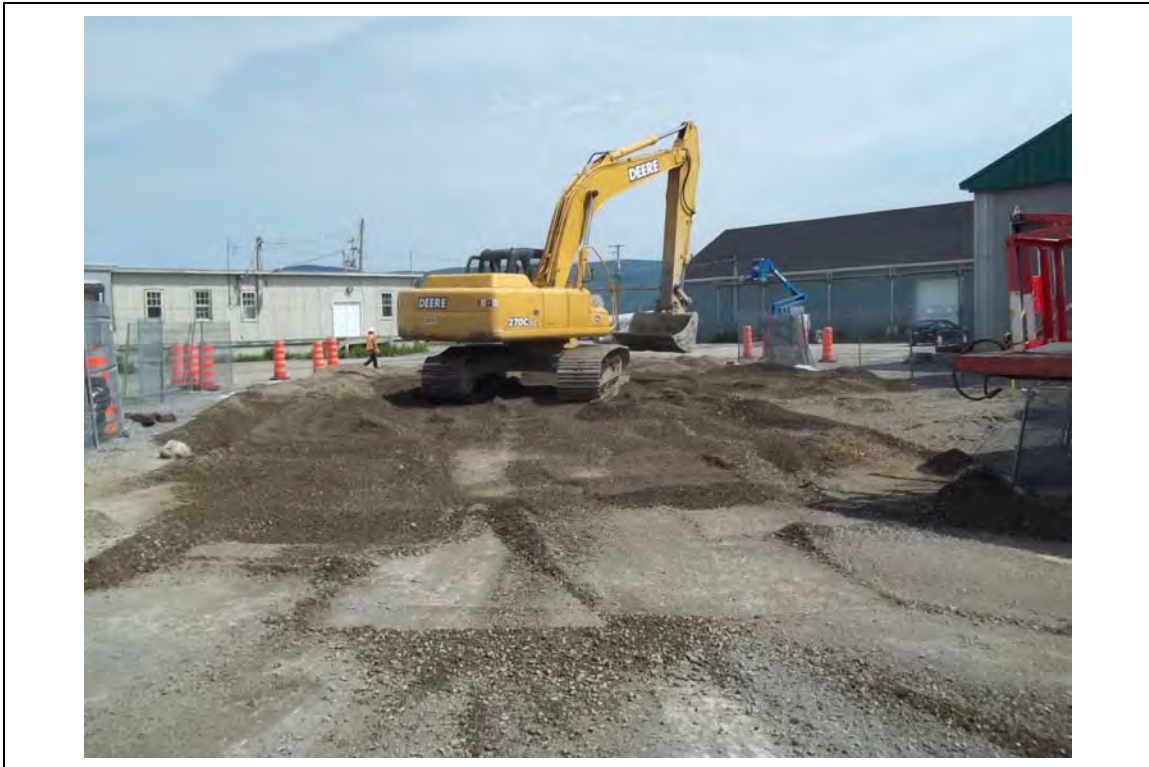
Photo No 14 – Épandage des sols de remblaiement.
