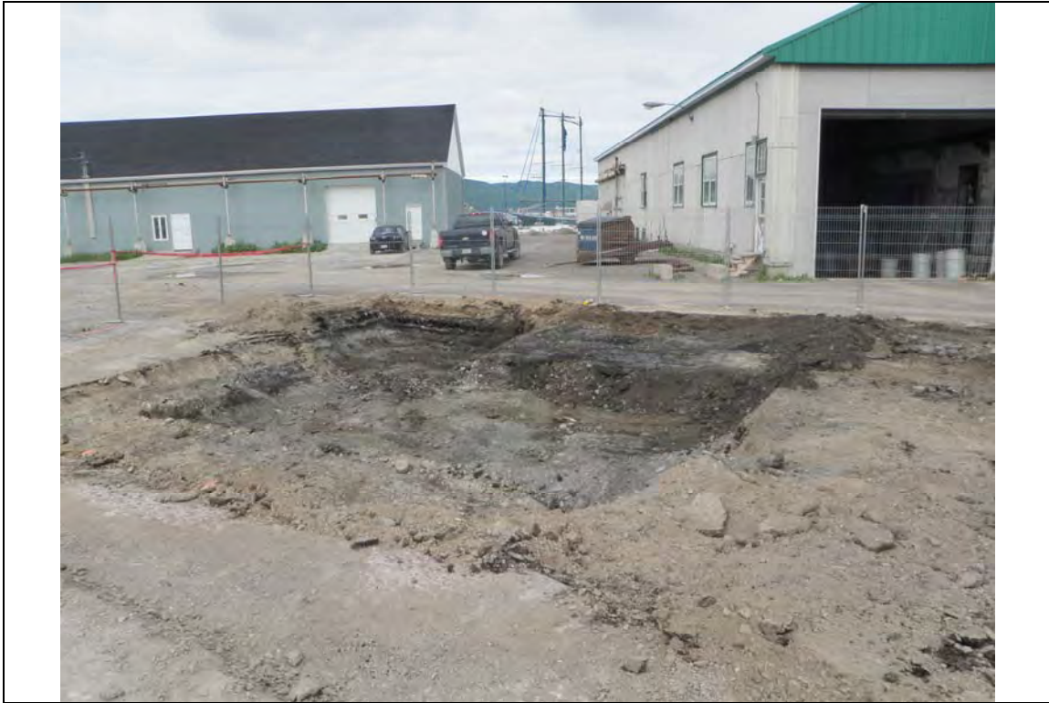
Photo No 3 – Vue du fond propre de l'excavation et de la couche contaminée dans la paroi.
