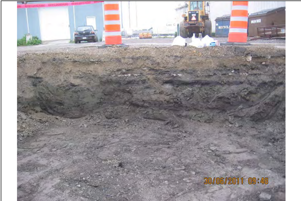
Photo No 8 - Vue de la paroi PA-14 (sur-excavation PA-8).
