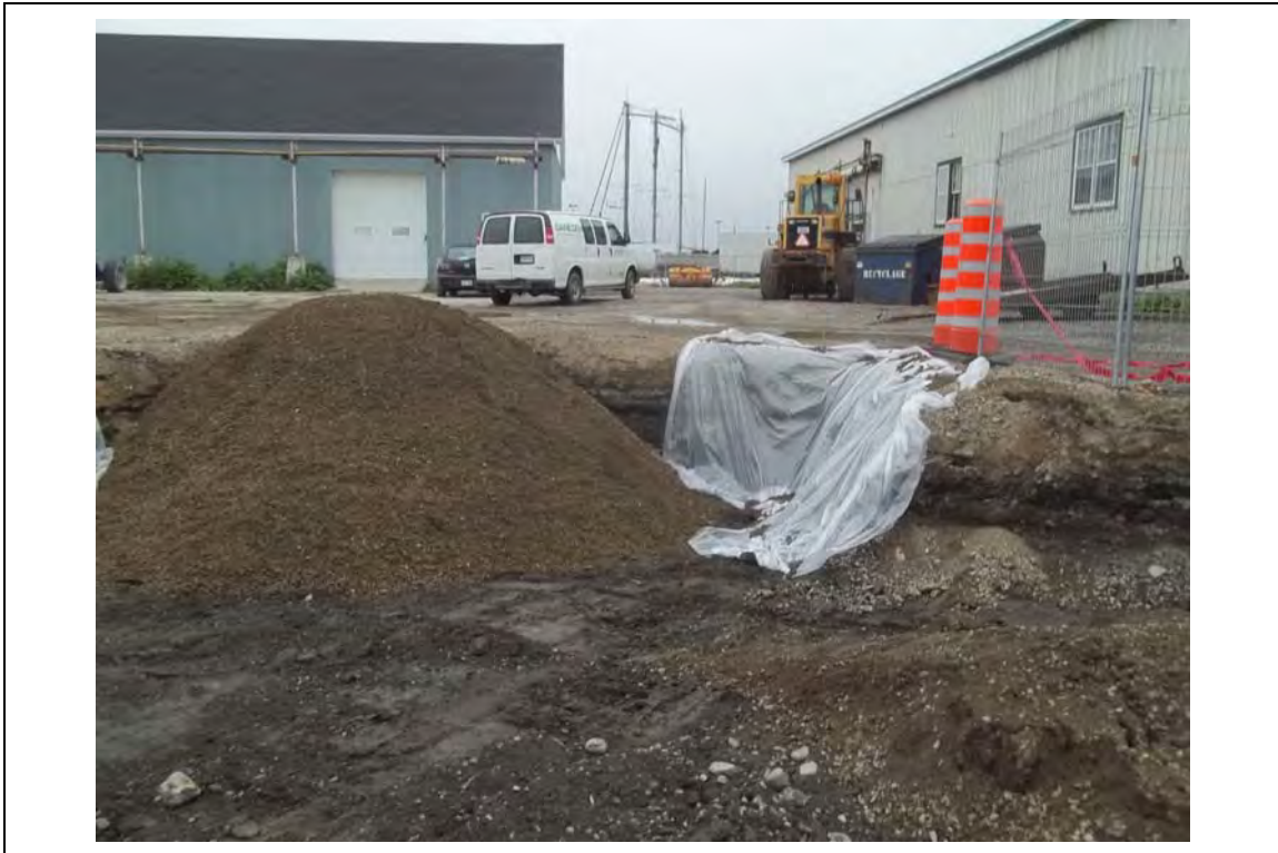
Photo No 12 – Début du remblaiement de l'excavation.
