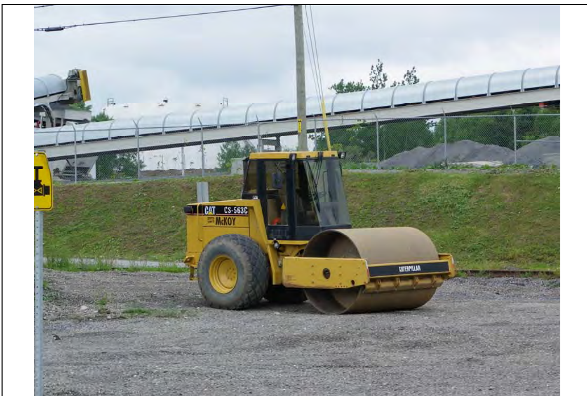
Photo No 15 – Machinerie utilisée pour le compactage des sols de remblaiement.
