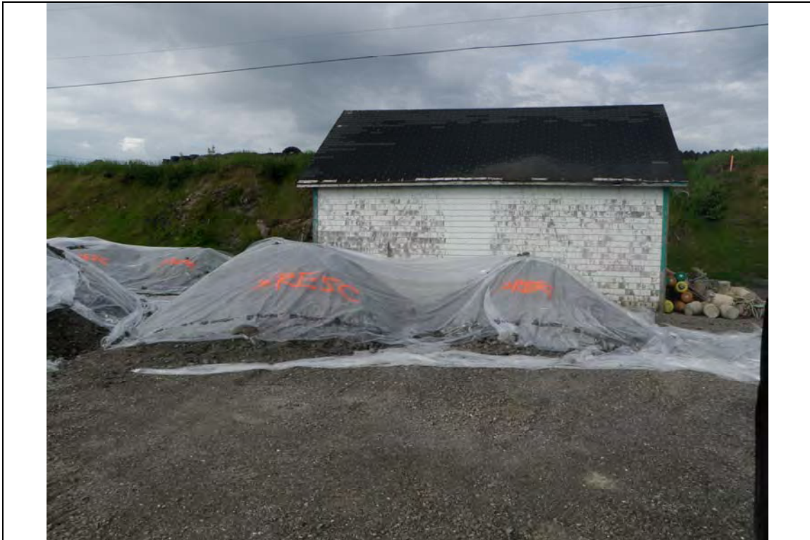
Photo No 6 – Premières piles entreposées sur et sous polythène.
