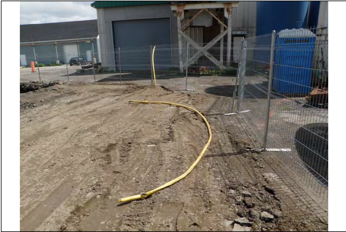
Photo No 5 – Section de conduite de gaz présumée. Non utilisée.
