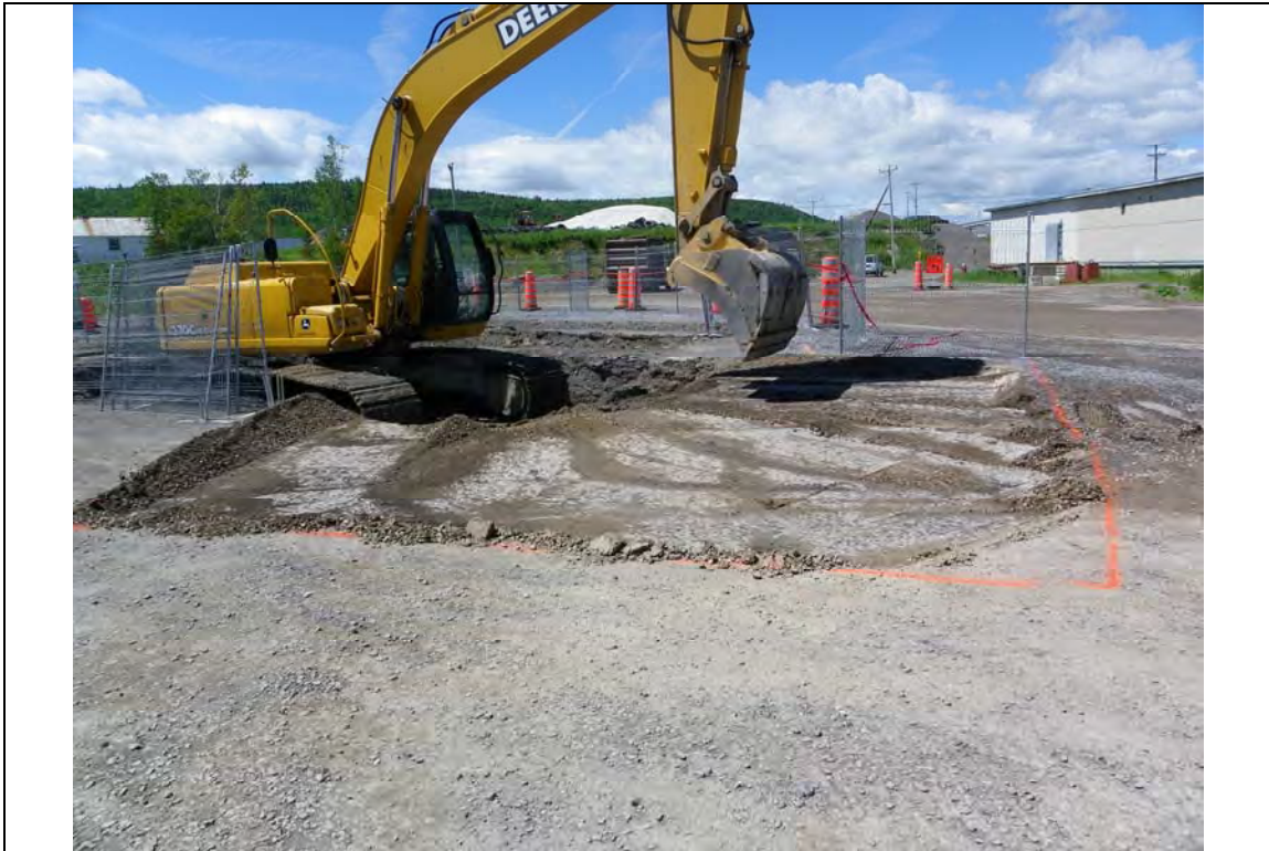
Photo No 7 – Sur-excavation des parois PA-1 et PA-8.
