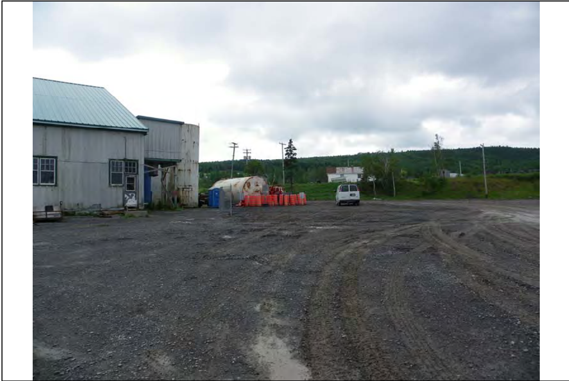
Photo No 17 – Vue de la zone d'excavation remblayée en regardant vers le sud.
