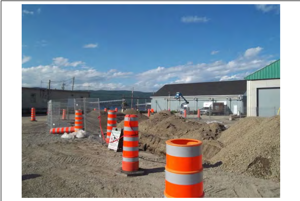
Photo No 13 – Vue des sols servant pour le remblaiement.
