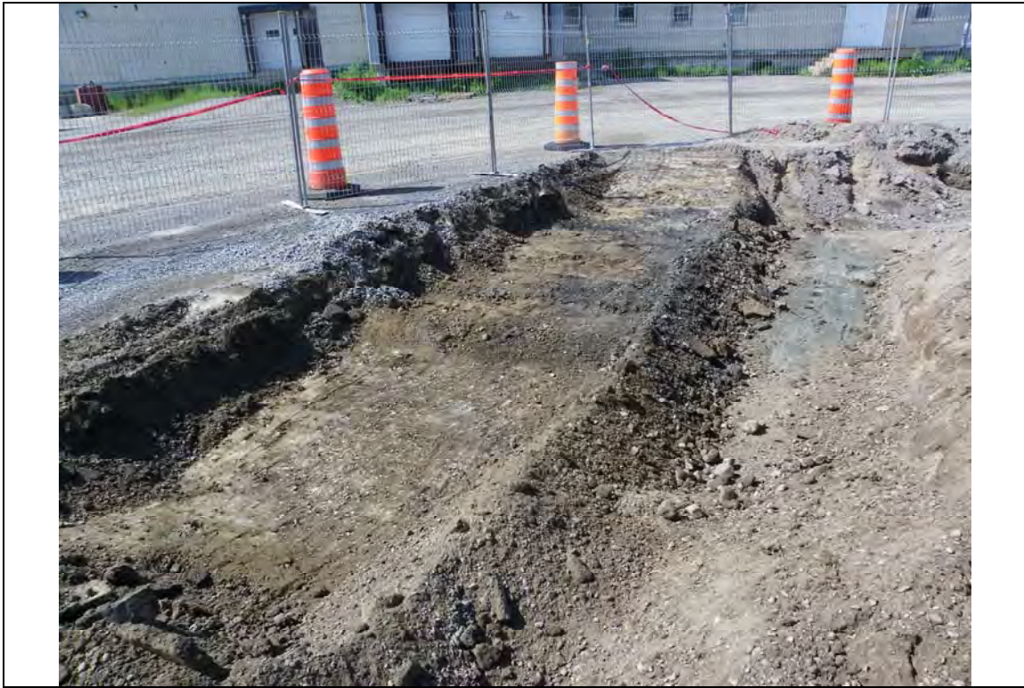
Photo No 9 – Vue de la paroi PA-17 (sur-excavation de la paroi PA-10).
