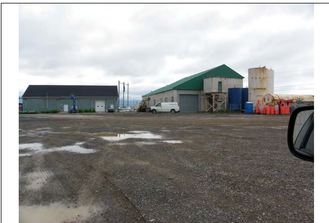
Photo No 16 – Aspect des lieux après avoir enlevé les clôtures et les cônes.
