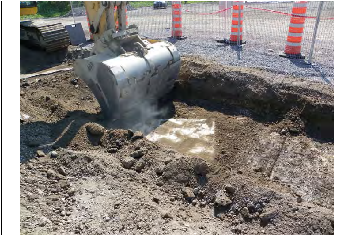
Photo No 10 – Dalle de béton de 2,0 m sur 2,0 m laissée sur place. Jonction entre PA-17 et PA-18.
