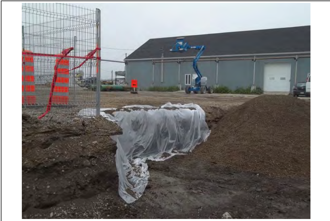
Photo No 11 – Pose du polythène aux pourtours de l'excavation et aux limites de propriété.
