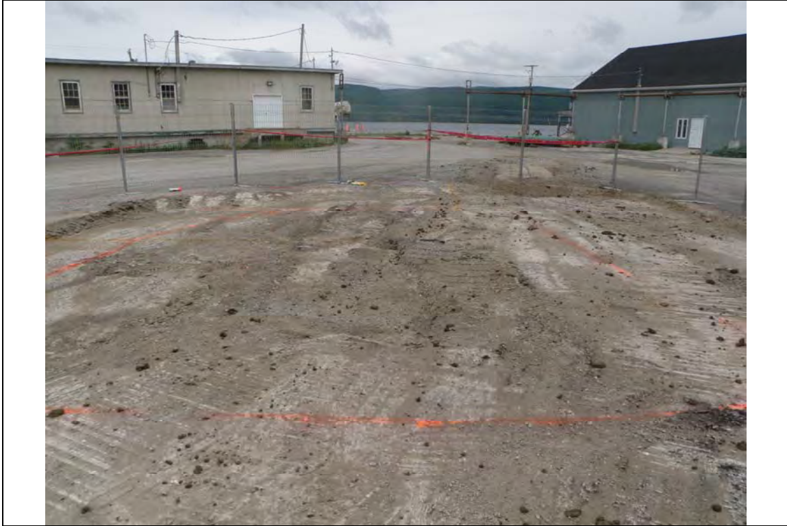
Photo No 1 – EX-3, Début de l'excavation. Couche de 0-¾ enlevée. Délimitation de l'excavation.
