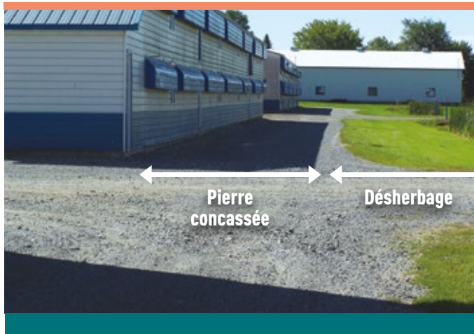
Abords dégagés du bâtiment
