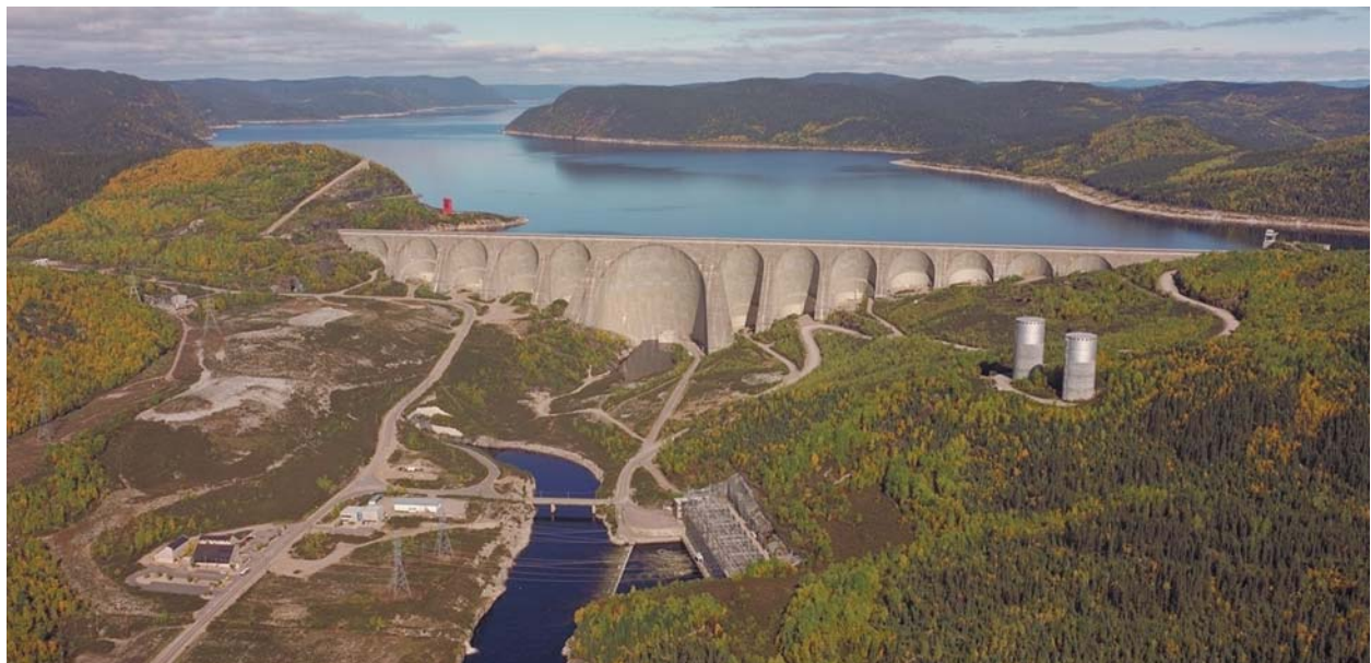
Barrage Daniel-Johnson – Côte-Nord
