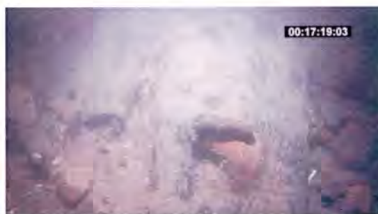
Figure 10. Clou rabattu, à la surface d'un couple.
