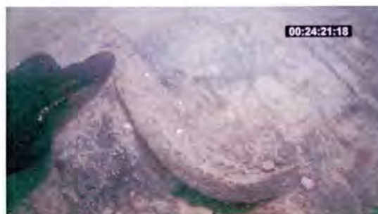
Figure 11. Broche carrée reliant deux pièces de couple, pliée par l'effort des glaces.
