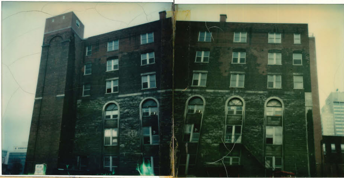
BÂTIMENT 6 ETAGES AU 987 RUE CÔTÉ, MONTREAL ÉLEVATION MUR SUD (2 PHOTOS)
