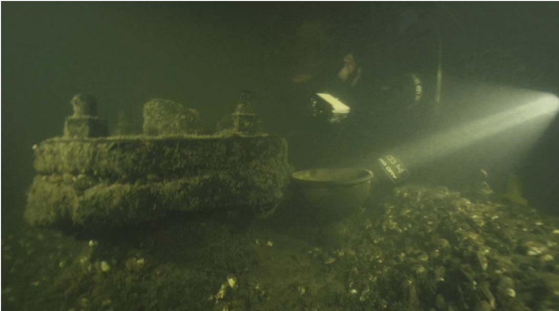
Figure 10 : Entonnoir et boîte à étoupe sur le dessus du cylindre
