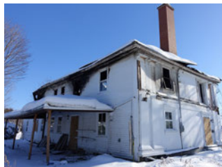
Manoir Taschereau (démoli). Vue d'angle arrière
