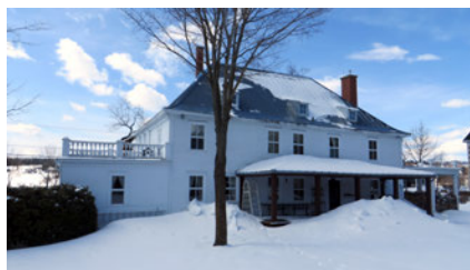
Manoir Taschereau (démoli). Vue d'angle arrière
