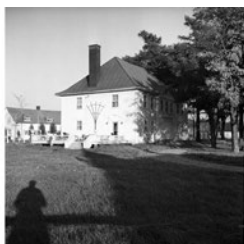
Manoir Taschereau (démoli)
