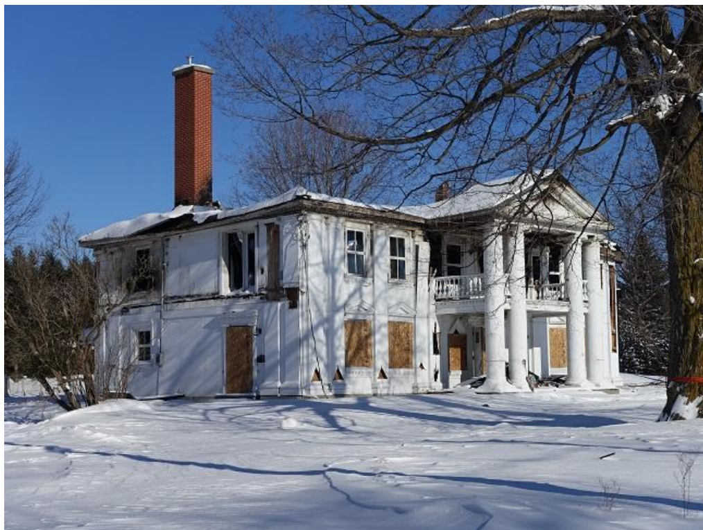
1) Manoir Taschereau après incendie vu de l'ouest.
