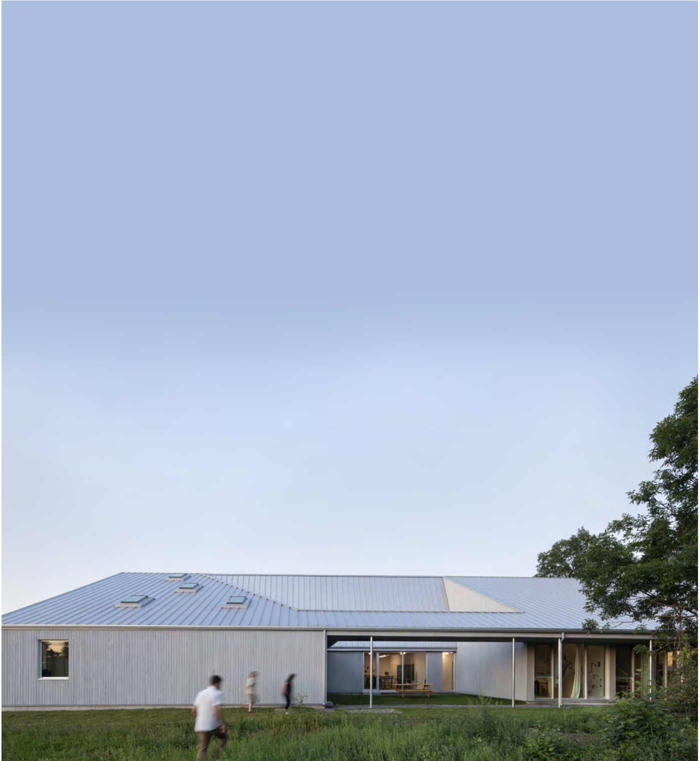
Est-Nord-Est, résidence d'artistes, à Saint-Jean-Port-Joli. Le Ministère a financé sa construction et l'inauguration a eu lieu à l'été 2019.
