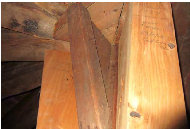
Photo 39 : Agrandi de l'assemblage à la tête du pilier de bois
