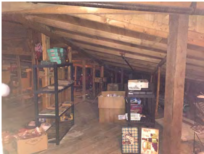
Photo 15 : Vue générale de la structure du faux-terrain
