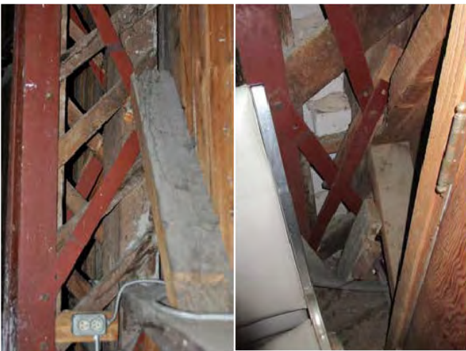
Photo 33 et 33A: Colonne treillis et ses renforts
