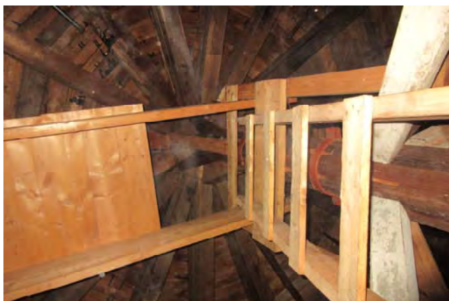
Photo 40 : Assemblages des fermes à la tête du pilier en bois
