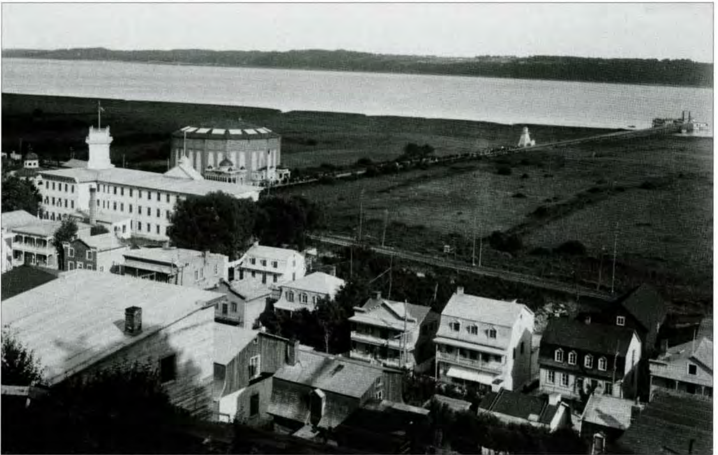
Fig. 18. Le Cyclorama à Sainte-Anne-de-Beaupré vers 1930. Photo Livernois. Sur cette image le toit porte encore les tabatières, fenêtres inscrites dans le plan de la couverture et qui assurent un éclairage zénithal de la toile.
