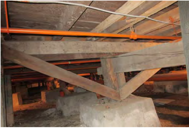
Photo 4 : Pilier de bois et jambe de force
