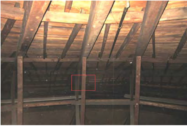
Photo 43 : Fermes de toit, poutres et solives intermédiaires à l'endroit de la défaillance
