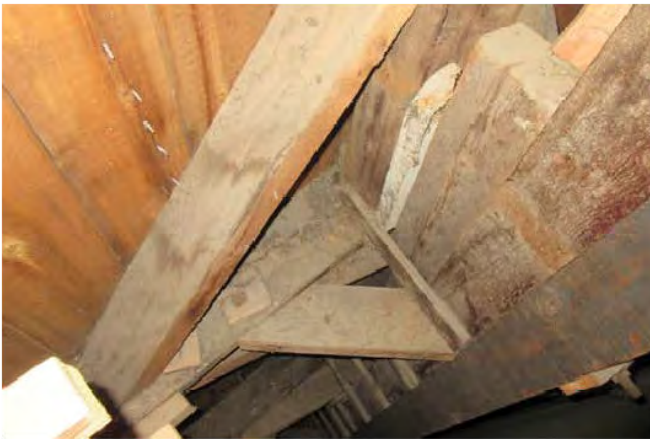
Photo 32 : Colonne treillis et ses assemblages
