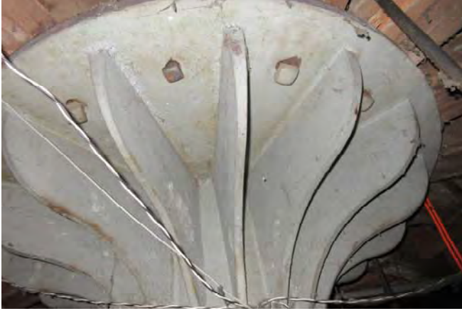
Photo 37 : Jonction du pilier central en bois à celui en acier et béton coulé et assemblages des fermes
