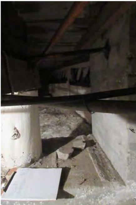
Photo 1 et 1A : Pilier central en acier et assise en béton
