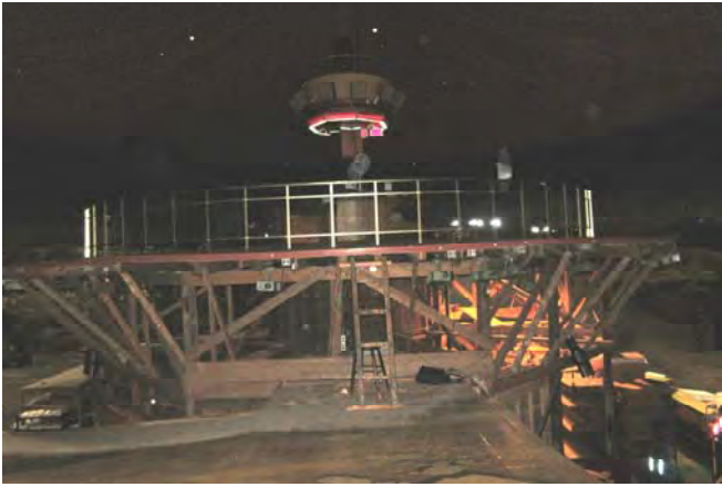
Photo 19 : Structure de la passerelle centrale
