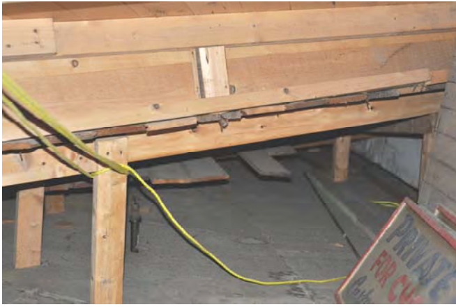
Photo 16 : Vue générale de la structure du faux terrain
