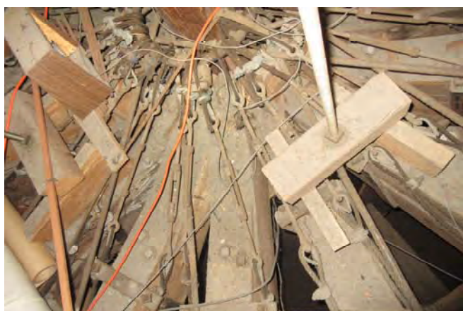
Photo 42 : Étriers et tendeurs d'acier aux fermes à leurs assemblages au pilier de bois
