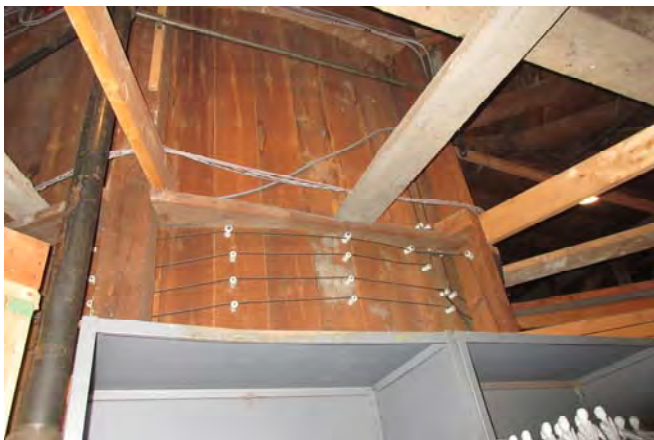
Photo 18 : Vue générale de la structure centrale radiale
