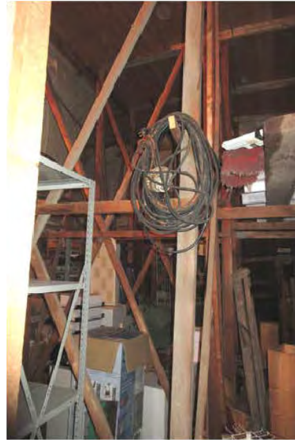
Photo 25 et 25A : Sous le faux terrain
