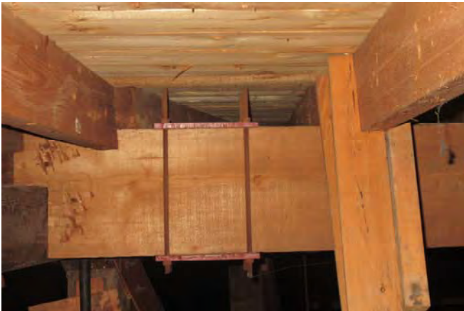
Photo 35 : Rive du toit et renfort d'assemblage d'une poutre intermédiaire
