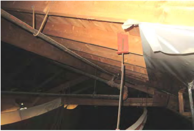
Photo 34 : Rive du toit et rail suspendu
