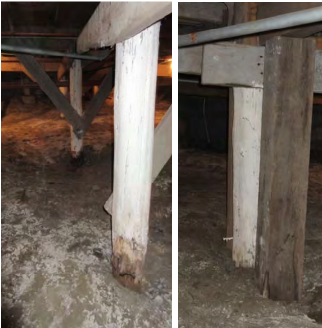
Photo 5-6 : Poteaux anciens en rondins
