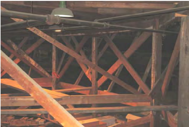
Photo 20 : Structure sous la passerelle centrale
