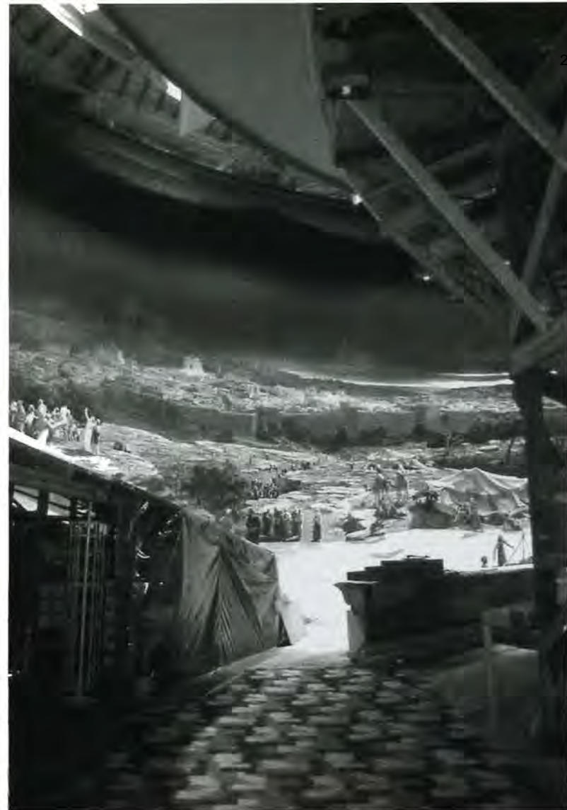
Fig 1. Intérieur du Cyclorama de Jérusalem à Sainte-Anne-de-Beaupré. Vue sur la toile depuis le dessous de la plate-forme. Au premier plan on aperçoit le faux-terrain, construction en bois qui porte le prolongement, dans l'espace, du décor peint. (photo Luc Noppen)
