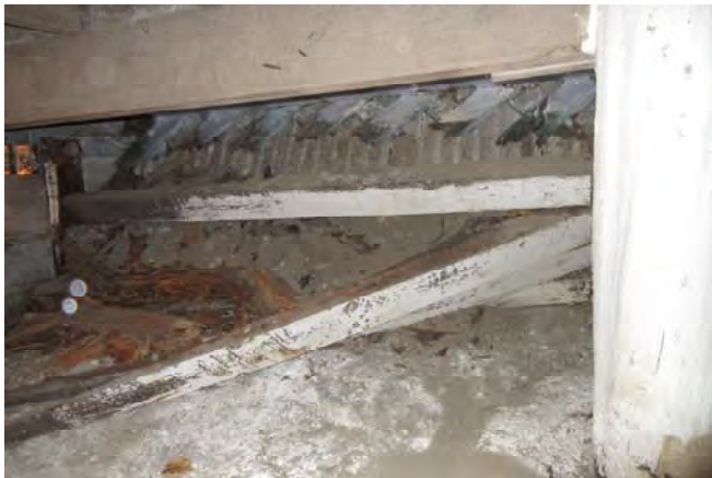
Photo 11 : Muret en 6" x 6"
