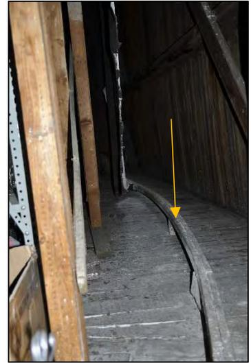
**Photo 22** : Système d'accrochage au bas du tableau. À cet endroit, sous le faux-terrain, on ne voit pas de toile, car le tableau a été coupé, mais sinon, la toile est tenue en « sandwich » entre ces barres de bois.
