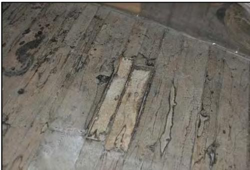
**Photo 31** : Plancher ancien, avec des planches remplacées.
