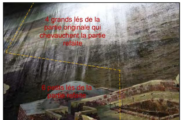
Photo 19 : Jonction de la partie refaite, en bas, avec la partie originale, en haut.
