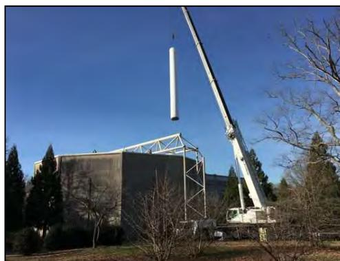
**Photo 35** : Un des rouleaux transporté par une grue dans la nouvelle rotonde. Le rouleau doit y entrer par le toit.
