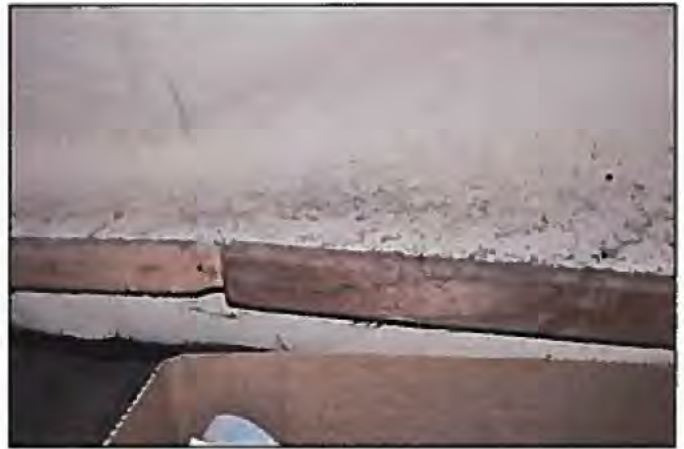
Photo 6 : Système d'accrochage pour tenir la toile, sous le plancher du faux-terrain, au sol.
