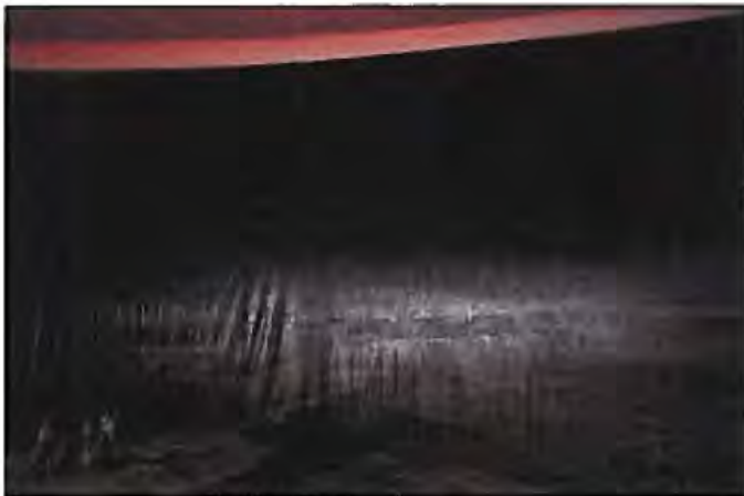
Photo 5 : Gondolements verticaux dans la toile.
