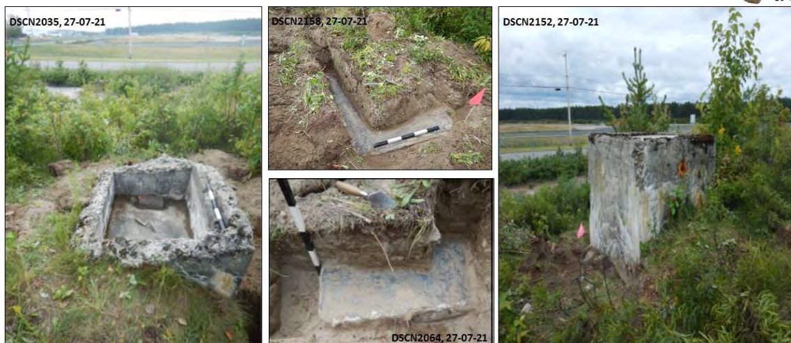
Figure 61 : Les cheminées d'aération sud (à gauche) et ouest (à droite) ainsi que les angles nord et est de la surface des réservoirs (au centre). (Source : Subarctique Enr., DSCN2035 (1E1), DSCN2158 (1E10), DSCN2064 (1E5), DSCN2152 (1E6 et 1E7))
