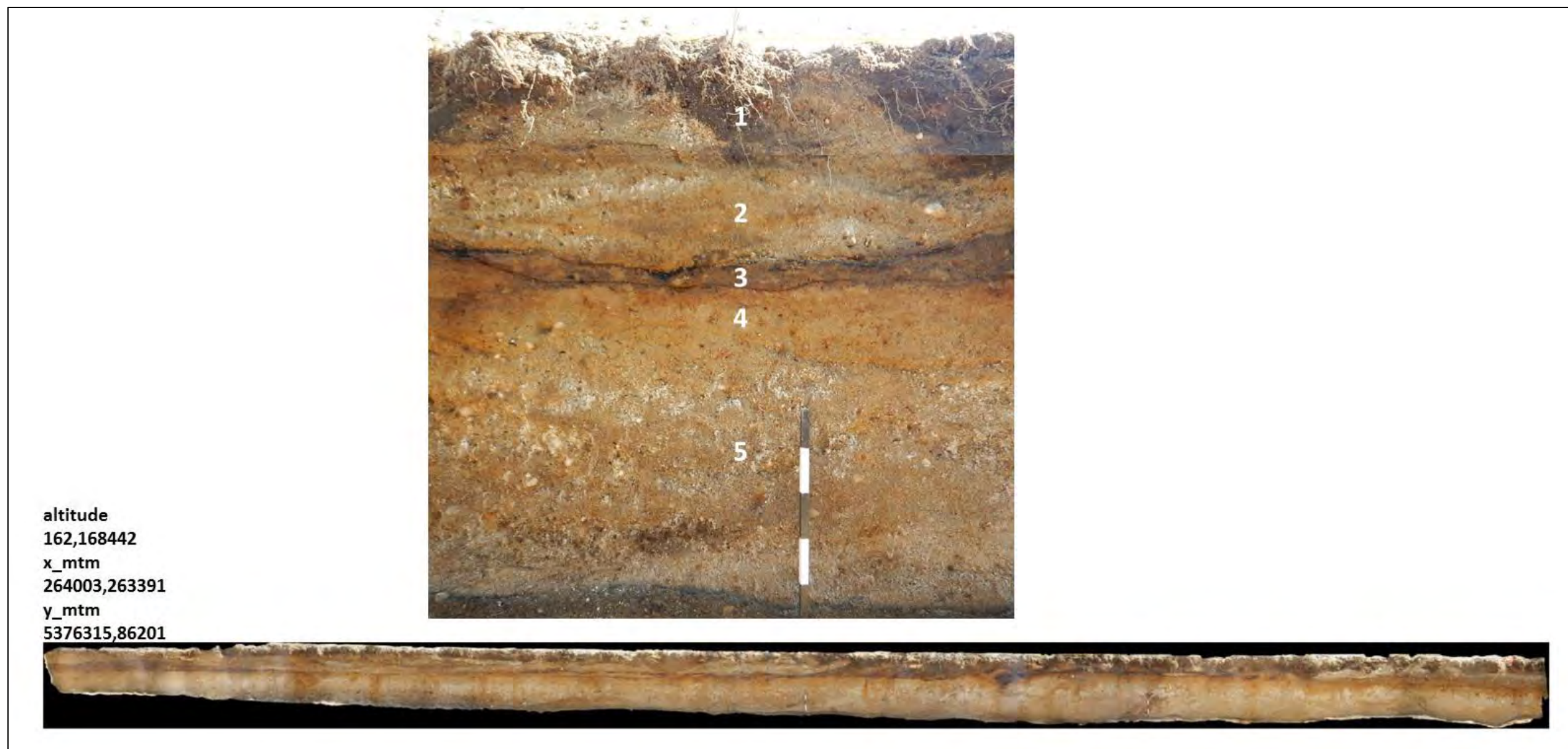
Figure 82 : Tranchée mécanique réalisée du côté ouest du terre-plein (4B), paroi nord. (Source : Subarctique Enr. 2020; encart : DSCN 3399 et DSCN3401; traitement 3D : J. Gagné)
