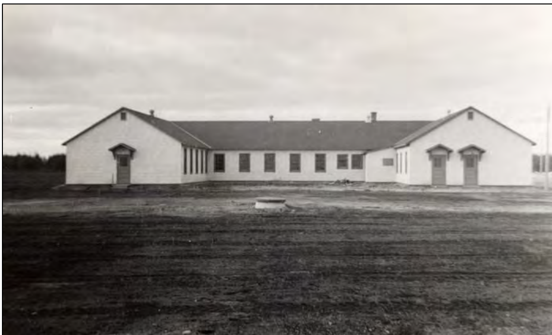
Figure 35 : Vue de la caserne datant de la Deuxième Guerre mondiale. (Source : Musée de la Défense aérienne / BFC Bagotville)
