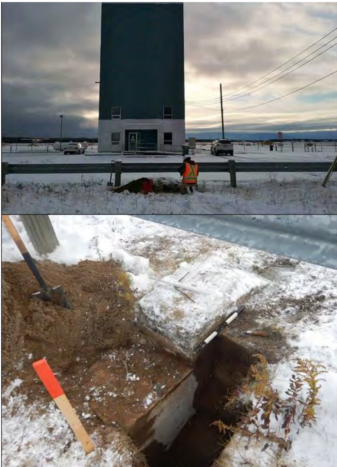
Figure 53 : Sondage 0 en bordure de la fondation du hangar d'avions. (Source : Subarctique Enr., 1603804195795 et DSCN3510, 2020-10-27)
