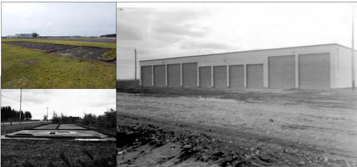
Figure 46 : Fondation du garage pour véhicules automobiles (S1-4), ca 1943, visible le long de la rue de l'aéroport. (Sources : Musée de la Défense aérienne / BFC Bagotville, Collection Michel Bergeron et Subarctique Enr, DSCN1110, 2020-08-04)
