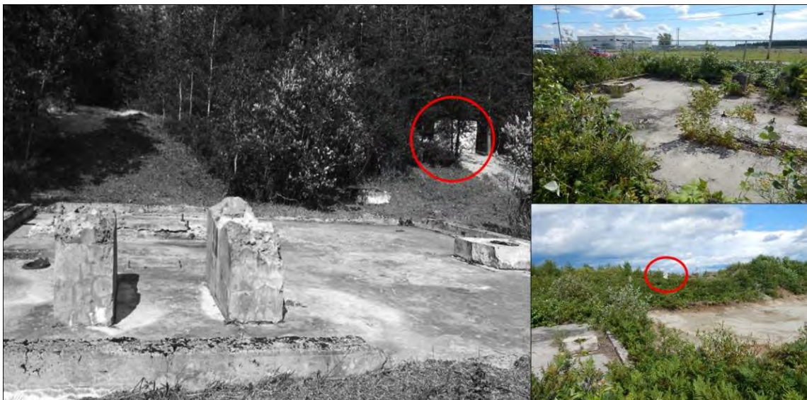
Figure 44 : Fondations de la station de pompage (S1-10) visibles le long de la rue de l'aéroport s.d. et aujourd'hui. Le monticule abritant les réservoirs d'eau est visible en arrière-plan et la cheminée d'aération est encerclée. (Sources : Musée de la Défense aérienne / BFC Bagotville et Subarctique Enr., DSCN1459 et DSCN1453, 2020-08-04)
