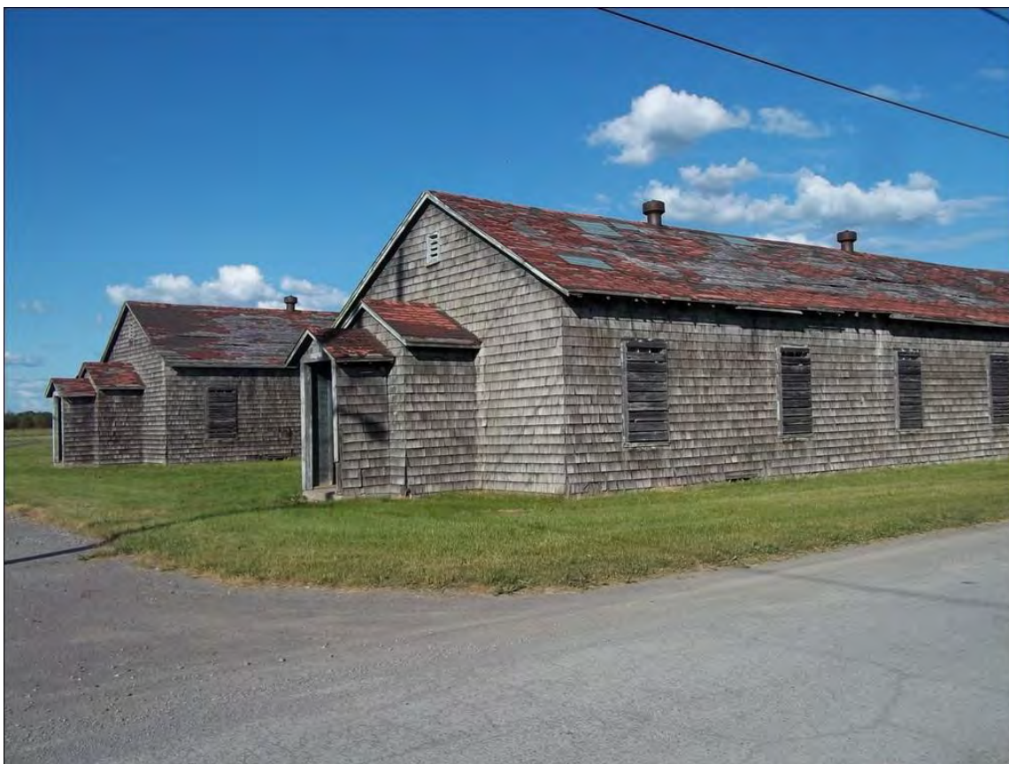
Figure 42 : Baraques militaires (« H huts ») à toiture de bardeaux d'asphalte, au camp Picton en Ontario, 12 mai 2012, photo : Bruce Forsyth. (Sources : https://militarybruce.com/abandoned-canadian-military-bases/abandoned-bases/ontario/ , https://militarybruce.com/wp-content/uploads/2014/01/101_3323.jpg , pages consultées le 2022-01-15)
