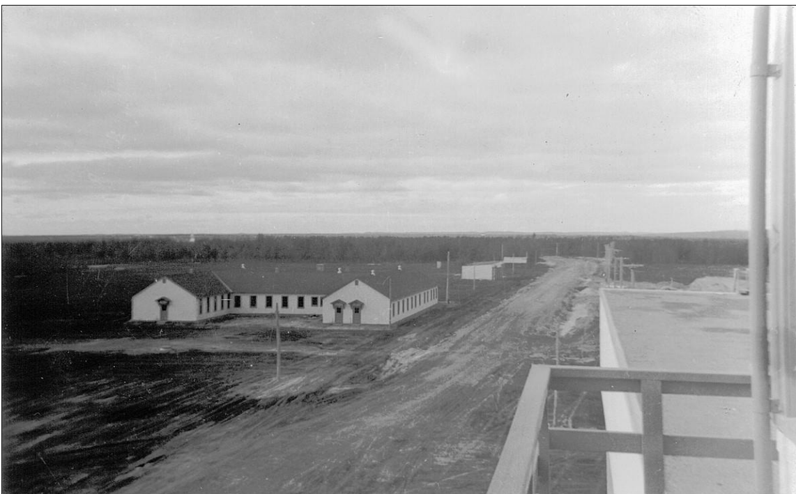
Figure 47 : Vue de la rue de l'aéroport, depuis la tour de contrôle, ca 1943. On aperçoit la caserne (S1-2), le garage pour véhicules automobiles (S1-4) et un autre bâtiment à toit mansardé [grange ou hangar] (S1-5) dont les fondations ne sont pas visibles aujourd'hui. (Source : Musée de la Défense aérienne / BFC Bagotville)
