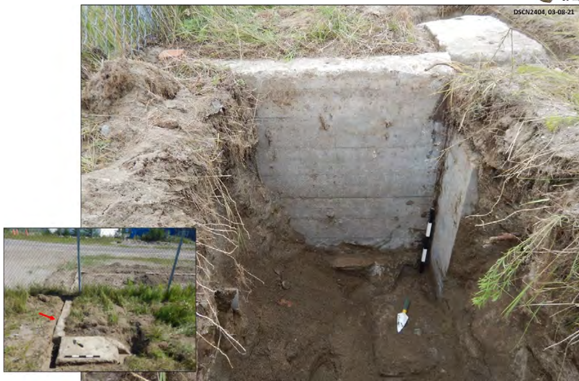
Figure 55 : Façade nord de l'annexe du hangar (1H2) indiquant son empattement en bois et, à droite, le butoir du hangar et sa base de béton. (Source : Subarctique Enr., DSCN2194 et DSCN2404)
