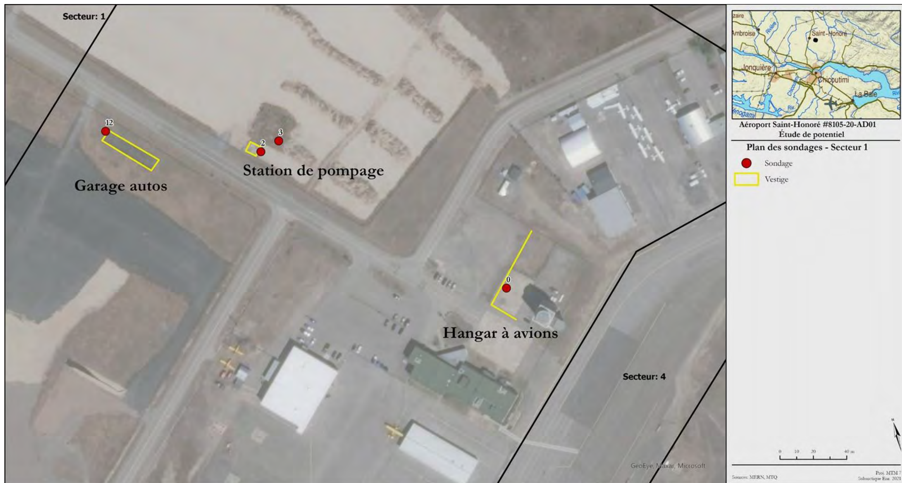
Figure 52 : Localisation des sondages réalisés en bordure des trois bâtiments dont les fondations sont visibles dans le secteur 1. (Source : Subarctique Enr., N. Plourde, octobre 2020)
