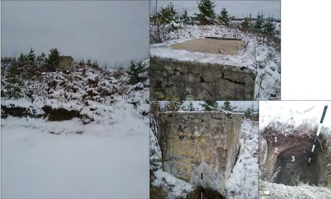
Figure 57 : Sondage 3 au pied de la cheminée d'aération, sur le monticule abritant les réservoirs d'eau, vers le nord-est. Le niveau de bois est visible à droite. (Subarctique Enr., 1603893010919, 1603890408703, 1603890438471, 1603890704726)
