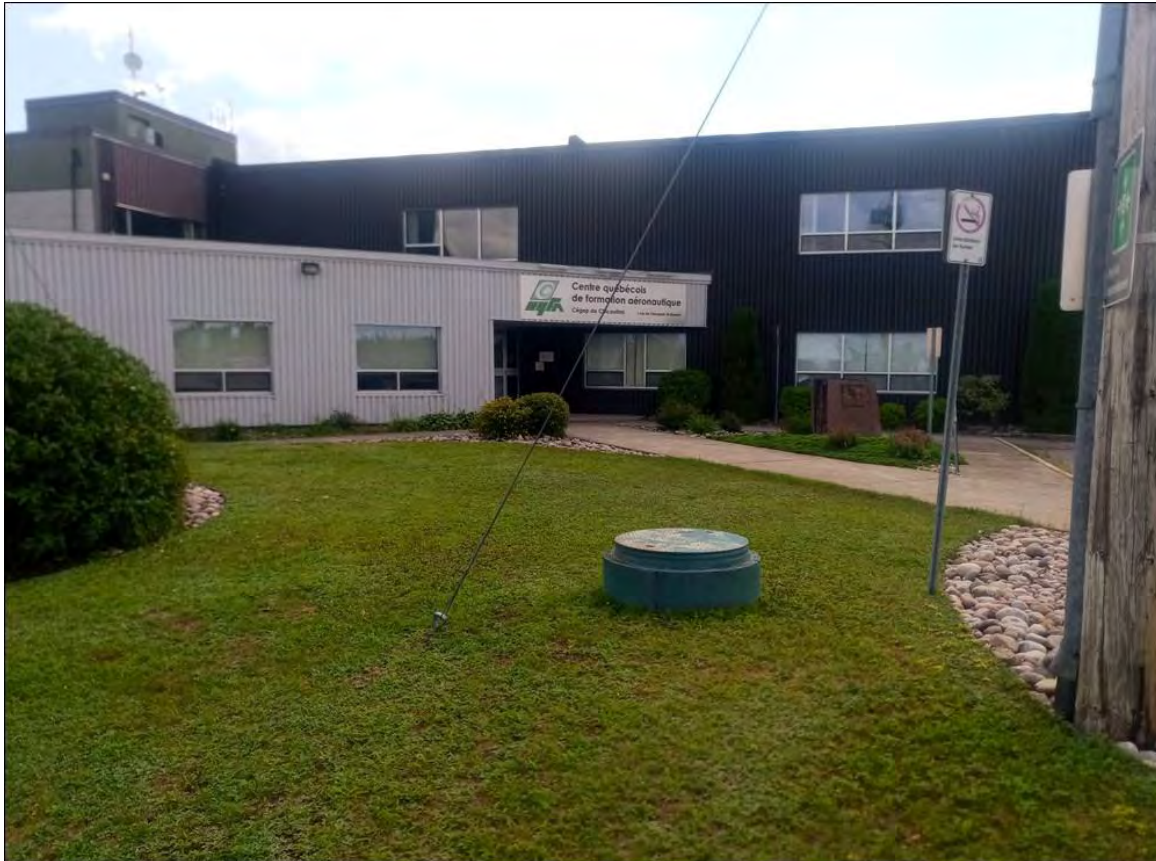
Figure 48 : Manhole devant le bâtiment du CFQA, associé peut-être au réseau d'origine d'évacuation des eaux usées de 1942. (Source : Subarctique Enr., #20200806185322916)
