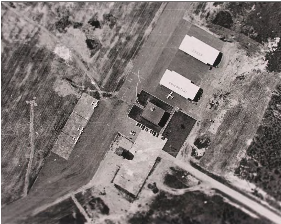
Figure 29 : Photo aérienne des installations du CQFA vers 1970 (secteur 1). (Source : Musée de la Défense aérienne / BFC Bagotville)
