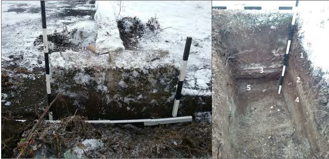
Figure 55 : Sondage 12 en bordure de la fondation du garage pour autos, vers le sud. On remarque l'assise en béton grossier sous la fondation. (Source : Subarctique Enr., DSCN3545 et 1603895858804, 2020-10-28)
