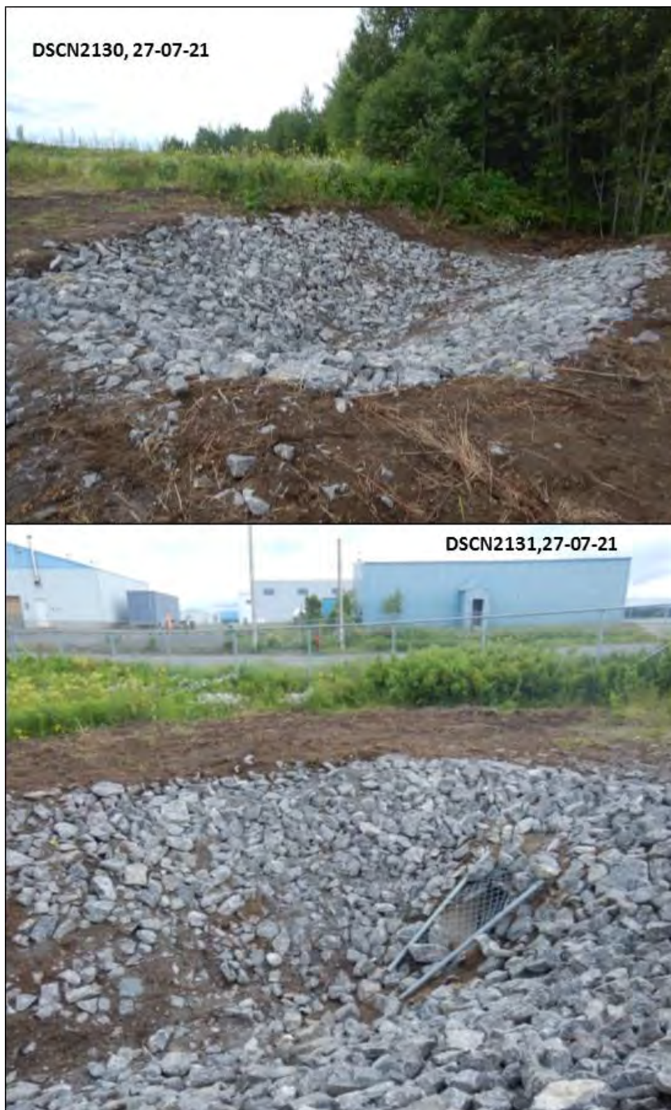
Figure 89 : Enrochement au lieu de résurgence du ruisseau de l'Aqueduc et le tuyau souterrain canalisant les eaux du ruisseau. (Source : Subarctique Enr., DSCN2130 et DSCN2131)
