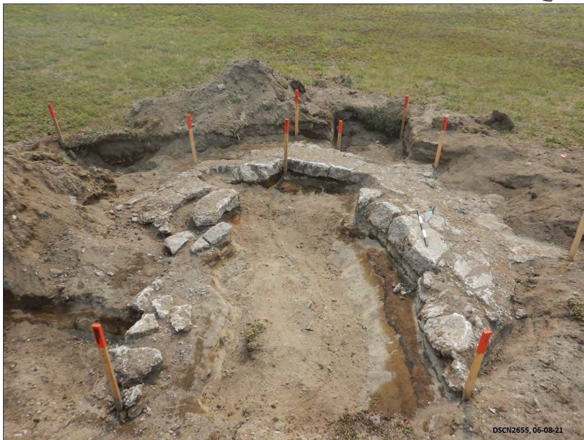
Figure 72 : Fondation en béton à l'emplacement du vestige S1-9, vue vers le sud-est. (Source : Subarctique Enr., DSCN2655)
