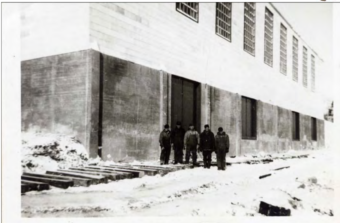
Figure 56 : Détail du revêtement de la partie supérieure du hangar d'avions indiquant l'utilisation de tuiles de ciment avec amiante. (Source : Collection Michel Bergeron, 45a-riviere sable 6)
