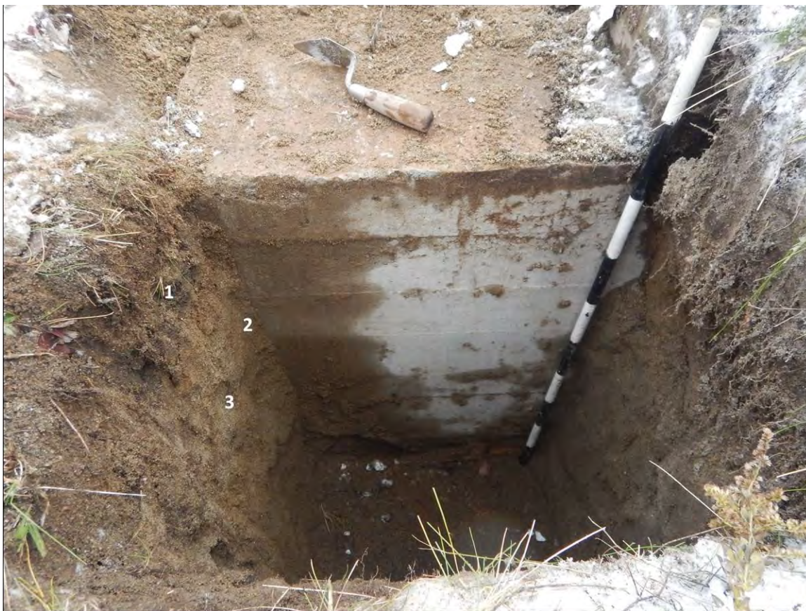
Figure 54 : Détail du sondage 0 et de la fondation en béton du hangar d'avions, vers le nord-est. La fondation repose sur un radier en bois. (Source : Subarctique Enr., DSCN3494, 2020-10-27)
