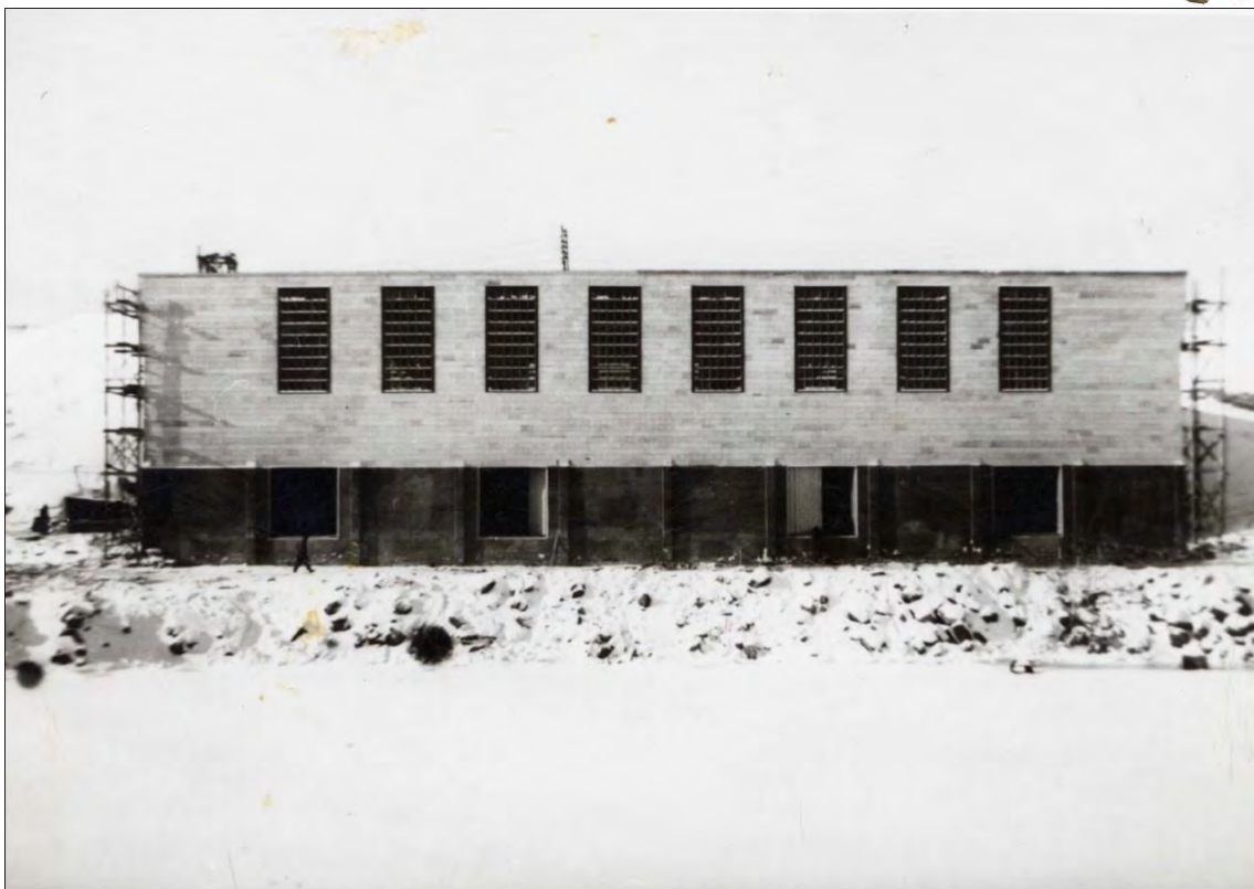
Figure 50 : Le hangar d'avions de Saint-Honoré en voie de démolition pour la vente, illustrant les piliers de support en béton entre les ouvertures de fenêtres. (Source : Collection Michel Bergeron, 44-rivière sable 4)
