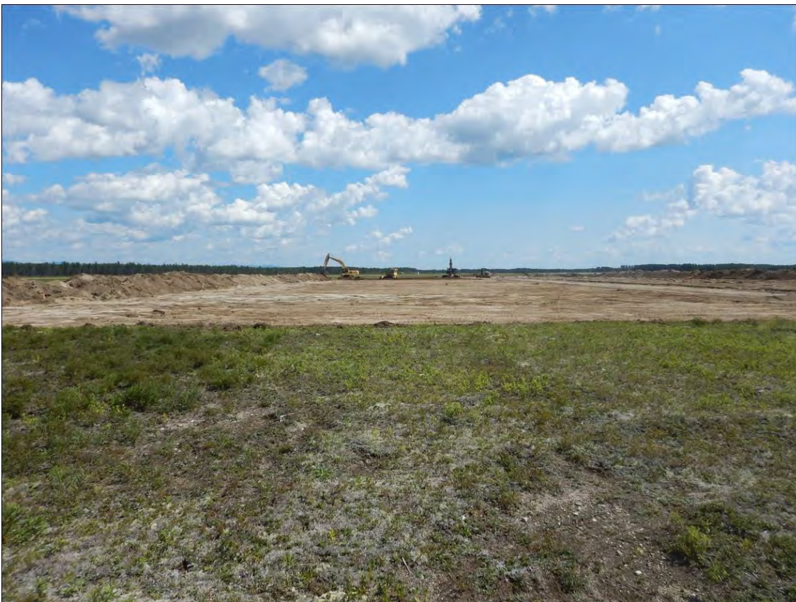
Figure 73 : Travaux de décapage de la couche organique, zone des pistes de planeurs dans la partie sud du secteur 4, vers l'est. (Source : Subarctique Enr., DSCN1600, 2020-08-11)
