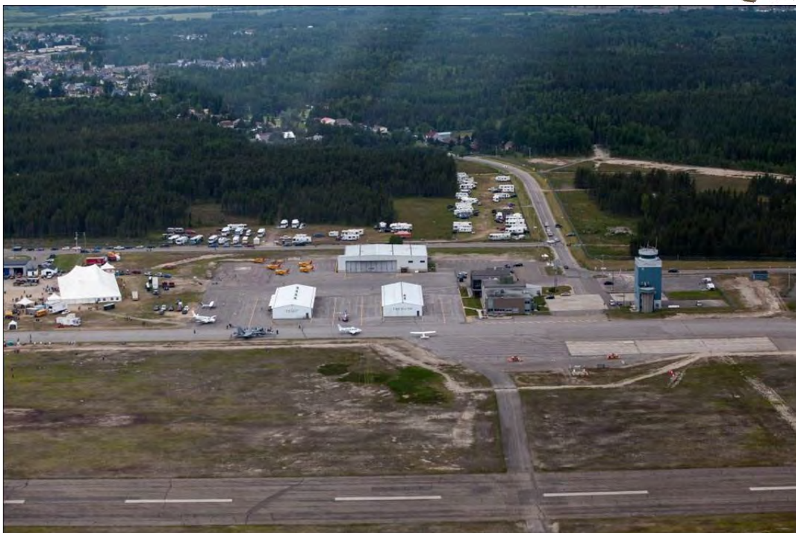
Figure 32 : Les installations du CQFA et la tour de contrôle érigée en 2006 (2013). (Source : MTQ)
