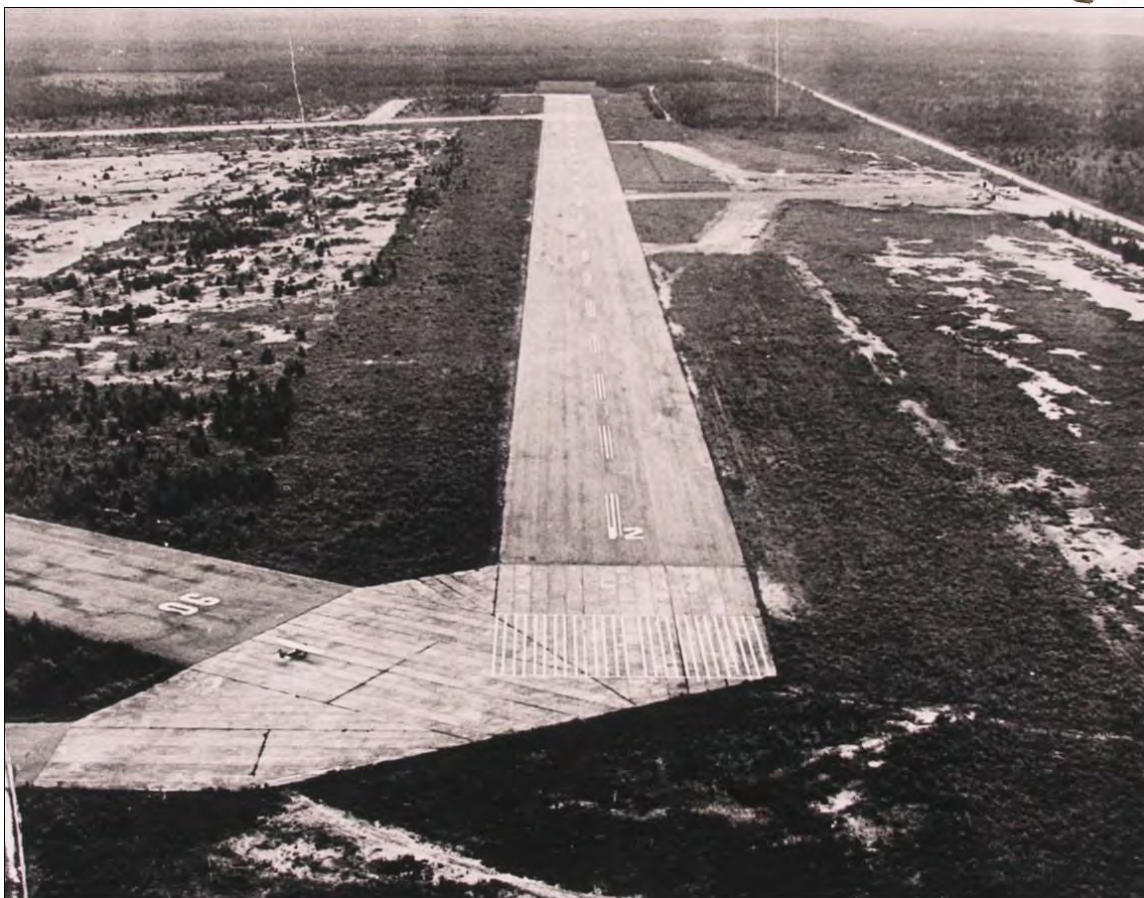
Figure 28 : Détail de la dalle bétonnée à l'angle sud-ouest des pistes, vue vers l'est (s.d.). (Source : Collection Michel Bergeron, 79-volair cons aérienne3)
