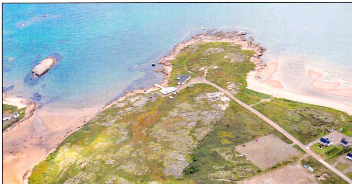
Photo 3 Vue aérienne du site classé de Room's Point
