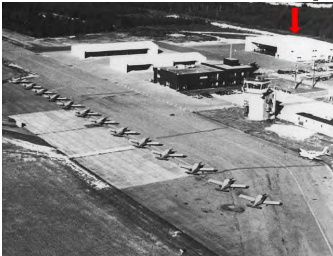
Figure 31 : Les installations du CQFA et la tour de contrôle de Transport-Canada à l'aéroport de Saint-Honoré, 1982. Le garage no 3 est indiqué par une flèche. (Source : Archives CQFA, tiré de Bergeron, 2013, p. 336)
