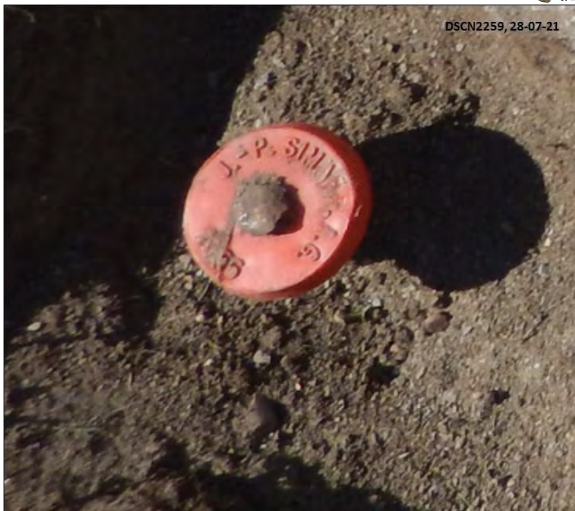
Figure 54 : Détail de la borne d'arpentage (1H9) planté en 1956 à l'angle sud-est de la fondation du bâtiment. (Source : Subarctique Enr., DSCN2259)
