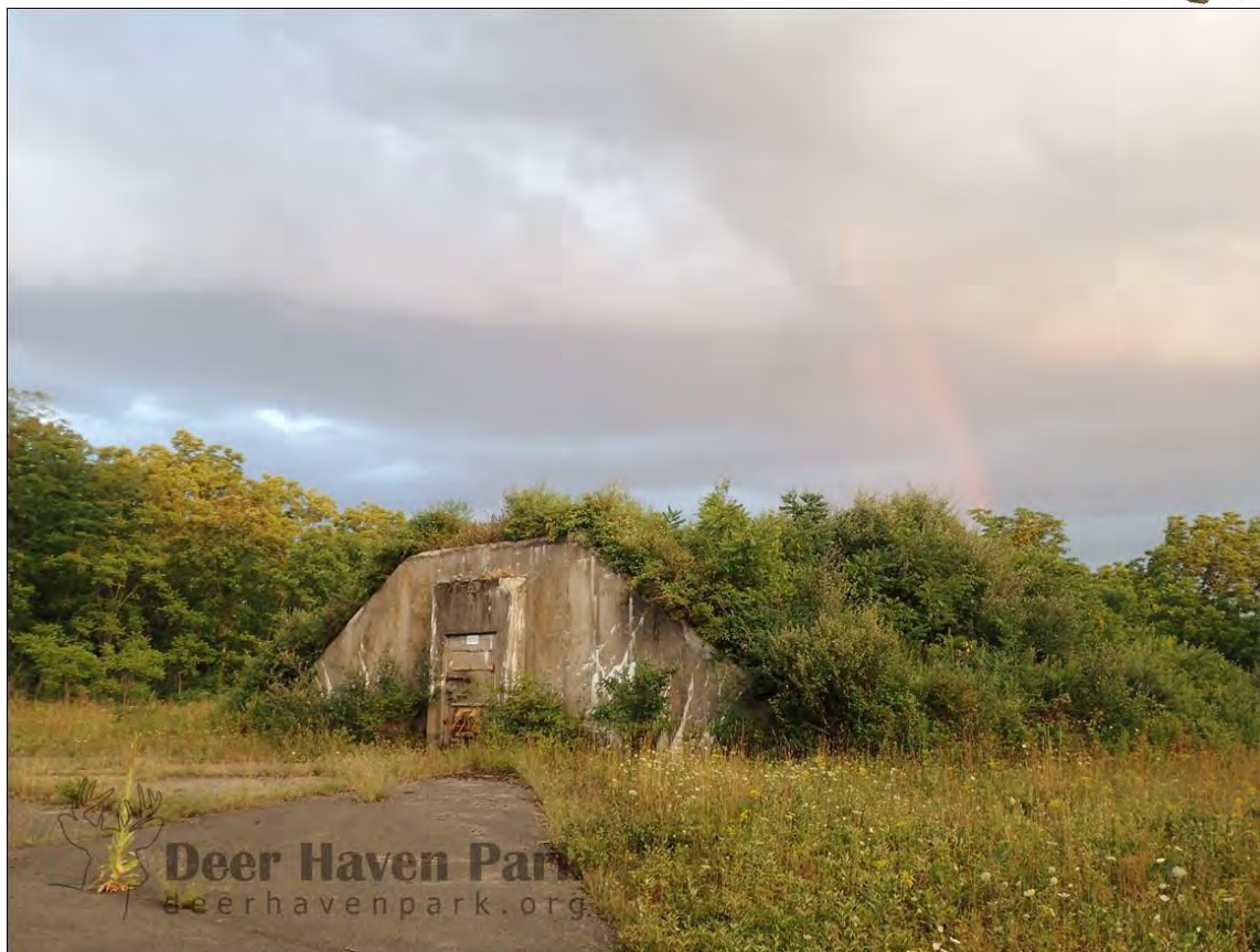
Figure 73 : Abri de munitions, du Seneca Army Depot, Deer Haven Park, https://www.fingerlakes.org/sites/default/files/2020-09/Deer_Haven_Park_Auto_Tours_Bunker.jpg , page consultée le 2022-04-22.
