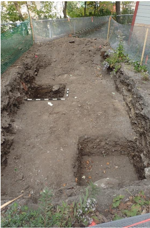
Figure 43. Fin de fouille de la tranchée CeEt-292-5A, vue vers le nord-est (Artefactuel, photo 266).
