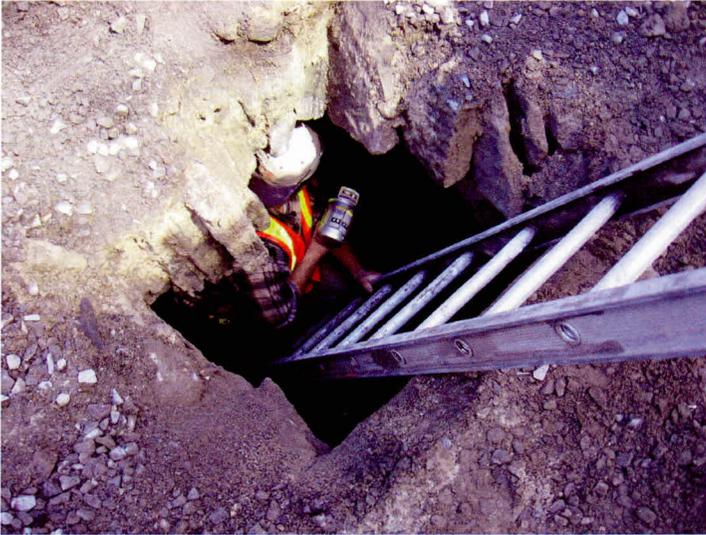
**Photo 3** - Rue Saint-Sulpice (site BfJf-13) – Sous-opération 4A – Brèche dans l’ouverture de la voûte provoquée par l’effondrement d’une première réparation en 1982 – Vue vers le nord-est – Vue vers le (BfJf-13-09-N1-7)
