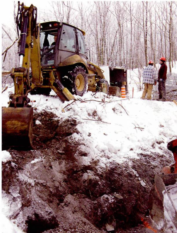
**Photo 4** - Chemin Summit Circle (MTL09-27-1) – Nivellement par ablation de la bordure nord du chemin – Vue vers le sud-ouest (MTL09-27-1-N3-17)
