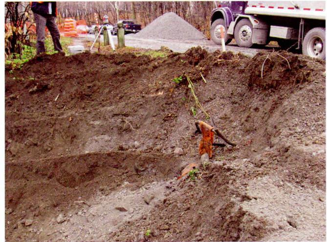
**Photo 6** - Chemin Summit Circle (MTL09-27-1) – Tranchée d’enfouissement d’un fil électrique en bordure nord du chemin – Vue vers l’est-sud-est (MTL09-27-1-N2-20)
