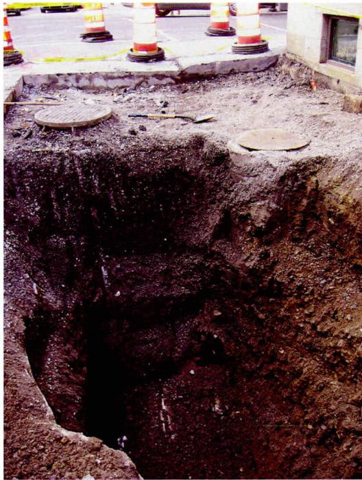
**Photo 8** - Rue Saint-Sulpice (MTL09-25-3) – Sous-opération 1C – Tranchées et sols en paroi. On aperçoit le till morainique sous le trottoir – Vue vers le nord (MTL09-25-3-N3-4)
