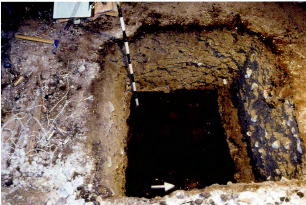
Photo 14 : Bâtiment Robert-Gillespie (I) – Sondage 6B Le flanc sud du radier sud a été dégagé sur bande d'environ 15 cm de largeur — Vue vers l'ouest (BjFj-101-04-D2-29)
