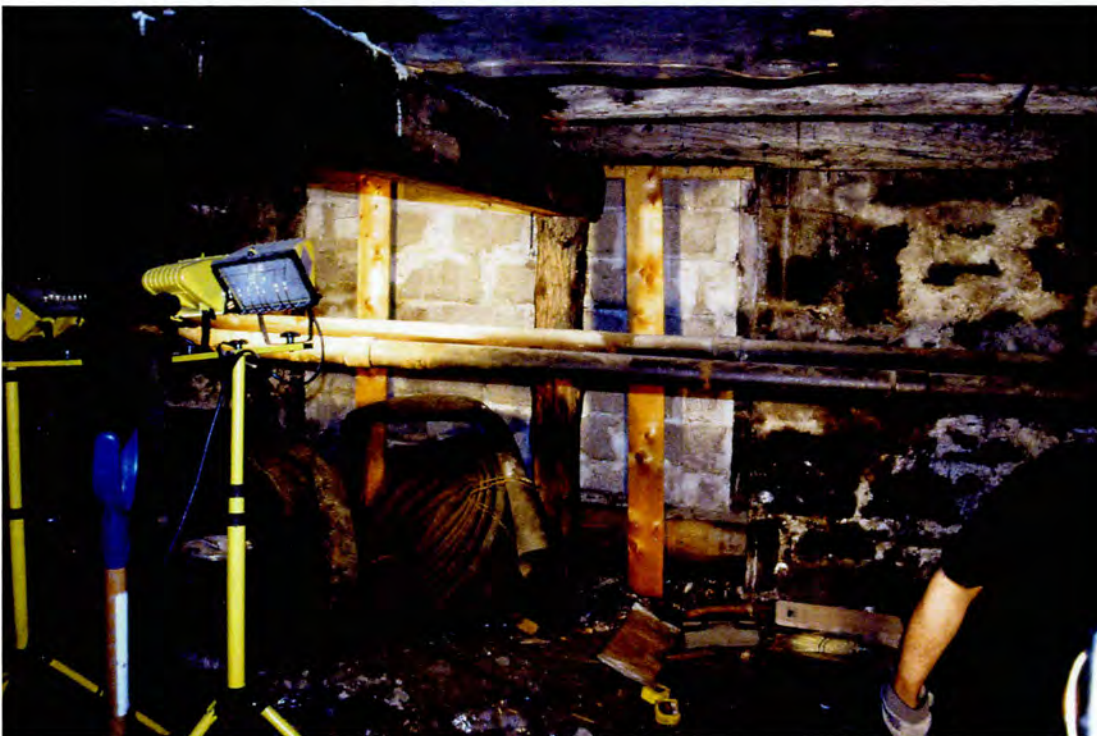
Photo 4 : Bâtiment Robert-Gillespie (I) – Portion centrale du mur ouest des fondations. Détail de la porte murée de blocs de ciment. Présence d'un soupirail comblé de débris dans la partie supérieure de la maçonnerie (BjFj-101-04-D3-21)
