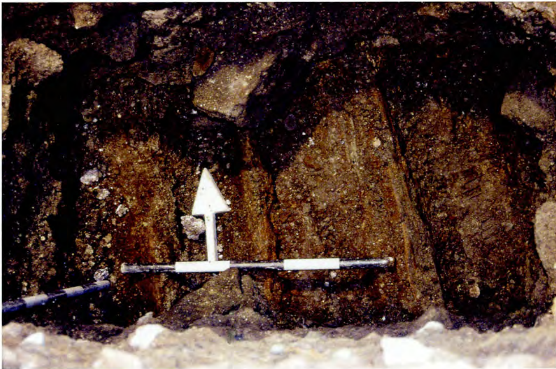
Photo 17 : Bâtiment Robert-Gillespie (I) – Sondage 6A, Surface des longrines du radier de charpente du bâtiment de Joseph Roy – Vue vers le nord (BjFj-101-04-D2-10).
