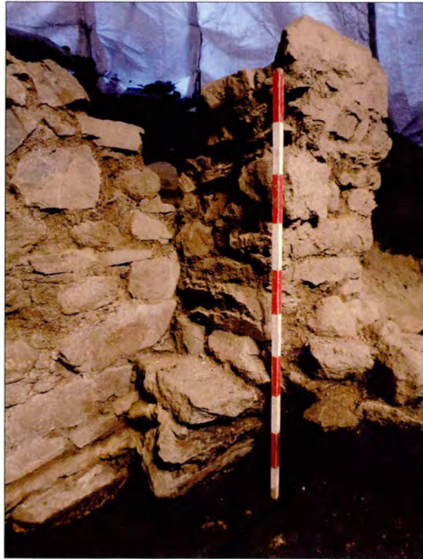
Photo 36 Liaison entre la patte ouest et le corps principal du mur en forme de I St-56, vue vers le sud-ouest. On observe que ces deux éléments de l'ouvrage sont adjacents, sauf au niveau du petit empattement visible à l'avant-plan. (BjFj-101-14-N3-328)
