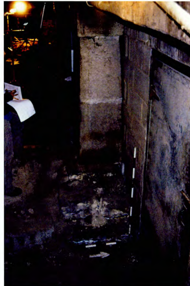
Photo 10 : Bâtiment Robert-Gillespie (I) Socle partiellement dégagé du pilier no 3 — Vue vers le nord (BjFj-101-04-D5-22)
