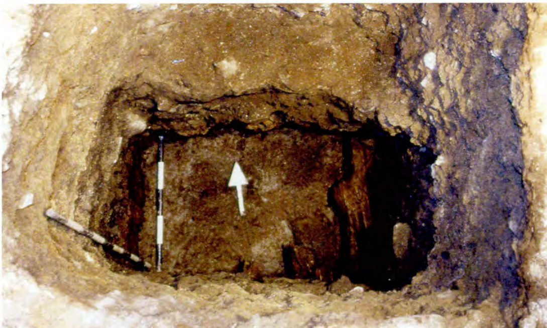
Photo 18 : Bâtiment Robert-Gillespie (I) – Sondage 6A, Base des longrines (sol à gley) du radier de charpente du bâtiment de Joseph Roy – Vue vers le nord (BjFj-101-04-D4-07).
