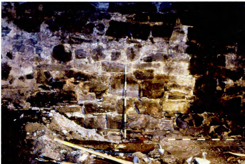
Photo 6 : Bâtiment Robert-Gillespie (I) – Portion centrale du mur sud des fondations. Assises irrégulières assemblées de pierres des champs (BjFj-101-04-D3-31)
