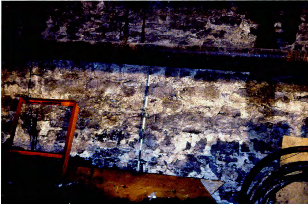
Photo 1 : Bâtiment Robert-Gillespie (I) – Portion centrale du mur nord des fondations (BjFj-101-04-D3-15)
