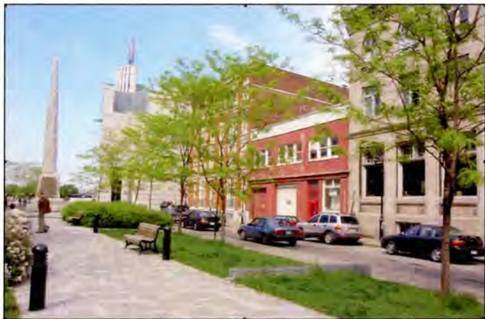
Photo 1. Façade du bâtiment du 214, place d'Youville (cliché hors-série).
