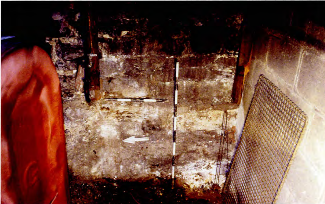
Photo 3 : Bâtiment Robert-Gillespie (I) – Portion nord du mur est des fondations. Détail des empattements mis au jour dans la chambre du réservoir d'huile (BjFj-101-04-D3-05)
