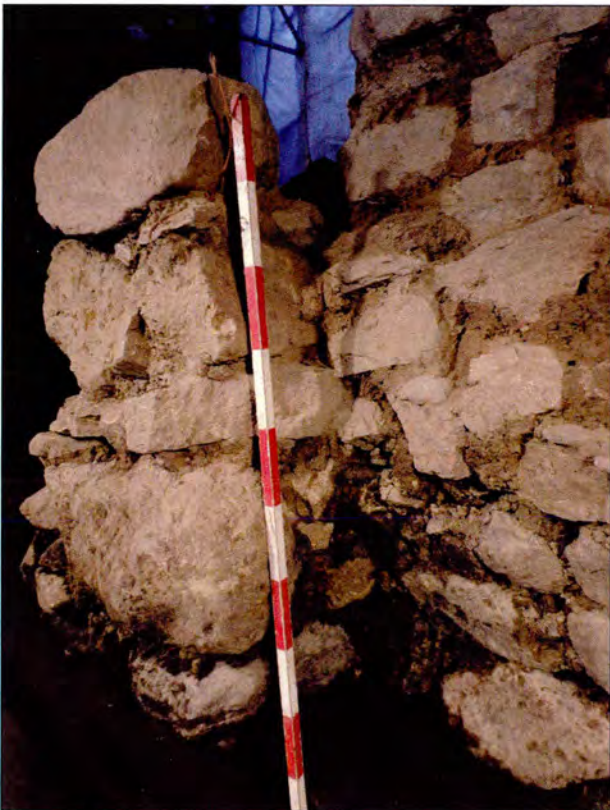
Photo 35 Liaison entre la patte est et le corps principal du mur en forme de I St-56, vue vers le sud-est. On observe que ces deux éléments de l'ouvrage sont imbriqués. (BjFj-101-14-N3-333)
