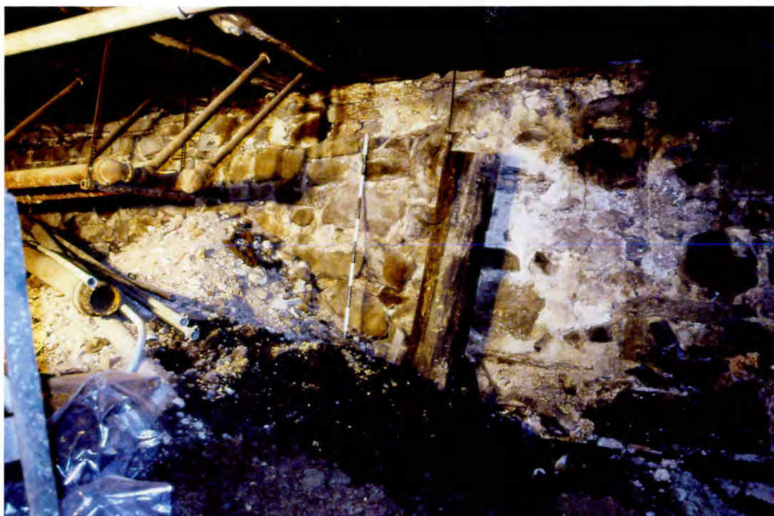
Photo 5 : Bâtiment Robert-Gillespie (I) – Portion est du mur sud des fondations. Assises irrégulières assemblées de pierres des champs (BjFj-101-04-D3-34)
