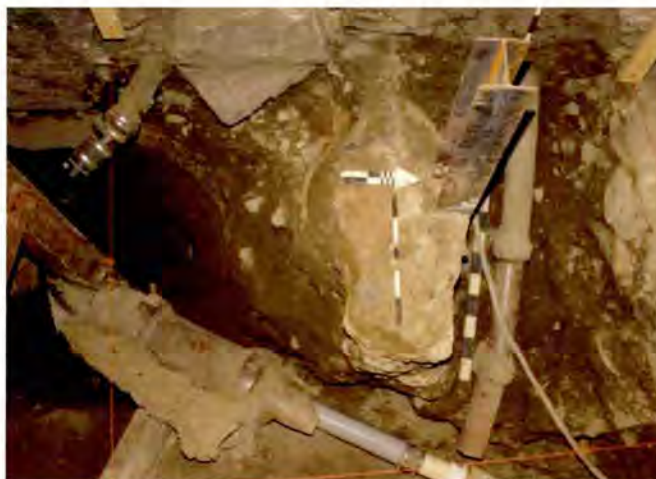
Photo 22. Segments des conduites d'égout et d'aqueduc, sous-opérations 14C et 14D (cliché 13-60).
