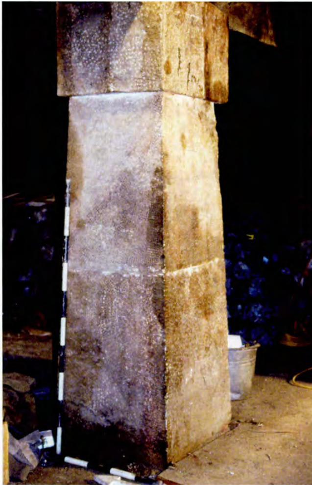
Photo 9 : Bâtiment Robert-Gillespie (I) - Pilier no 2 — Vue vers le nord-est (BjFj-101-04-D5-21)
