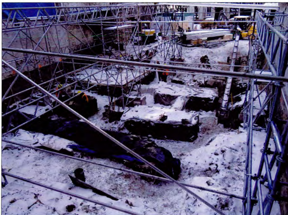
Photo 3 Vue générale du site après le désensablement et lors de l'installation de l'abri, vue vers le nord-ouest (BjFj-101-14-N1-47)
