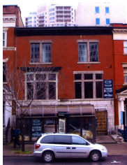
2045-2055, rue Crescent. Vue avant
