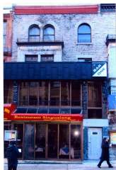
2090-2102, rue de la Montagne. Vue avant
