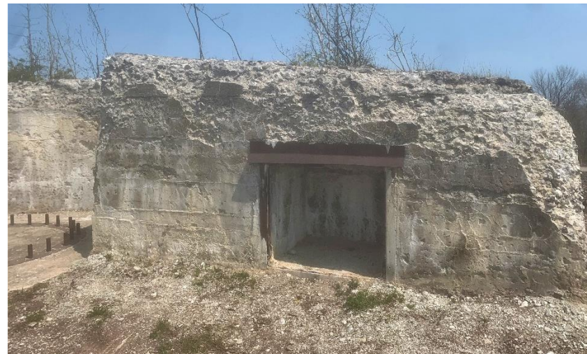
Gauche : vue de la casemate nord-ouest. Droite : détail. Source : CPCQ, 12 mai 2022.
