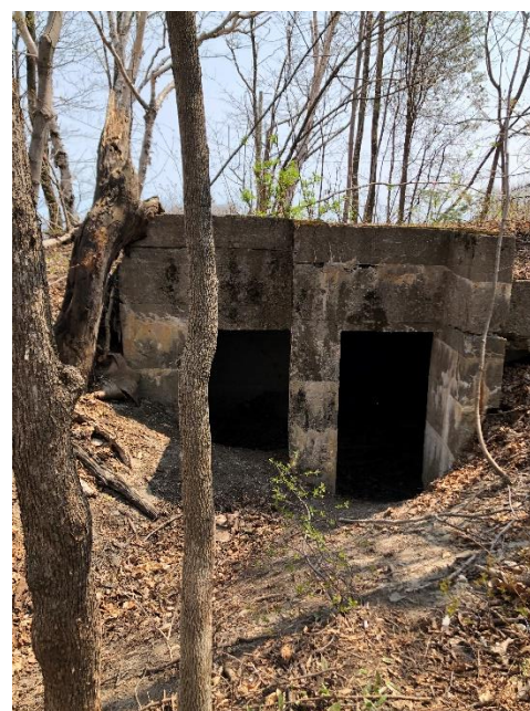
Gauche : intérieur de l'abri à munitions. Droite : entrée sud de l'abri à munitions. Source : CPCQ, 12 mai 2022.
