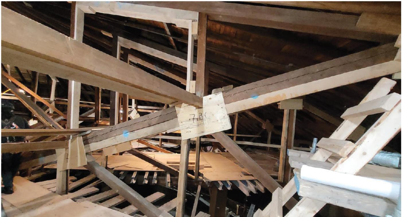
Photo 6 : Membreure nécessitant un renfort mécanique
