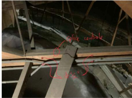
DÉTAILS DE CHEVAUCHEMENT DES PIÈCES DE LA CORDE INFÉRIEURE
