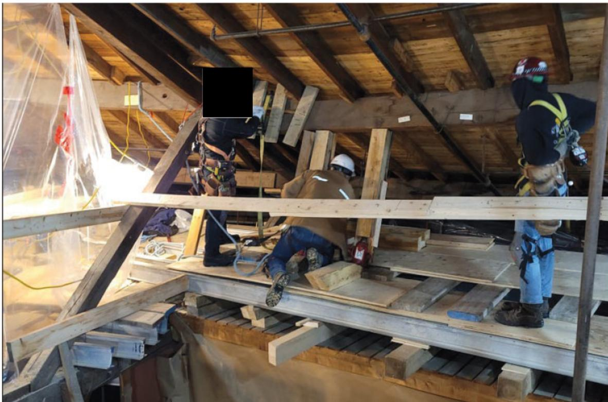
Photo 2 : Installation pour la réparation de la panne à la ferme 14
