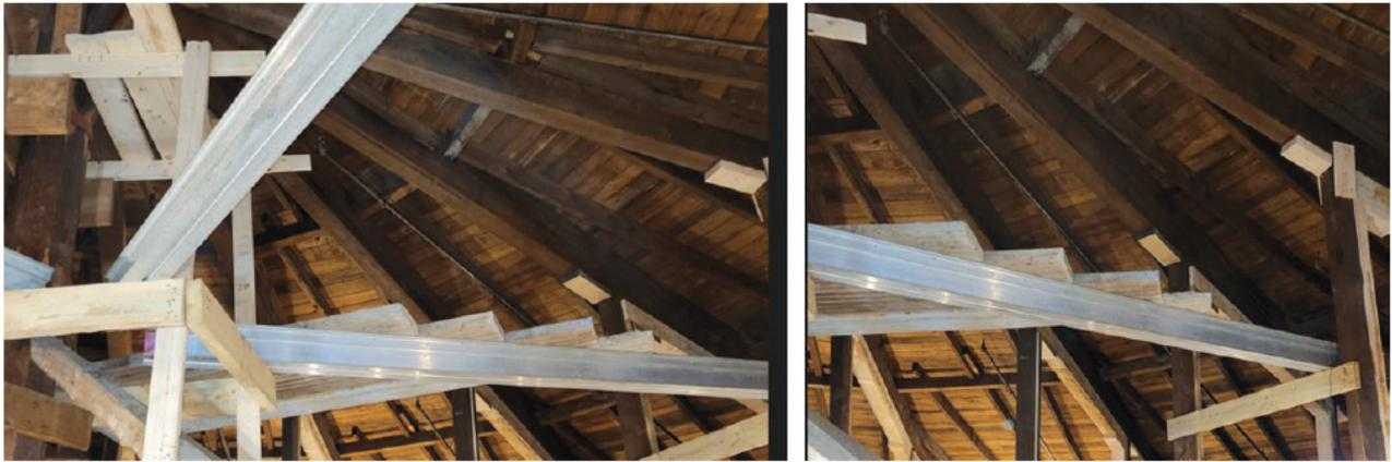
Photos 2 et 3 : Structure temporaire pour installer les blocages
