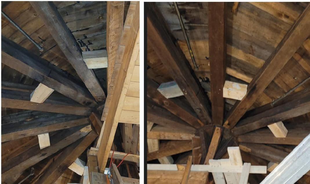
Photos 4 et 5 : Installation des blocages de corde supérieure
