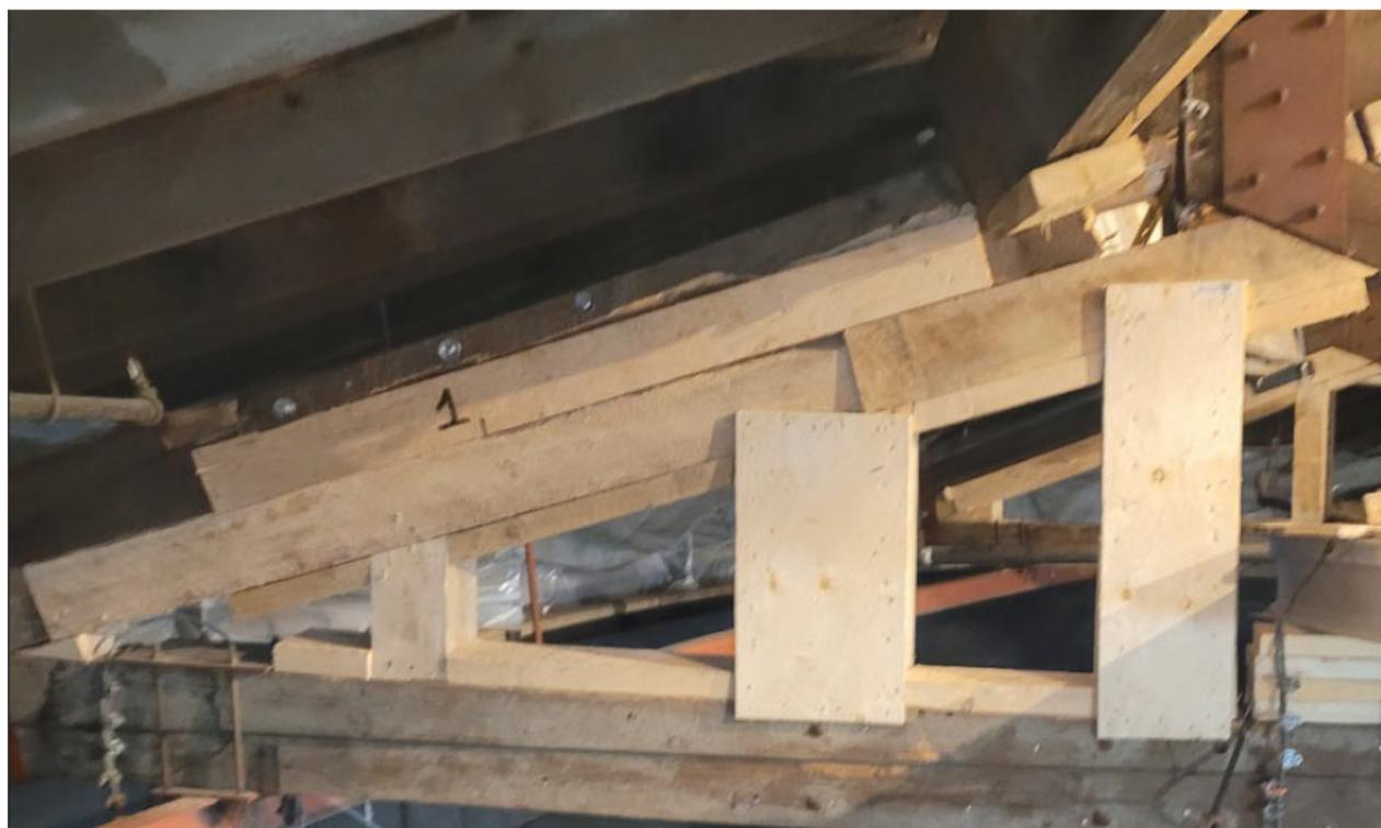
Photo 1 : Réparation de membrure cassée à la ferme 14
