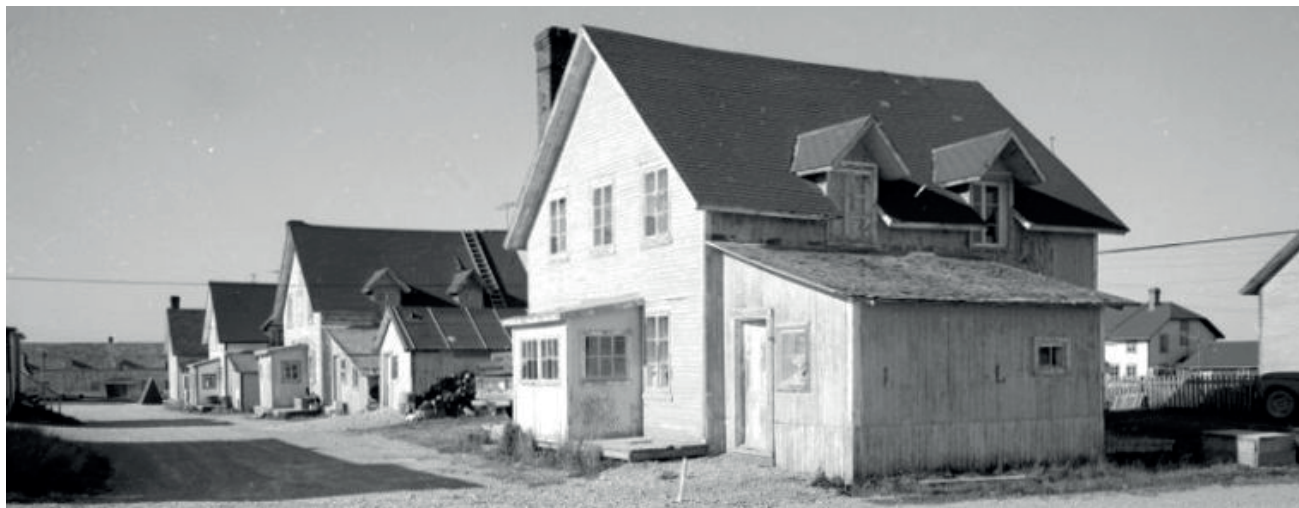
Maisons de la Bacchante et du Fleurus vers 1975. Source : Gilles Langevin. Fonds Ministère de la Culture et des Communications, Office du film du Québec, BAnQ — E6, S7, SS1, D752401-752494z
