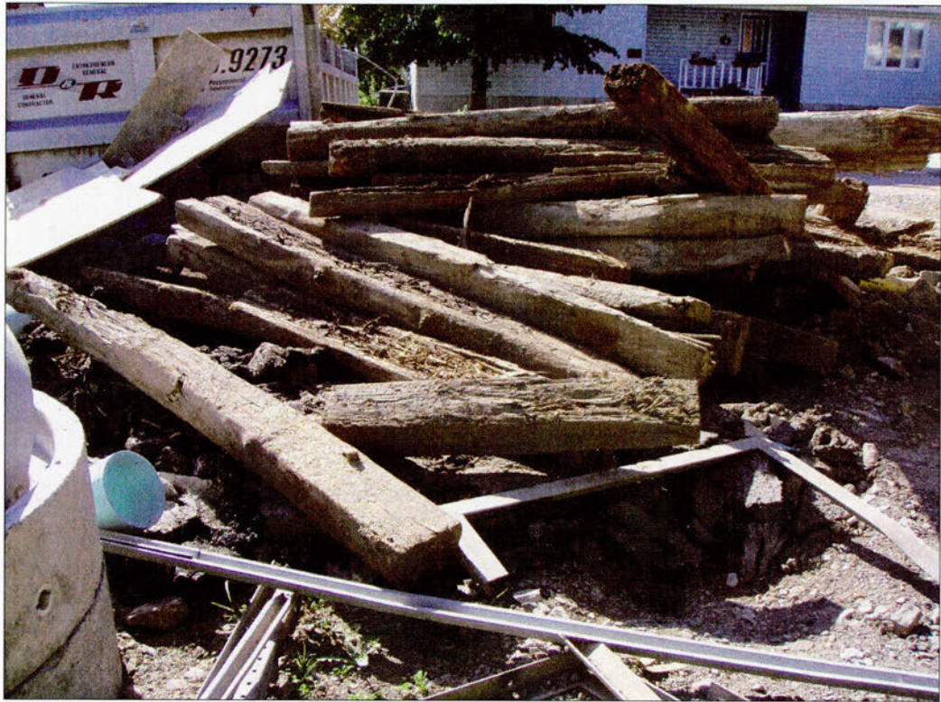
Photo 4.33 Amas des traverses de tramway mis au jour lors des travaux d'égout et d'aqueduc sous la rue Principale à Aylmer. source : AGS09_MF6_040
