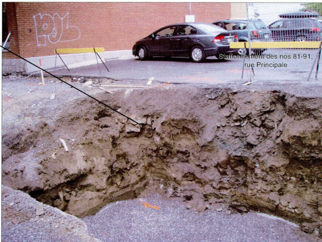
Photo 4.16 Sous opération 2H, Vue sur la section de sol de démolition dans le coin nord-ouest de la sous-opération source : AGS09_MF6_207
