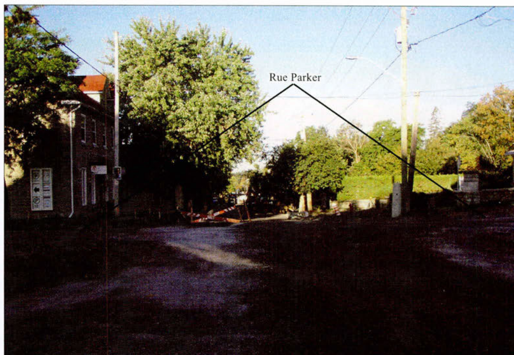
Photo 4.01 Rue Principale vers l'ouest à partir du British Hotel Malgré les remblaiements et rehaussements, la rue descend toujours en pente à partir de la rue Parker. D'ailleurs, le roc est souvent sous l'aménagement de surface en descendant la pente jusqu'à la rue Tiberius environ. Puis, vers l'ouest, il y a eu remblaiement, rehaussement et extension de la rue Principale Sources : AGS09_MF6_472
