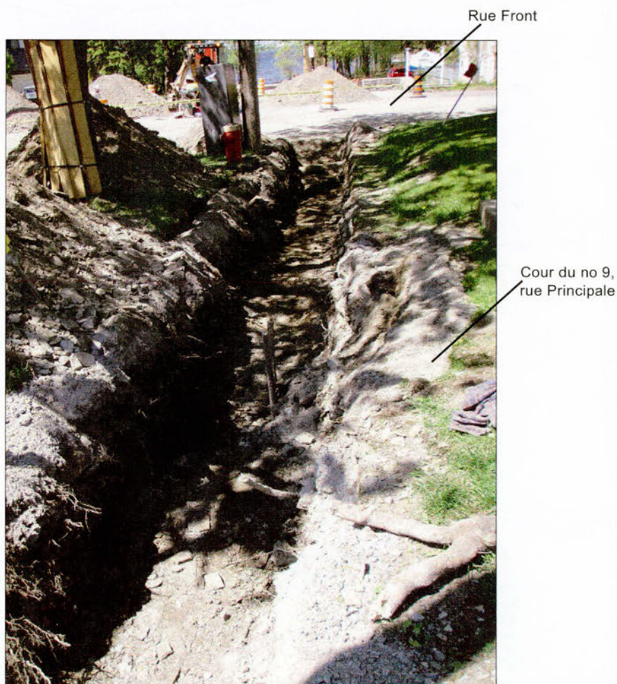
Photo 3.15 Sous-opération 1D à la fin de l'excavation mécanique source : AGS09_MF2_024
