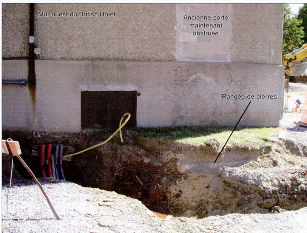
Photo 4.07 Pierres taillées alignées, parallèles à une ancienne porte maintenant obstruée. source : AGS09_MF6_013
