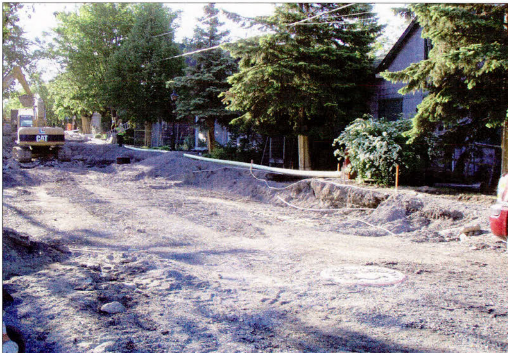
Photo 3.27 Vue sur les travaux d'infrastructure
