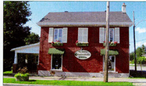
Façade du no 27, rue Principale no 27 rue Principale
