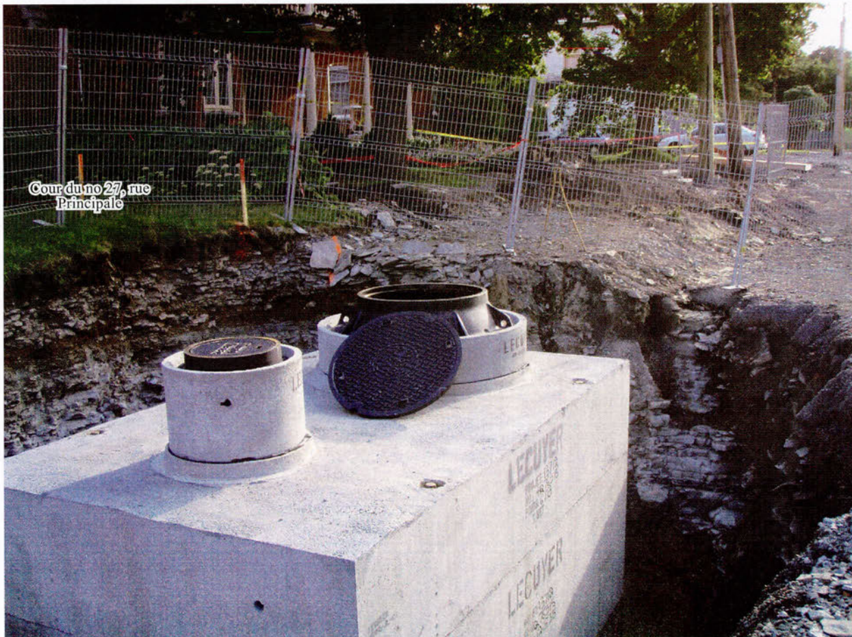
Photo 4.06 Roc à proximité de la surface dans la tranchée du PA-7651 source : AGS09_MF5_075
