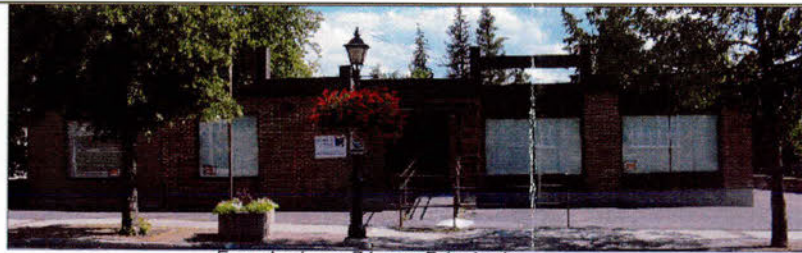
Façade du no 74, rue Principale.
