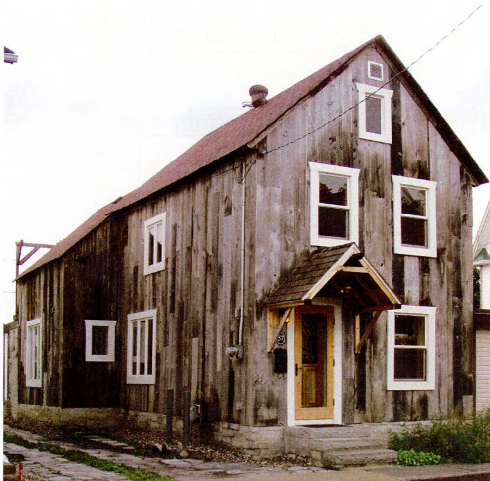
Photo 4.31 Maison de bois construite sur une fondation de pierres à Hull sur la rue de Lanaudière entre Bégin et Coallier.
