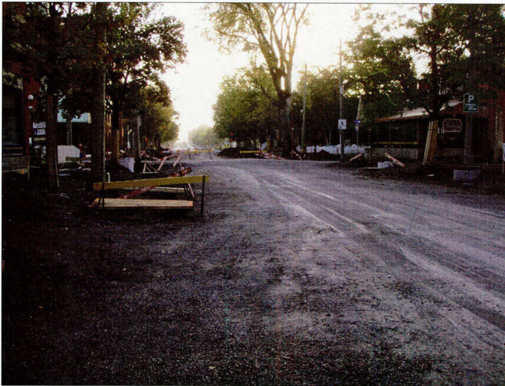
Photo 4.04 Rue Principale vers l'est à partir du stationnement à l'est des nos 81-91 Le relief est maintenant plus plat source : AGS09_MF6_751
