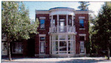
Façade des nos 84-86, rue Principale
