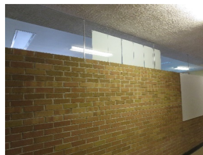
FIGURE 9 : MUR DE BRIQUE SURMONTÉ D'UN BANDEAU VITRÉ
