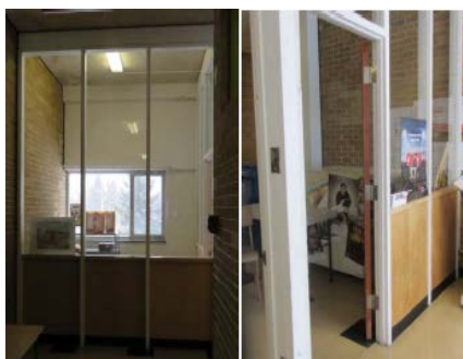
FIGURE 12 : MURS RIDEAUX INTÉRIEURS AVEC PANNEAUX TYMPANS DE BOIS
