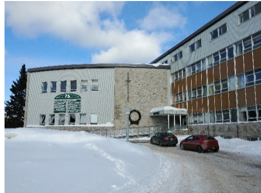
FAÇADE CINTRÉE DU THÉÂTRE
