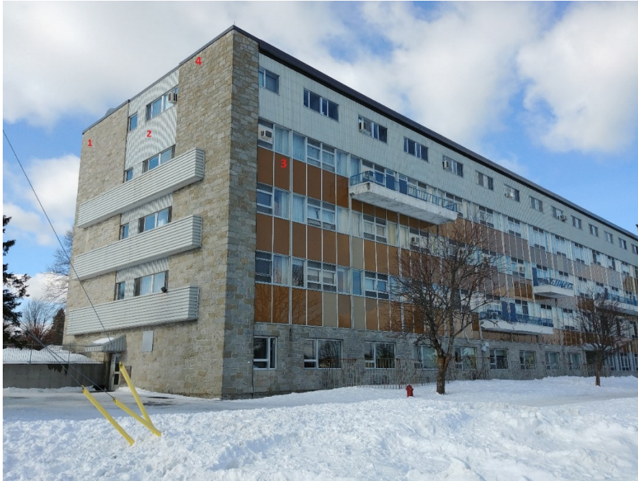
FIGURE 2 : FAÇADE SUD ET EST DU BÂTIMENT
