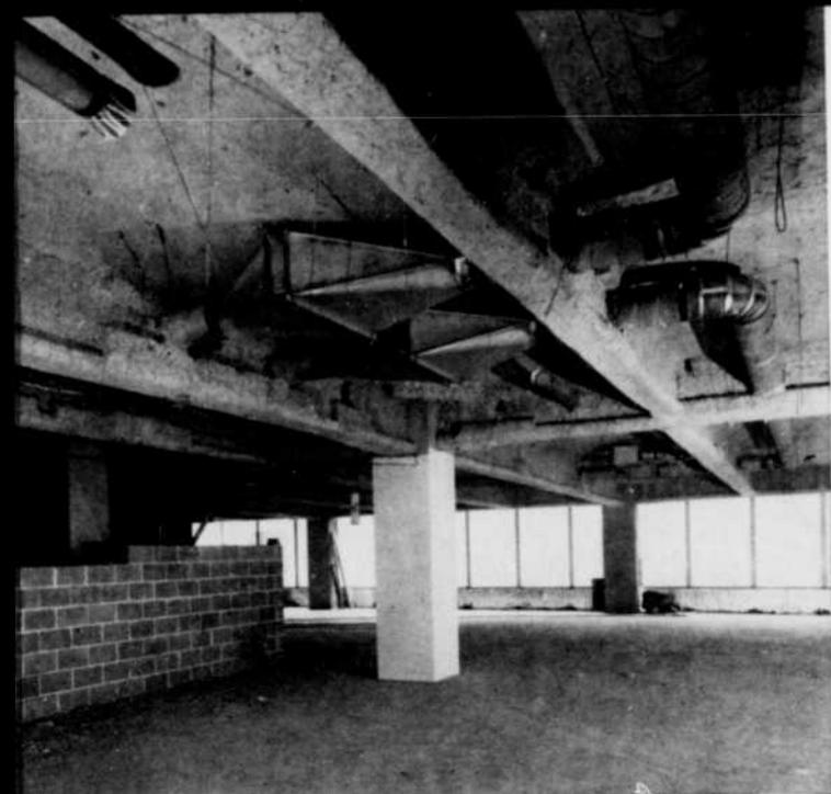
*Les conduites de climatisation passent à travers les poutres d'acier.*
