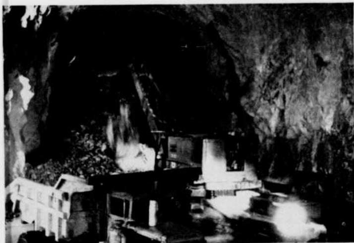
*Intérieur d'un des deux tunnels de 2,200' de longueur sur 47' de diamètre, construits pour détourner la rivière Manicouagan du barrage principal durant la construction. Le sautage périmétrique au XACTEX a permis d'obtenir des parois lisses et uniformes pour les murs et la voûte du tunnel.*
