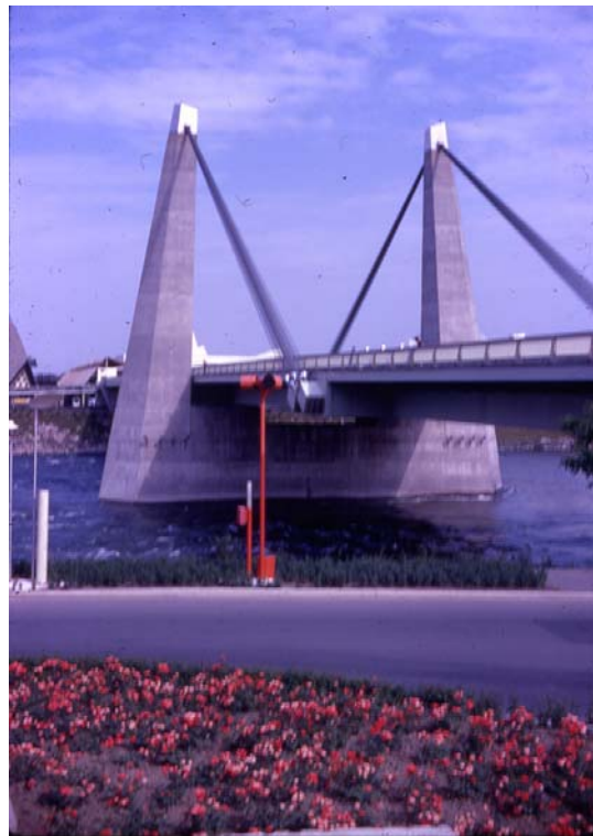
Fig.1 Vue sur le Pont des îles durant l'Expo 67 (1967)
