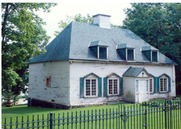
Figure 1 : Etat de la maison en 2010, été 2010 - Ville de Québec
