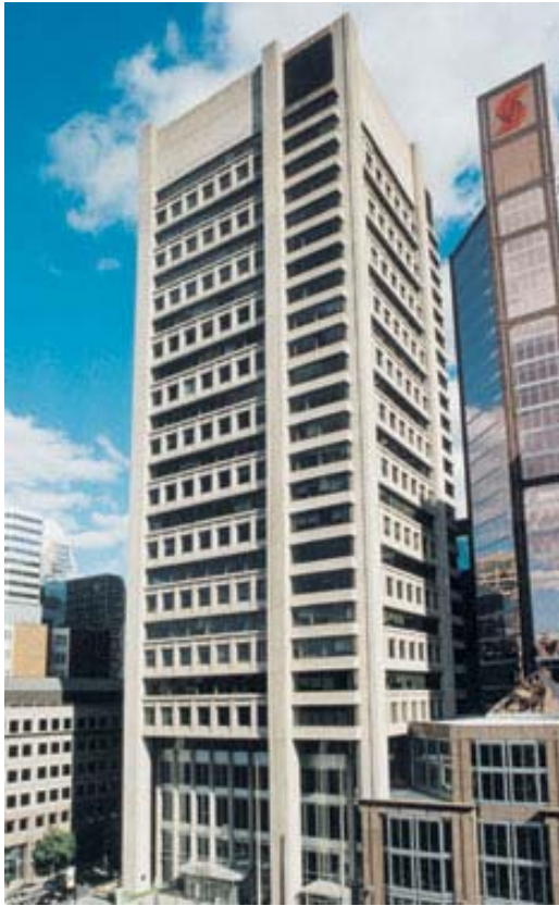
Fig. 6 Rue Sherbrooke Ouest, 1000, Montréal Rosen, Caruso, et Vecsei, architectes (date de la photo inconnue)
