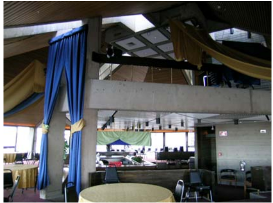
Fig. 7 Vue intérieure du restaurant de la Marinière, premier étage et mezzanine (2004)
