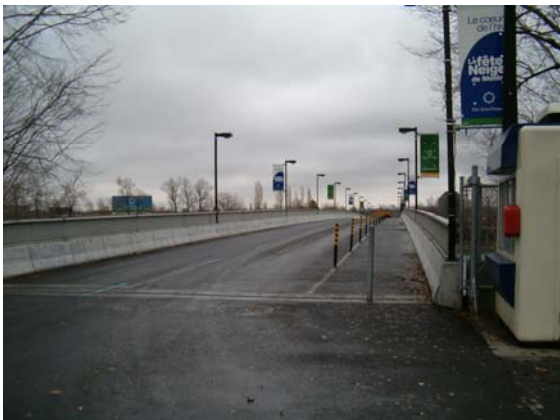
Fig.7 Passerelle du Cosmos vue de la plate-forme actuelle (2004)
