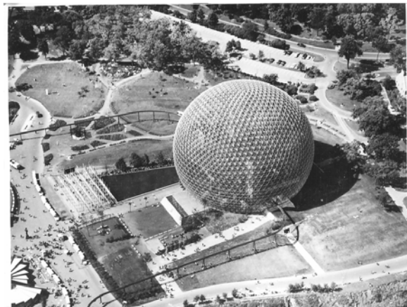
Fig.3 Le Pavillon des États-Unis et son aménagement extérieur (1967)
