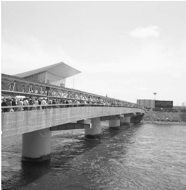
Fig. 2 Passerelle du Cosmos (1967)
