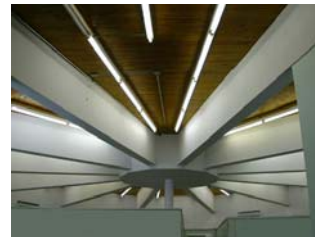
Fig. 7 Vue du plafond (2005)
