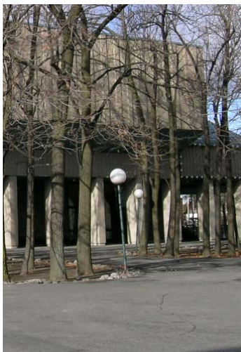
Fig.5 Vue sur un lampadaire de La Ronde face au Jardin des Étoiles (2004)
