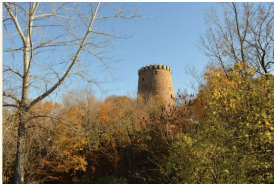
La tour de Lévis au sommet du mont Boullé Photo : WAA
