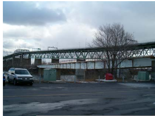
Fig.4 Vue sur le Pont de l'Expo-Express de La Ronde (2004)
