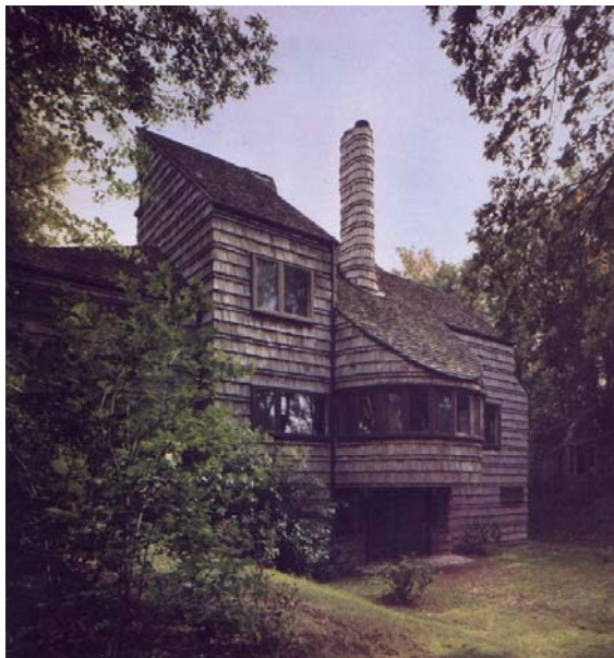
Fig. 6 Résidence Gaboury, Winnipeg (1968)
