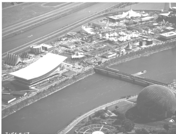
Fig.1 Passerelle du Cosmos pendant l'Expo, lien principal entre le pavillon des États-Unis et le pavillon de l'URSS (1967)
