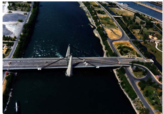
Fig. 5 Vue aérienne du pont des Îles (vers 1988-1992)
