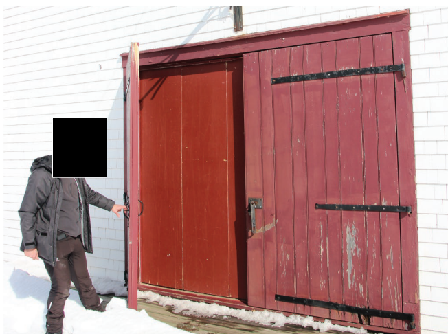
Figure 50 : Les portes principales situées sur la façade sud-ouest sont à doubles vantaux et composées de porte et de contre-portes.
