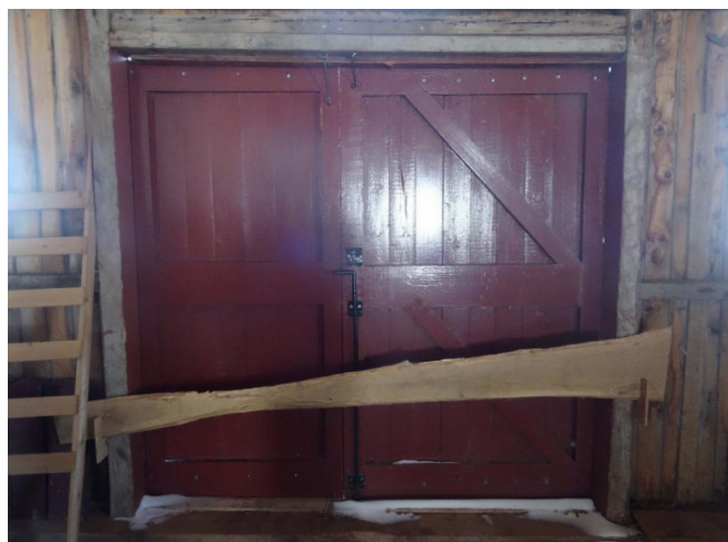
Figure 65 : Une porte double sur la façade ouest donne accès à l'appentis.
