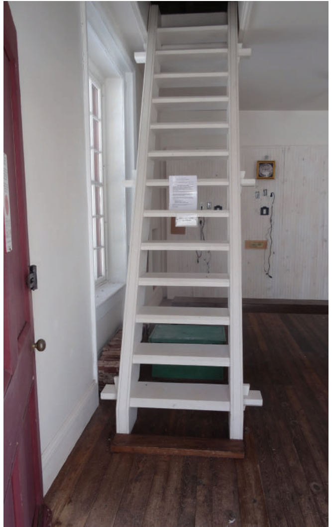
Figure 57 : La trappe d'accès est accessible par une échelle de meunier.
