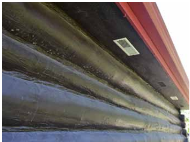
Figure 93 : L'entretoit est ventilé au moyen de grilles sur les pignons ainsi que sur les soffites. Les larmiers ont été modifiés par le passé à une date inconnue.
