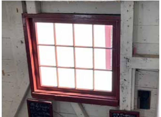
Figure 31 : Quatre fenêtres à douze carreaux sont situées sur la façade ouest. Elles sont en bon état, bien que la peinture commence à s'écailler par endroits.
