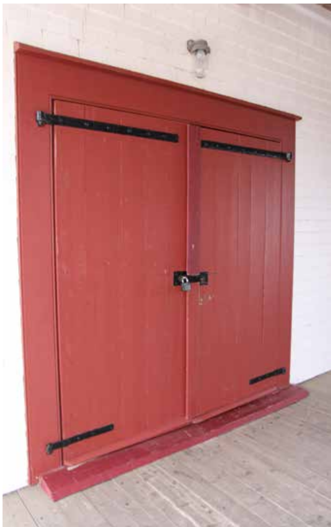
Figure 93 : Le long du corridor central, deux portes doubles et une porte simple donnent accès à la partie est du bâtiment et deux portes doubles à la partie ouest.
