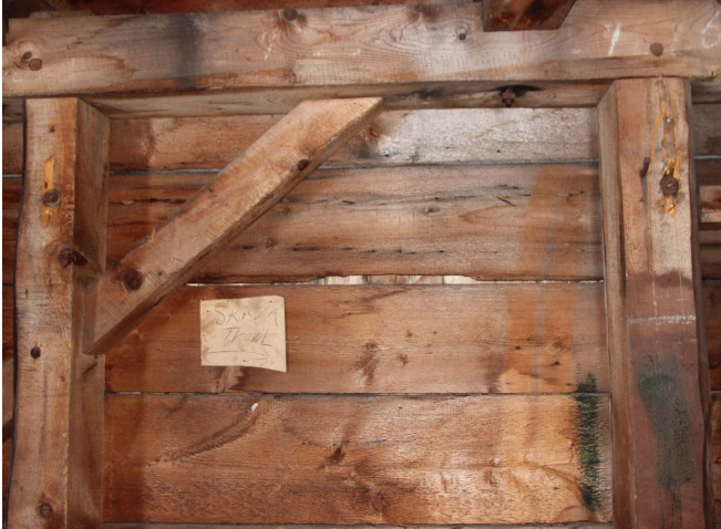
Figure 34 : La structure est recouverte du côté extérieur d'un platelage de bois.
