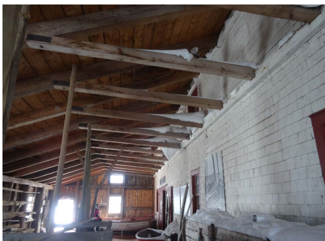
Figure 29 : Les entrails de la charpente de l'appentis s'appuient sur le bâtiment principal et sont parfois soutenus par des poutres.
