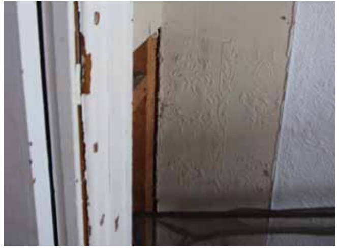
Figure 113 : Au rez-de-chaussée, une ancienne finition de murs en papier texturé est encore visible.
