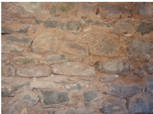
Figure 11 : Les murs de fondation du bâtiment sont en pierres.
