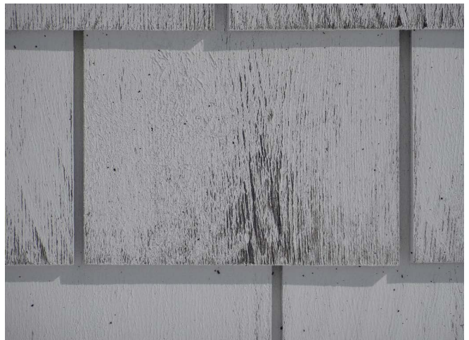
Figure 33 : La peinture sur les bardeaux s'efface, mais les bardeaux sont généralement en bon état.
