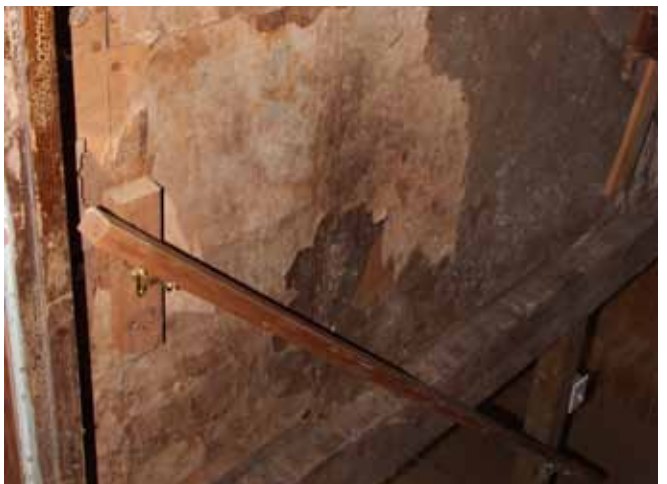
Figure 105 : L'escalier du sous-sol possède une main courante posée en applique sur la paroi latérale.
