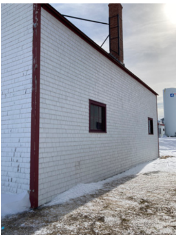
Figure 4 : Façade latérale ouest.
