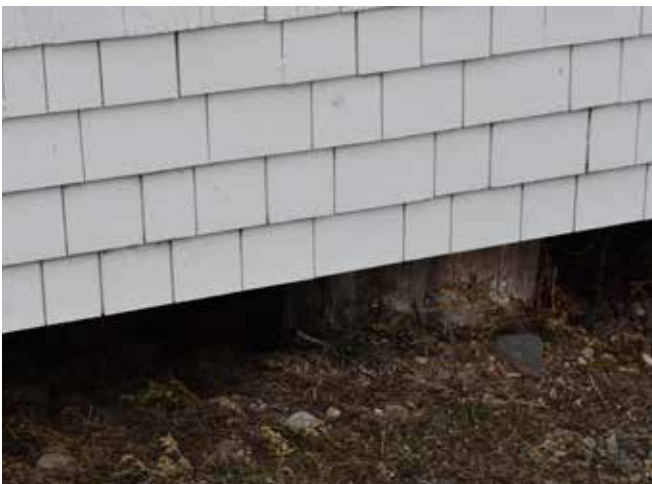
Figure 26 : Les semelles et les poteaux ont ensuite été enfouis dans le sol.
