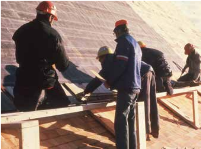
Figure 104 : En 1981, de nouveaux bardeaux de cèdre sont installés sur une membrane. Source: Collection du SHNP. 1981.
