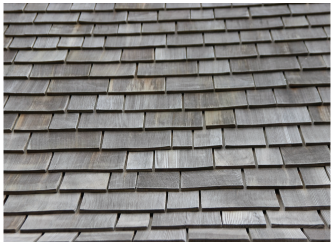
Figure 30 : Le toit est recouvert de bardeaux de cèdre laissés à nu. Les bardeaux de cèdre ont été posés lors des travaux de 1981, car des bardeaux d'asphalte avaient été posés vers 1970.
