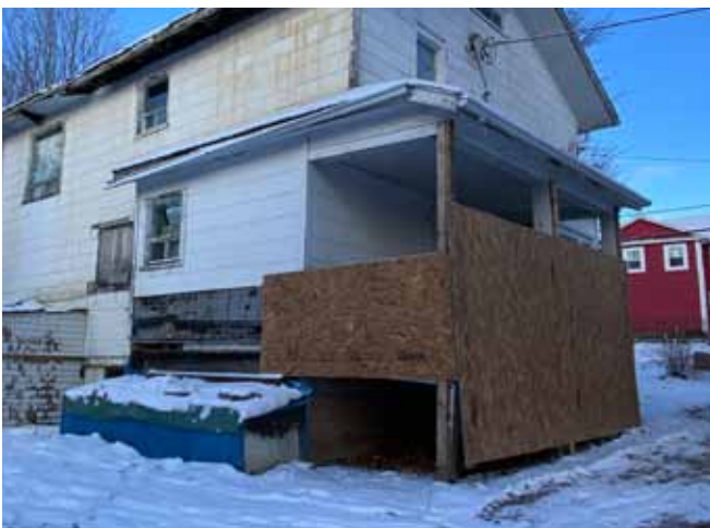
Figure 37 : La résidence possède deux galeries couvertes. La seconde est contiguë à la façade latérale est qui se prolonge sur la façade arrière, créant un petit espace intérieur en saillie de la façade.
