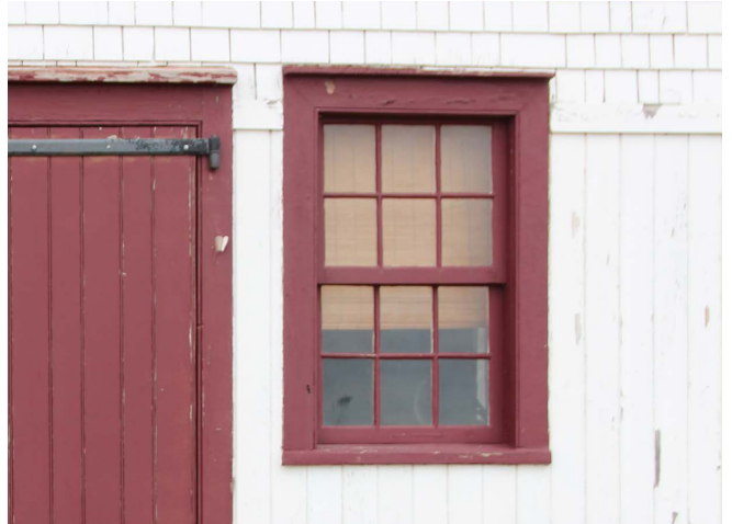
Figure 53 : Le platelage vertical recouvrant la structure des murs de l'appentis est visible depuis l'intérieur.
