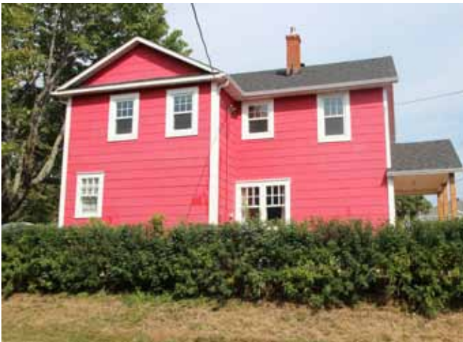
Figure 85 : Elle conserve certaines de ses fenêtres à guillotine en bois d'origine. Le châssis supérieur est divisé en six carreaux, ce qui est courant à cette époque dans l'architecture des communautés anglophones.
