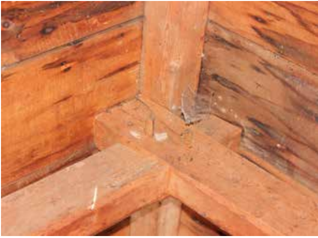
Figure 20 : Le croisement des arbalétriers au faite est tenu par un assemblage à cheville.
