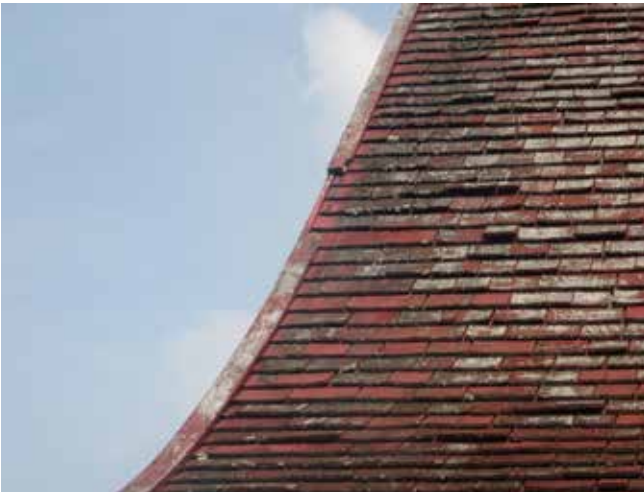
Fig. 44 : Les bardeaux sont peints en rouge mais la peinture est très usée laissant le bois à nu qui s'érode sous l'effet des rayons du soleil.
