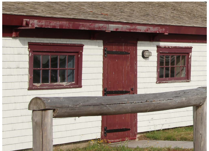
Figure 81 : À l'exception d'une gouttière de bois installée au-dessus de la porte de l'appentis sud, le bâtiment n'est pas muni de gouttières.
