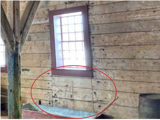
Figure 58 : Les planches intérieures suggèrent que l'appentis donnait probablement accès à la pièce nord-ouest à l'emplacement actuel de l'une des fenêtres de cette façade.
