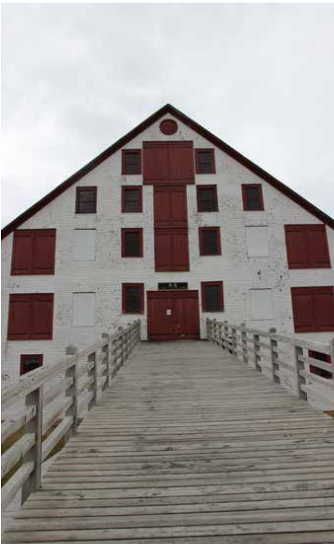
Figure 40 : Une rampe de chargement permet d'accéder aux portes principales situées à l'étage.
