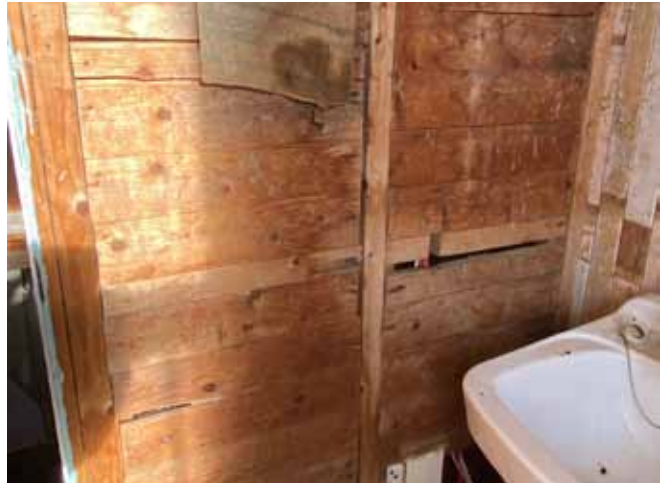
Figure 63 : Des lattes entre les montants servaient pour la pose de la finition.
