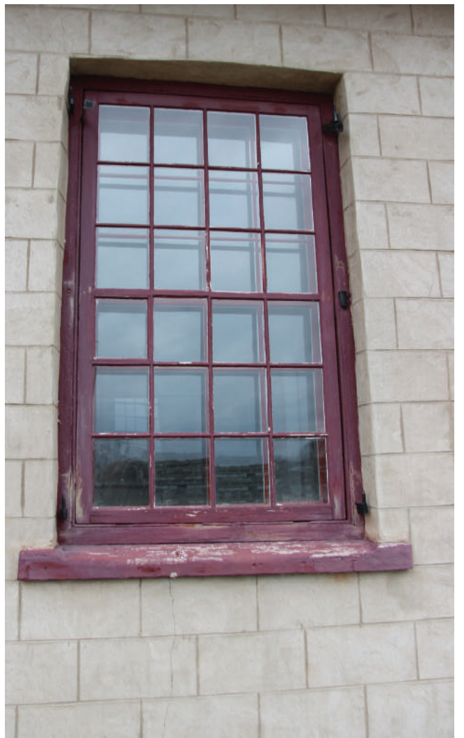
Figure 34 : Le bâtiment possède quatre fenêtres et contre-fenêtres en bois à 24 carreaux.
