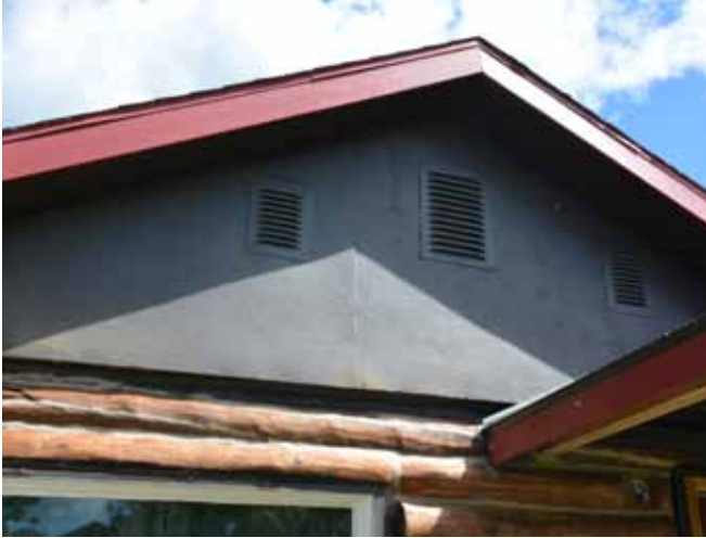
Figure 95 : Les pignons ont également été modifiés. Plutôt que d'être recouverts de planches de bois posées à la verticale, ils sont recouverts de planches de contreplaqué.
