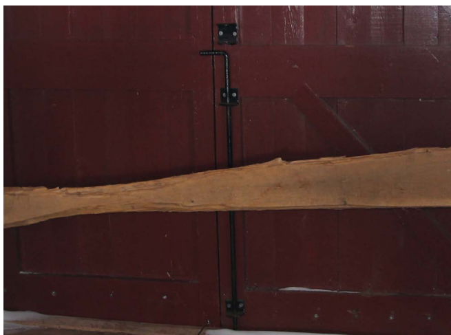
Figure 71 : Elles sont installées dans les cadres avec un système de grandes pentures en fer forgé retenues sur des gonds. La quincaillerie des portes est peinte en noir.
