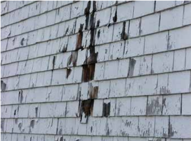
Figure 68 : Plusieurs bardeaux sont pourris et doivent être remplacés alors que d'autres sont tombés.
