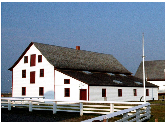
Figure 13 : Après les travaux de restauration de 2005. Collection du SHNP.
