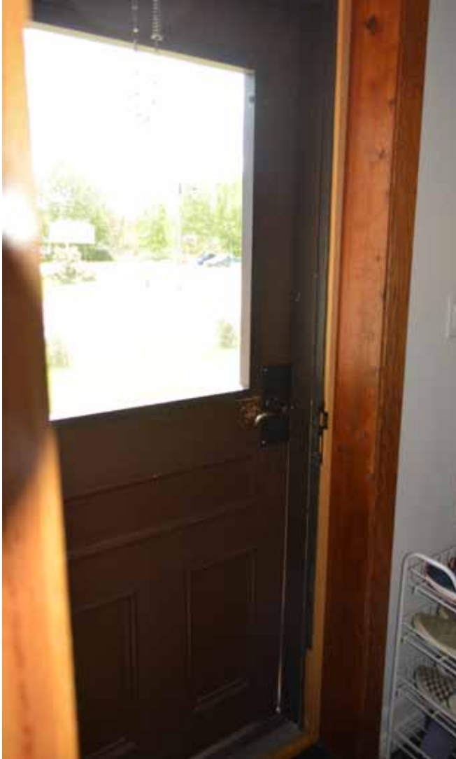
Figure 117 : Elle a remplacé sa porte en bois il y a quelques années, et celle-ci est déjà tordue et la peinture s'écaille.
