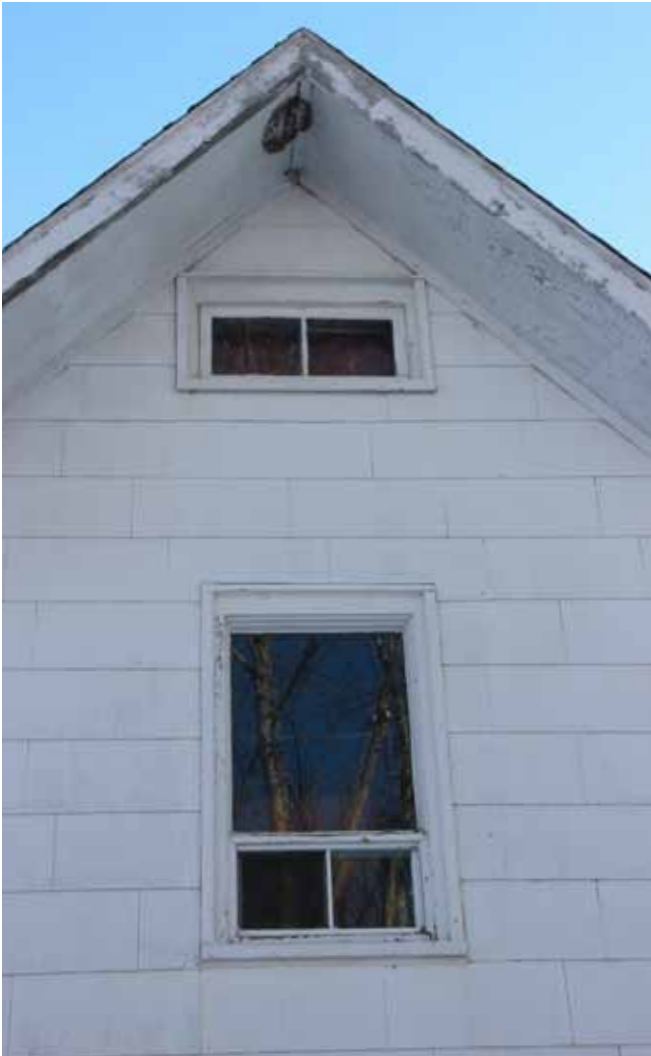
Figure 75 : La plupart des fenêtres de la maison René-Lévesque sont en bois à grands châssis avec guichet en partie basse.
