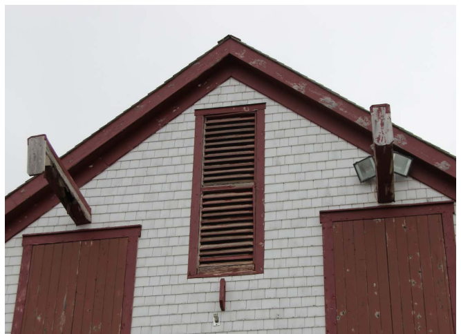
Figure 53 : Des persiennes d'aération ont été installées vers 1940 dans les pignons du volume principal.
