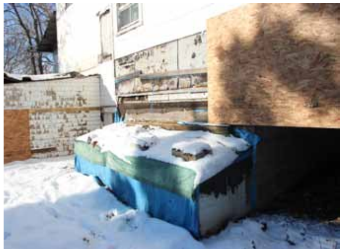
Figure 16 : Une section de fondation en béton coulé sur place est située en saillie de la façade arrière vis-à-vis le coin sud-est de la résidence.
