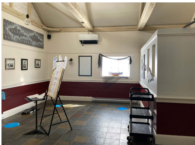
Figure 24 : La charpente de la cookroom est en partie visible depuis la salle à manger. Le platelage est recouvert de gypse, mais les chevrons et entrails de bois sont visibles.
