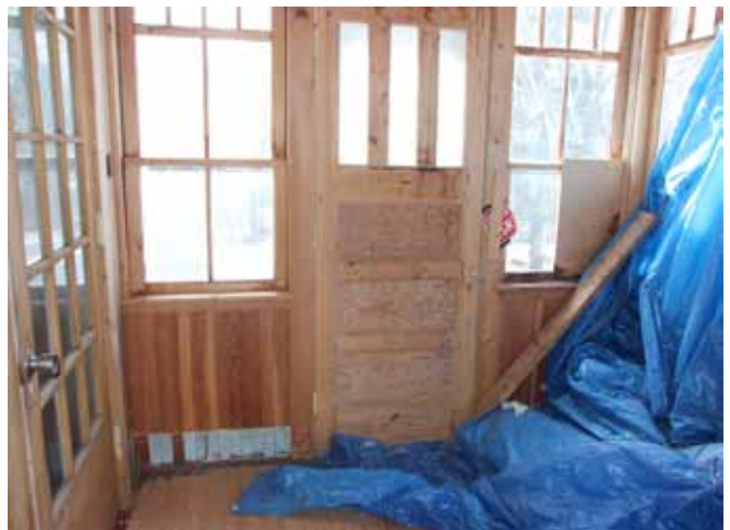
Figure 58 : L'ossature de la véranda est constituée des montants de bois de section carrée entre les fenêtres.
