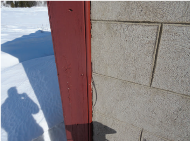
Figure 30 : Des planches cornières en bois peint rouge décorent le bâtiment. Les planches sont rainurées.
