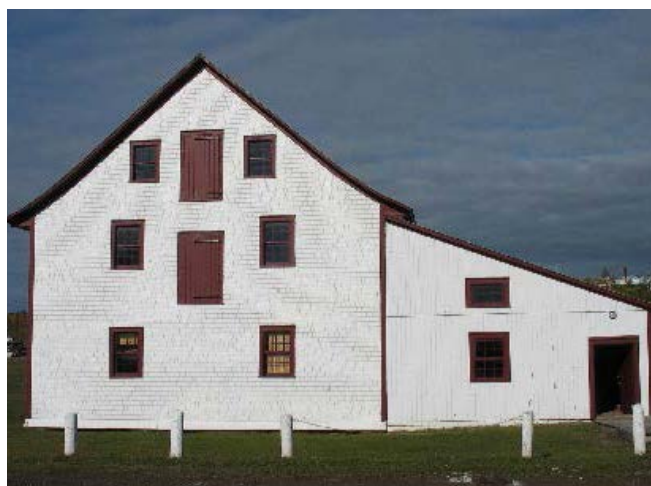
Figure 5 : Façade arrière est.
