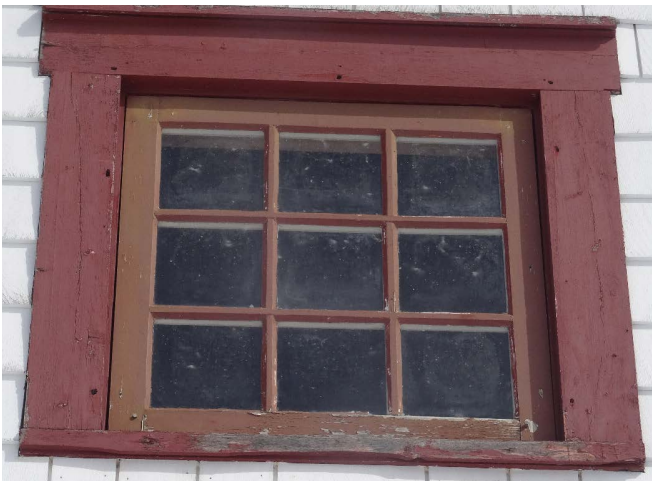
Figure 40 : Les 2 fenêtres situées dans chacun des pignons ont 9 carreaux. Elles ne sont pas peintes de la même couleur que les cadres et chambranles.
