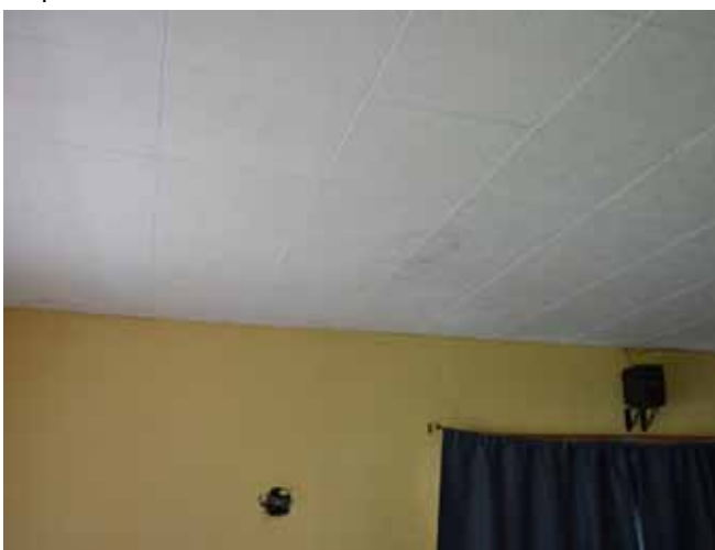
Figure 156 : Les finitions intérieures ont été remplacées par du carton fibre sur les plafonds et du stuc pulvérisé sur les murs.
