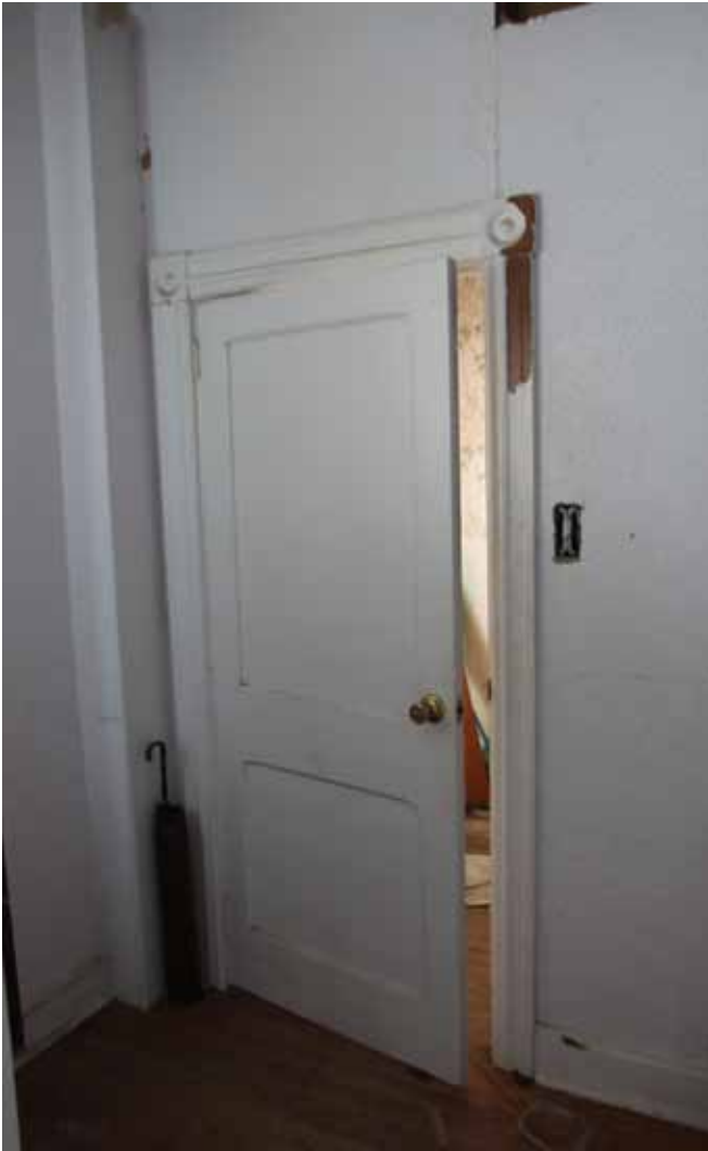
Figure 97 : Les portes intérieures d'origine sont en bois à caissons.
