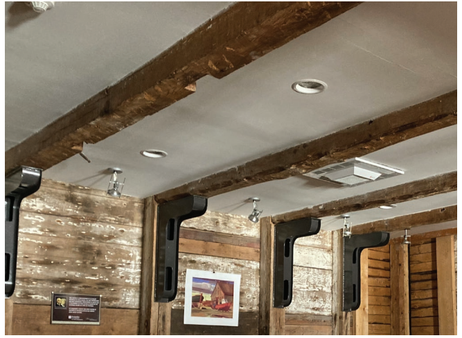
Figure 87 : Des luminaires sont encastrés dans le plafond de gypse de la boutique.
