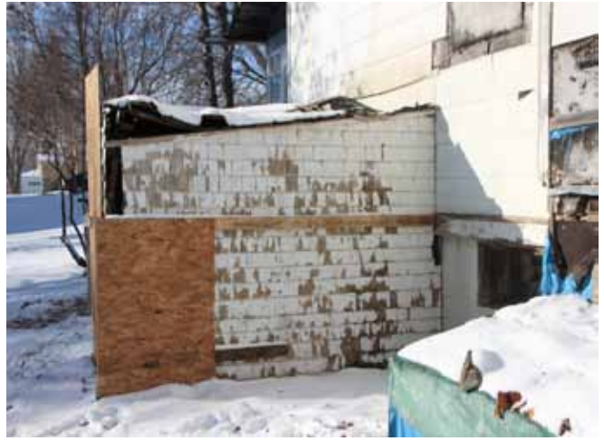
Figure 61 : Un appentis recouvert de bardeaux de cèdre est également contigu à la façade arrière sud.
