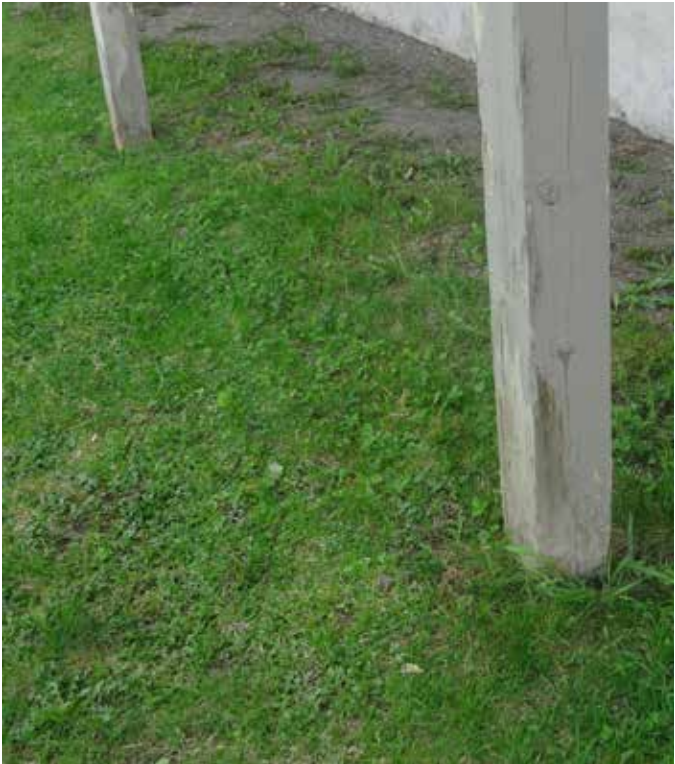
Fig. 28 : Les colonnes de bois des galeries reposent sur des piliers de béton encastrés dans le sol.
