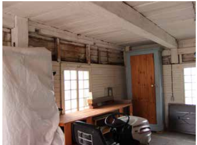
Fig. 63 : Les finis intérieurs du bâtiment se composent de planches de bois peintes en blanc.
