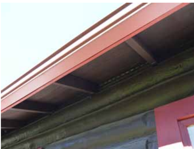
Figure 16 : Soffite original en planches de bois type 1" x 6" de la maison témoin. 123, avenue Perrault.
