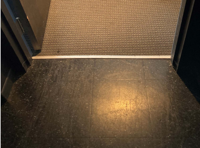
Figure 98 : Le plancher de la loge et de la scène sont recouverts de linoléum.
