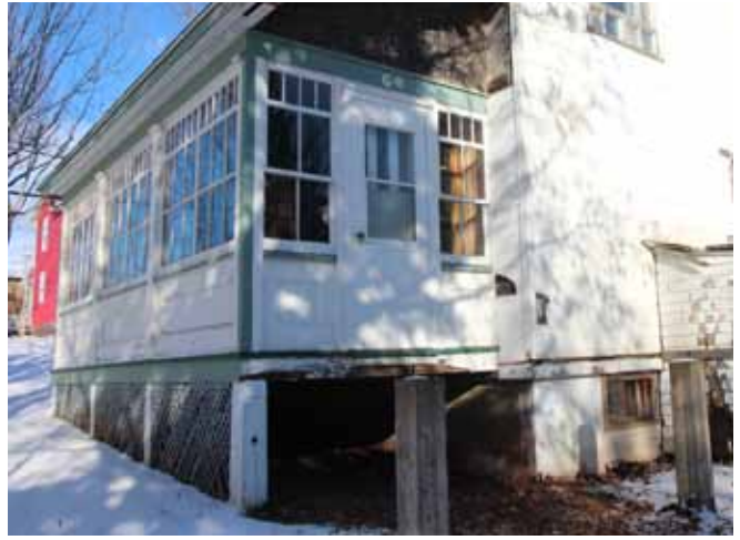
Figure 40 : Une véranda fait toute la longueur de la façade latérale ouest. Elle est supportée par des piliers de béton peint en blanc.
