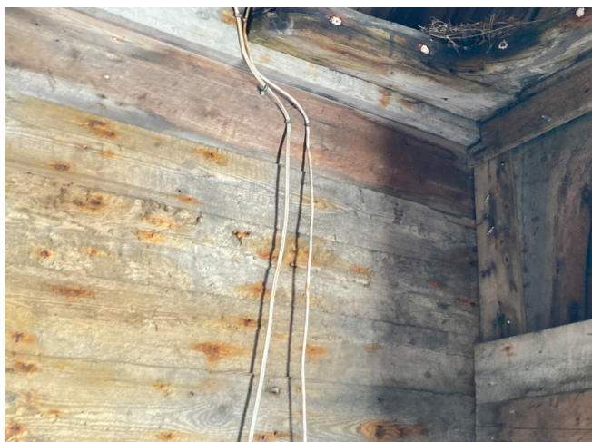
Figure 32 : Les murs sont recouverts de planches de bois laissé à nu. Le chaulage des murs intérieurs est visible par endroits.
