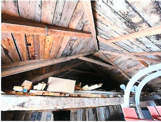
Photo #12 La structure du toit est en bon état.
