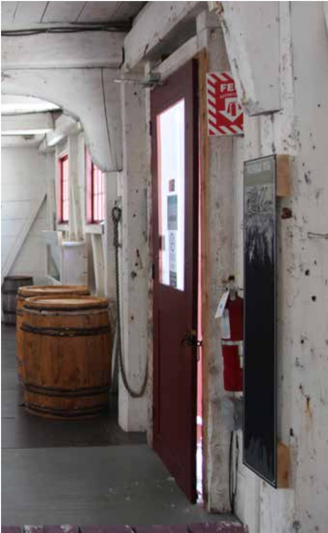
Figure 36 : La porte sur la façade ouest est munie d'une contre-porte. Elle a été ajoutée lors de travaux de 1989 en remplacement d'une des cinq fenêtres d'origine sur cette façade.
