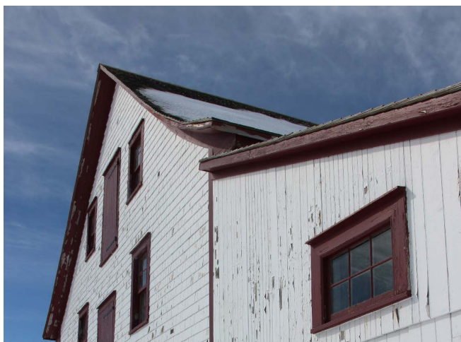
Figure 25 : Le volume principal de la charpenterie est surmonté d'un toit à deux versants droits avec larmiers recourbés dans la partie inférieure des versants.
