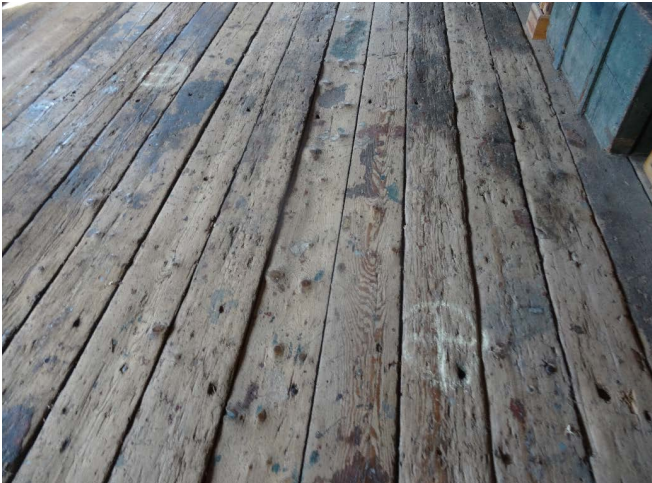
Figure 16 : Le plancher du volume principal est composé d'un platelage de bois déposé sur un système de poutres et poutrelles.
