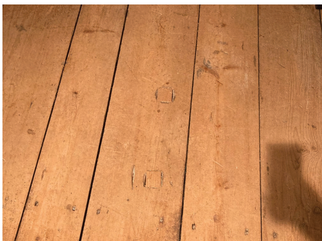
Figure 83 : Le plancher de l'étage est en planches de bois verni. Des traces d'usages antérieurs sont visibles sur le plancher.
