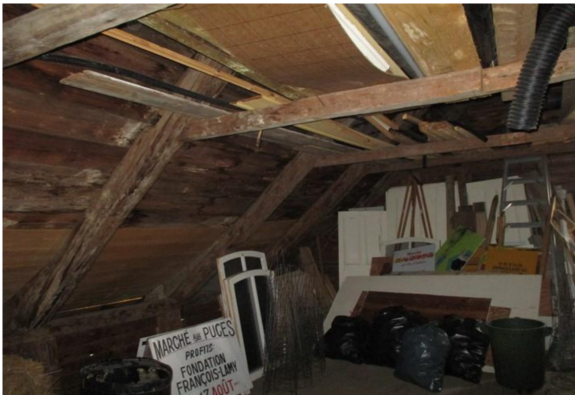
Photo 2: Structure existante supportant la toiture
