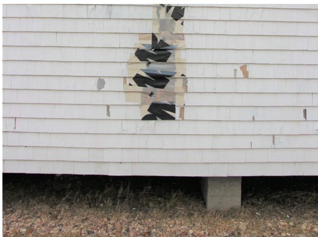
Figure 15 : Le bâtiment a été soulevé et des piliers de béton ont notamment été ajoutés sous le bâtiment en 2004-2005.
