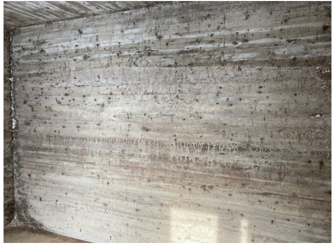
Figure 30 : Des traces du coffrage utilisé pour aménager le coffre-fort dans l'Office Robin sont visibles.
