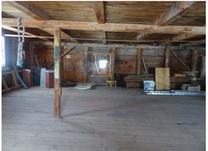
Figure 19 : Le plancher de l'étage est en bon état.
