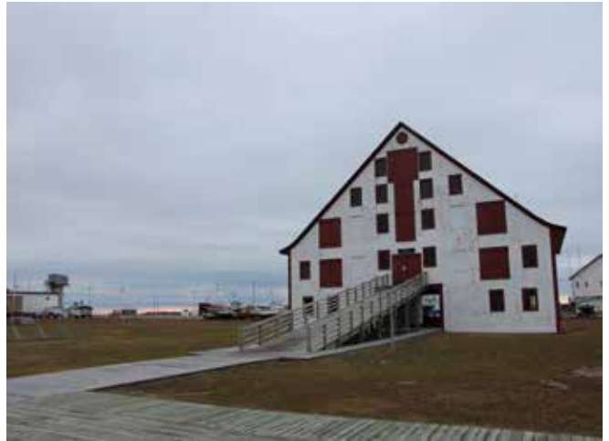
Figure 138 : Un trottoir de bois donne accès au bâtiment et permet de relier l'entrepôt au hangar.
