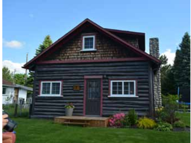
Figure 100 : Le 101, avenue Perrault est une résidence de type A ayant conservé, à l'extérieur, un degré élevé d'intégrité patrimoniale.
