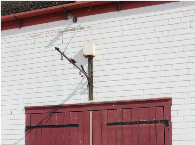
Figure 74 : Sur la façade principale, une potence en fer forgé surmonte les portes double.
