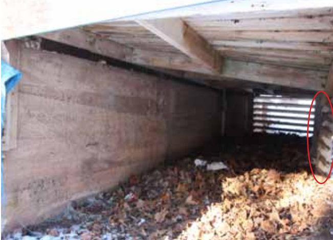
Figure 9 : Les fondations sont constituées de murs de béton coulé sur place et laissé à nu. Le plancher de la galerie contiguë à la façade latérale est supporté par des poteaux de bois.
