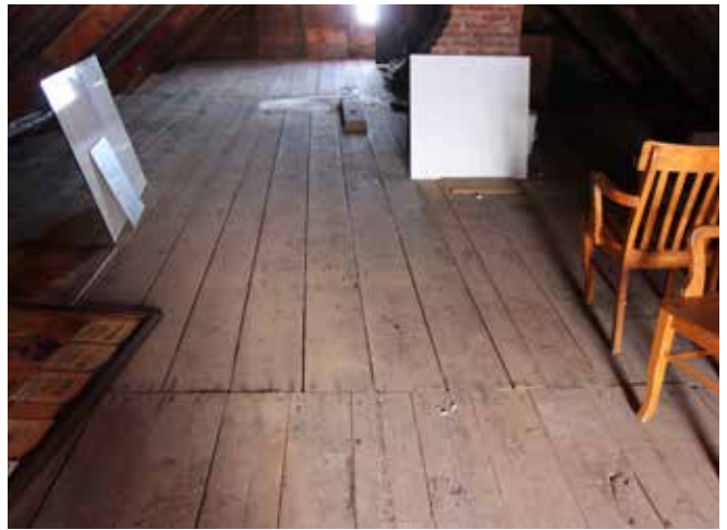
Figure 51 : Le plancher de l'étage est en planches de bois laissé à nu généralement en bon état.
