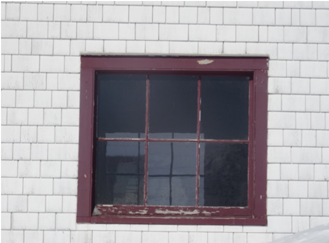
Figure 29 : Les fenêtres sont en bon état, bien que la peinture s'écaille par endroits.
