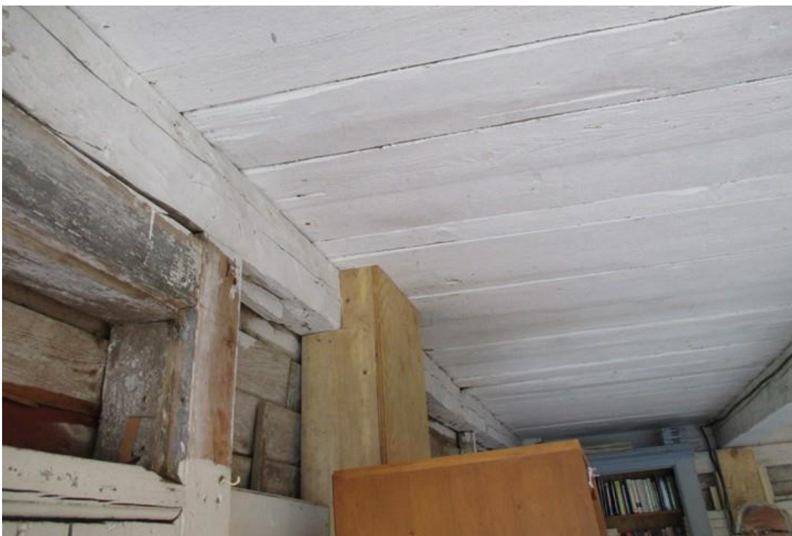
Photo 7: Renfort de bois sur la colonne existante
