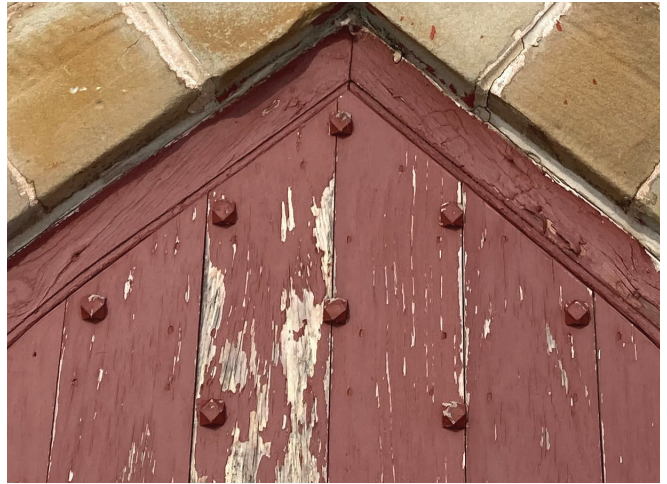
Figure 27 : La porte à simple vantail est formée d'un assemblage de planches verticales en bois et ornée de chevilles en bois peint de la couleur Rouge Navajo 4076-85 de la compagnie SICO.
