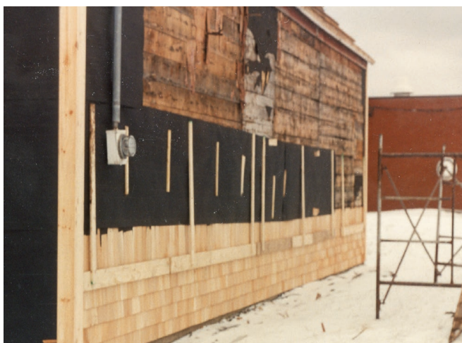
Figure 18 : La structure des murs est composée d'un système de poutres et colonnes en bois massif recouvert d'un platelage de bois du côté extérieur. Collection du SHNP. 1989.
