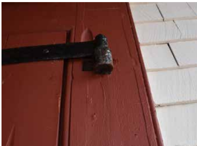
Figure 88 : Les portes sont installées dans les cadre avec un système de grandes pentures en fer forgé retenues sur des gonds.
