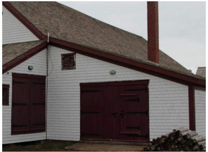
Figure 55 : Une persienne a également été ajoutée sur le mur ouest de l'appentis sud.
