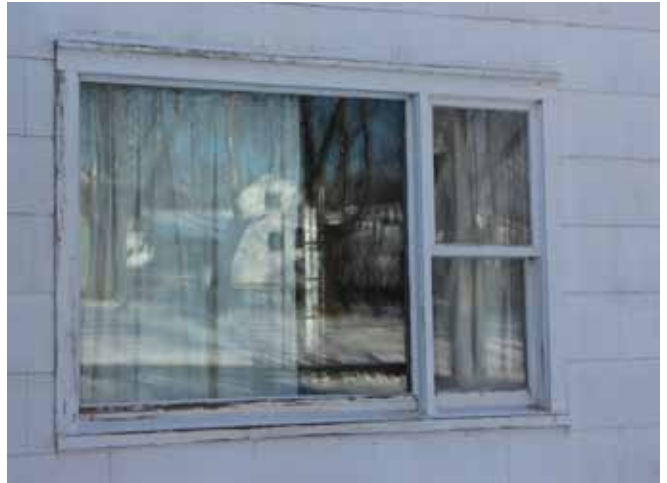
Figure 76 : Les ouvertures des deux fenêtres au rez-de-chaussée de la façade avant ont été élargies et possèdent des fenêtres à grand châssis avec une partie ouvrante à guillotine.
