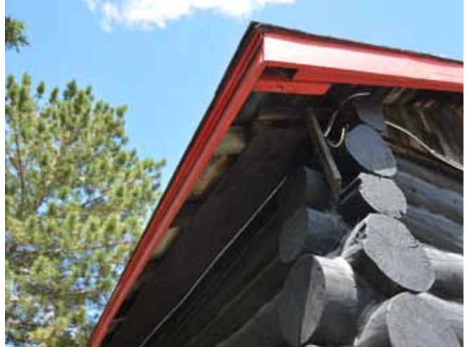
Figure 130 : Sur certains larmiers, le contreplaqué ne se poursuit pas jusqu'à l'extrémité des chevrons, permettant à l'air de passer.
