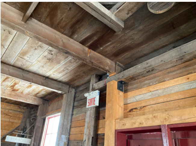
Figure 23 : Certains éléments structuraux ont été remplacés lors des travaux de restauration de 2003.
