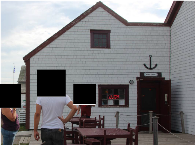
Figure 62 : Sur la cookroom, une porte simple donne accès au restaurant depuis la façade nord.
