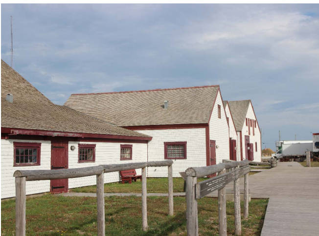
Figure 146 : Un trottoir de bois donne accès au bâtiment depuis la façade sud et permet de relier le hangar à bois aux autres bâtiments du site.
