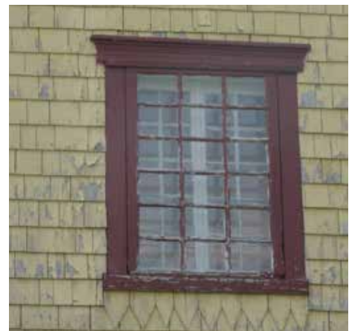
Fig. 27 : La plupart des contre-fenêtres ont été retirées.
