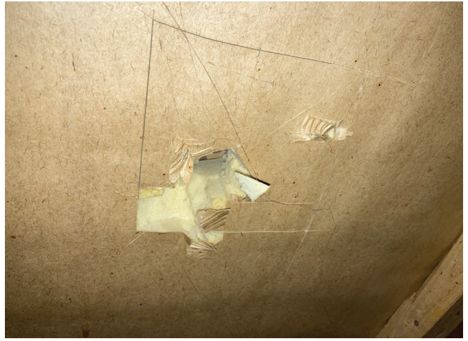
Figure 59 : Un isolant est également installé directement sur le platelage de la toiture.
