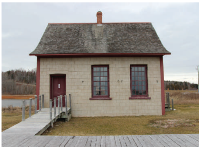
Figure 16 : La rampe est en bois nu et composée de planches de bois. Les garde-corps sont composés de poteaux de section carrée reliés entre eux par des cordes.
