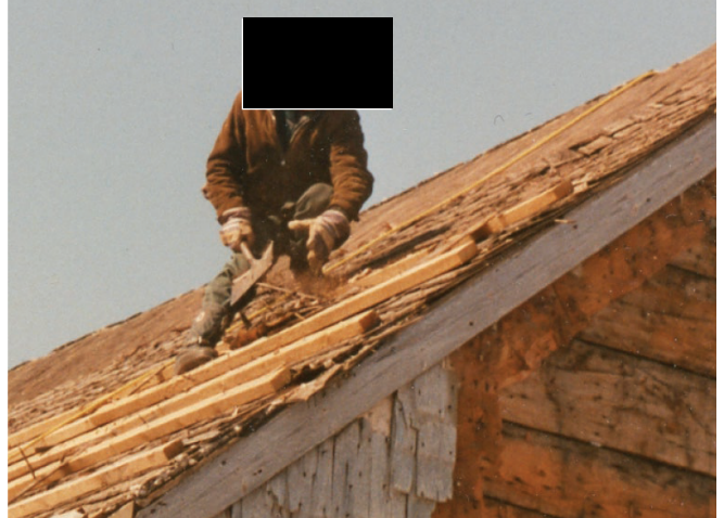
Figure 27 : Une photographie prise pendant les travaux de restauration de 1989 montre la présence d'écorce de bouleau sous l'ancien bardeau. Collection du SHNP.
