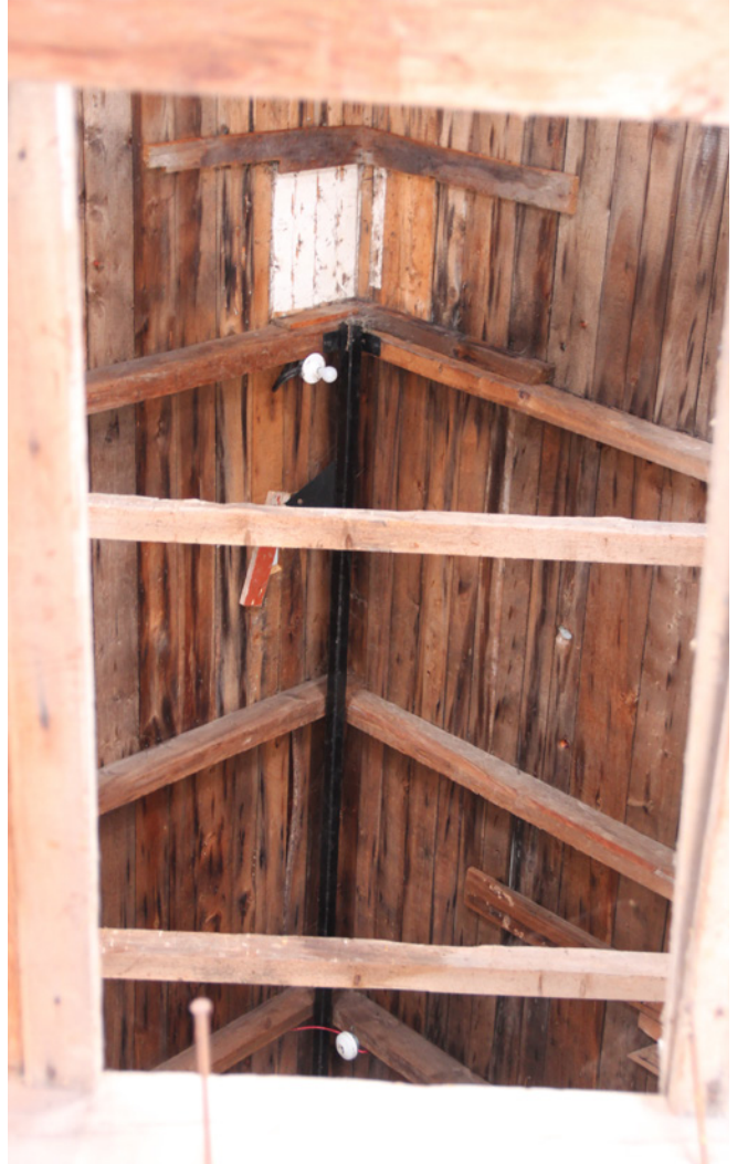
Figure 19 : Une poutre métallique consolide la charpente.
