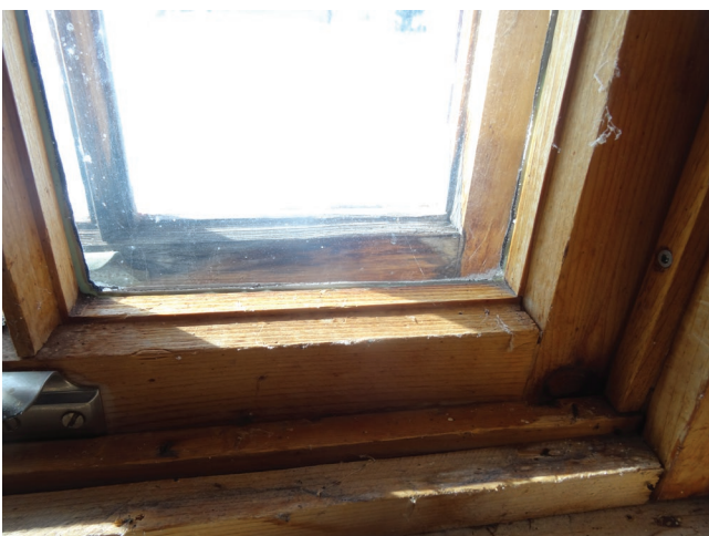
Figure 43 : Du côté intérieur, les fenêtres sont en bois nu.
