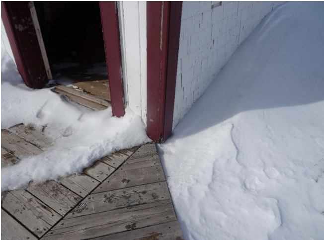
Figure 48 : Les ornements sont en bon état, mais elles doivent être peintes.
