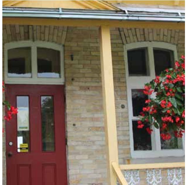
Fig. 43: Les ouvertures sont surmontées de linteaux de briques en soldat.
