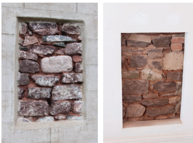
Figure 26 : Une «lunette» a été ajouté dans l'enduit, du côté extérieur, afin de d'exposer l'ossature du mur porteur d'origine. La composition du mur est également visible depuis l'intérieur.
