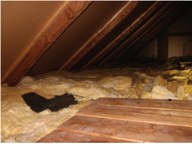
Figure 58 : La toiture est isolée avec des matelas de laine posée sur le plancher de l'entretoit.
