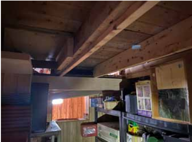
Figure 21 : La structure des planchers est constituée d'un platelage posé sur des solives en bois de sciage, ce qui est cohérent avec le type et l'année de construction d'origine de la maison.
