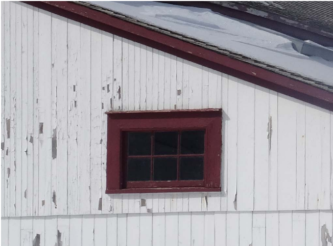
Figure 56 : L'appentis est percé de 2 fenêtres fixes à 6 carreaux
