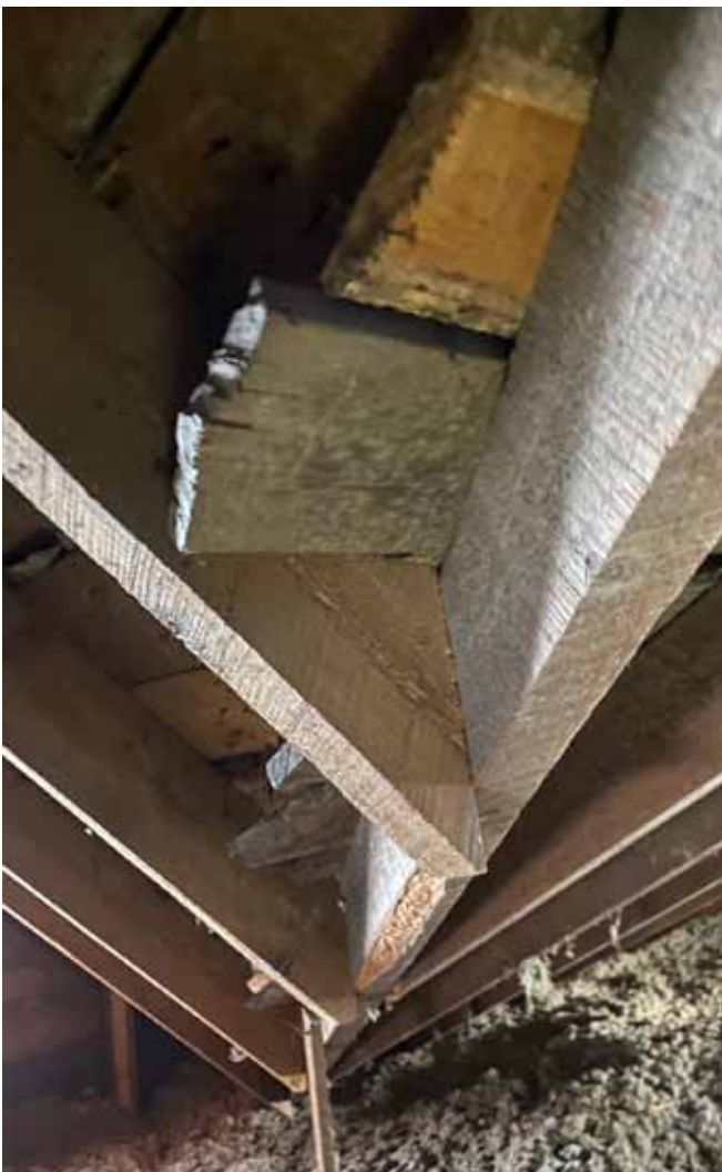
Figure 51 : Une lucarne pignon est présente au centre du versant avant nord de la toiture. La structure de la lucarne est en bon état. Les chevrons d'arêtier, à la jonction de la pente de toit et de la lucarne, sont en bon état.
