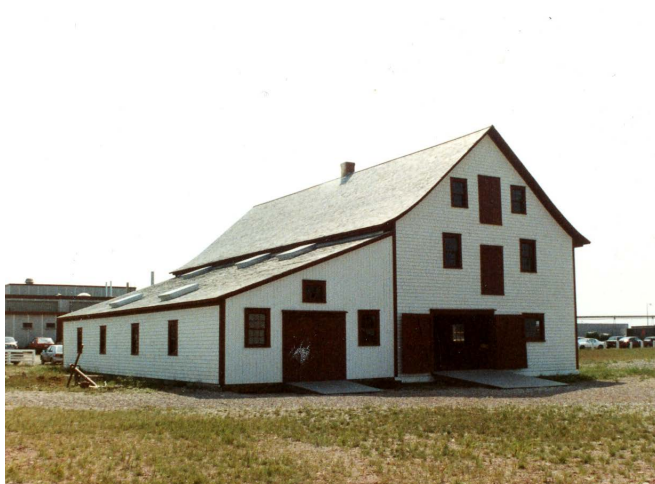
Figure 12 : Après les travaux de restauration de 1988. Collection du SHNP.
