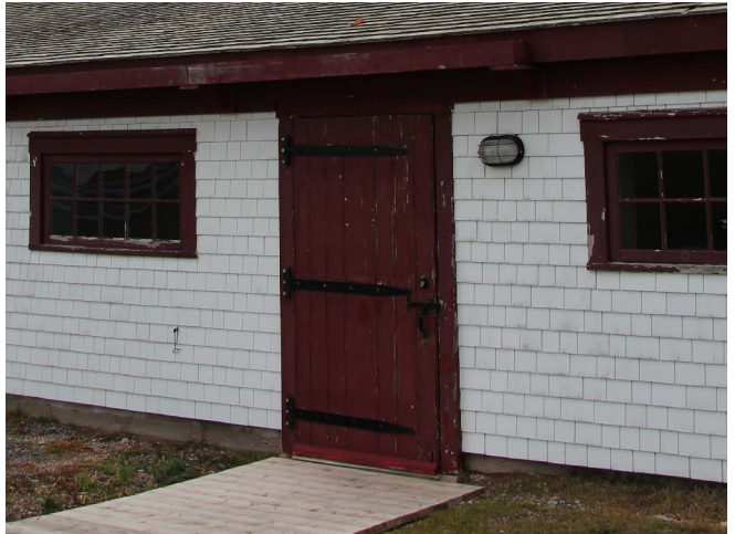
Figure 65 : L'appentis sud est percé d'une porte simple sur la façade sud.
