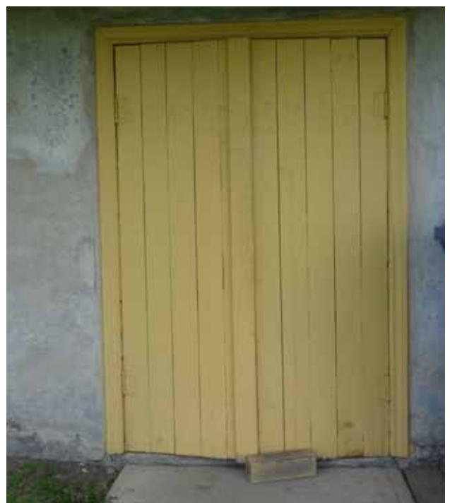
Fig. 62 : À l'arrière, le sous-sol est accessible par une porte en planches de bois, peinte de couleur jaune, avec contre-porte et ceinturée d'un chambranle.
