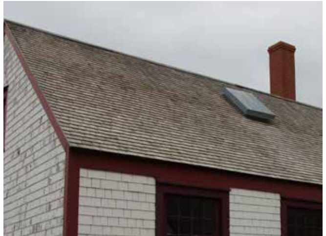
Figure 38 : La toiture est recouverte de bardeaux de cèdre laissés à nu. La planche faîtière de la toiture est aussi en bois laissé à nu.
