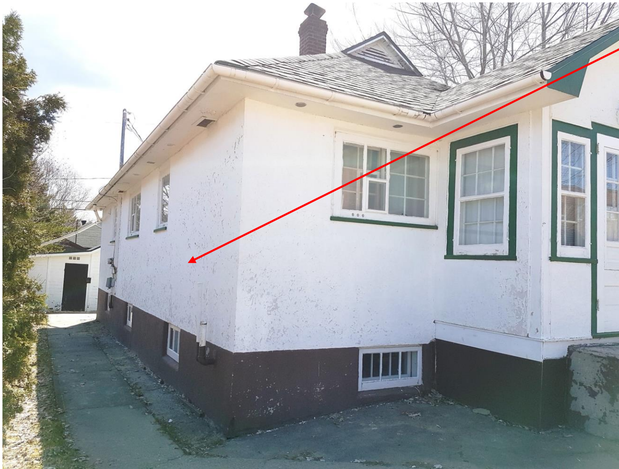
Photo façade gauche
