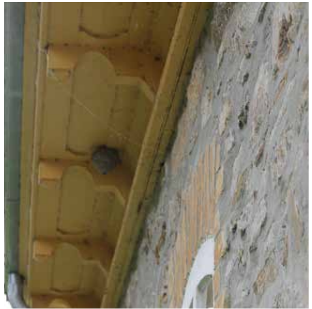
Fig. 70 : Il y a un nid de guêpes sur le larmier du mur nord-est. Les larmiers de la toiture sont décorés par des consoles de bois peintes en jaune.
