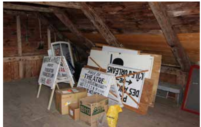
Fig. 71 : À l'été 2018, l'entretroit du hangar a été vidé.
