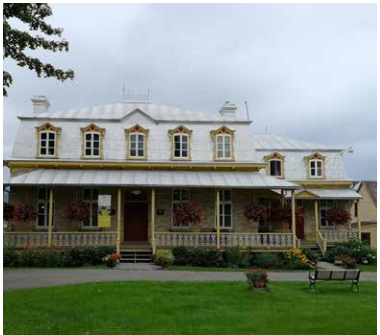
Fig. 22 : La galerie avant orne la largeur totale du bâtiment et donne accès aux entrées principales et secondaires.
