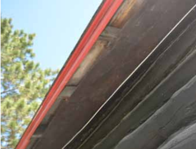
Figure 129 : Sur certains larmiers, le contreplaqué ne se poursuit pas jusqu'à l'extrémité des chevrons, permettant à l'air de passer.
