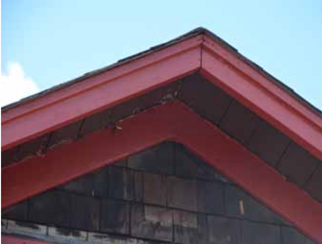
Figure 106 : Sur la moitié avant, qui n'a pas encore été isolée, les soffites d'origine en planches de bois ont été préservés.
