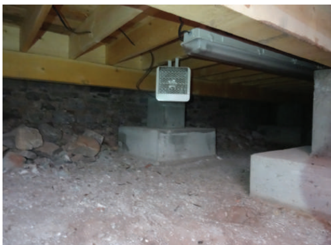
Figure 18 : Un vide sanitaire de quelques pieds de hauteur est situé sous le bâtiment.
