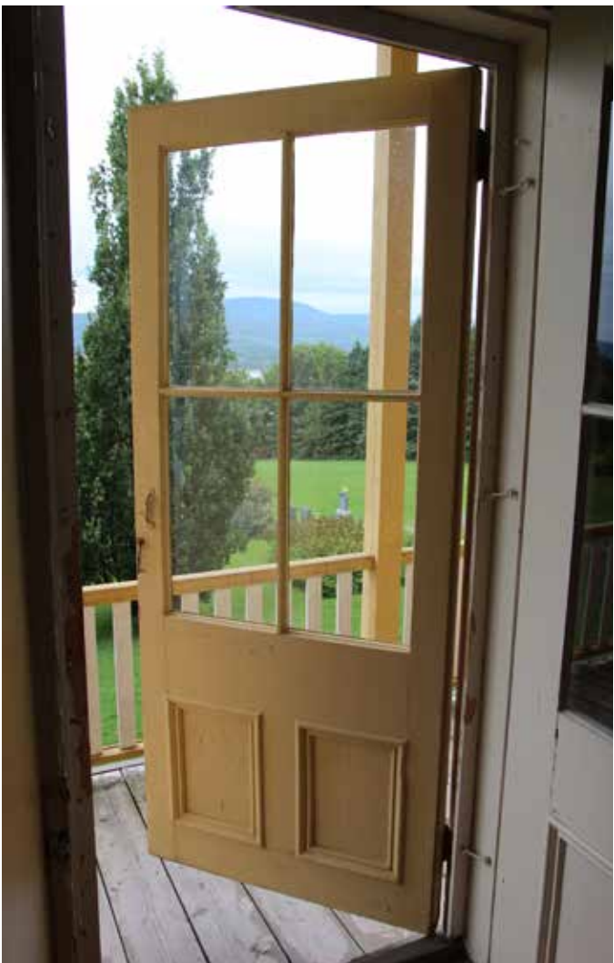
Fig. 65 : La seconde porte à l'arrière, située sur le corps principal du bâtiment, est une porte en bois, vitrée, avec des caissons et une imposte vitrée.
