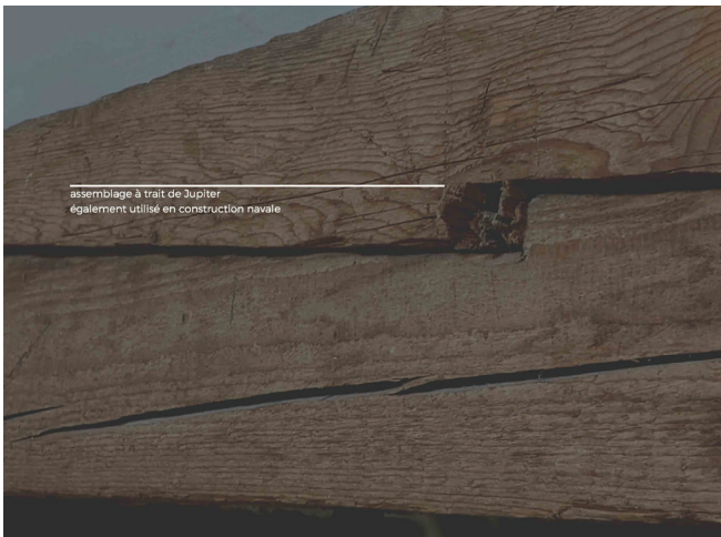
Figure 23 : Certains assemblages de la structure sont réalisés à trait de Jupiter. Source: Site historique national de Paspébiac.
