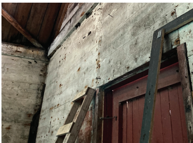
Figure 33 : Les murs sont recouverts de planches de bois laissé à nu. Le chaulage des murs intérieurs est visible par endroits.
