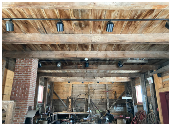
Figure 51 : Un système d'éclairage sur rail est installé au plafond.
