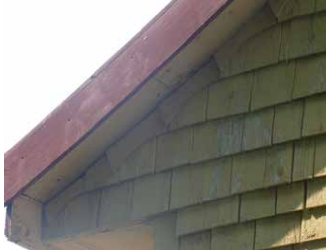
Fig. 16 : Dans les pignons, les bardeaux sont découpés de manière à créer des dentelles de bois.
