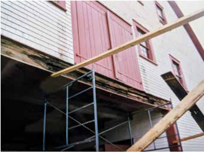
Figure 66 : La poutre située au-dessus du corridor central a été remplacée en 1999. Source: Collection du SHNP, 1999.
