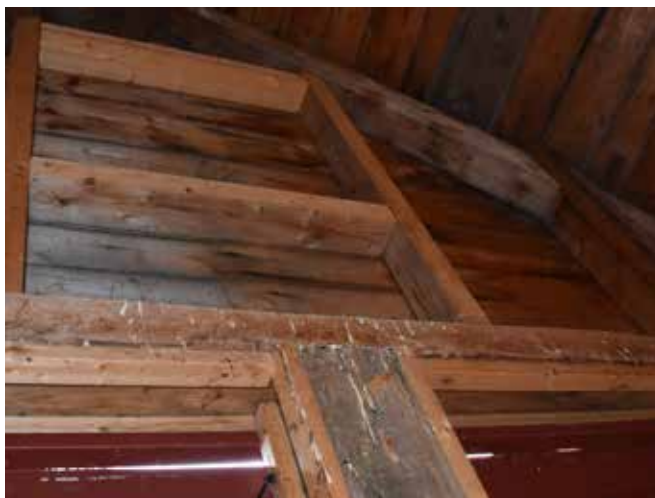
Figure 99 : Les linteaux et les cadres de portes ont parfois été consolidés lors des travaux de restauration.
