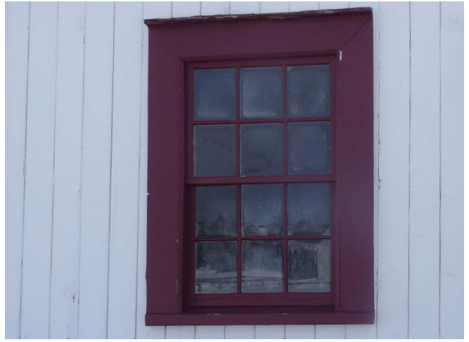
Figure 55 : L'appentis est percé de 7 fenêtres à 12 carreaux à guillotine.
