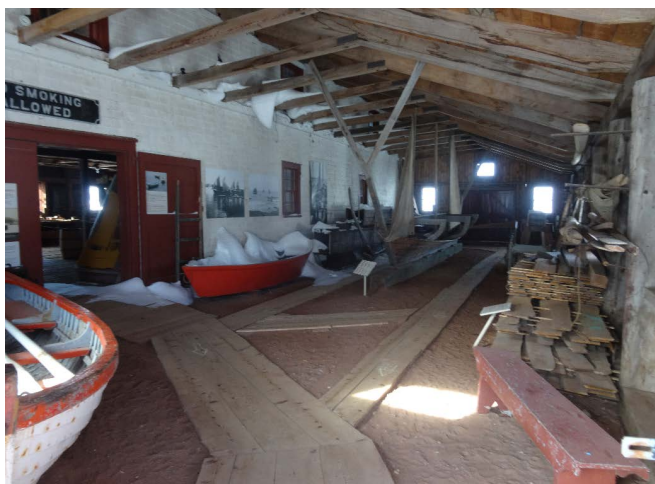
Figure 24 : L'appentis nord est laissé sur un sol en terre battue. Des trottoirs de bois, déposés directement sur le sol, donnent accès aux espaces d'exposition intérieurs.
