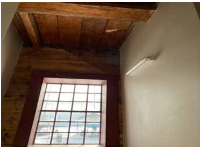
Figure 128 : Dans les sanitaires, des tube fluorescents sont accrochés aux murs.
