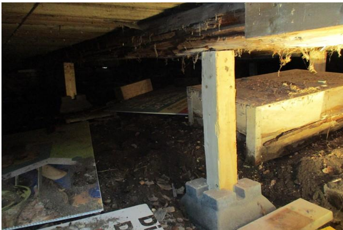
Photo 10: Nouvelles colonnes supportant le rez-de-chaussée
