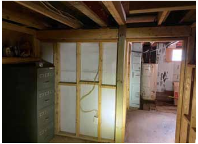
Figure 20 : Le sous-sol est divisé en sections par des cloisons légères en colombages de bois.
