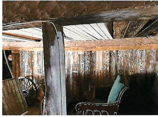
Photo #19 La poutre est soutenue par deux poteaux qui ont été ajoutés. Les poteaux s'appuient sur la face extérieure du mur en-dessous. Bien que cela représente un ajout, tout est correct.
