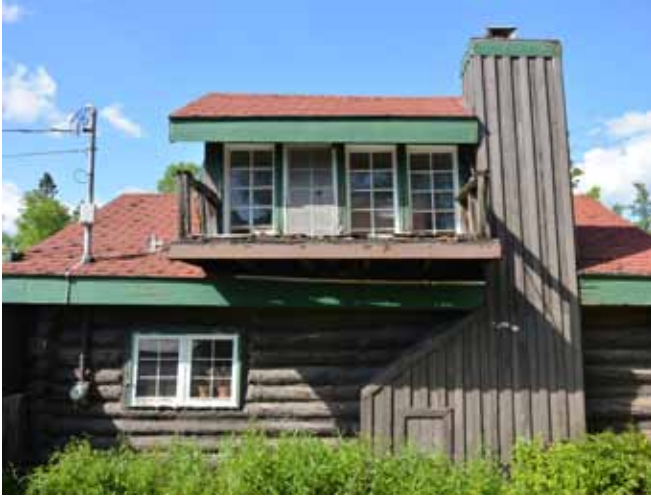
Figure 86 : La résidence a été modifiée de façon importante notamment par l'ajout d'une lucarne avec un balcon et l'ajout d'une cheminée recouverte de planches de bois.
