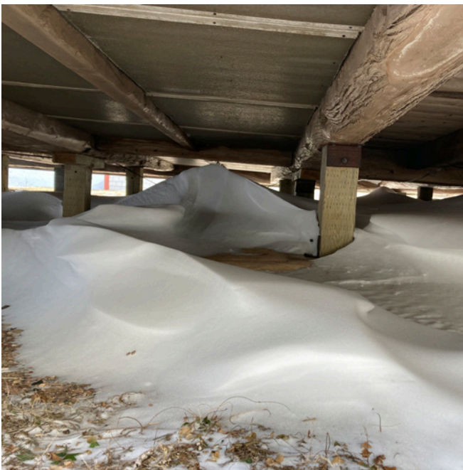
Figure 18 : Le dessous du plancher de bois de la section arrière du bâtiment a été isolé avec de l'isolant rigide et recouvert d'un pare-air et de panneaux de béton installés sur des fourrures lors des travaux de 2003.
