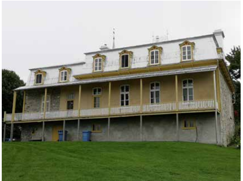
Fig. 10 : De l'extérieur, les fondations sont apparentes et surélevées par rapport au niveau du sol. À l'arrière, la dénivellation du terrain dégage entièrement le sous-sol.
