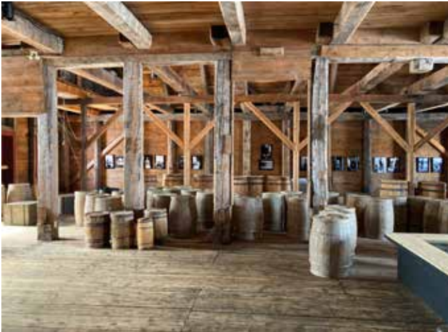
Figure 32 : Les planchers sont composés d'un platelage de bois déposés sur un système de poutres et poutrelles. Des colonnes de bois soutiennent les poutres principales.
