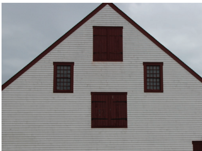
Figure 48 : Deux portes double de chargement donne accès à l'étage et à l'entretout sur la façade pignon ouest.
