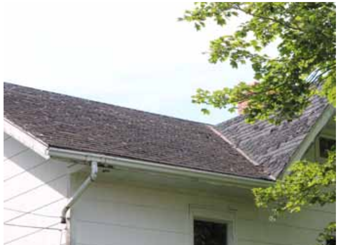
Figure 86 : Le toit du corps principal de la maison et la toiture des annexes au rez-de-chaussée, des galeries et de la véranda sont recouverts de bardeaux d'asphalte de couleur noire.
