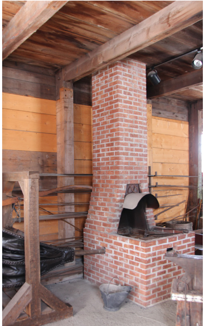
Figure 41 : Une cheminée de forge en brique a été construite lors des travaux de 2003.
