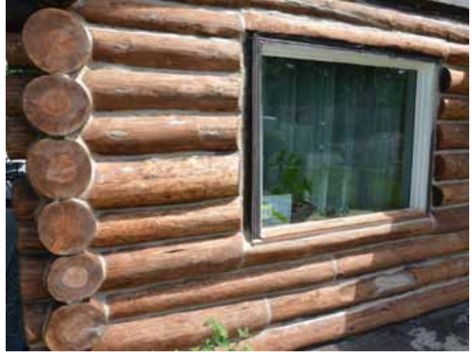
Figure 96 : Si un billot peut être conservé, il remplit les cavités avec du chinking.
