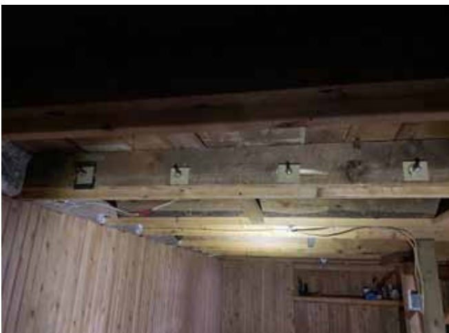
Figure 25 : Certaines solives ont été renforcées par moilage au moyen de tiges et profilés métalliques.
