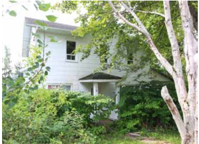
Figure 14 : De l'extérieur, le périmètre de la résidence est entouré de végétation. Cette situation permet à l'eau pluie de stagner à la base des murs.
