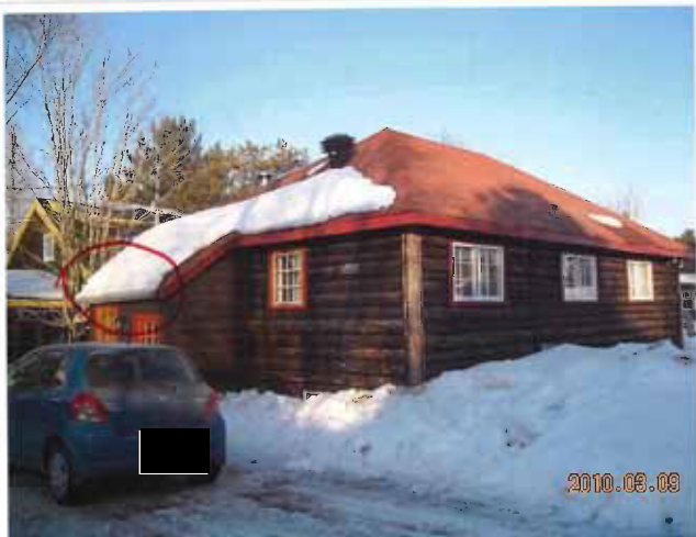
Figure 52 : Il se forme régulièrement des digues de glace à l'arrière du 61, rue Marineau, comme en témoigne cette photographie prise tardivement dans l'hiver en mars 2010. Photographie transmise par la ville de Val-d'Or.
