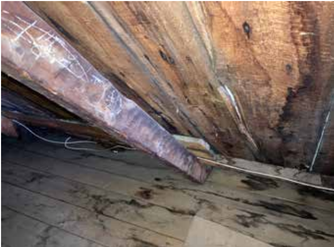
Figure 22 : Des cernes, visibles sur le platelage de la toiture et le plancher de l'entretoit, témoignent d'infiltrations d'eau.
