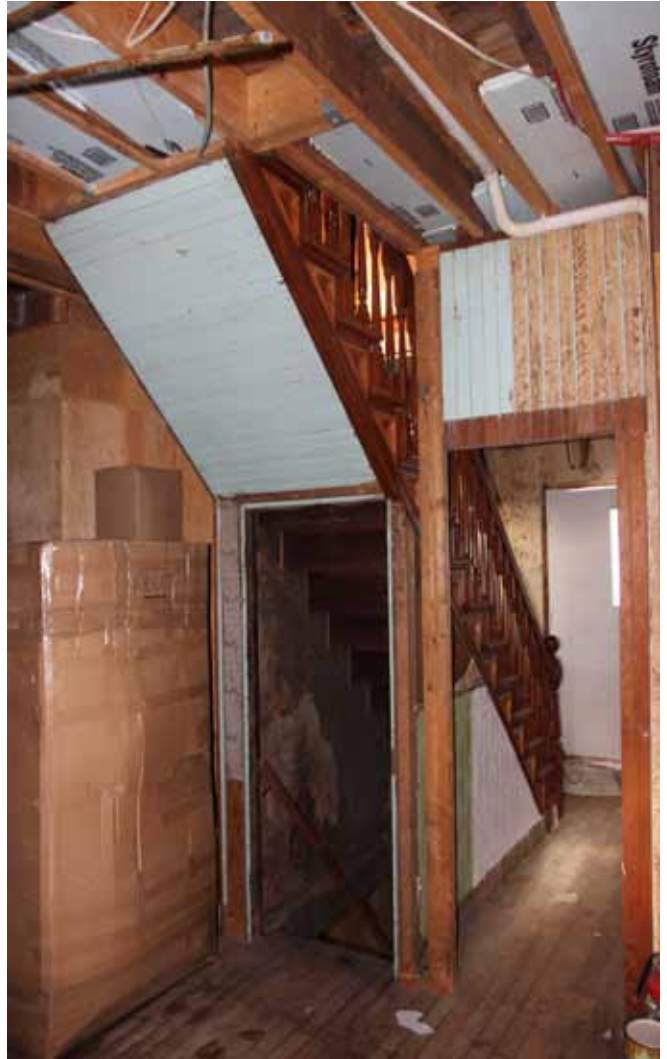
Figure 103 : La paroi latérale et la sous-face de l'escalier sont constituées de planches de bois peintes. L'escalier entre le rez-de-chaussée et le sous-sol est situé sous l'escalier principal.
