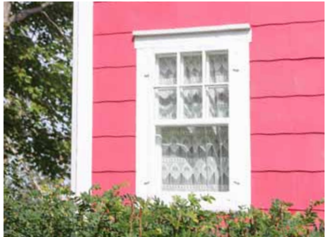
Figure 84 : Elle conserve certaines de ses fenêtres à guillotine en bois d'origine. Le châssis supérieur est divisé en six carreaux, ce qui est courant à cette époque dans l'architecture des communautés anglophones.
