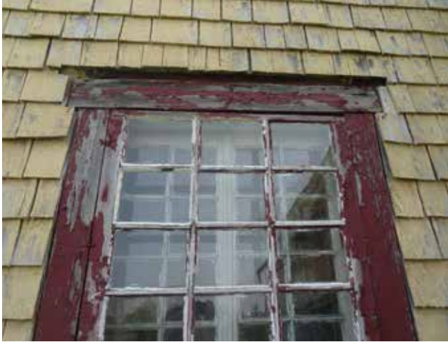
Fig. 36 : Les fenêtres et les portes existantes sont toujours munies de leurs chambranles de bois d'origine peints en rouge.
