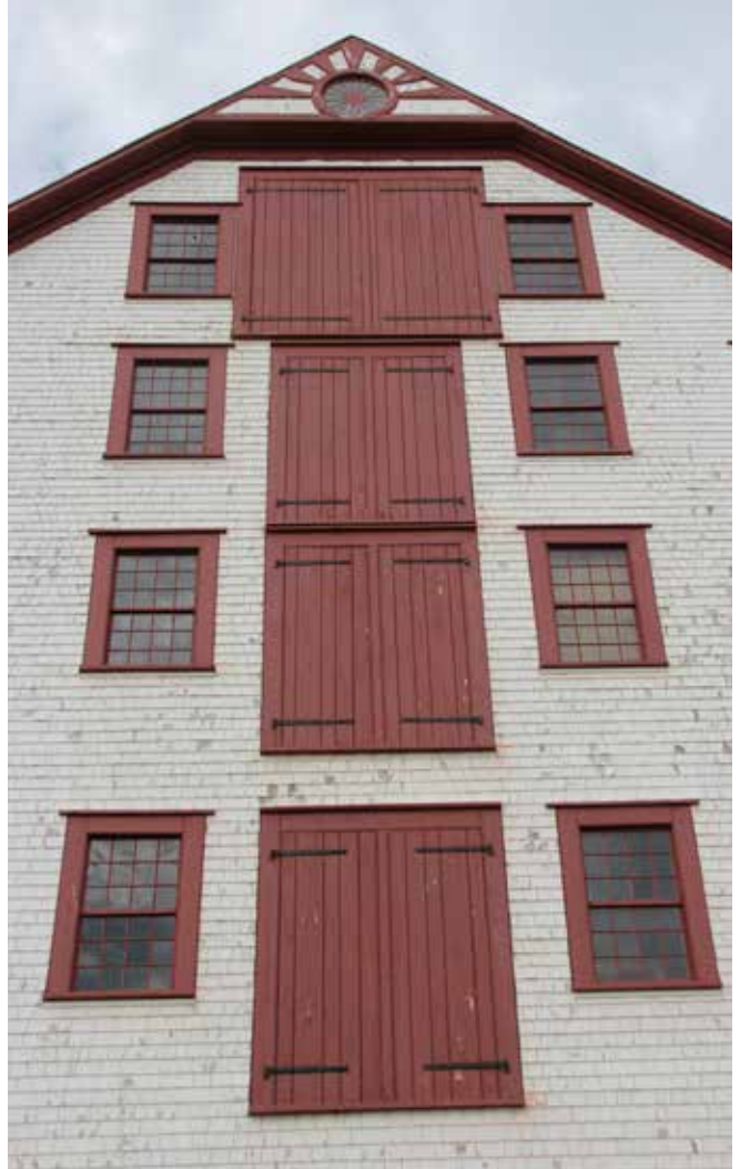
Figure 87 : Le bâtiment possède huit portes de chargement à double vantaux sur chacune des façade pignon disposées de façon symétrique.
