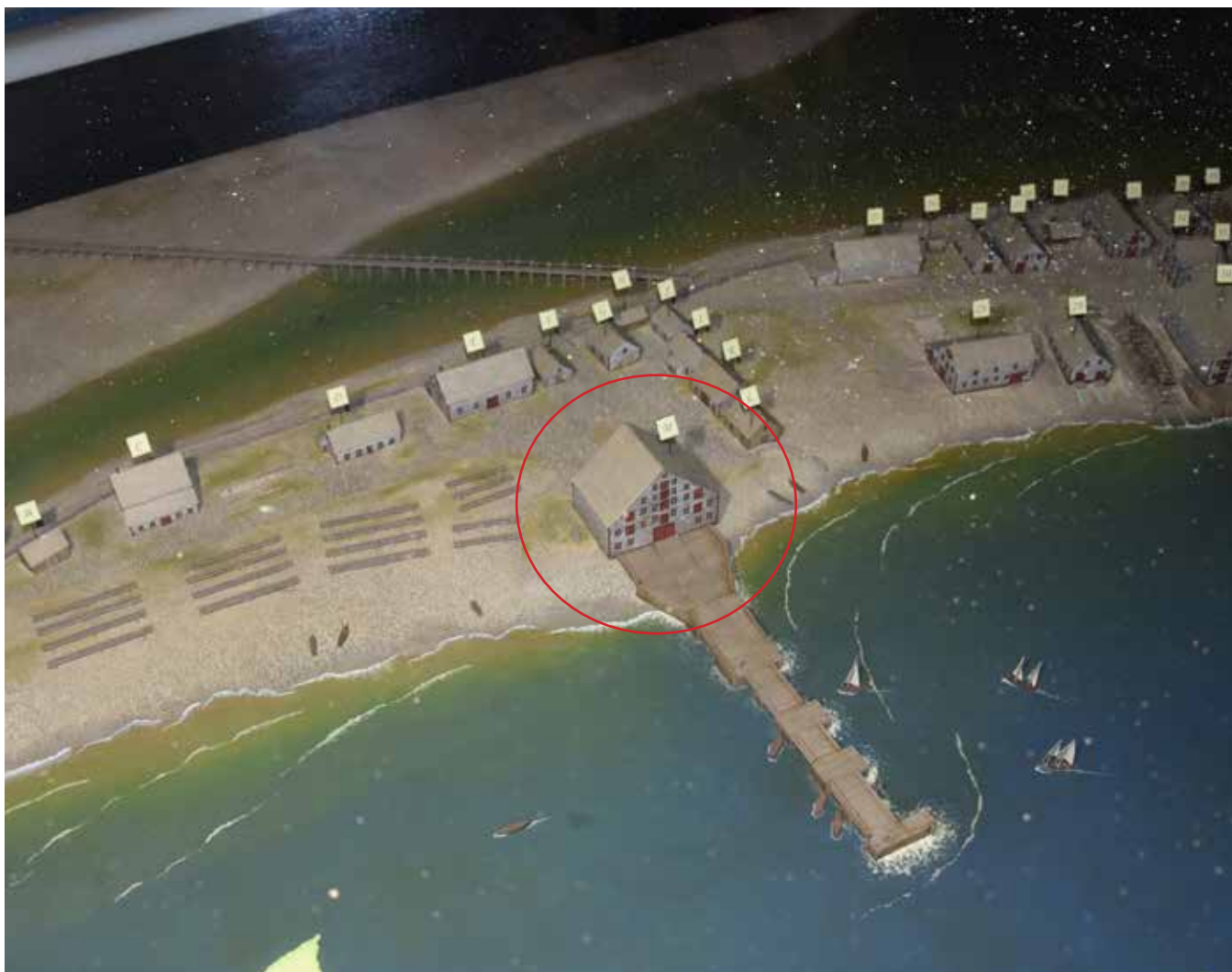
Figure 47 : Le grand corridor central autrefois situé en prolongement du quai. Photo de la maquette du site en 1870.
