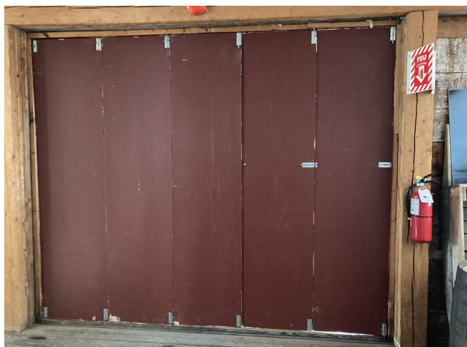
Figure 53 : Du côté intérieur, la porte est composée de plusieurs vantaux.
