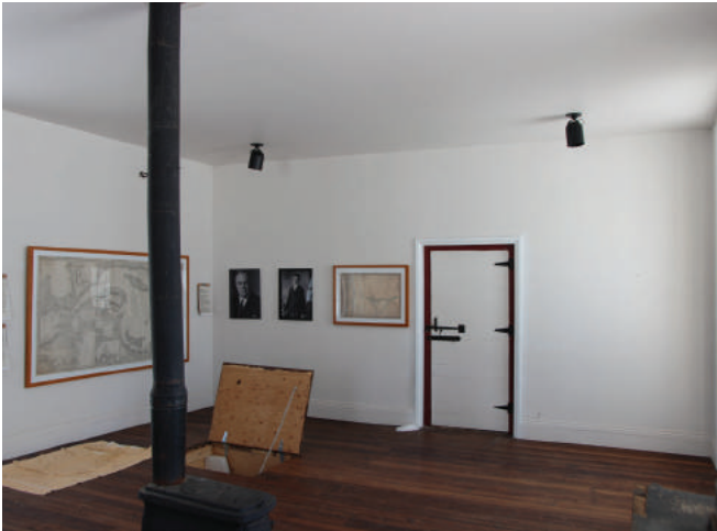
Figure 58 : Les cloisons intérieures sont revêtues d'un enduit de plâtre.
