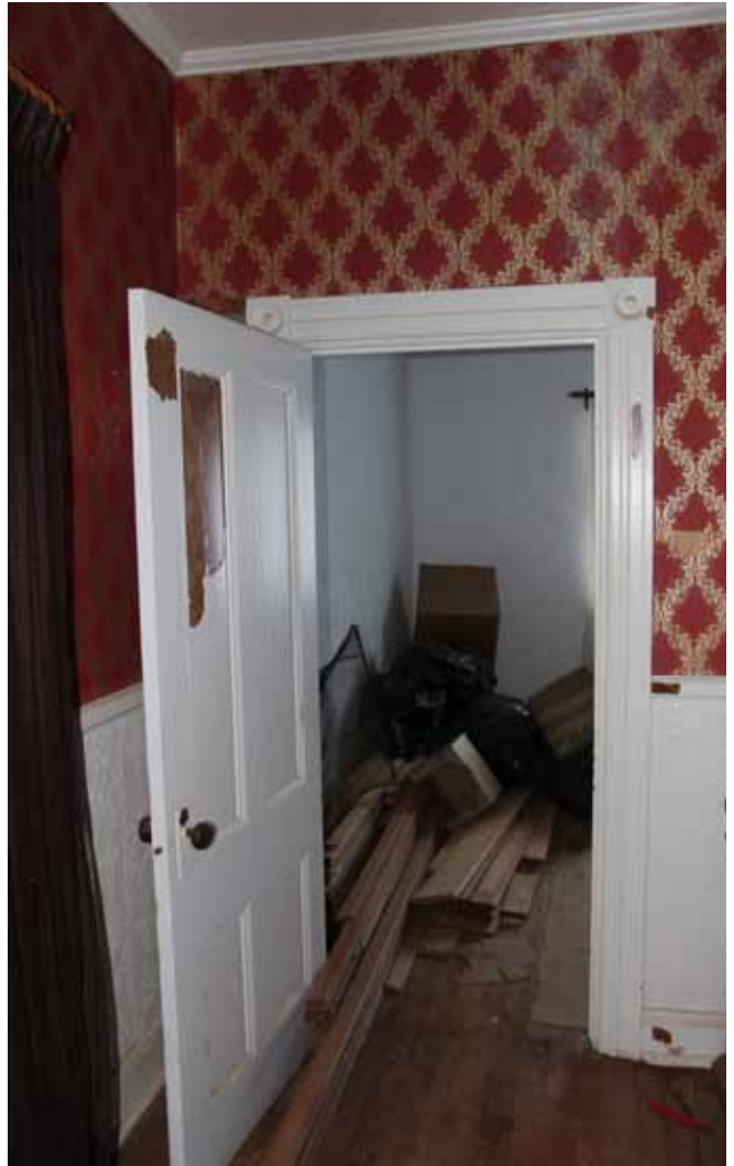
Figure 98 : Les portes intérieures d'origine sont en bois à caissons.
