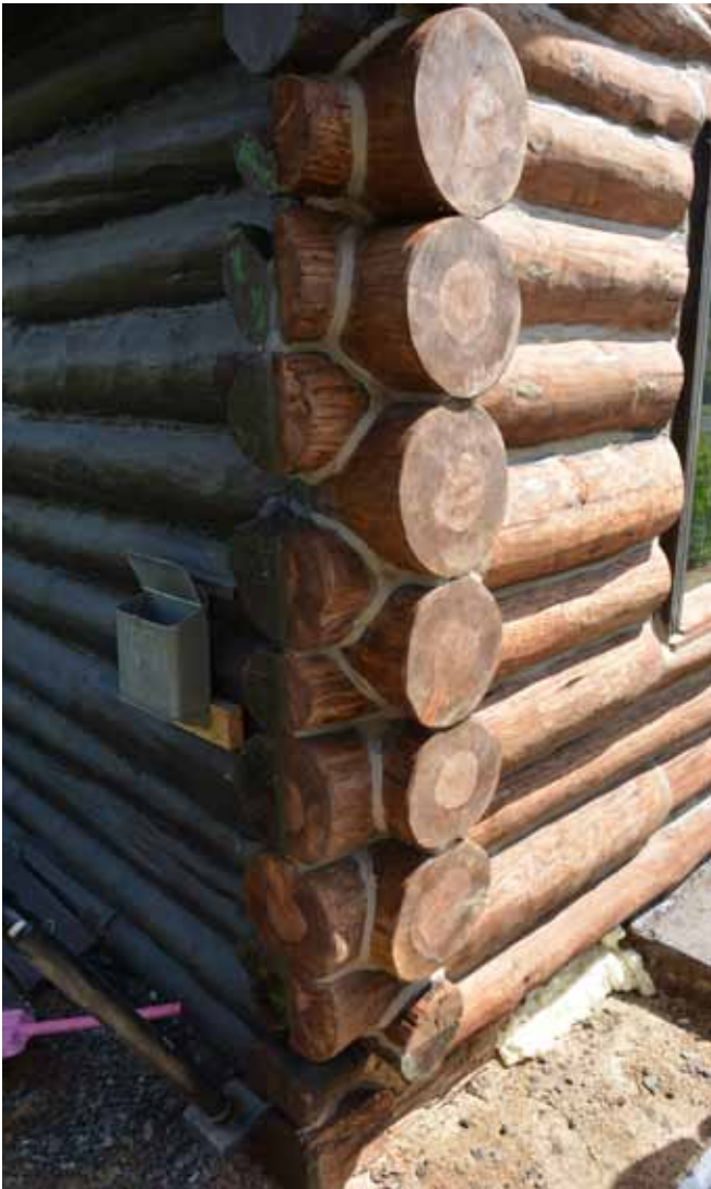
Figure 97 : Si un billot peut être conservé, il remplit les cavités avec du chinking.
