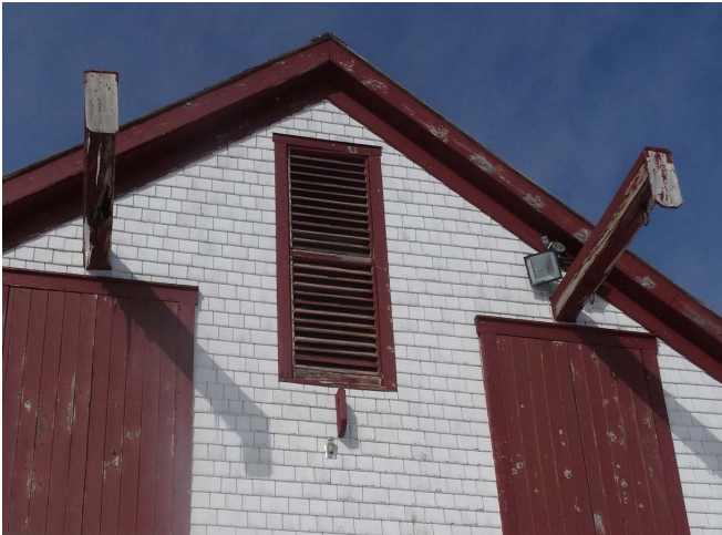
Figure 142 : Sur la façade est du volume principal, des poutres de bois percent la façade.
