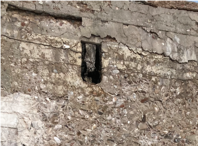
Figure 24 : L'emplacement de trois pièces de bois autrefois encastrées dans le béton est visible sur la façade principale sud. Il s'agissait probablement des poutres du plancher de l'étage.
