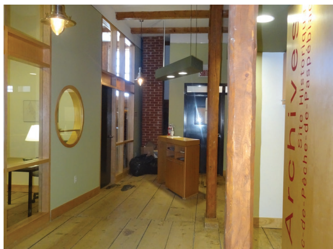
Figure 18 : Les planchers sont composés d'un platelage de bois déposés sur un système de poutres et de colonnes en bois.
