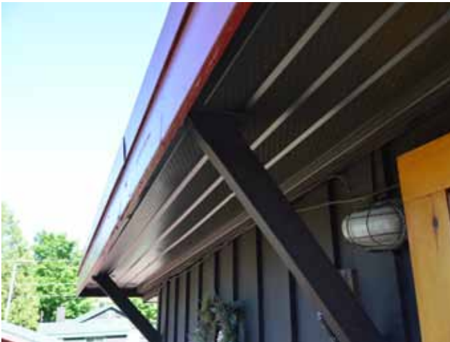
Figure 68 : Du côté sud, les soffites sont recouverts d'aluminium perforé.
