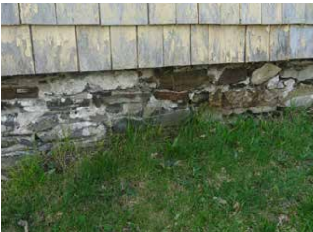
Fig. 7 : Les murs de fondation sont constitués de pierres à tout venant qui forment une maçonnerie massive qui s'appuie directement sur le roc.
