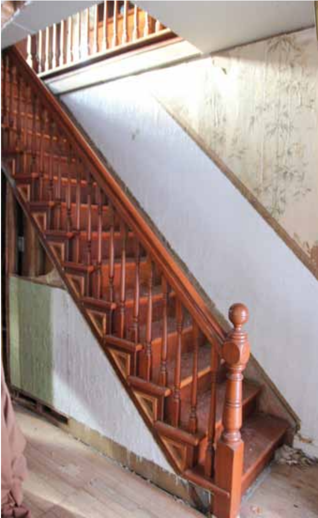
Figure 102 : L'escalier d'origine a été conservé et est en bon état. Les marches, les contremarches, le poteau de départ tourné et la main courante supportée par des barrotins tournés sont en bois verni.
