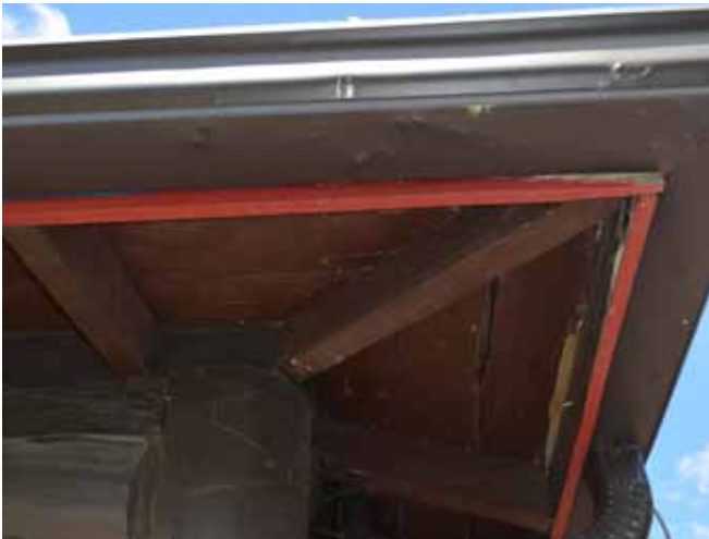
Figure 107 : Sur la moitié avant, qui n'a pas encore été isolée, les soffites d'origine en planches de bois ont été préservés.
