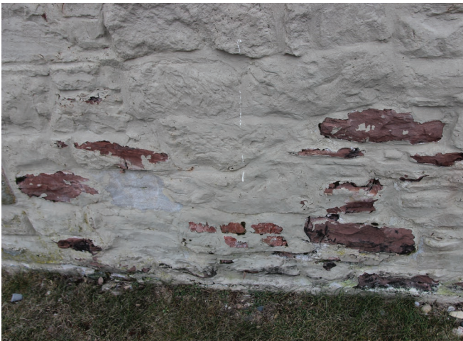
Figure 17 : Les autres murs extérieurs sont en maçonnerie de moellons de pierre à tout venant. Ils sont composés de grès, de calcaire et de granit recouvert de crépi.
