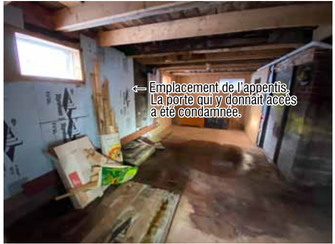
Figure 12 : À l'intérieur, la hauteur des fondations dégage un sous-sol habitable. La face intérieure des fondations a été recouverte de panneaux d'isolant en polystyrène extrudé.
