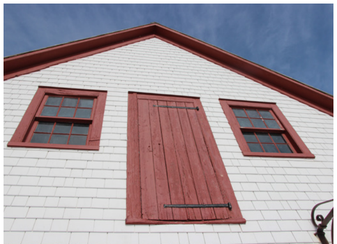
Figure 26 : De façon générale, les larmiers sont en très bon état.
