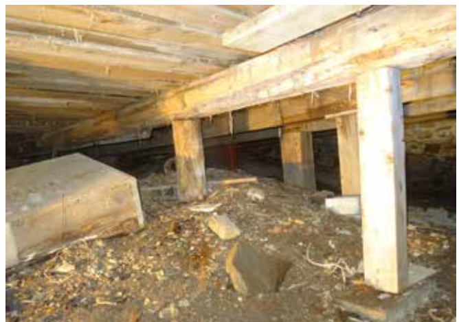
Fig. 59 : Le plancher est composé d'un platelage de bois existant déposé sur un système de grumes et de poteaux de bois.
