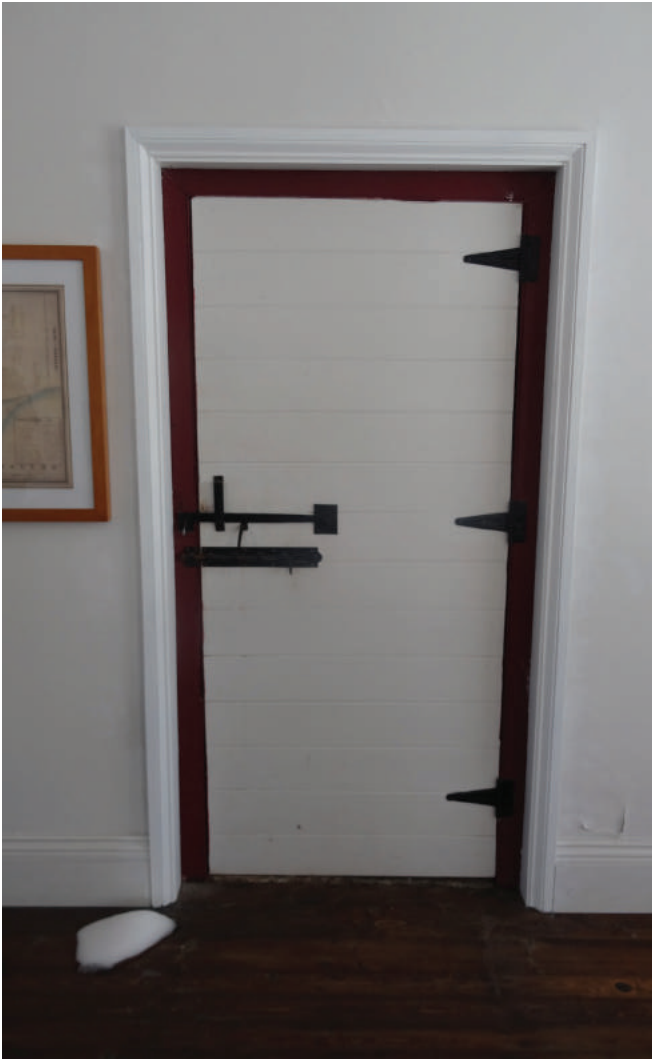
Figure 42 : Du côté intérieur, la porte latérale est composée d'un assemblage de planches horizontales.
