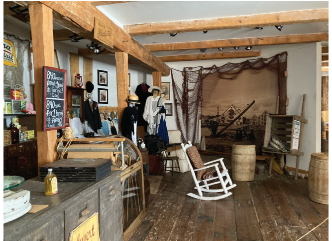
Figure 24 : Une poutre centrale soutenue par des colonnes de bois permet de soutenir les planchers de l'étage.
