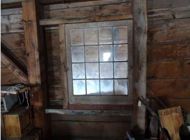
Figure 50 : Le bâtiment est orné de cinq fenêtres situées sur la façade nord du volume principal, visibles depuis l'intérieur de l'appentis.
