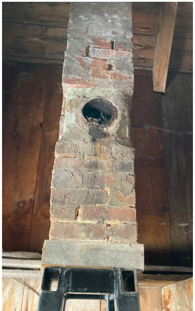
Figure 51 : La cheminée est en bon état. De l'intérieur, elle est installée sur une structure métallique visible depuis l'étage.
