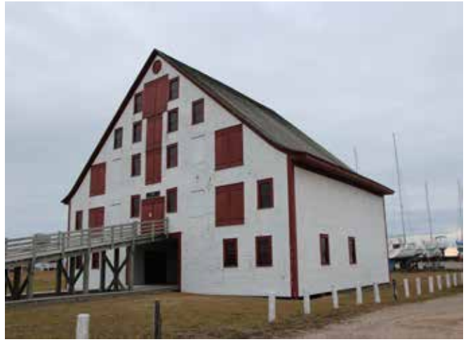
Figure 137 : Un trottoir de bois donne accès au bâtiment et permet de relier l'entrepôt au hangar.
