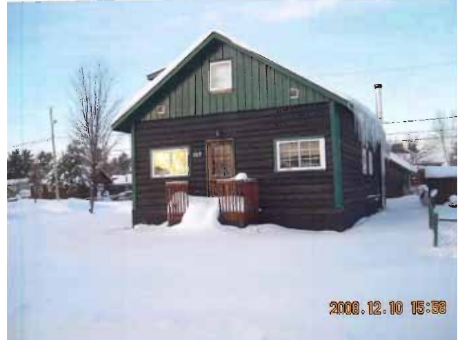
Figure 25 : Maison de type A. 107, avenue Perrault. Photographie transmise par la ville de Val-d'Or.
