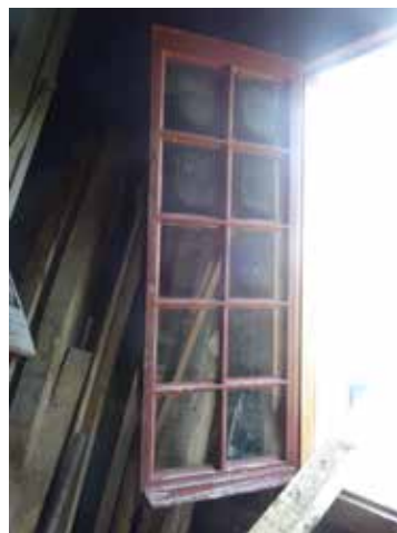
Fig. 26 : Le bâtiment est muni de fenêtres de bois, à battants, à 10 carreaux et peintes en rouge.
