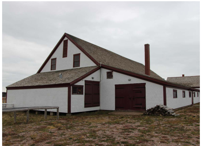
Figure 21 : Les appentis sud et ouest sont recouverts d'un seul versant adossé au bâtiment principal également recouvert de bardeaux de cèdre naturels.
