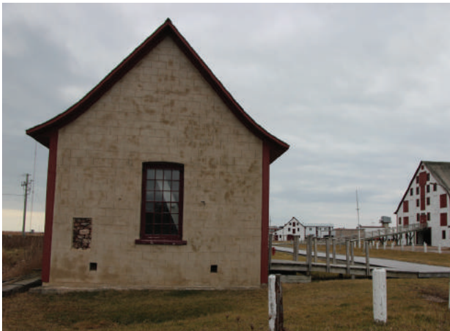
Figure 4 : Façade latérale Nord-ouest.
