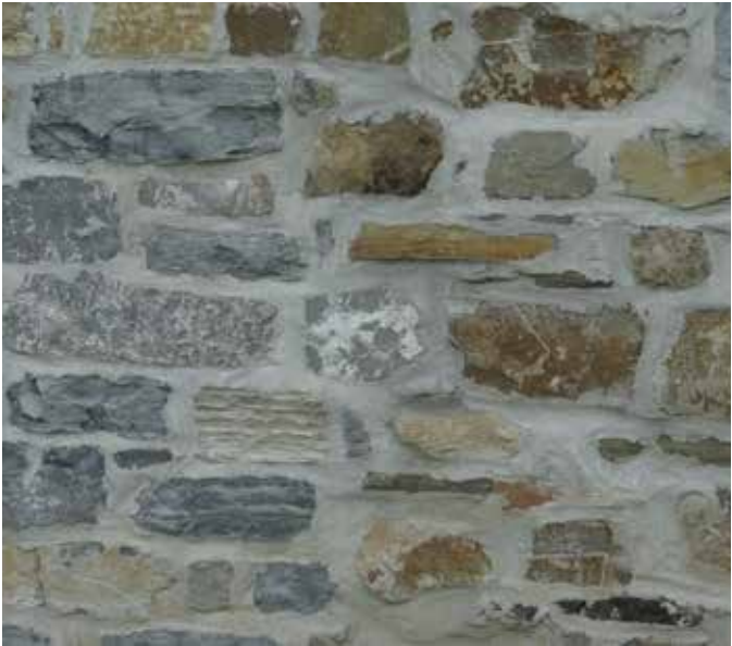
Fig. 7 : Les fondations sont en pierres de moellons brut avec appareillage à tout-venant.
