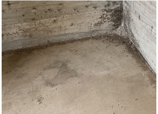
Figure 17 : Le plancher du coffre-fort est constitué d'une dalle sur sol en béton laissé à nu. La dalle est en bon état et aucune fissure n'a été observée à l'intérieur.
