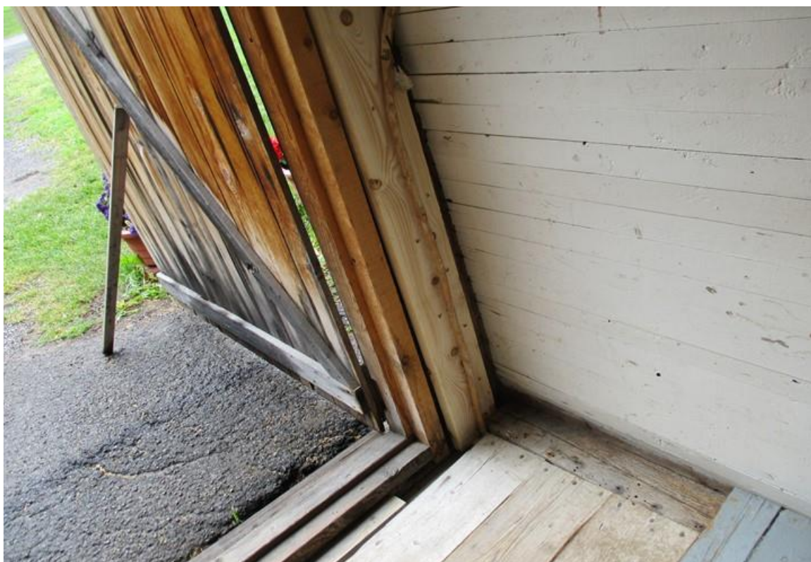
Photo 9: Colonne supportant le linteau appuyée sur la fondation existante
