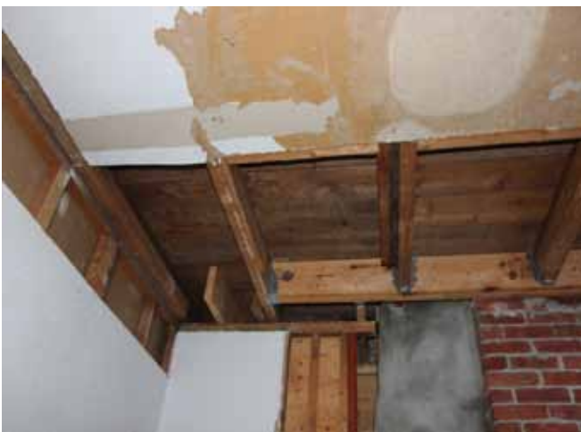
Figure 31 : À quelques endroits, les solives d'origine ont été modifiées ou sciées pour permettre le passage de canalisations. Ces solives ont été renforcées par des solives modernes.
