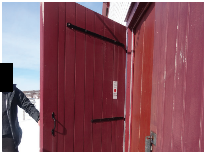
Figure 51 : Les portes principales situées sur la façade sud-ouest sont à doubles vantaux et composées de porte et de contre-portes.
