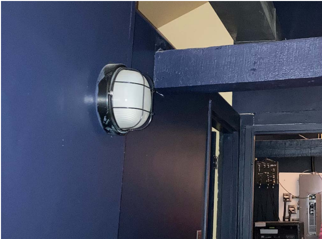
Figure 126 : Des lumières en applique éclairent la loge.
