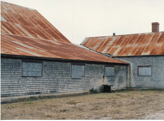
Figure 70 : Les photographies anciennes témoignent qu'avant 1988, au moment de la restauration du bâtiment, la toiture était recouverte de tôles métalliques. Collection du SHNP.
