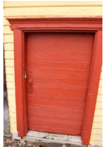
Fig. 32 : Une porte simple de planches, typiques des bâtiments agricoles québécois, peinte en rouge est située à côté des portes doubles.
