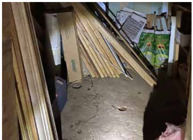
Figure 18 : Le plancher du sous-sol est constitué d'une dalle de béton.
