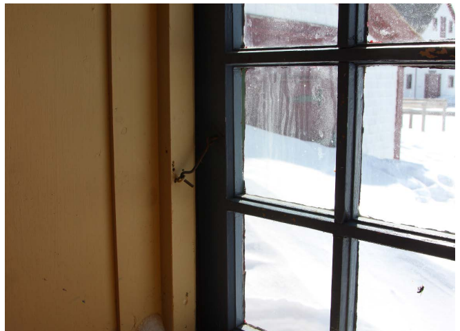
Figure 41 : Les fenêtres sont retenues à leur cadre grâce à un système de crochets.
