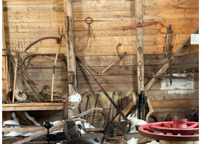
Figure 43 : Les murs intérieurs sont généralement en bon état. Ils sont recouverts de planches de bois laissé à nu.
