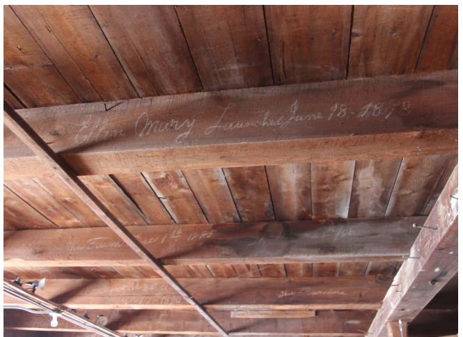
Figure 21 : Des graffitis anciens sont visibles sur les consoles et sur les poutres.
