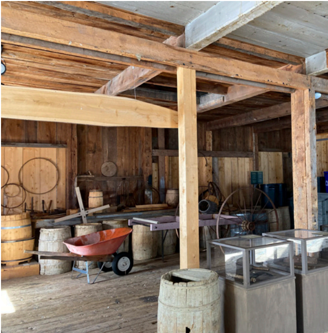
Figure 16 : Le plancher de l'étage la tonnellerie est constitué d'un platelage de bois déposé sur un système de poutrelles qui s'appuie sur une poutre centrale elle même appuyée sur des poteaux de bois.
