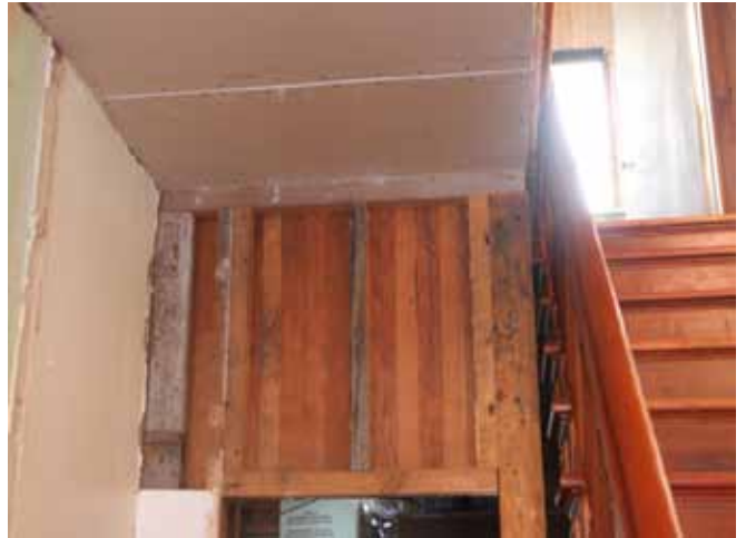
Figure 94 : Certaines cloisons sont aussi constituées de planches de bois, dont la cloison dans le passage vis-à-vis l'escalier au rez-de-chaussée.
