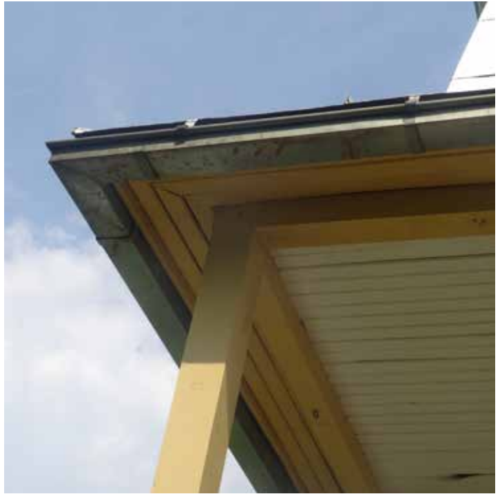
Fig. 74 : Des gouttières sont présentes à la base de chacun des versants de la toiture de l'édifice.
