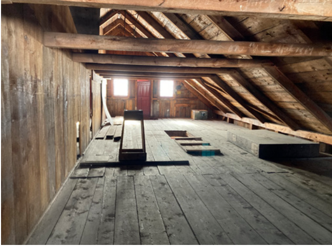
Figure 20 : La structure, visible de l'intérieur, se compose d'arbalétriers de 100 x 150 mm reliés par des faux entrails.
