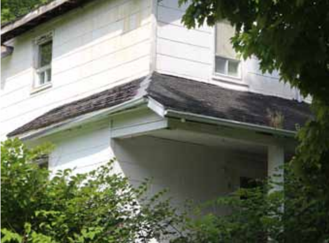
Figure 89 : Le toit du corps principal de la maison et la toiture des annexes au rez-de-chaussée, des galeries et de la véranda sont recouverts de bardeaux d'asphalte de couleur noire.
