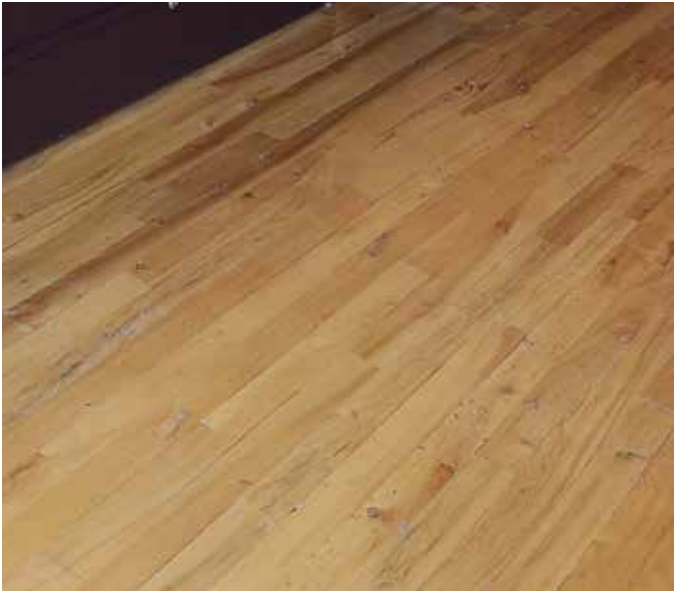
Fig. 102 : Le plancher du rez-de-chaussée du volume principal est en bois franc.
