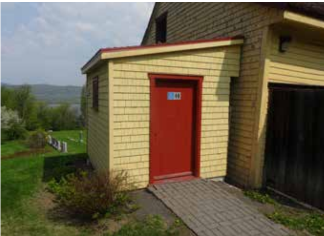
Fig. 23 : Au tournant des années 2000, un appentis a été ajouté au hangar afin d'y aménager des toilettes publiques.
