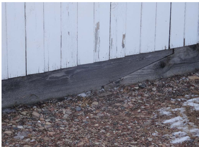
Figure 22 : La solive de rive de l'appentis est déposée directement au sol. Une section, à l'ouest, a été consolidée avec un assemblage à trait de Jupiter lors des travaux de restauration.
