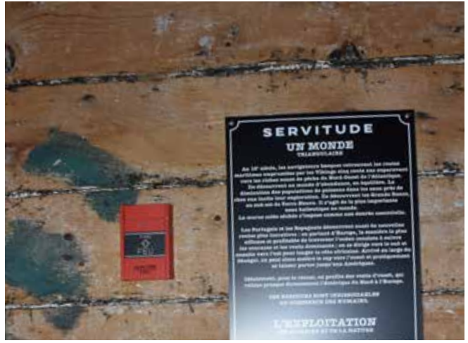
Figure 130 : Le bâtiment est muni d'un système de détection et d'alarme incendie. Des déclencheurs manuels sont installés dans le bâtiment.
