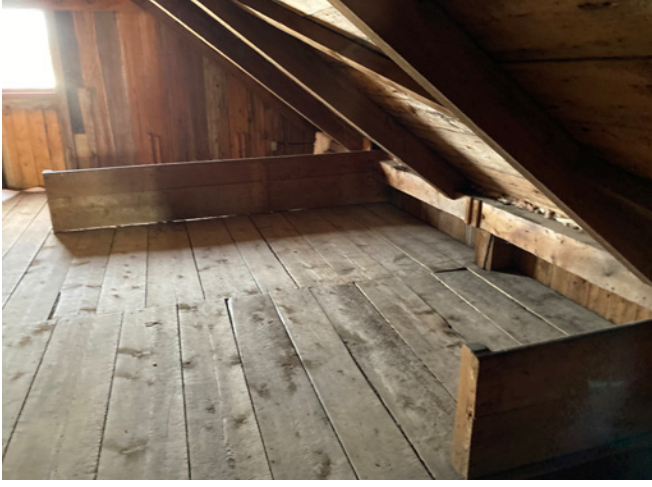
Figure 71 : Des structures de lits amovibles sont disposées sur le plancher.
