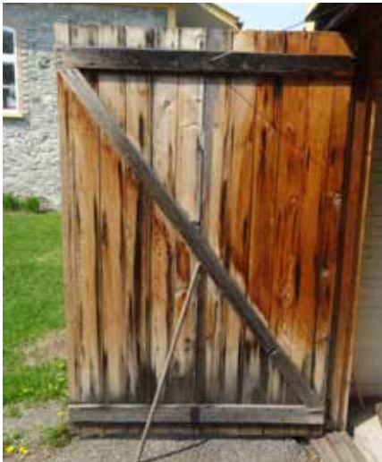
Fig. 30 : Les portes doubles, sont construites en planches de bois, nu.
