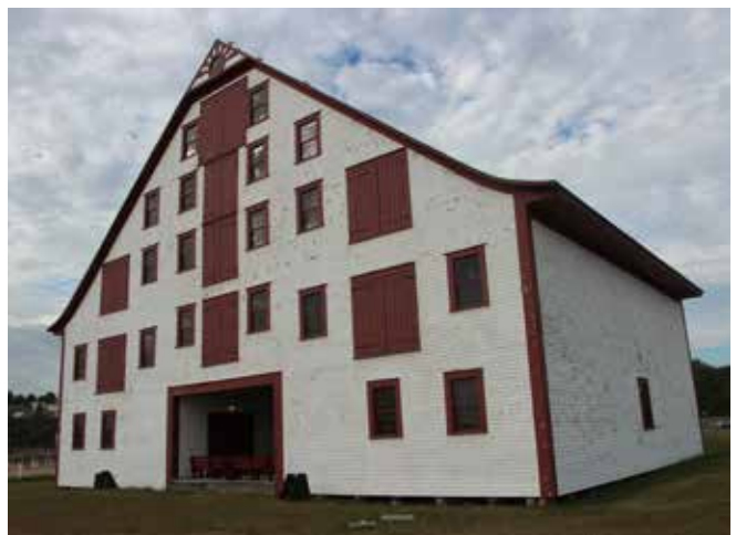
Figure 5 : Façade arrière sud-ouest.
