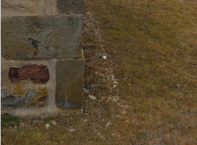
Figure 15 : En 2005, un lit de propreté en galet de rivière a été réalisé au périmètre du bâtiment. Du gazon est présent dans le lit de propreté.
