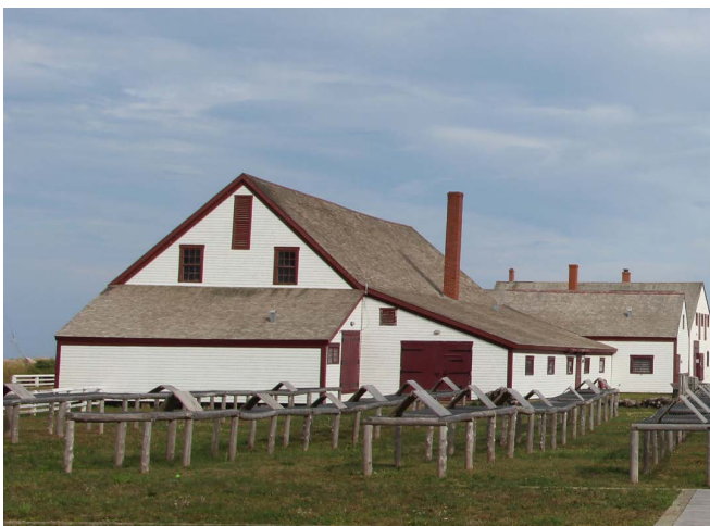
Figure 4 : Façade latérale ouest.
