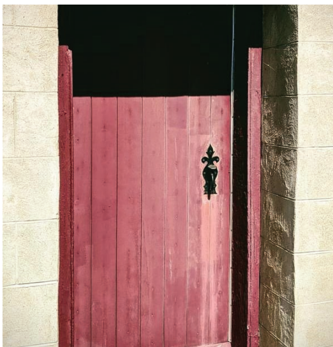
Figure 41 : La porte secondaire sur la façade est en bois composée d'un assemblage de planches verticales. Source: Site historique du banc de Paspébiac.
