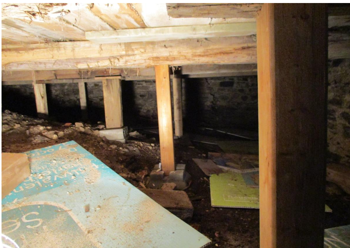
Photo 11: Nouvelles colonnes supportant le rez-de-chaussée
