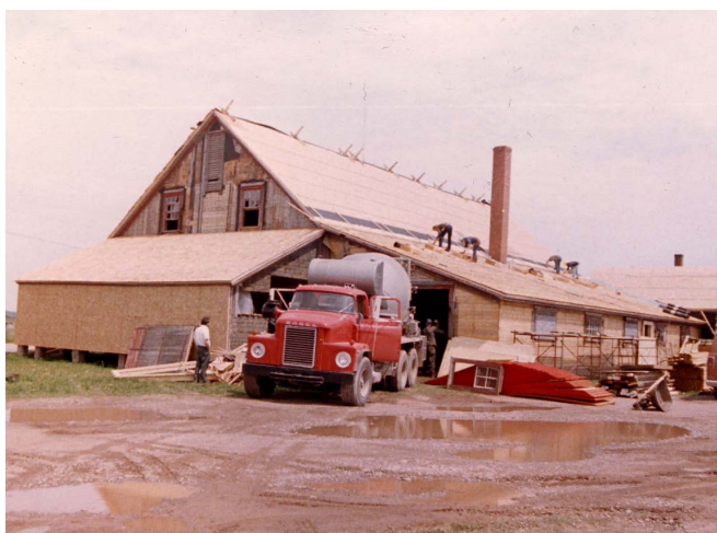
Figure 10 : Travaux de restauration du bardeau de cèdre des murs et des toitures recouvertes de contreplaqué et d'une membrane en 1988. Collection du SHNP.
