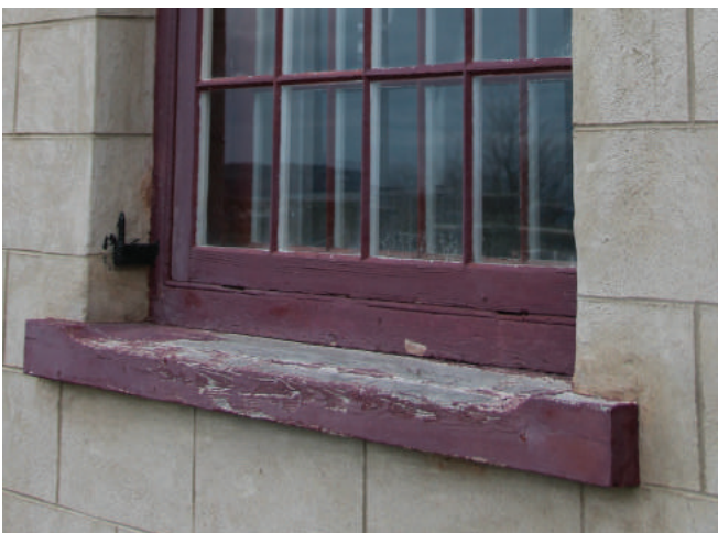
Figure 33 : Les tablettes des fenêtres ont été sculptée pour faciliter l'égouttement.
