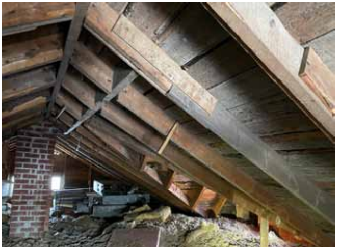
Figure 52 : Les chevrons sont constitués de madriers de bois assemblés bout à bout par moisage.
