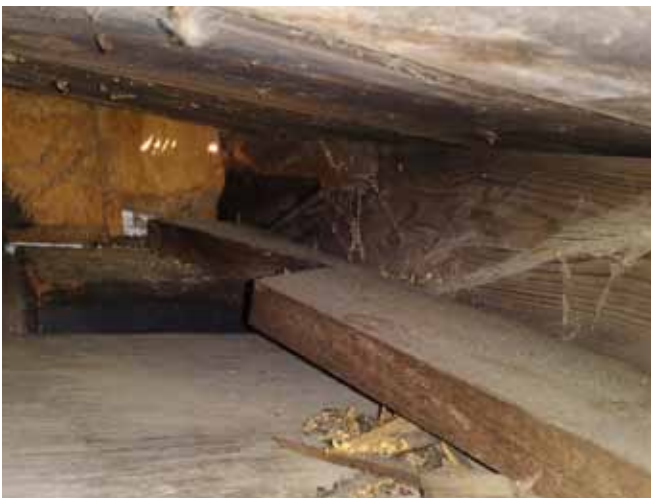
Figure 131 : Les planches de bois qui fermaient l'espace entre les chevrons au sommet des murs extérieurs ont été retirés
