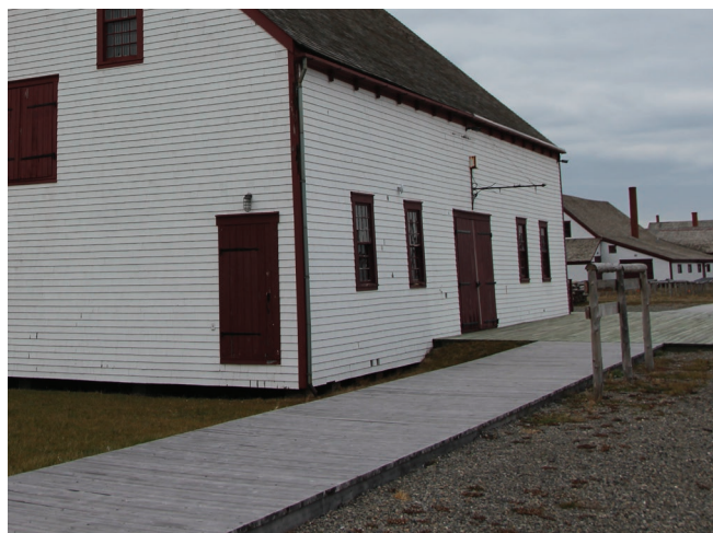
Figure 16 : Un trottoir de bois nu a été ajouté le long de la façade sud-ouest en 2005.
