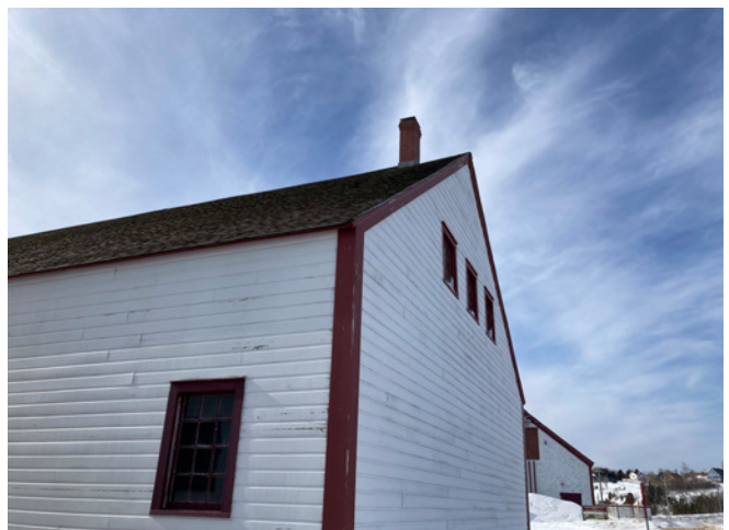
Figure 5 : Façade arrière Nord-est.
