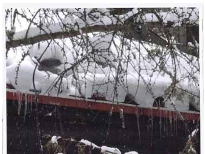
Figure 35 : 133, avenue Perrault. Photographie transmise par la ville de Val-d'Or. Certains propriétaires témoignent que l'ampleur du phénomène de formation de digues de glace diminue depuis l'installation de ventilation sur le faite.
