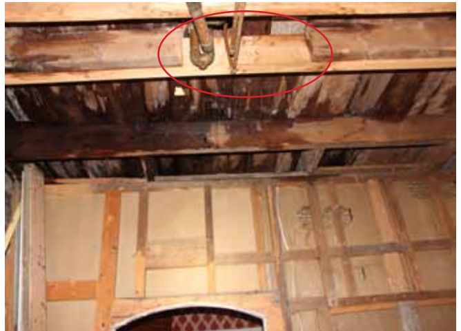
Figure 30 : À quelques endroits, les solives d'origine ont été modifiées ou sciées pour permettre le passage de canalisations. Ces solives ont été renforcées par des solives modernes.
