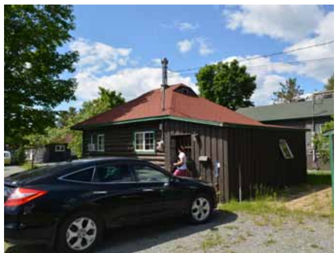
Figure 176 : La toiture a été modifiée pour permettre l'aménagement de deux chatières de ventilation triangulaire vis-à-vis le faîte. La toiture de l'annexe a cependant conservé sa forme d'origine.
