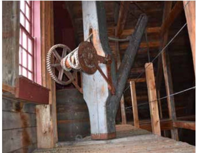
Figure 132 : Une grue pivotante fixée à la charpente du bâtiment permettait de déplacer la marchandise.
