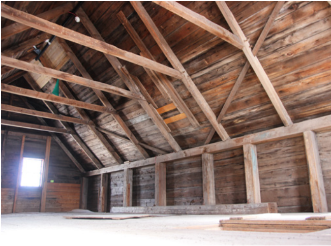
Figure 20 : En 2003, lors des travaux de restauration, plusieurs planches du platelage du versant est ont été remplacées.
