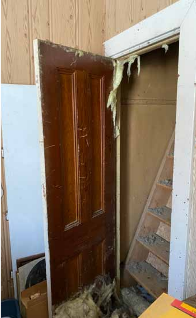
Figure 99 : Les portes intérieures d'origine sont en bois à caissons. Une échelle de bois permet d'accéder à l'entretoit.
