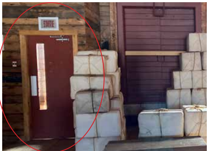
Figure 122 : Une cage d'escalier d'issue a été ajoutée sur le coin sud-est du bâtiment.
