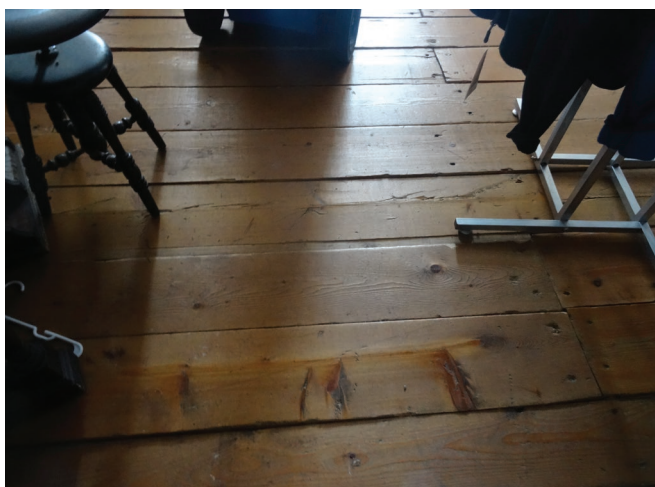
Figure 82 : Le plancher du rez-de-chaussée est en planches de bois verni.
