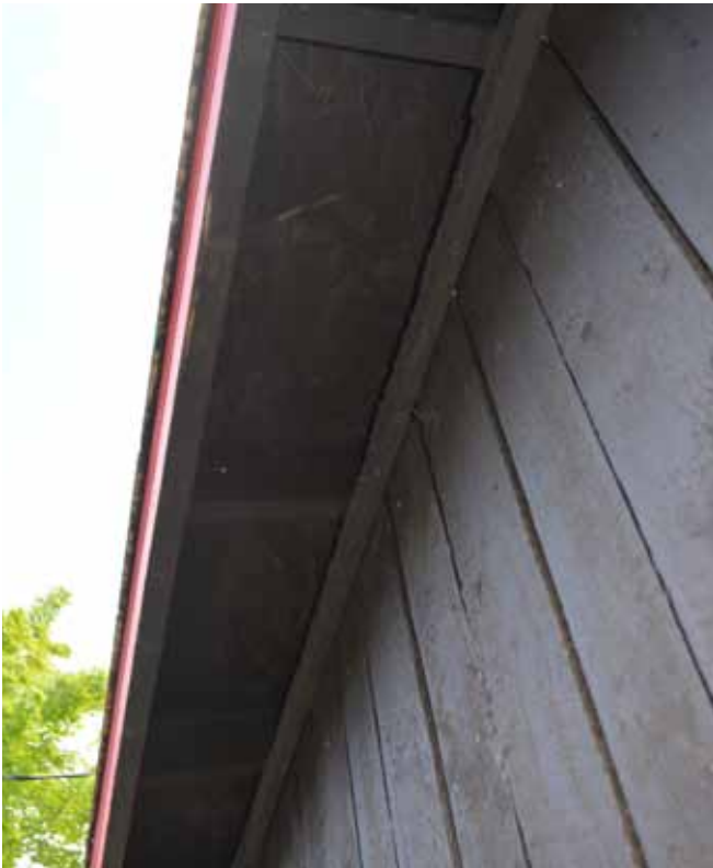
Figure 127 : La partie des chevrons qui se poursuit au-delà des murs extérieurs a été recouverte de planches de contreplaqué.
