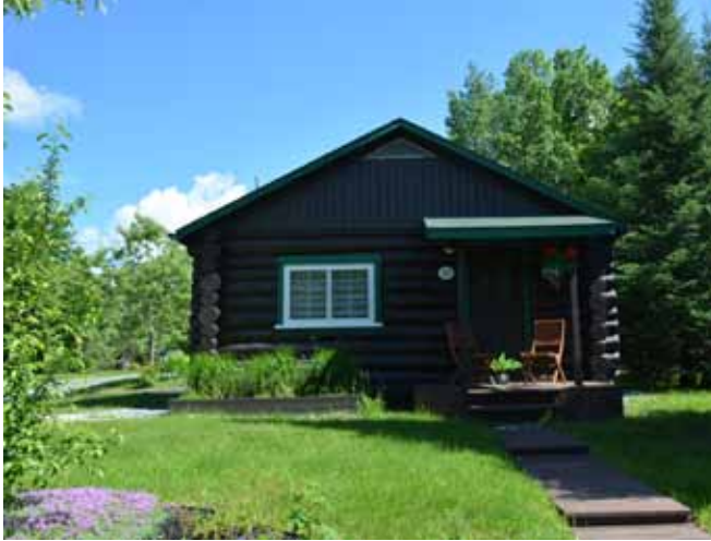
Figure 12 : La maison de type C possède un seul étage et un toit à deux versants avec pignon en façade. Sa façade avant comporte une porte sur le côté gauche et une fenêtre située du côté droit. 119, avenue Perrault.
