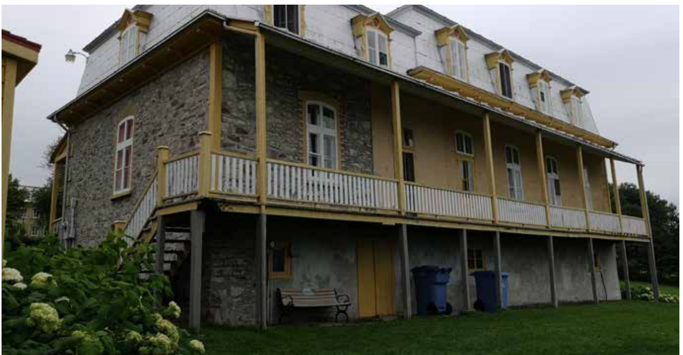
Fig. 23 : La galerie arrière orne la largeur totale du bâtiment et donne accès aux entrées secondaires.
