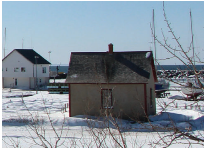
Figure 5 : Façade arrière Nord-est.
