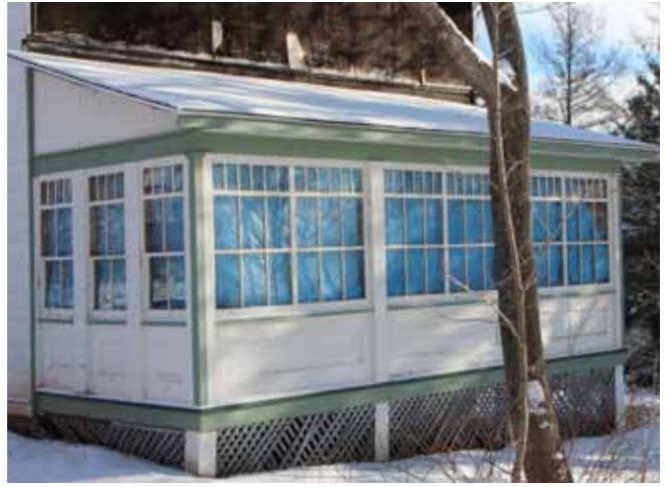
Figure 81 : Il faut ajouter à cela les 5 châssis à quatre carreaux et 6 châssis à six carreaux surmontés d'impostes à carreaux qui constituent la fenestration de la véranda.
