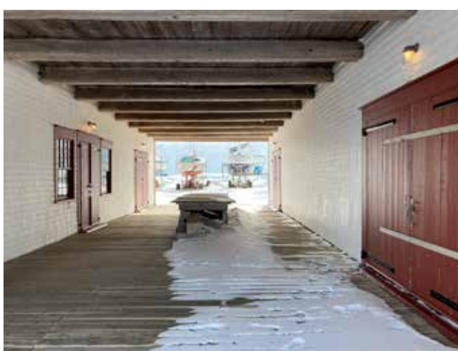
Figure 91 : Le long du corridor central, deux portes doubles et une porte simple donnent accès à la partie est du bâtiment et deux portes doubles à la partie ouest.
