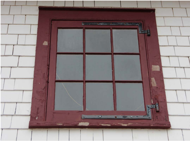
Figure 54 : L'étage est éclairé par 3 fenêtres à 9 carreaux à battant.
