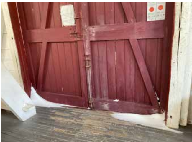
Figure 34 : La porte est à double battant en planches verticales de bois peintes en rouge.
