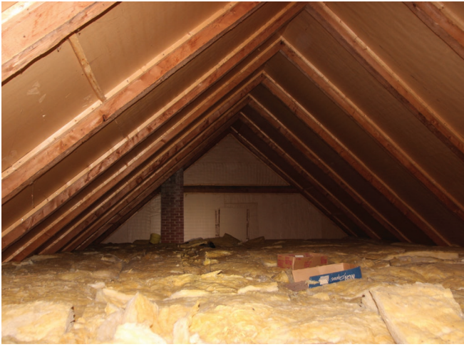
Figure 21 : La charpente est constituée d'arbalétriers en bois, appuyés sur le dessus des murs extérieur.
