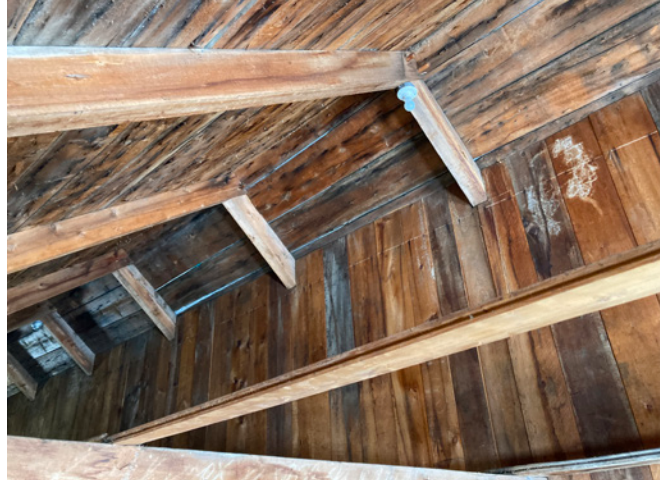
Figure 21 : Les planches du pontage de bois de 25 mm d'épaisseur sont déposées à l'horizontale sur les arbalétriers.
