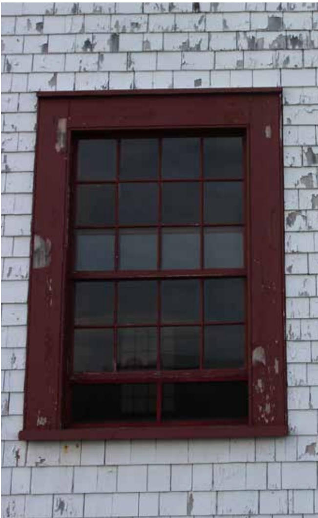
Figure 76 : Le bâtiment possède 43 fenêtres en bois à guillotine de 24 carreaux.
