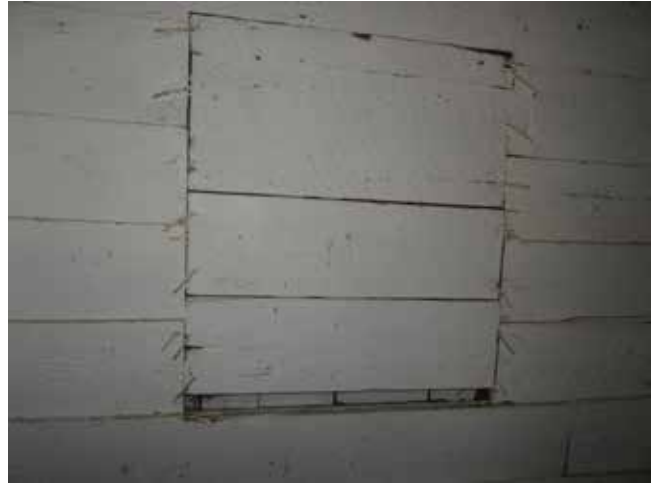
Fig. 22 : Il est possible que toutes les façades du hangar aient été recouvertes, à l'origine, de ce même clin de bois comme en témoignent les murs intérieurs du hangar.
