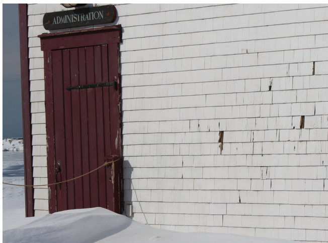
Figure 45 : Une porte simple sur la façade est donne accès au bâtiment.
