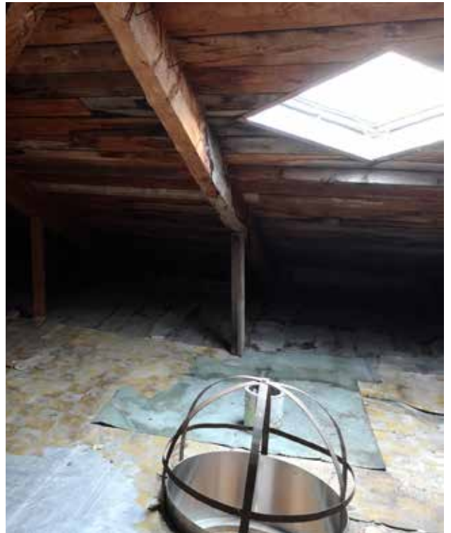
Fig. 37 : Le terrassement est percé de deux lanternes en losange, situés de part et d'autre de la crête.
