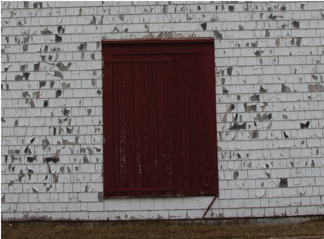
Figure 24 : Comme pour les fenêtres, la porte située sur la façade sud a été reconstituée lors des travaux de 1989. Elle est en bois peint en rouge.
