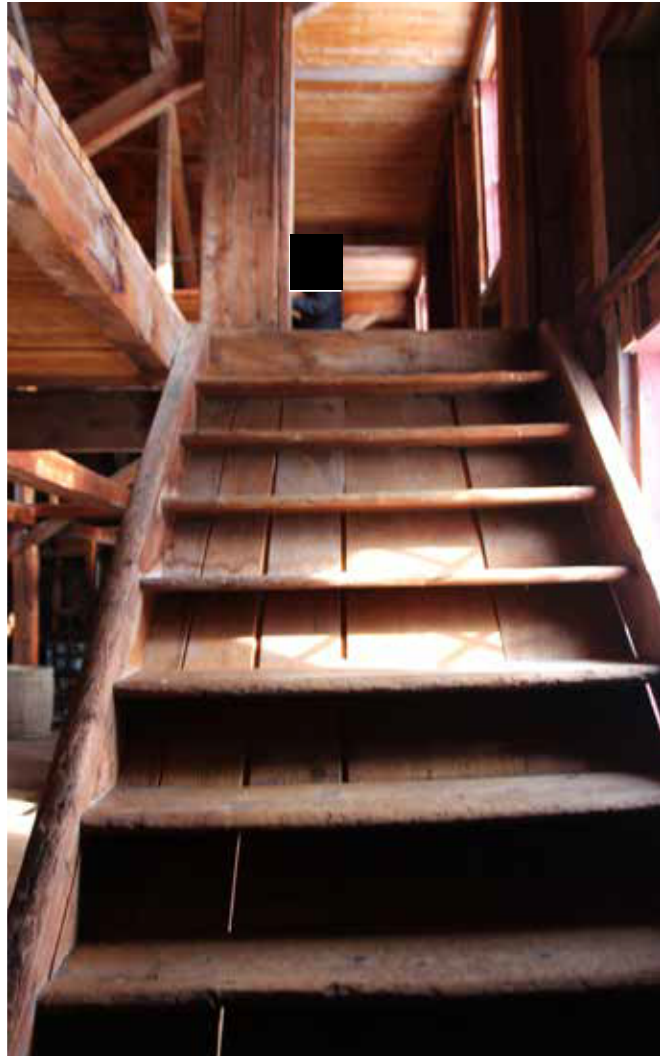
Figure 120 : Des escaliers de meuniers donnent accès aux passerelles situées dans le volume principal.
