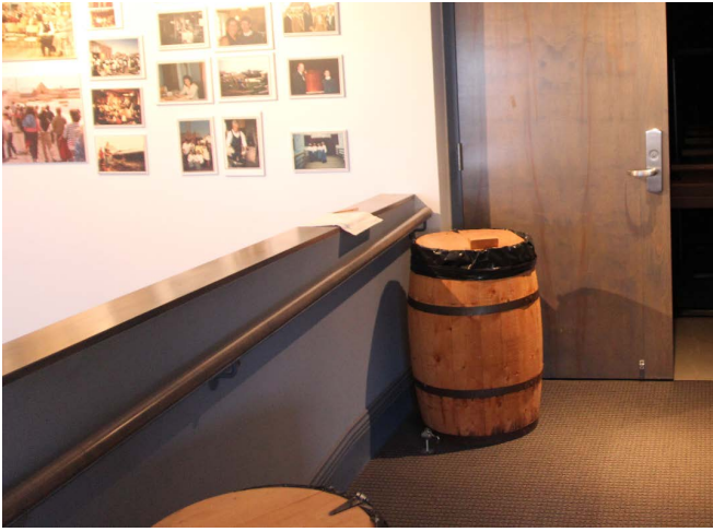
Figure 94 : Des mains-courantes en acier peint sont installées de part et d'autre de l'escalier et de la rampe intérieure sur les murets.
