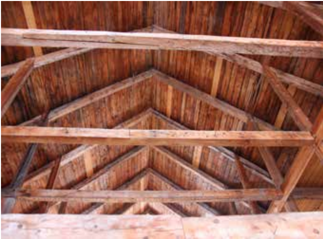
Figure 52 : La toiture en pente à deux versants droits à larmiers incurvés repose sur une charpente en bois visible depuis l'intérieur du bâtiment.
