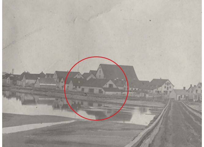
Figure 145 : À l'origine, le bâtiment était implanté en bordure du bārachois.
