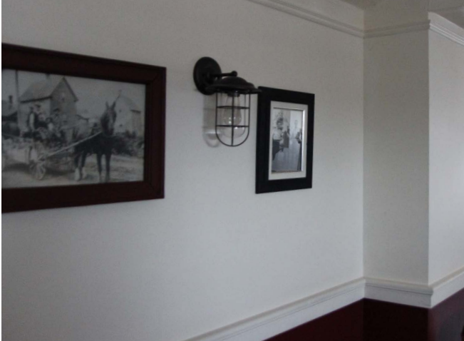
Figure 128 : Des luminaires de type appliqués muraux éclairent la salle à manger.
