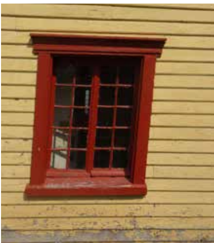
Fig. 25 : Le bâtiment est muni de fenêtres de bois, à battant, à 10 carreaux et peintes en rouge.
