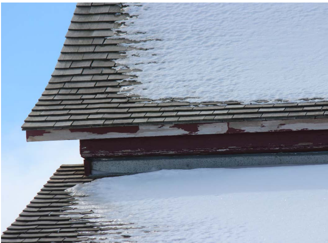
Figure 78 : Un solin métallique assure l'étanchéité entre la toiture de l'appentis et le mur nord du volume principal.
