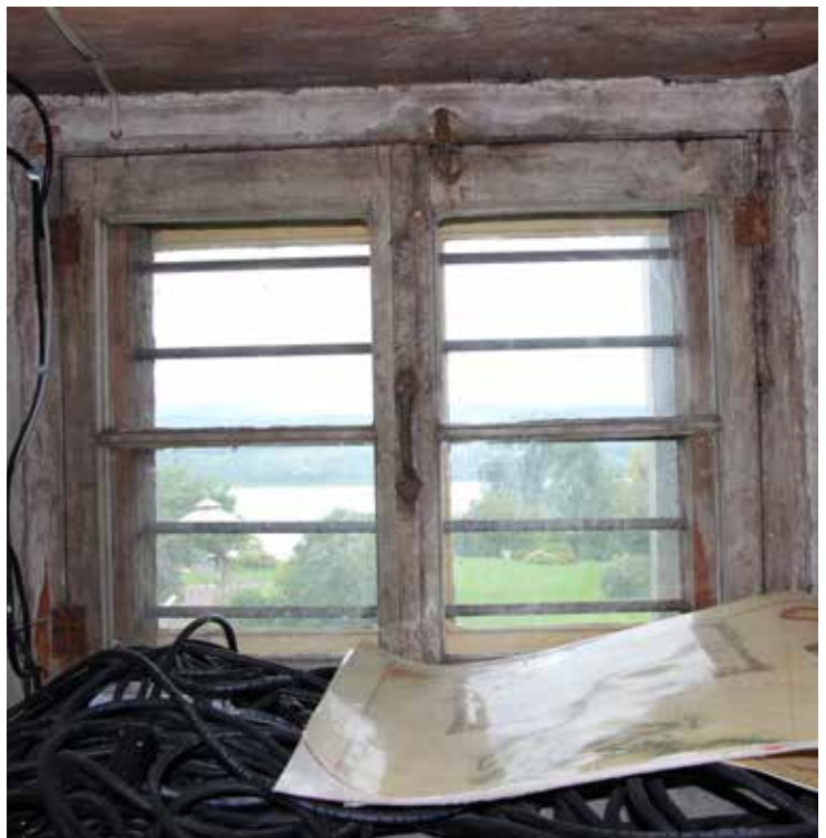
Fig. 49 : Les fenêtres du sous-sol sont en bois avec des divisions à quatre carreaux. Des barres anti-intrusions ont été installées entre les fenêtres et les contre-fenêtres.
