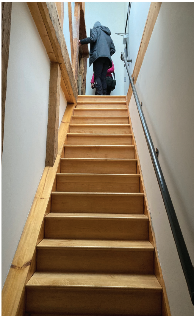
Figure 81 : Deux escaliers d'issue conforme en bois verni avec main-courante métallique ont été ajoutés au bâtiment le long des deux murs pignons.
