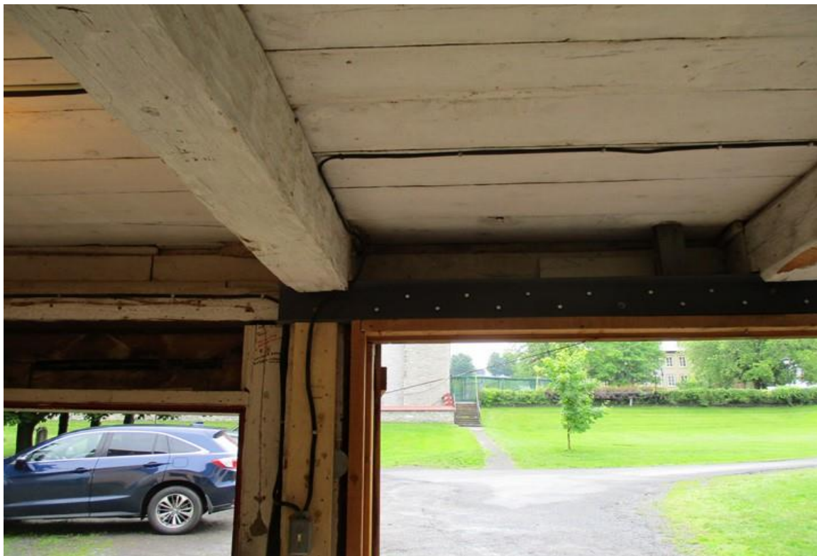
Photo 8: Renfort du linteau et renfort des colonnes supportant ce dernier
