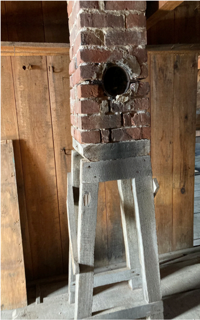
Figure 53 : Une seconde souche de cheminée de briques est installée dans une des pièces de l'étage.
