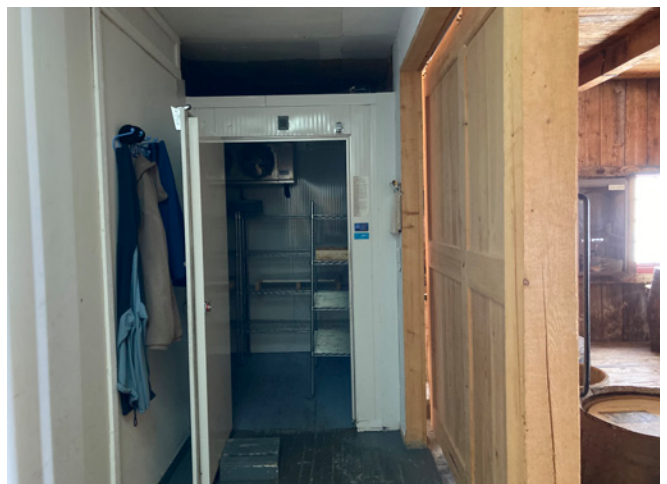
Figure 57 : Dans la partie arrière du bâtiment, des chambres froides ont été aménagées.
