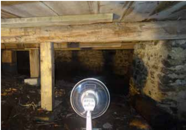
Fig. 11 : Un vide sanitaire est présent sous le bâtiment.
