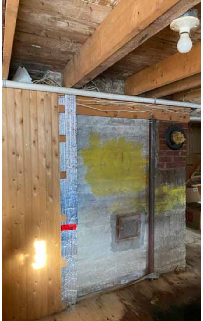
Figure 91 : Cette cheminée repose au sous-sol sur une large base en béton coulé sur place, dans laquelle a été aménagée la trappe du tiroir à cendre. La maison était chauffée par un poêle ou une chaudière située au sous-sol, comme en témoigne le trou qui a été bouché par des nattes d'isolant.
