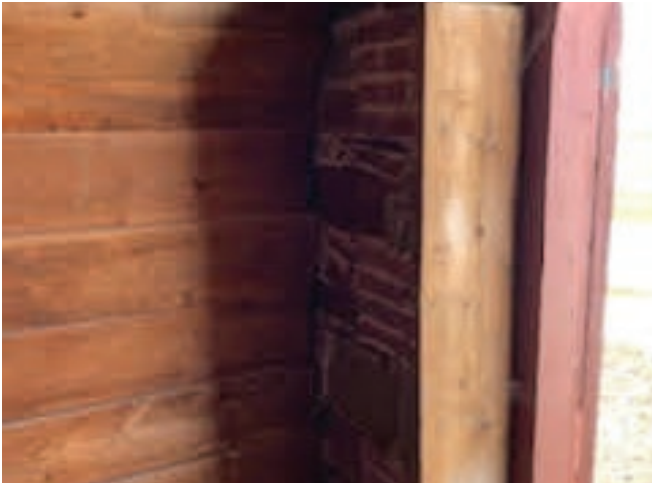
Figure 35 : Les murs intérieurs sont recouverts de planches de cèdre généralement en bon état. Photo transmise par le client.
