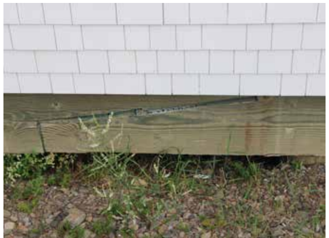
Figure 27 : Au coin sud-ouest, le bâtiment est déposé sur une poutre de bois traité qui a été installée lors des derniers travaux de restauration.
