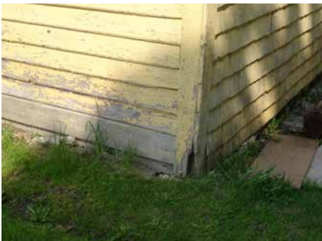
Fig. 13 : Le périmètre du bâtiment est entouré de gazon. Nous recommandons l'ajout d'un lit de propreté au pourtour des fondations.
