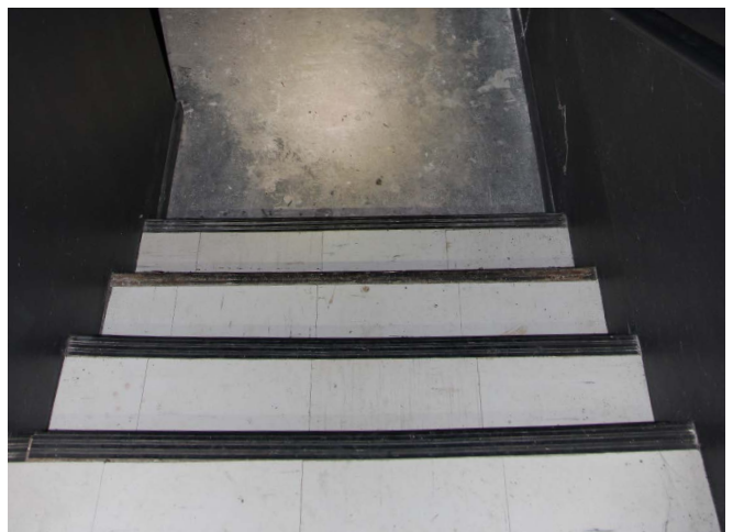
Figure 93 : Les escaliers sont recouverts de linoléum avec nez de marche en caoutchouc.
