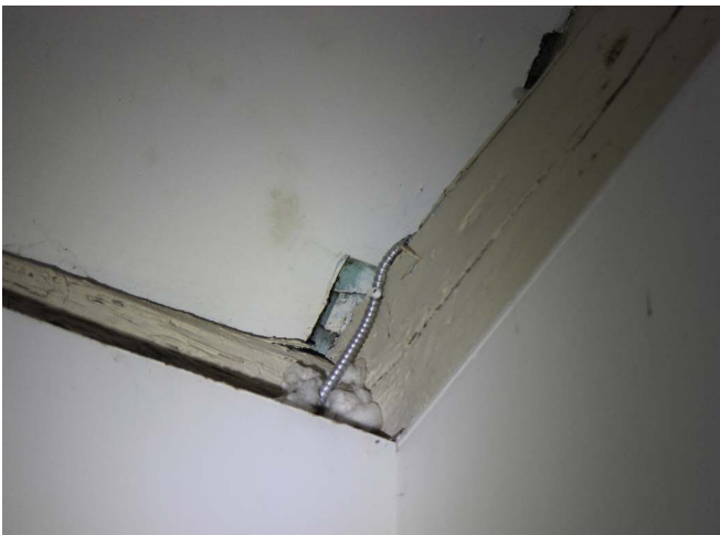
Figure 80 : La toiture a été isolée lors des travaux de 1988.
