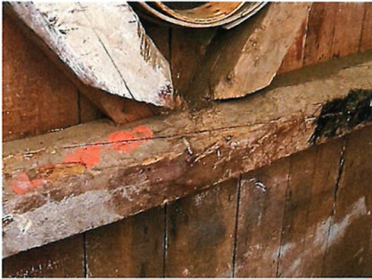
Photo #18 Structure murale en bon état
