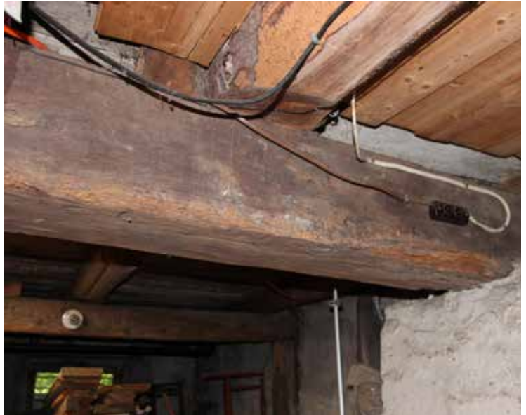
Fig. 14 : Les solives des planchers ont été amincies afin d'être déposée sur la poutre maîtresse.
