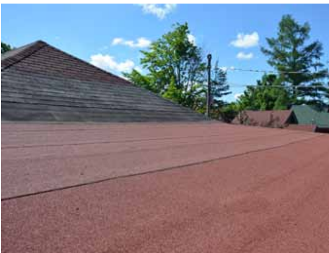
Figure 77 : La toiture de l'annexe est recouverte d'asphalte en rouleaux.
