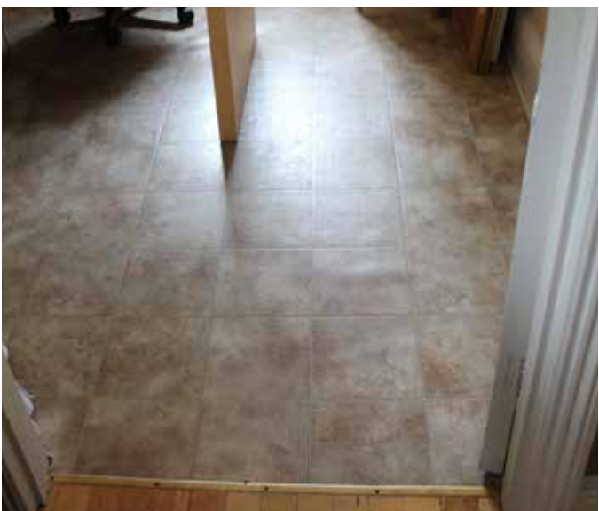
Fig. 106 : Une partie du plancher de l'étage de la maison d'été est en céramique.
