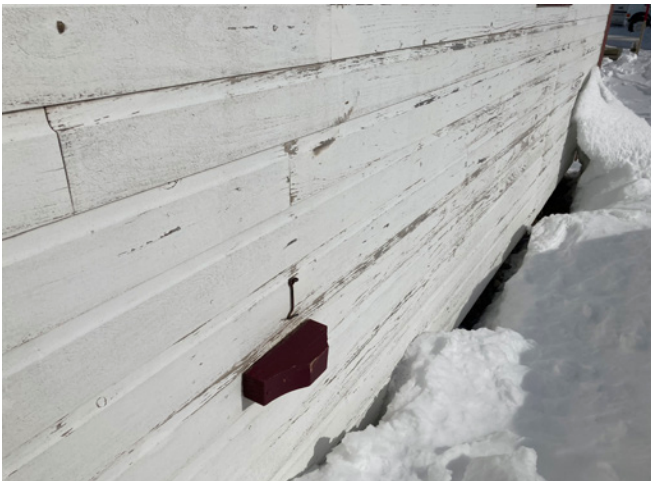
Figure 26 : Les murs extérieurs sont revêtus de planches à gorge, ou à feuillure, peint blanc. Un système de blocs de bois et de crochets permet de laisser les portes en position ouverte.
