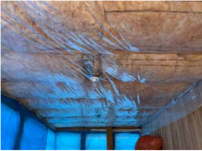
Figure 60 : Le plafond de la vréanda a été isolé par des nattes d'isolant entre les poutre de la structure du plafond. Un pare-vapeur a été posé par dessus, mais la finition de plafond n'a pas été restaurée.
