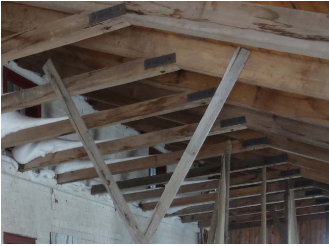
Figure 30 : Des pièces métalliques fixent les entrails aux chevrons.
