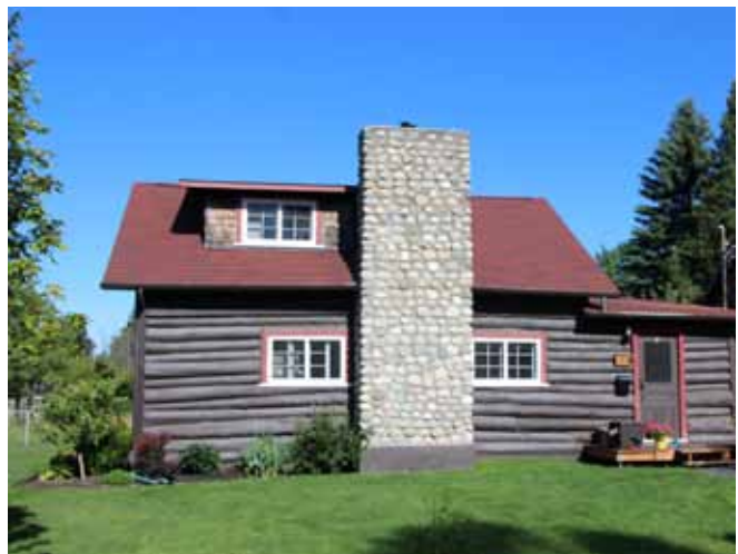
Figure 101 : Les principales modifications à l'extérieur consistent en l'ajout d'une large cheminée maçonnée en pierre sur la façade latérale est
