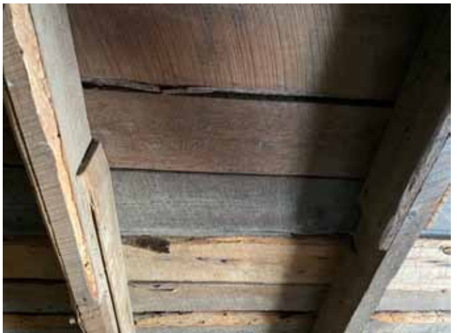
Figure 50 : La structure de toiture est constituée d'un platalage posé sur des chevrons en bois de sciage espacé tous les 2 pi environ.
