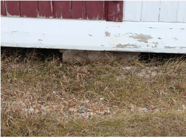
Figure 14 : Le bâtiment est déposé sur des pilotis de bois.
