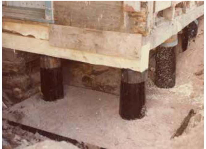
Figure 25 : Des semelles de béton ont été ajoutées sous les poteaux de bois remplacés lors des travaux de restauration antérieurs. Source: Collection du SHNP. 1981.
