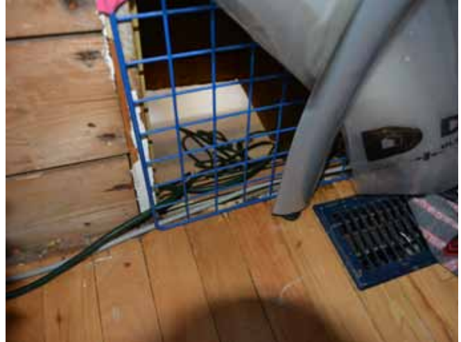
Figure 165 : Des trappes permettent à l'air de circuler entre le rez-de-chaussée de l'appentis et les chambres à l'étage de la maison.
