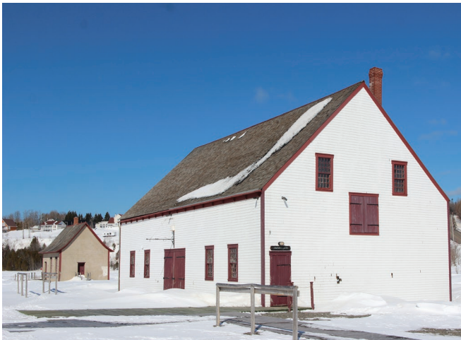
Figure 4 : Façade latérale nord-ouest.
