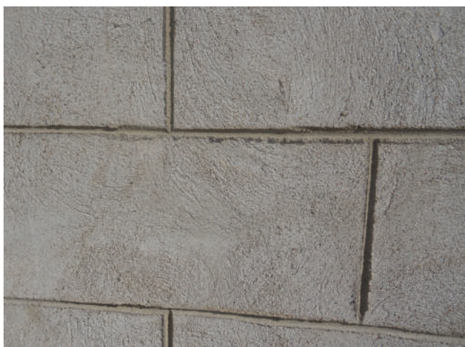
Figure 25 : Pour uniformiser l'enveloppe extérieure les murs ont été enduits de crépis et lignés de faux joints pour imiter la pierre de taille.
