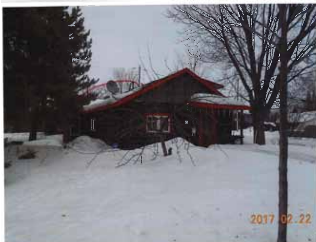
Figure 138 : Photographie prise en février 2017 montrant la formation de digue de glace du côté sud-ouest. Photographie transmise par la ville de Val-d'Or.
