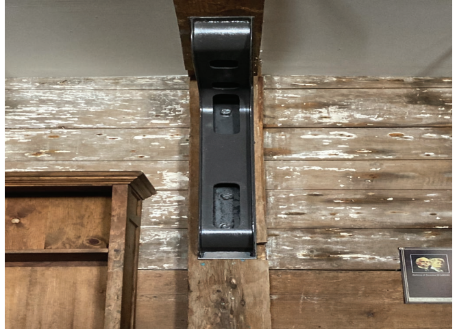
Figure 26 : Certaines de ces consols ont été remplacées par des consols métalliques.
