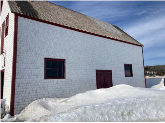
Figure 27 : La peinture sur les bardeaux s'efface, mais les bardeaux sont généralement en bon état.
