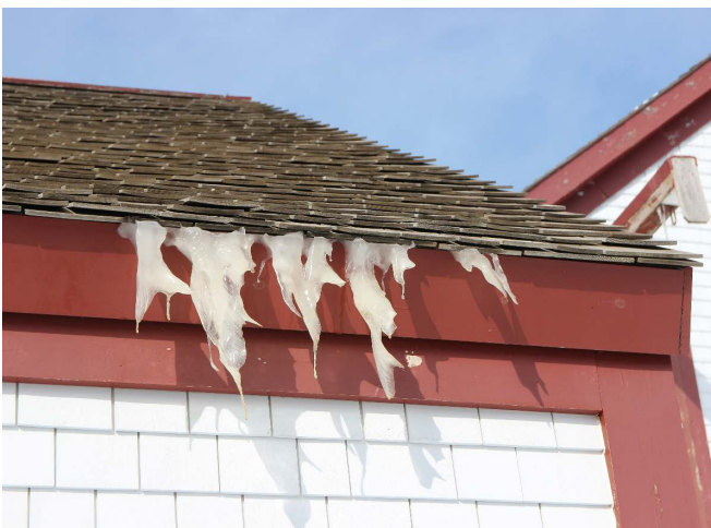
Figure 76 : Quelques bardeaux sont retroussés parfois dans le sens de la largeur parfois dans le sens de la longueur.
