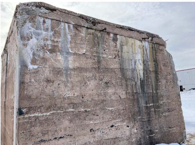
Figure 18 : Le toit plat est constitué de béton.
