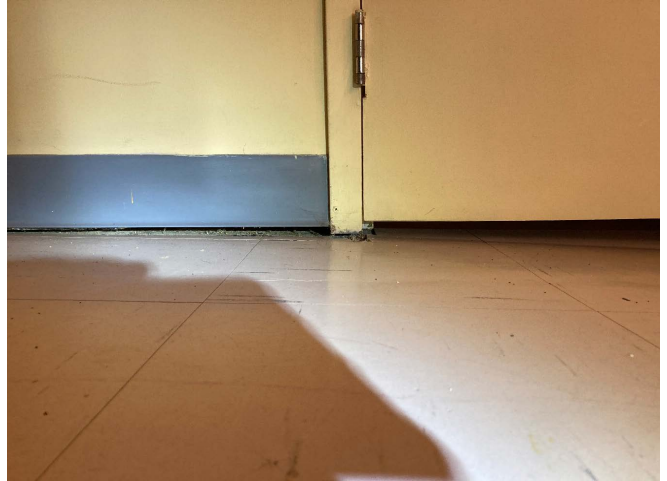
Figure 99 : Le plancher de la loge et de la scène sont recouverts de linoléum.
