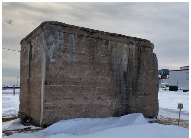
Figure 5 : Façade arrière nord.
