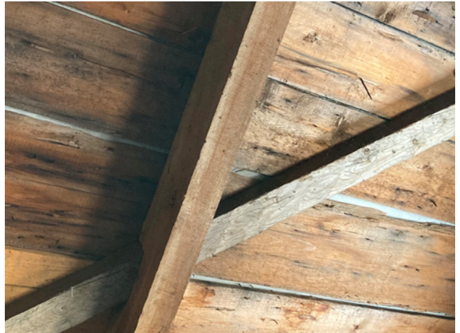
Figure 50 : Lors des travaux de restauration, le revêtement de toiture a été installé sur une membrane visible entre les planches du platelage depuis l'entretoit.
