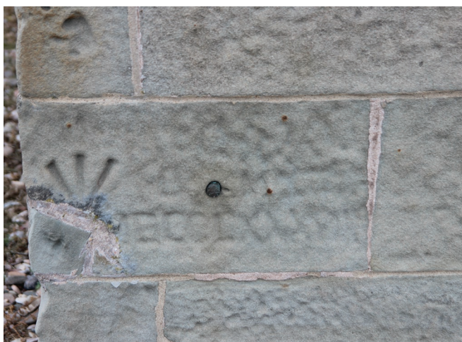
Figure 22 : Une pierre millésimée est située en façade avant sud. La date 1788 est gravée en chiffres romains (MDCCLXXXVIII).
