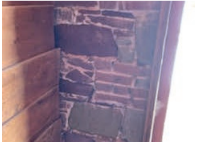
Figure 36 : La maçonnerie structurale constituée de pierres est visible sur le mur intérieur avant sud. Photo transmise par le client.
