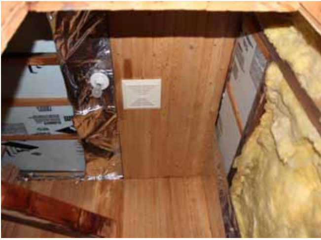
Figure 66 : Des nattes d'isolant en laine de roche et des panneaux d'isolant en polystyrène extrudé sont visibles entre les montants.
