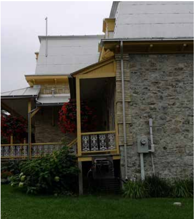
Fig. 116 : L'entrée électrique est située sur le côté droit du bâtiment.
