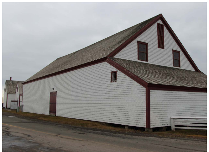
Figure 5 : Façade arrière nord.
