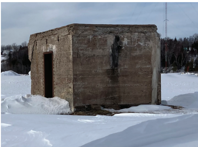
Figure 4 : Façade latérale ouest.
