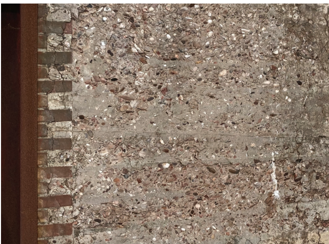
Figure 20 : La structure des murs est en béton artisanal. Il contient des agrégats vraisemblablement d'origine locale.
