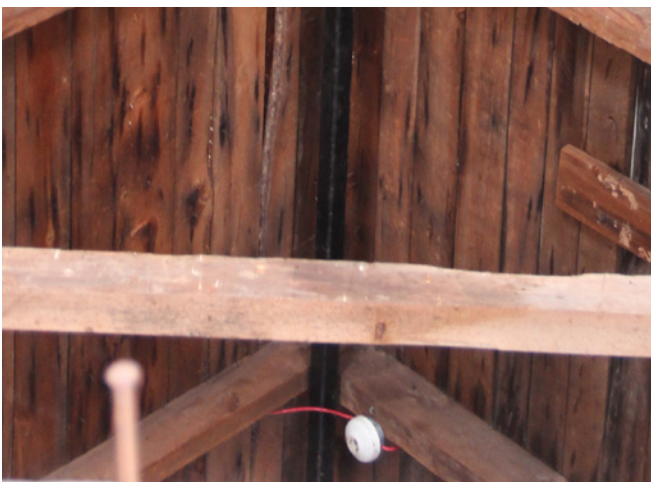
Figure 50 : Le bâtiment est muni d'un détecteur de fumée
