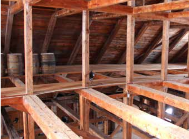
Figure 125 : Des câbles électriques sont disposés le long de la structure du bâtiment pour alimenter celui-ci en électricité et éclairage.
