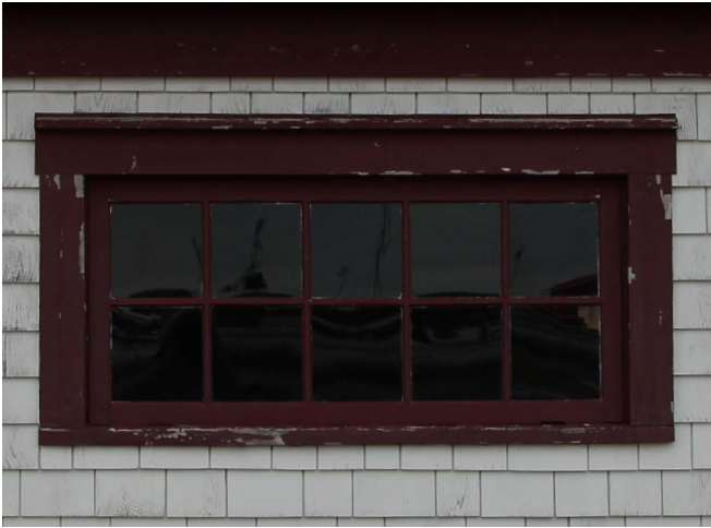
Figure 38 : Les 6 fenêtres fixes situées sur la façade sud des appentis ont 10 carreaux .
