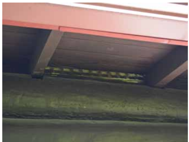
Figure 17 : Les ouvertures dans les planches au sommet des murs fermant l'espace entre les chevrons ont été remplacés par des grilles métalliques sur la maison témoin. 123, avenue Perrault.
