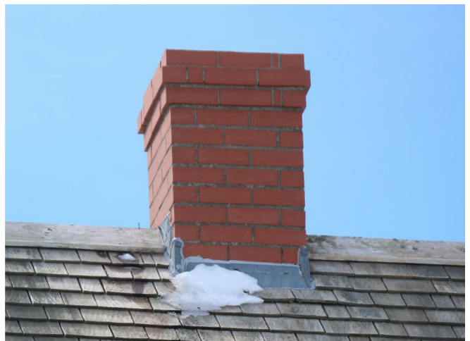
Figure 81 : La cheminée est en bon état. Un solin métallique assure l'étanchéité.
