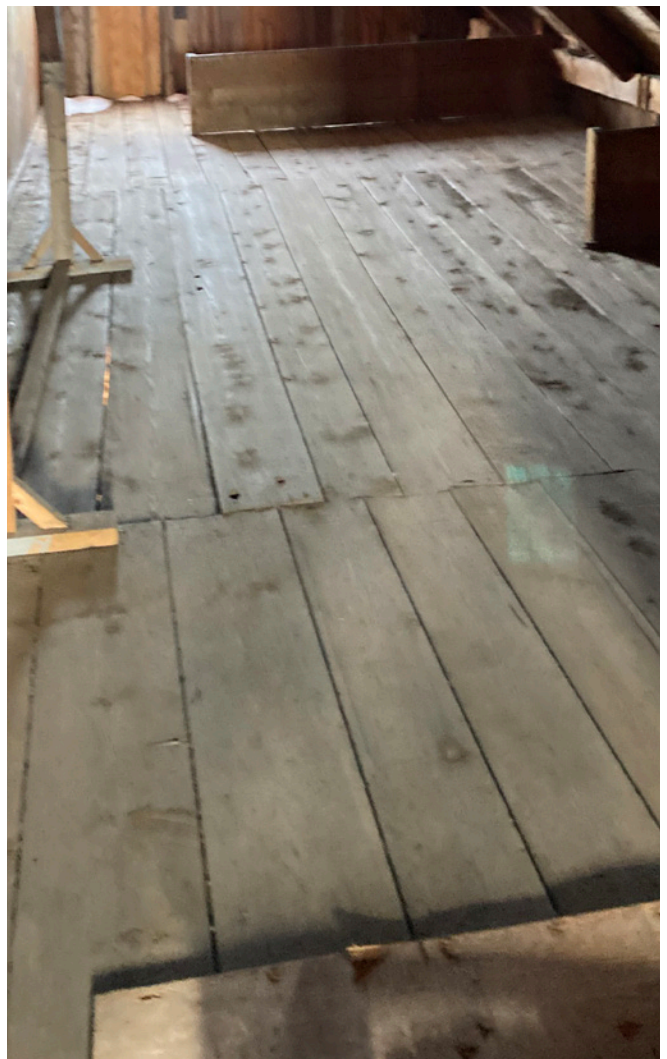
Figure 62 : Le plancher de l'étage est en planches de bois nu. Les planchers sont probablement d'origine. Ils sont en bon état.
