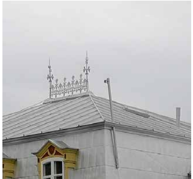
Fig. 35 : Le terrassement est surmonté d'une crête faîtière et est percé de deux lanternes en losange, situés de part et d'autre de cette crête.
