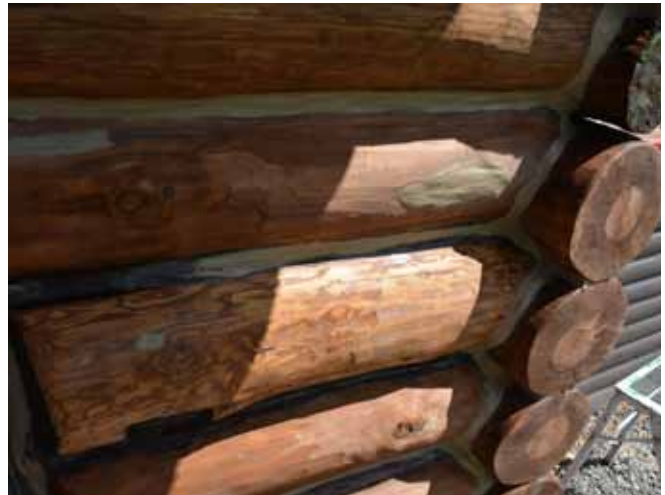
Figure 98 : Si un billot peut être conservé, il remplit les cavités avec du chinking.
