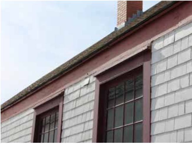
Figure 28 : Une planche décorative dans le haut des murs en bois peint en rouge orne le bâtiment d'accueil.
