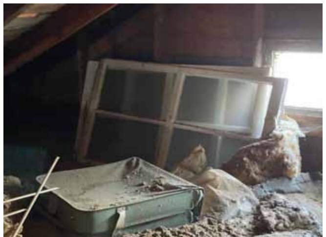
Figure 79 : Des contre-fenêtres conservées dans l'entretoit suggère que les fenêtres d'origine étaient à quatre carreaux.
