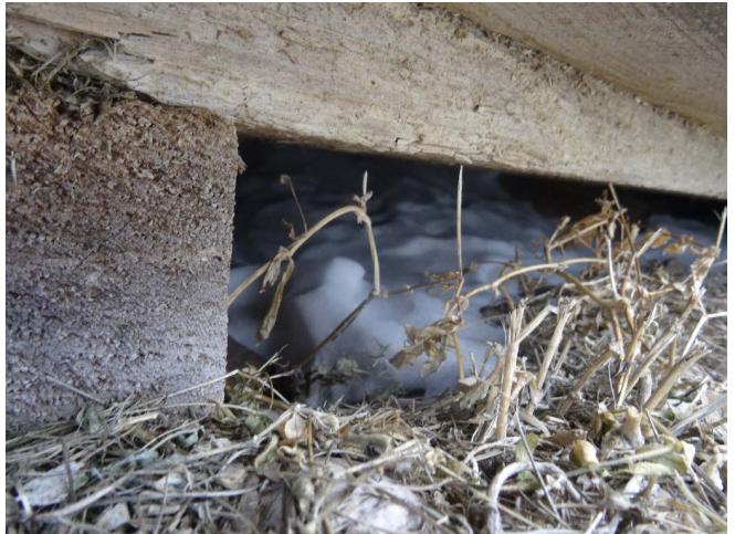
Figure 17 : La poutre centrale est appuyée au centre sur des poteaux de bois.
