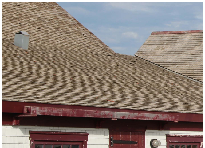
Figure 77 : Quelques bardeaux sont retroussés parfois dans le sens de la largeur parfois dans le sens de la longueur.
