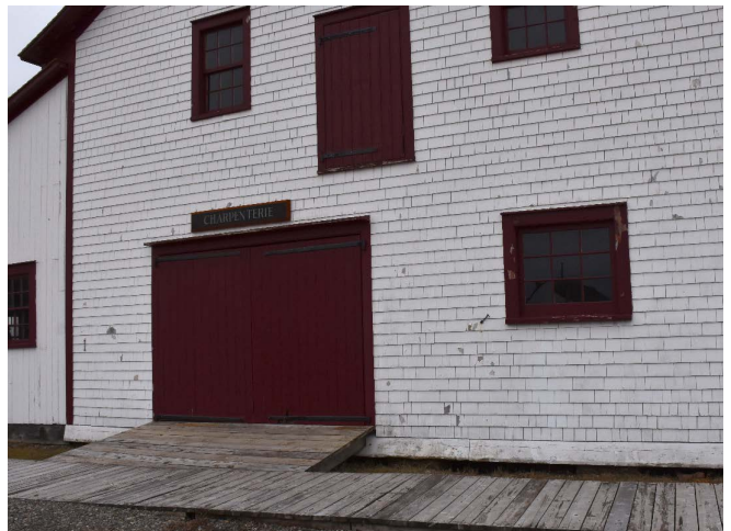
Figure 95 : Un trottoir de bois donne accès au bâtiment depuis la façade ouest et permet de relier la charpenterie aux autres bâtiments du site.
