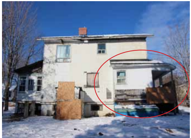
Figure 5 : Façade arrière sud. La galerie le long de la façade est se prolonge devant la façade arrière sud, créant un petit espace intérieur en saillie de la façade.
