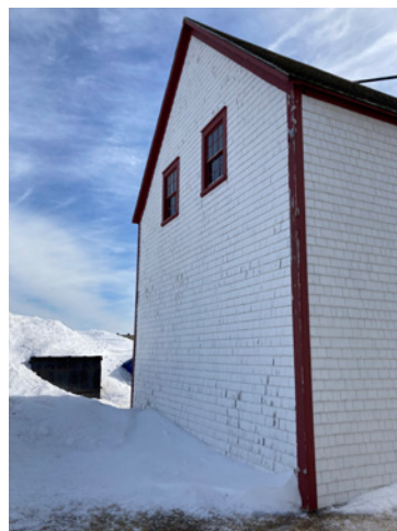
Figure 5 : Façade arrière nord.
