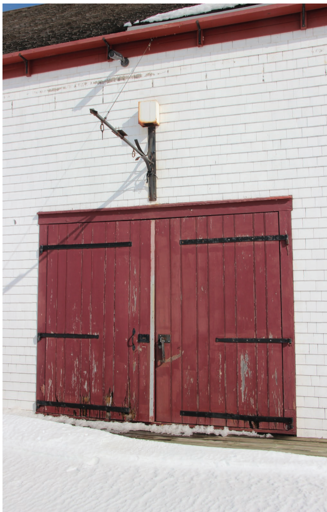
Figure 44 : Le bâtiment possède une porte à doubles vantaux au rez-de-chaussée.
