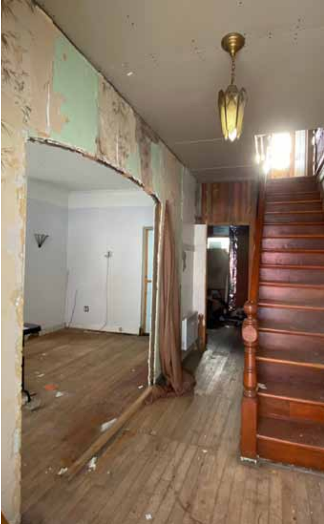
Figure 95 : La distribution intérieure de la maison a généralement été préservée. Une arche en anse de panier a été aménagée dans la cloison à gauche de l'escalier, entre le salon et le passage central.
