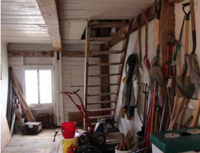
Fig. 66 : Un escalier de bois permet d'accéder à l'entretroit.
