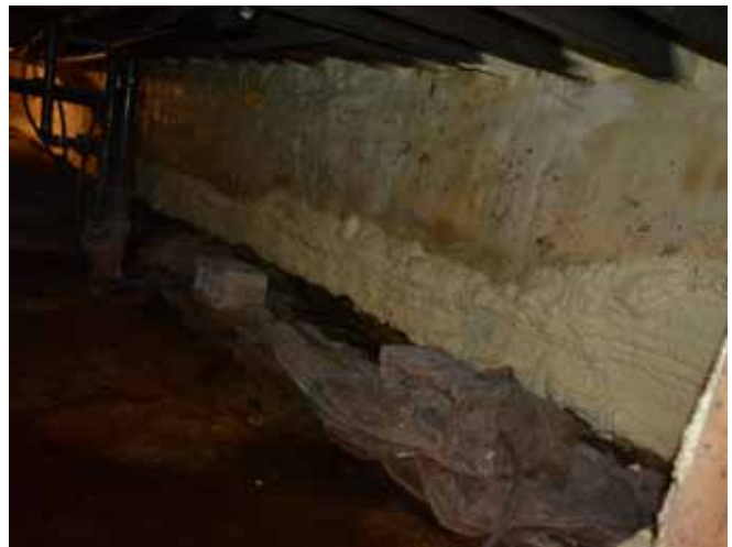
Figure 116 : De l'uréthane a été giclé à l'intérieur du vide sanitaire, recouvrant l'appareillage de maçonnerie ainsi que les extrémités des solives du plancher et la poutre de rive du rez-de-chaussée.
