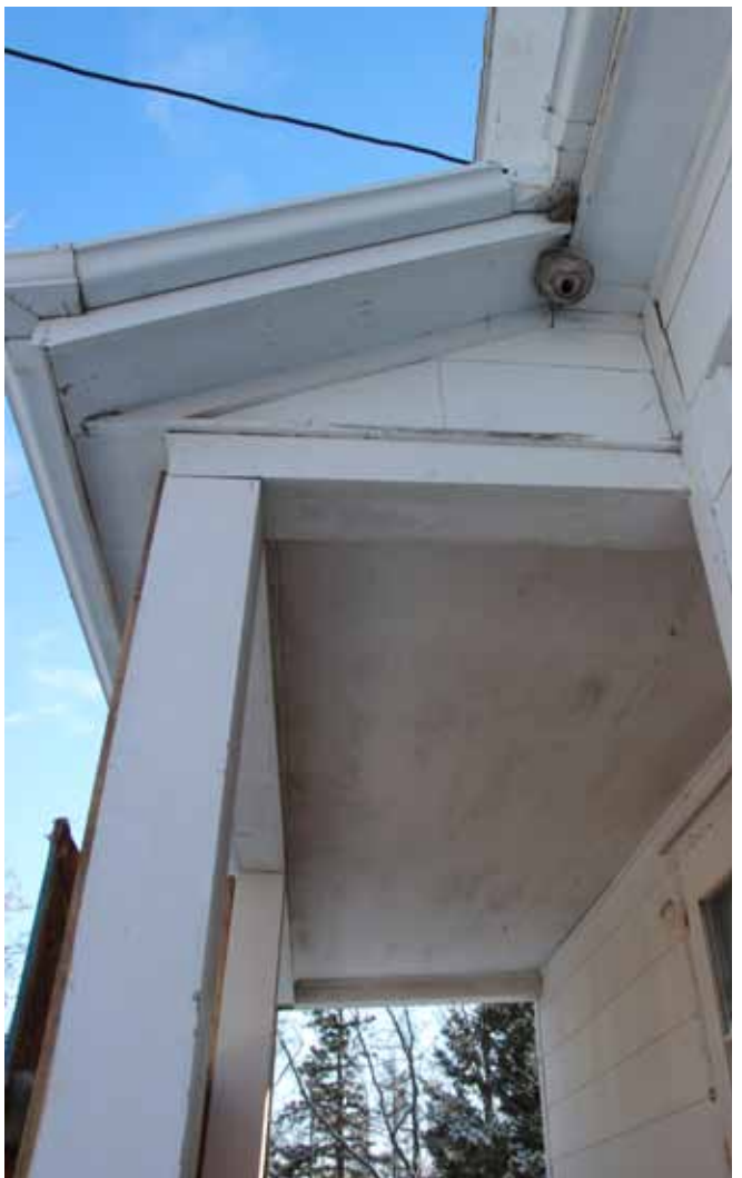
Figure 38 : La toiture de la galerie est supportée par des colonnes de section carrée en bois peint en blanc et le plafond de la galerie est constitué de planches de contreplaqué peint en blanc.
