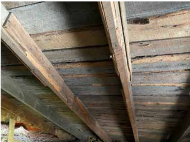
Figure 49 : La structure de toiture est constituée d'un platalage posé sur des chevrons en bois de sciage espacé tous les 2 pi environ.
