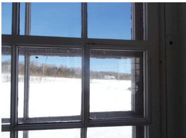
Figure 38 : Du côté intérieur, un guichet est installé dans la fenêtre.
