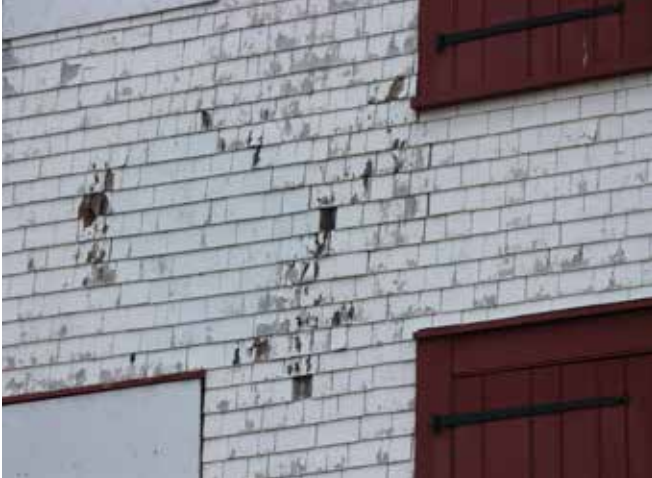
Figure 70 : Plusieurs bardeaux sont pourris et doivent être remplacés alors que d'autres sont tombés.
