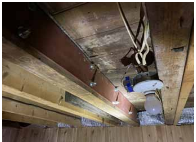
Figure 26 : Certaines solives ont été renforcées par moilage au moyen de tiges et profilés métalliques.
