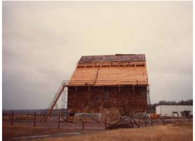
Figure 105 : En 1981, de nouveaux bardeaux de cèdre sont installés sur une membrane. Source: Collection du SHNP. 1981.
