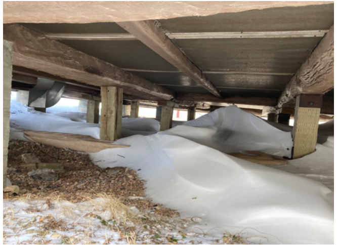
Figure 15 : La tonnellerie est installée sur des fondations en blocs de béton réalisées en 2003.
