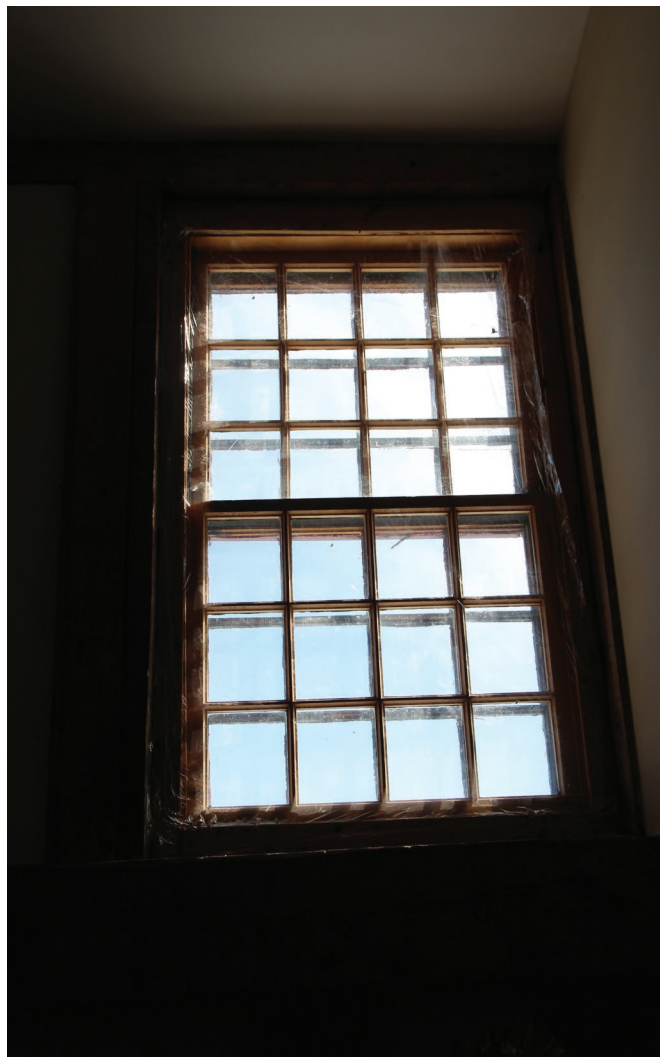
Figure 42 : Du côté intérieur, les fenêtres sont en bois nu.
