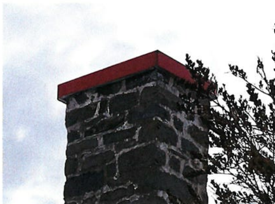
Photo #26 INTERVENTION #6 Le solin au-dessus de la cheminée est à remplacer et il couvrira l'ensemble de la surface de bois.
