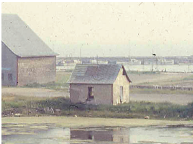
Figure 36 : En 1980, avant les travaux de restauration, des fenêtres complètes sont absentes. Collection du SHNP 1980.
