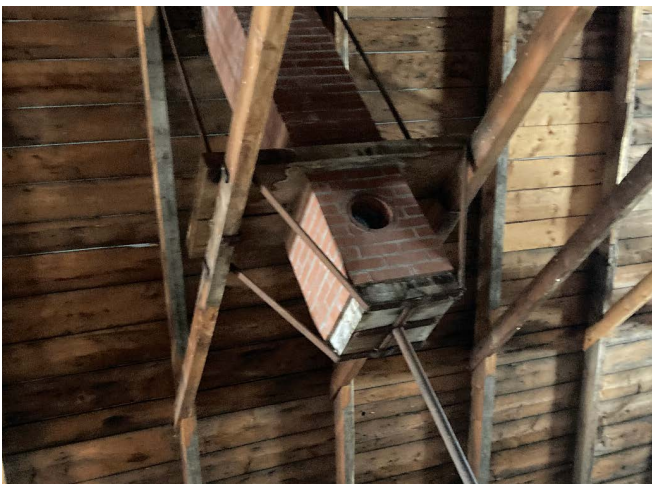
Figure 80 : Au tournant du 20e siècle, une cheminée est ajoutée au bâtiment.
