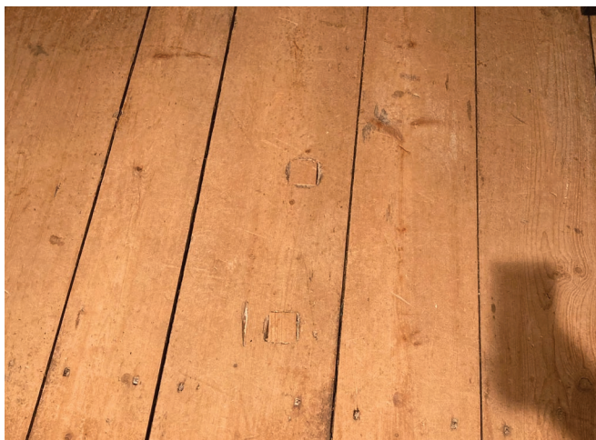
Figure 19 : En général, les planchers sont en bon état.
