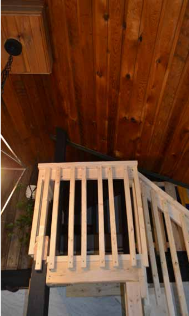
Figure 135 : La finition intérieure est constituée de lattes de bois verni.
