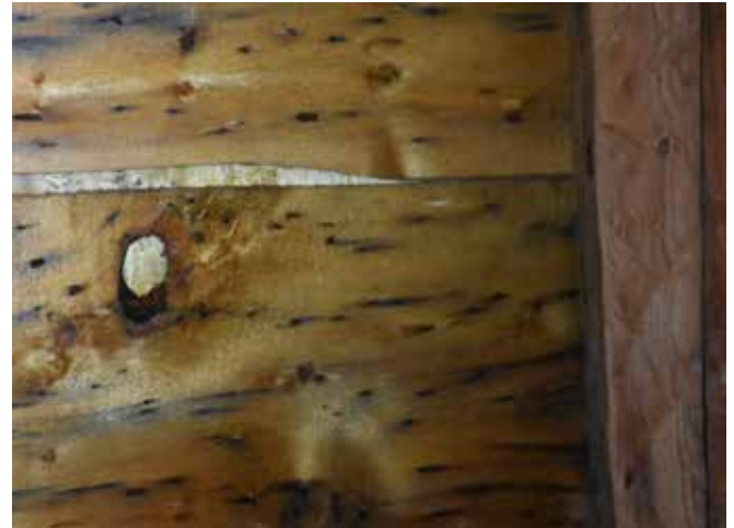
Figure 61 : À l'origine, le revêtement de bardeaux de cèdre était chaulé et posé sur de l'écorce de bouleau. De l'intérieur, à certains endroits, l'écorce est toujours visible.
