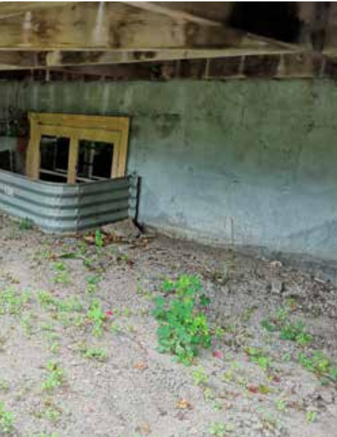
Fig. 9 : À l'avant, les fondations sont apparentes et surélevées par rapport au niveau du sol.
