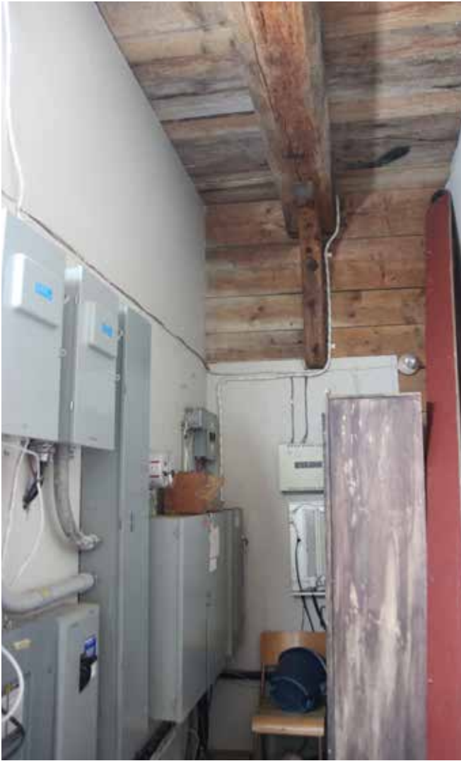
Figure 110 : Dans la salle électriques, les cloisons sont en gypse.
