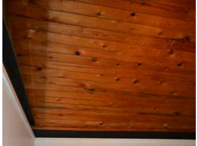
Figure 136 : La finition intérieure est constituée de lattes de bois verni.
