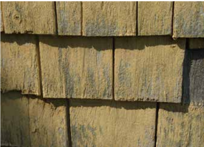
Fig. 17 : Les bardeaux ont été peints en jaune. La peinture est usée laissant parfois le bois à nu.
