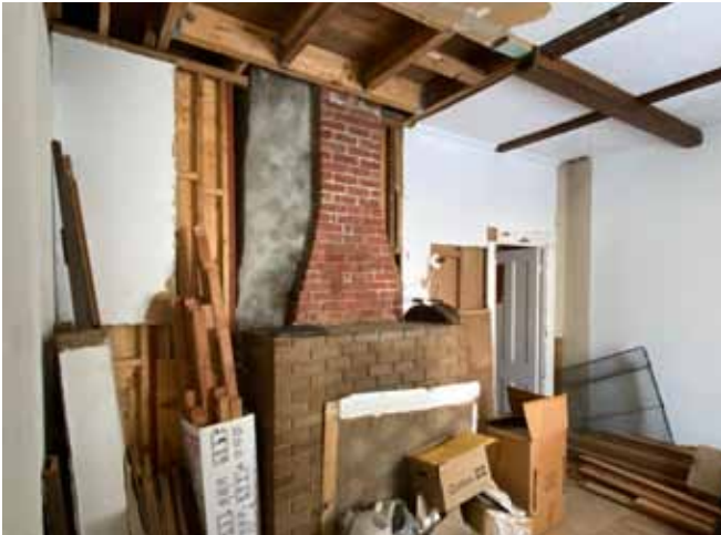
Figure 62 : La structure des murs est peu visible ni de l'intérieur ni de l'extérieur. La structure de la maison est de type à claire-voie.
