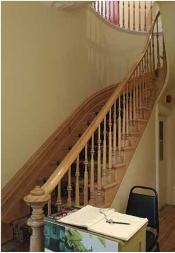
Fig. 96 : Un escalier en bois tournant monumental donne accès à l'étage. Il est d'origine et il contribue à la grande qualité architecturale du bâtiment.
