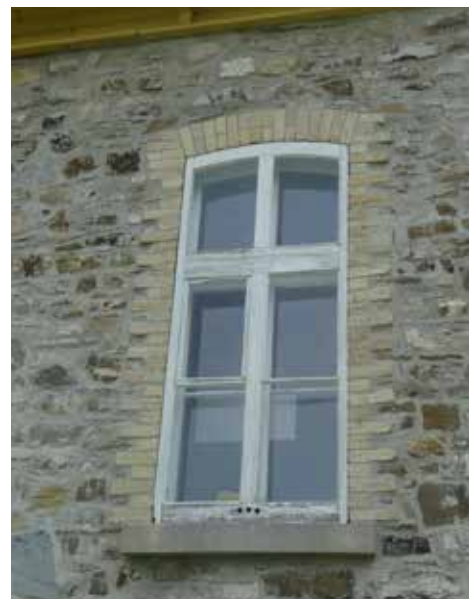
Fig. 45: Sur les murs en pierre de grès, les pourtours des fenêtres sont en briques et les tablettes en pierres de taille.
