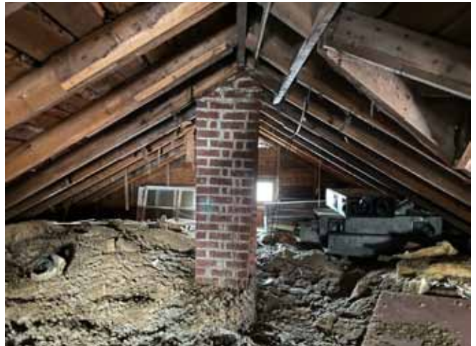
Figure 44 : Le bâtiment est surmonté par une toiture à deux versants droits de faible pente. Les chevrons sont fixés au sommet à une panne faitière.
