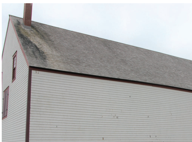
Figure 55 : Le hangar possède un toit à deux versants droits avec faible larmier recouvert de bardeaux de cèdre non peint.
