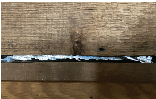
Figure 34 : Un pare-vapeur et un papier noir ont aussi été ajoutés à la composition du mur
