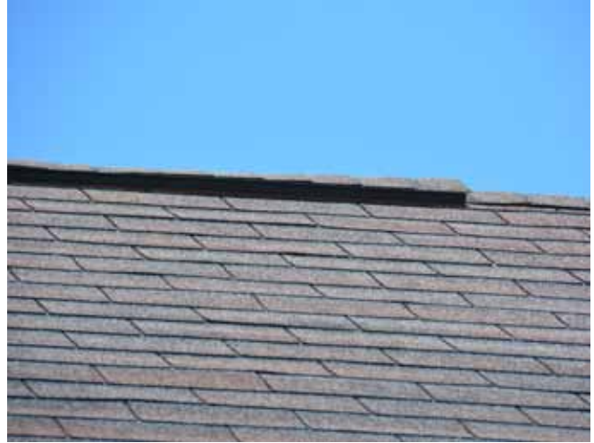
Figure 112 : Une crête faîtière a ensuite été ajoutée pour créer un appel d'air depuis les larmiers.
