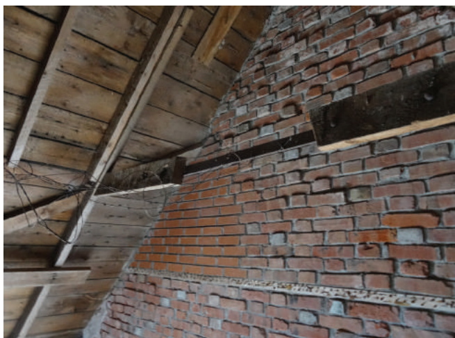
Figure 24 : Les murs sont composés d'un assemblage hétérocyte de pierres et de briques.
