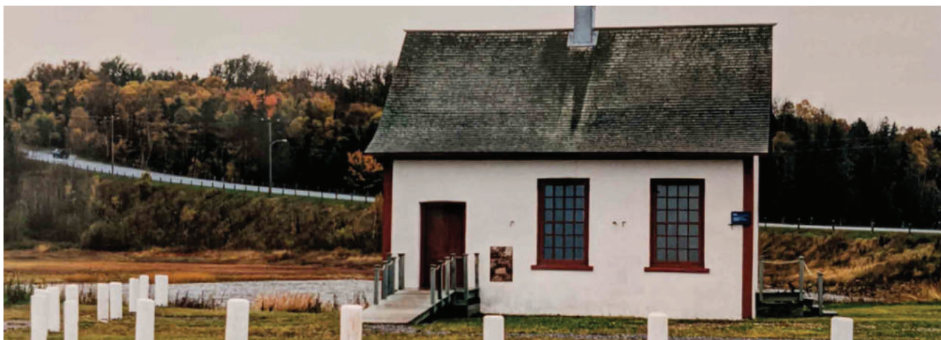
Figure 15 : En 1990, une rampe d'accès est ajoutée à la façade sud-ouest du bâtiment et un escalier à la façade sud-est. Source: Collection du SHNP. 1998.
