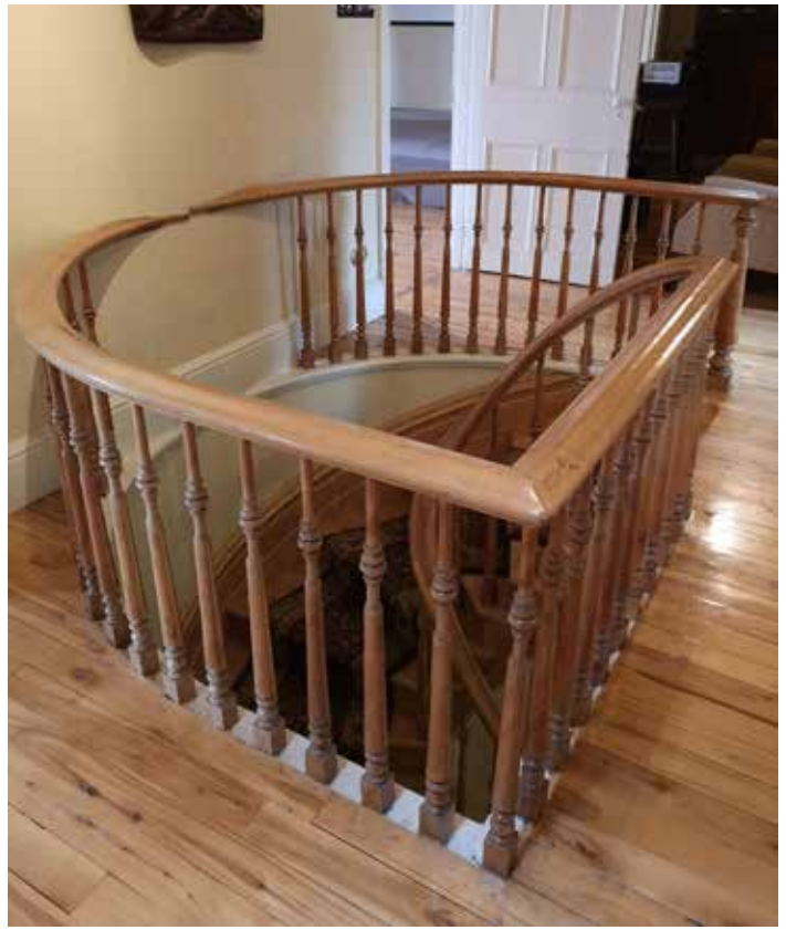
Fig. 97 : Un escalier en bois tournant monumental donne accès à l'étage. Il est d'origine et il contribue à la grande qualité architecturale du bâtiment.
