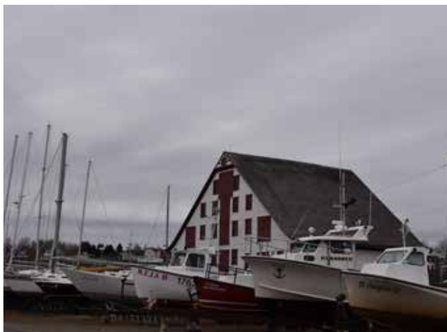
Figure 49 : Le lien avec la baie a été atténué avec le remblayage du terrain entre le bâtiment et la baie.
