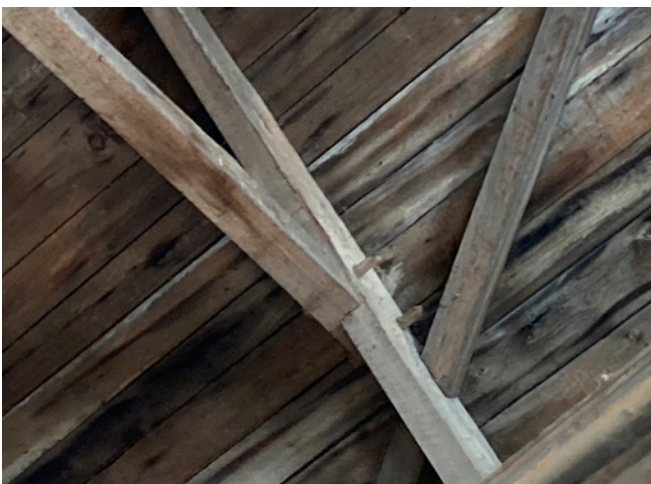
Figure 18 : La charpente est assemblée avec des chevilles de bois.
