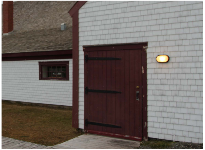
Figure 63 : Sur la cookroom, une porte simple perce la façade sud.
