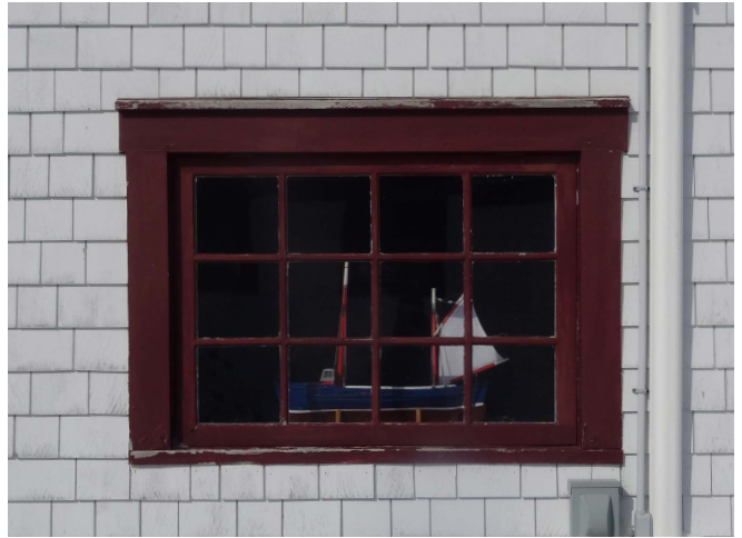
Figure 39 : Les 3 fenêtres fixes situées au rez-de-chaussée de la cookroom ont 12 carreaux.
