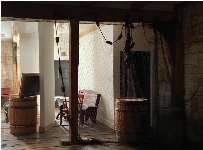
Figure 67 : Au rez-de-chaussée des cloisons fixes composées de gypse ont été ajoutées notamment pour cloisonner les escaliers d'issue.
