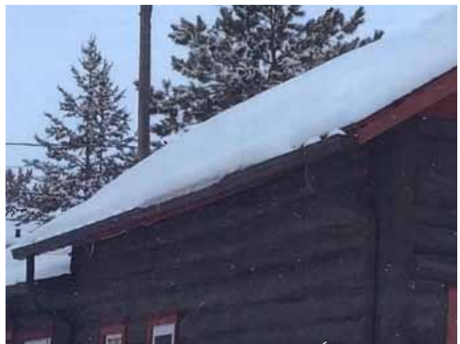
Figure 121 : Le phénomène de formation de digues de glace a diminué sur la moitié arrière de la résidence depuis les travaux d'isolation par l'intérieur. Photographie transmise par la ville de Val-d'Or.
