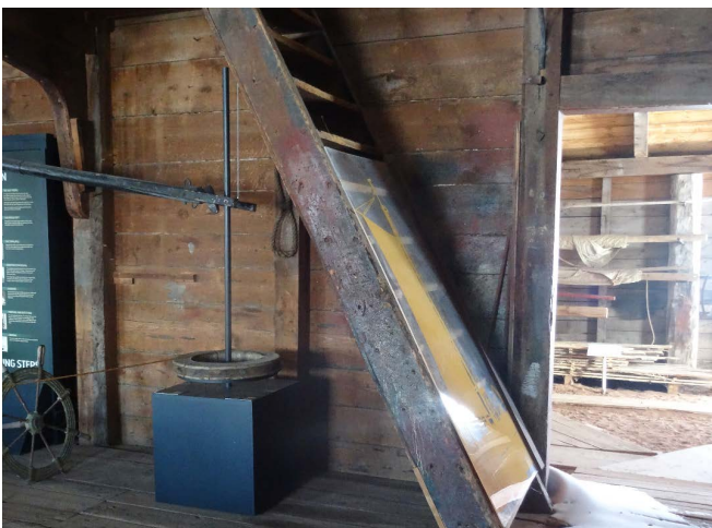
Figure 82 : Les murs intérieurs sont généralement en bon état. Ils sont recouverts de planches de bois laissé à nu.
