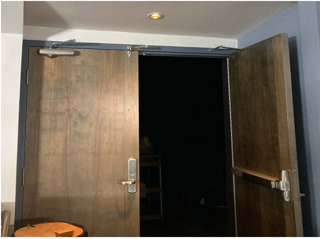
Figure 86 : Des portes de facture contemporaine avec barre panique et ferme-porte ont été installées dans le bâtiment.
