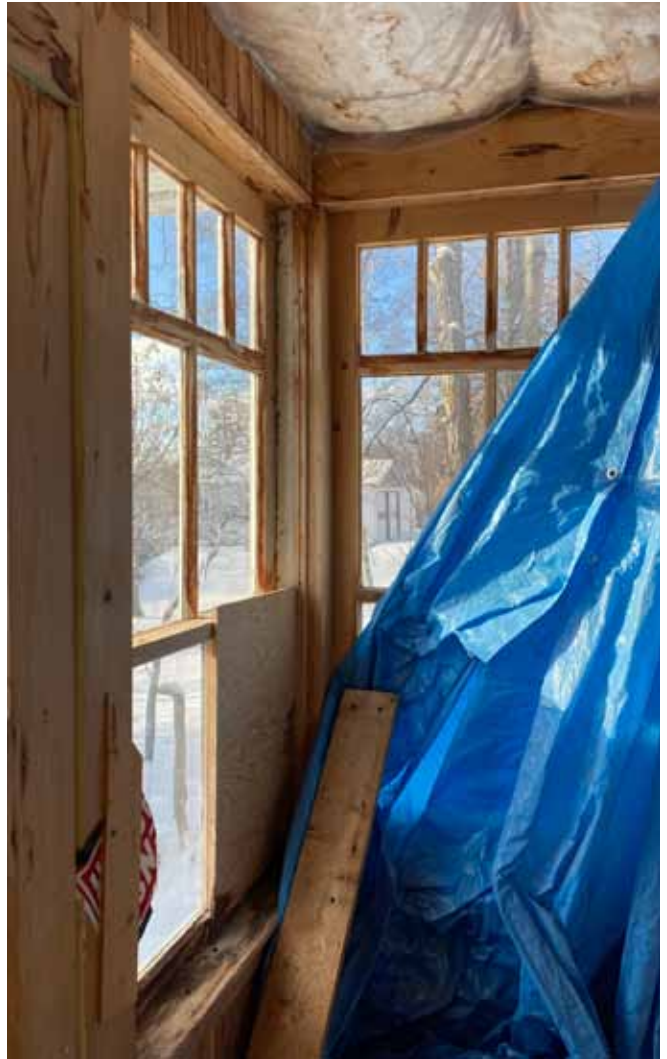
Figure 56 : L'ossature de la véranda est constituée des montants de bois de section carrée entre les fenêtres.
