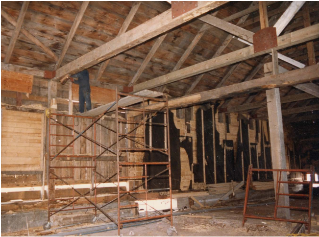
Figure 30 : Lors de ces travaux, plusieurs pièces du platelage de bois pourri ont été remplacées. Travaux de restauration de 1988. Source : Collection du SHNP.
