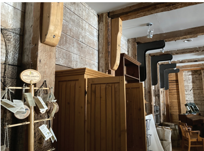
Figure 27 : Certaines de ces consols ont été remplacées par des consols métalliques.
