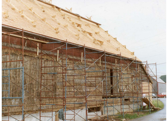
Figure 59 : Les ouvertures de la façade nord ont été révélées lors des travaux de 1988. Collection du SHNP.
