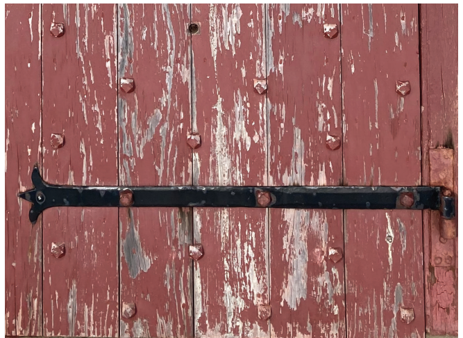
Figure 28 : La quincaillerie, dont les gonds en fer forgé et la clé ancienne, a été nettoyée et peinte en 2005.
