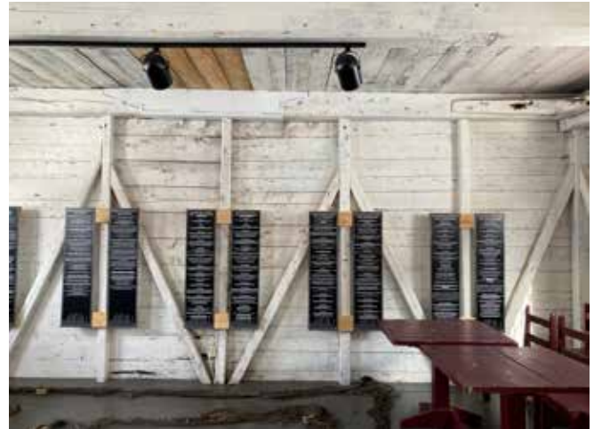
Figure 23 : La structure des murs est visible de l'intérieur du bâtiment. Elle est constituée d'un platelage de bois cloué sur une charpente de bois.
