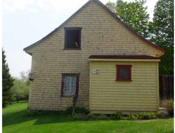
Fig. 4 : Élévation ouest du hangar.
