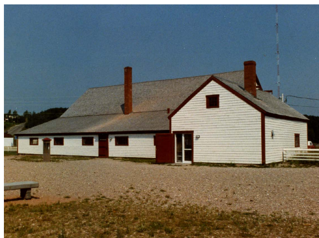
Figure 11 : Après les travaux de restauration de 1988. Collection du SHNP.
