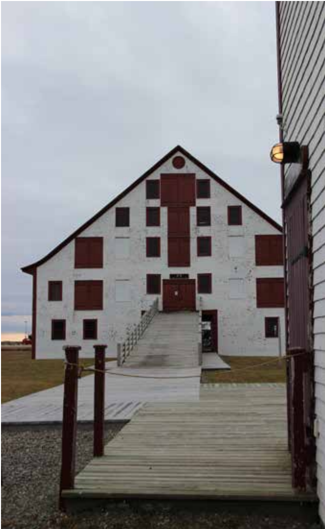
Figure 136 : Un trottoir de bois donne accès au bâtiment et permet de relier l'entrepôt au hangar.
