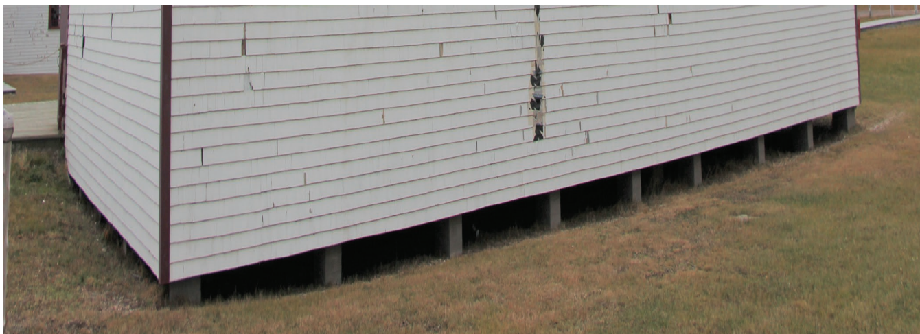
Figure 14 : Le bâtiment a été soulevé et des piliers de béton ont notamment été ajoutés sous le bâtiment en 2004-2005.
