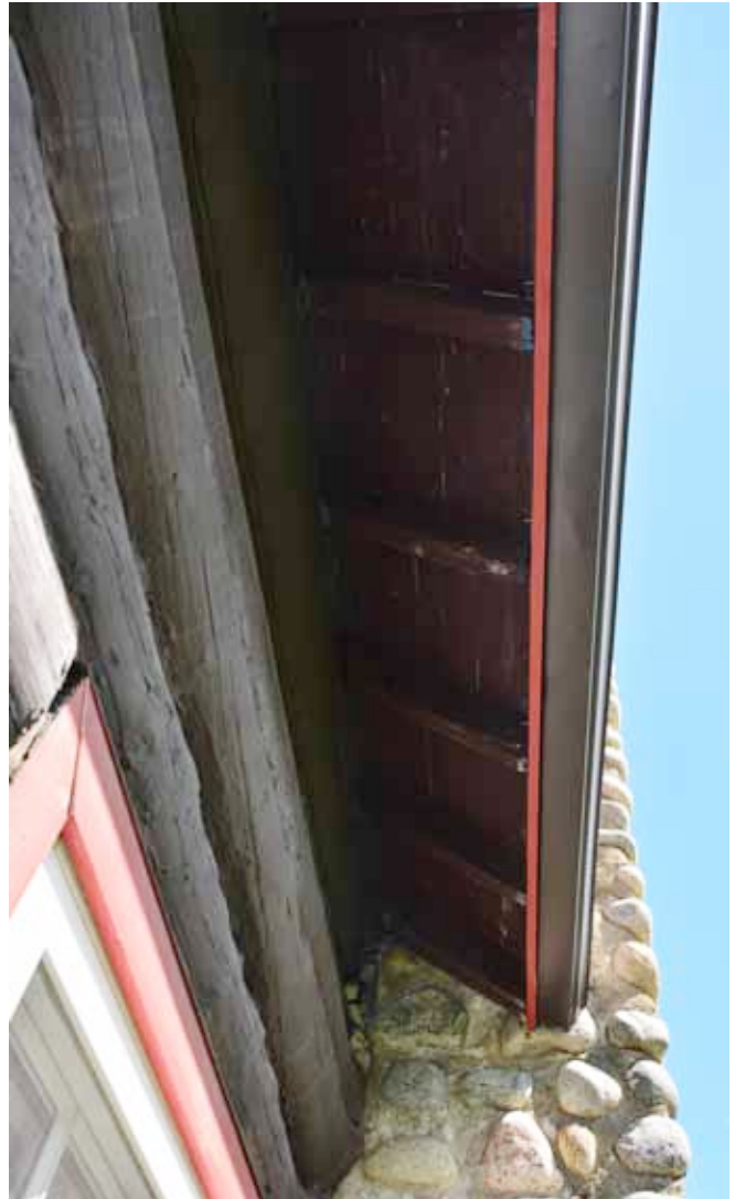
Figure 108 : Sur la moitié avant, qui n'a pas encore été isolée, les soffites d'origine en planches de bois ont été préservés.
