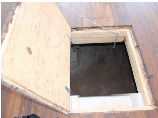
Figure 64 : Une trappe a été ajoutée au plancher en 2004-2005 afin de donner accès au vide sanitaire.
