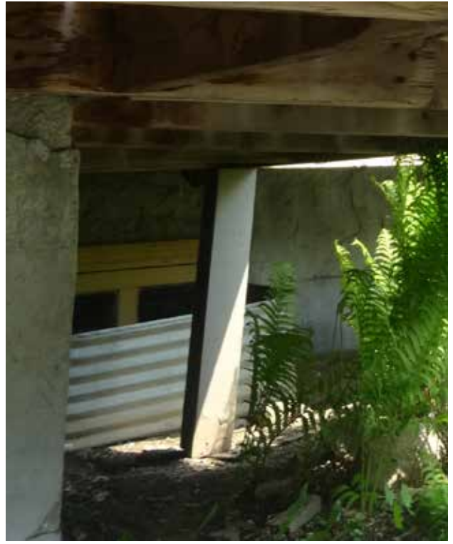
Fig. 29 : Les colonnes de bois des galeries reposent sur des piliers de béton encastrés dans le sol.
