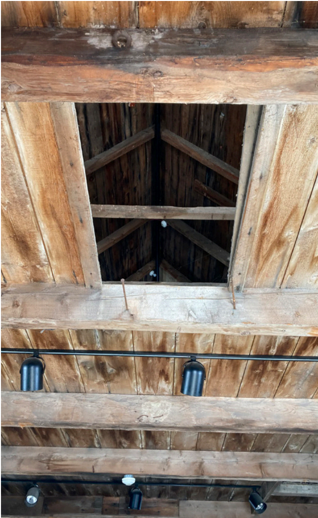
Figure 46 : Des trappes de chargement percent le plancher de l'entresol.
