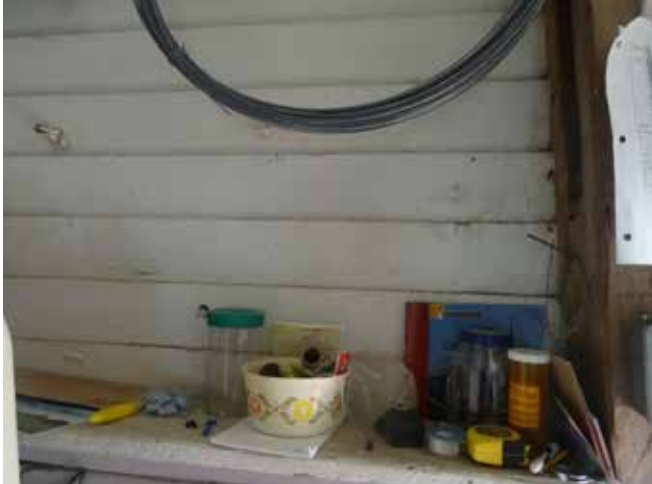
Fig. 21 : Le parement, peint en blanc, est visible depuis l'intérieur et contrevente l'ensemble de la structure.
