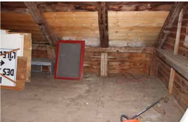
Fig. 70 : À l'été 2018, l'entretroit du hangar a été vidé.
