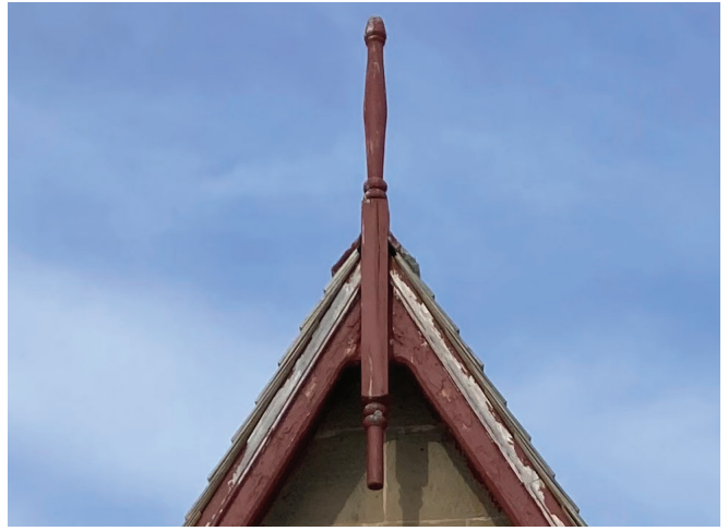
Figure 34 : Deux épis de faitage ornent le bâtiment. D'une hauteur d'environ 1,26 m, ils sont en bois peint en rouge.
