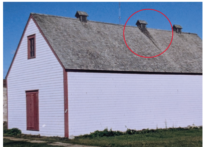
Figure 11 : Cheminée centrale remplacée. Collection du SHNP. Fin 1990.
