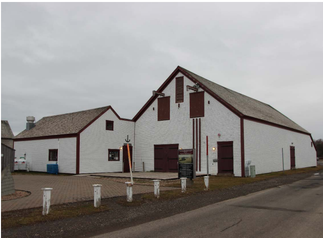
Figure 20 : Le volume principal du hangar à bois et de la cookroom annexée sont surmontés d'un toit à deux versants droits recouvert de bardeaux de cèdre non peint.
