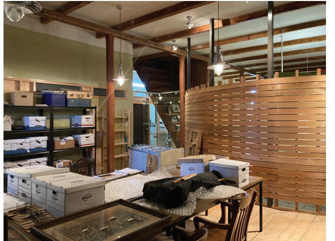
Figure 68 : À l'étage, des écrans composés de lattes de bois soutenues par une structure métallique permettent de séparer les différentes zones de travail.
