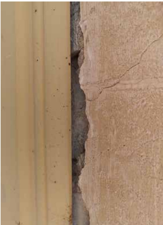
Fig. 48 : À quelques endroits l'enduit est fissuré et se détache de son substrat.
