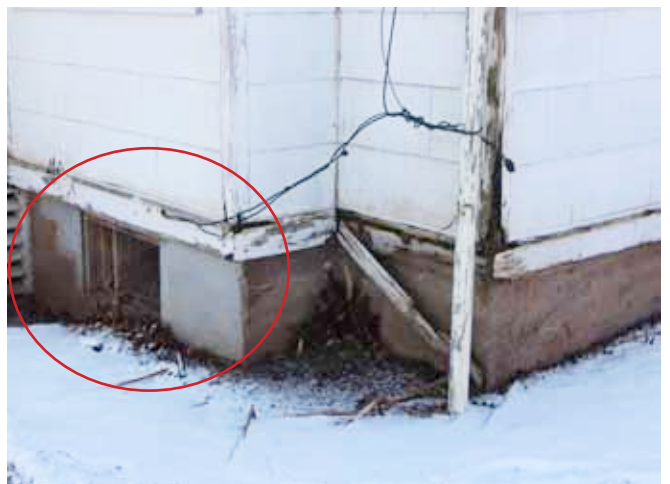
Figure 10 : La face extérieure de certaines sections des fondations a été recouverte d'un enduit. La trace d'un ancien escalier menant à la galerie contiguë à cette façade est toujours visible.
