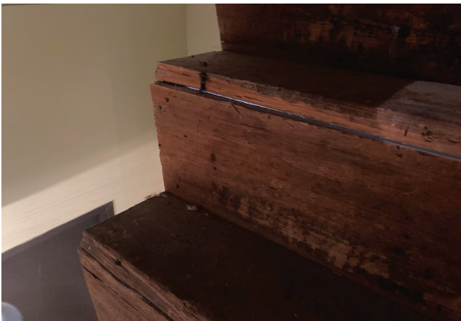
Figure 78 : Les marches, contre-marches et les limons sont en bois.
