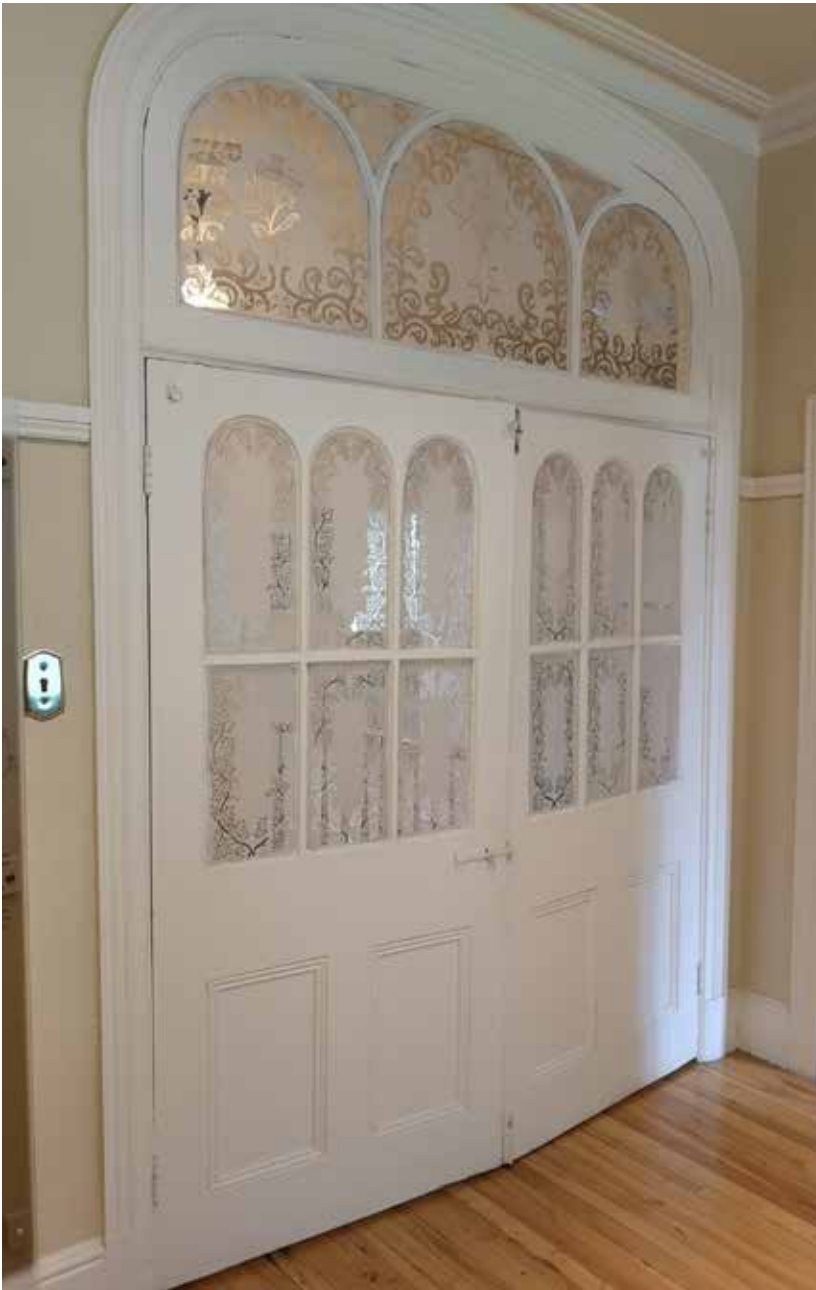
Fig. 81 : Au deuxième étage, une porte de bois, à doubles vantaux vitrés et à caissons, peinte en blanc avec imposte vitrée, donne accès à l'ancien salon de l'évêque.
