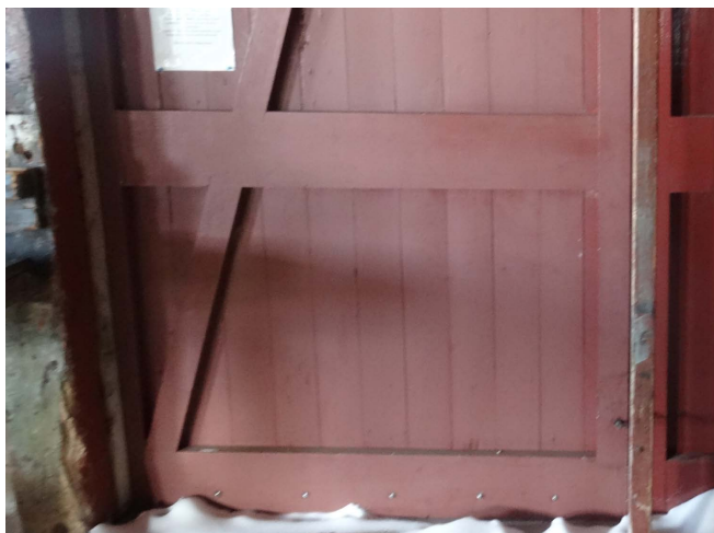
Figure 70 : Les portes sont composées d'un assemblage de planches verticales.
