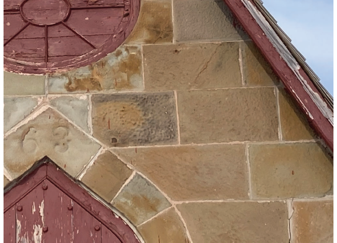
Figure 16 : En façade avant sud, le mur extérieur est en maçonnerie structurale composée de pierre de taille de grès vert, fini piqué.
