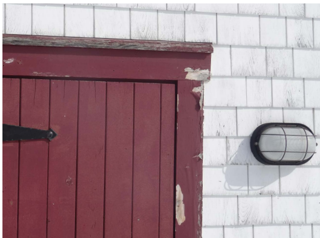
Figure 132 : Des luminaires en applique de style marin sont installés près des portes extérieures.
