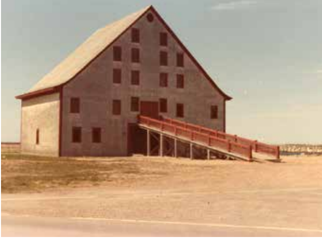
Figure 22 : L'entrepôt restauré en 1981. Collection du SHNP.
