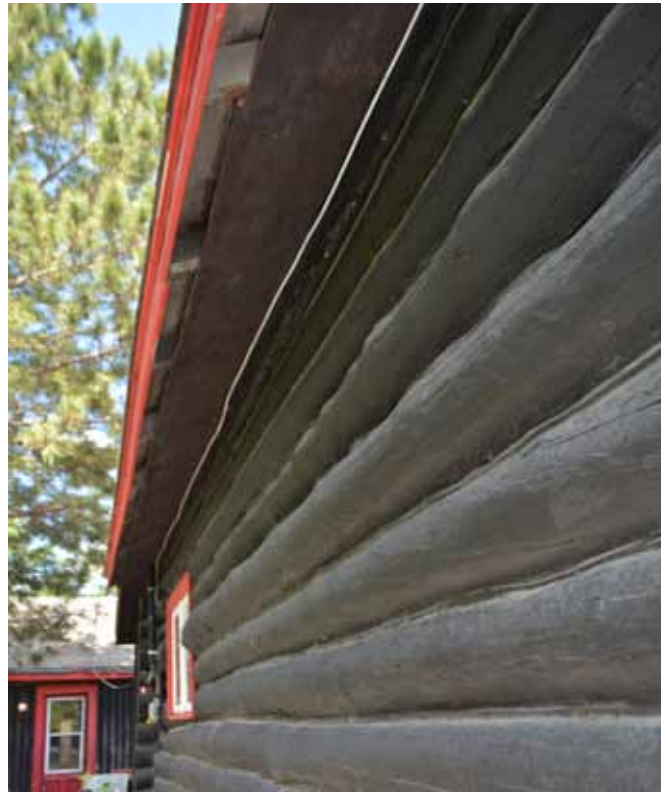
Figure 128 : Sur certains larmiers, le contreplaqué ne se poursuit pas jusqu'à l'extrémité des chevrons, permettant à l'air de passer.
