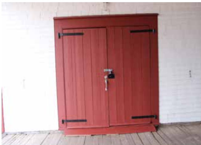
Figure 92 : Le long du corridor central, deux portes doubles et une porte simple donnent accès à la partie est du bâtiment et deux portes doubles à la partie ouest.
