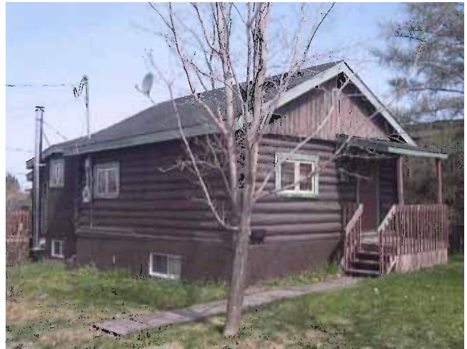
Figure 21 : Maison de type C. 61, rue Lemieux, en 2005. Photographie transmise par la ville de Val-d'Or.
