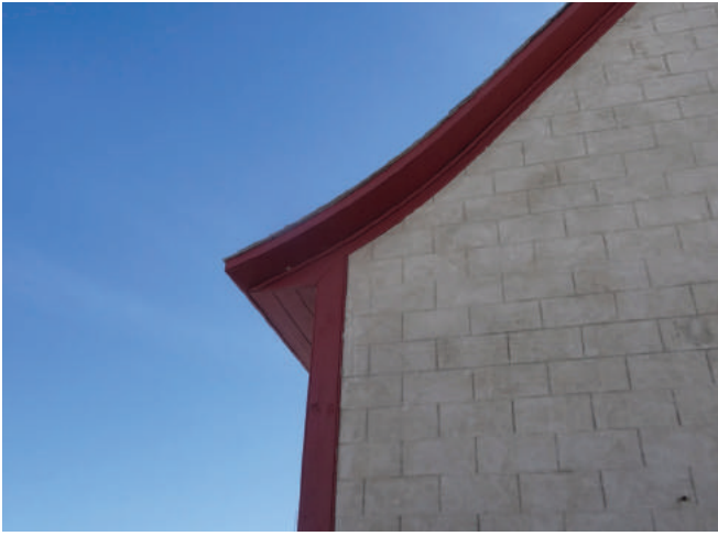
Figure 28 : Les larmiers sont formés de soffites, le revêtement qui recouvre le dessous du larmier, et de fascias, la bande verticale sous le bord de toit, en bois peint en rouge.
