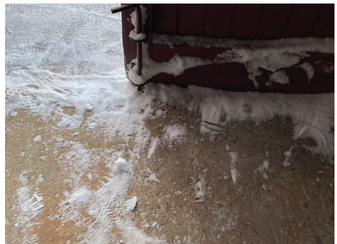
Figure 13 : Le plancher du hangar est constitué d'une dalle sur sol en béton laissé à nu. La dalle est en bon état et aucune fissure n'a été observée à l'intérieur.
