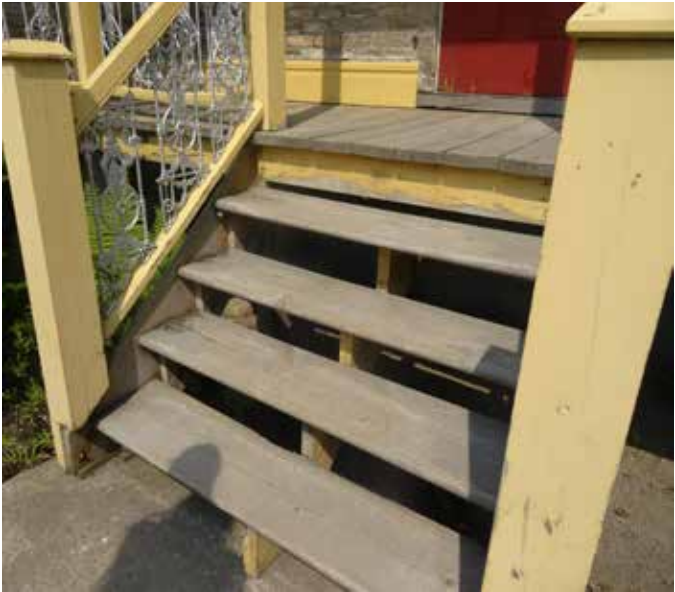
Fig. 34 : L'escalier de la cuisine d'été est déposé sur une dalle de béton.
