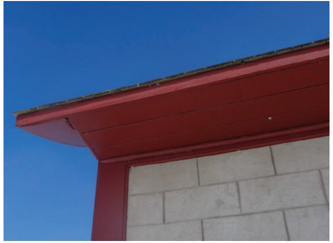
Figure 29 : Ils ont été restaurés en 2004-2005 et sont en bon état.
