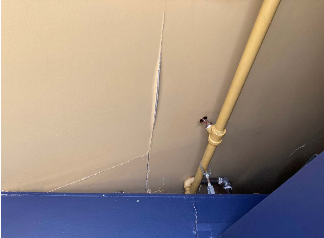
Figure 120 : Le bâtiment est muni d'un système de gicleurs.
