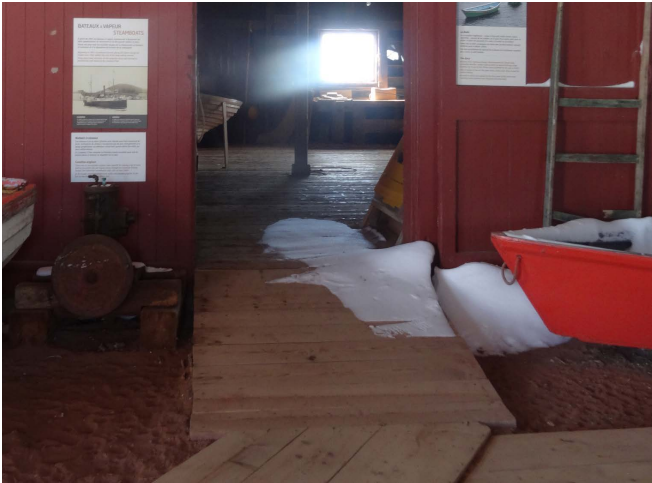
Figure 86 : Une rampe intérieure en bois permet de rejoindre le plancher du volume principal depuis celui en terre battue de l'appentis.
