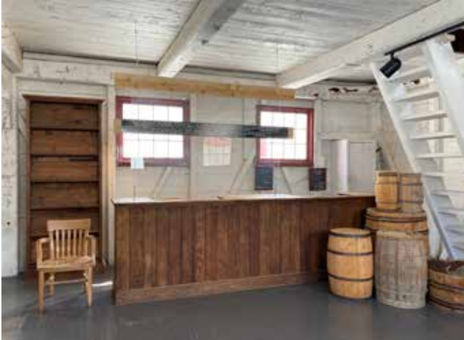
Figure 24 : La structure des murs est visible de l'intérieur du bâtiment. Elle est constituée d'un platelage de bois cloué sur une charpente de bois.
