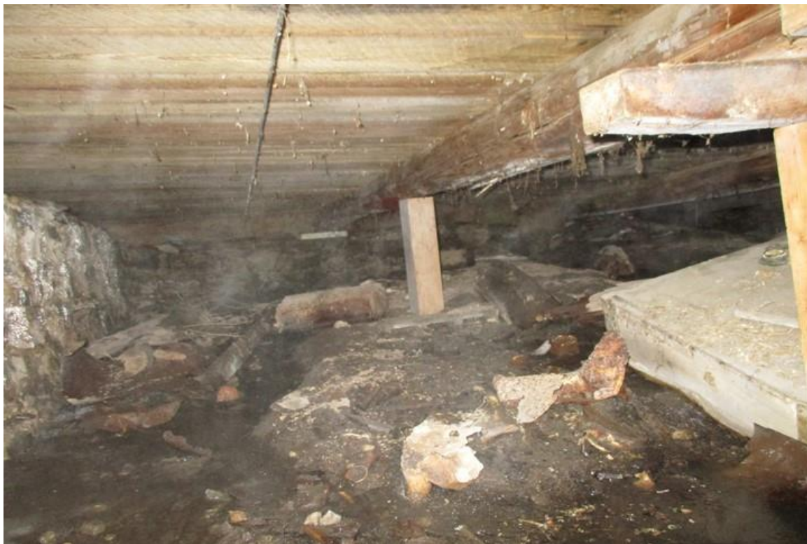
Photo 4: Structure et fondation existante supportant le rez-de-chaussée
