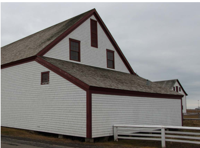
Figure 44 : Aujourd'hui, le mur ouest de l'appentis est complètement aveugle.
