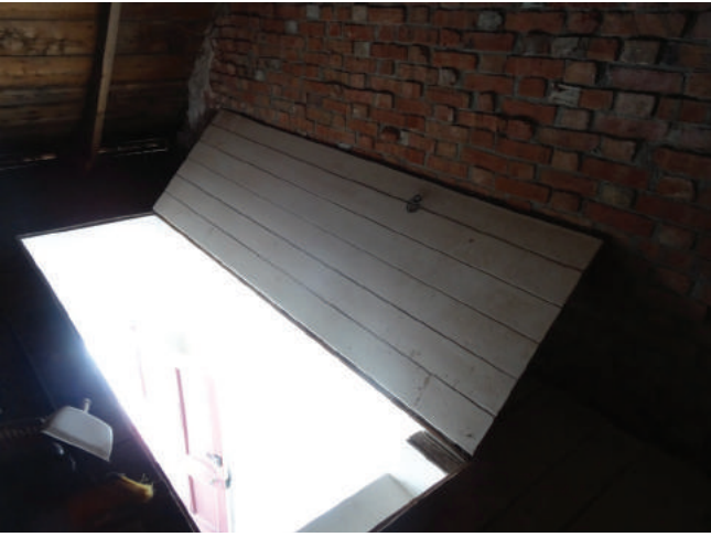
Figure 56 : Une trappe en planches de bois donne accès à l'entresol depuis le rez-de-chaussée.
