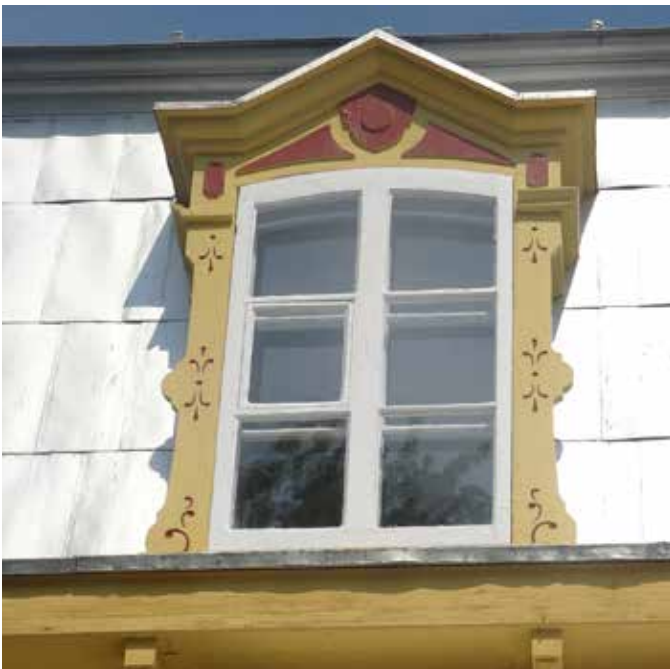
Fig. 71 : Les lucarnes de la toiture sont en bois et comportent des éléments décoratifs.
