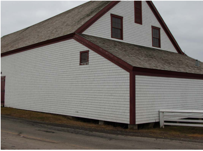
Figure 14 : À l'exception de l'appentis ouest qui est construit sur pilotis, le bâtiment est déposé sur des fondations de béton.
