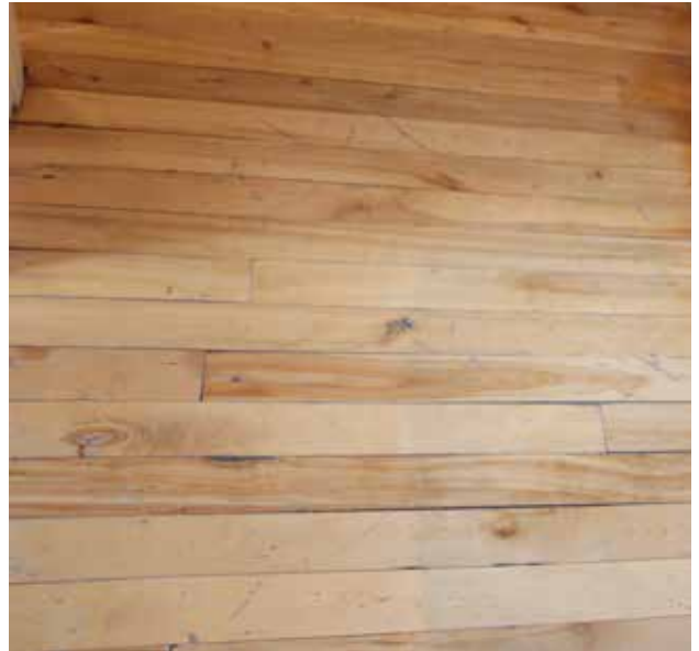
Fig. 103 : À l'étage, le plancher d'origine a été recouvert d'un plancher de bois franc verni.
