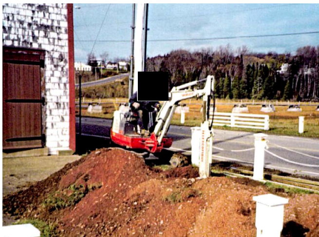
Figure 12 : Excavation sous la supervision d'archéologues pour l'installation de fils d'électricité, de téléphone et d'alarme en 2003. Source : Pierre Giroux.
