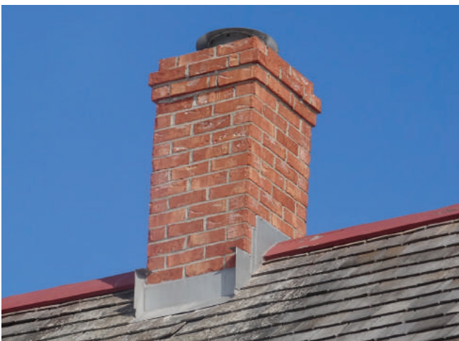
Figure 54 : La cheminée a été construite lors des travaux de 2004-2005. Elle est en brique rouge et située au centre de la toiture.
