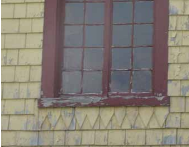
Fig. 15 : Les murs extérieurs nord, est et ouest sont revêtus de bardeaux de cèdre. Sous les tablettes des fenêtres, les bardeaux sont découpés de manière à créer des dentelles de bois.
