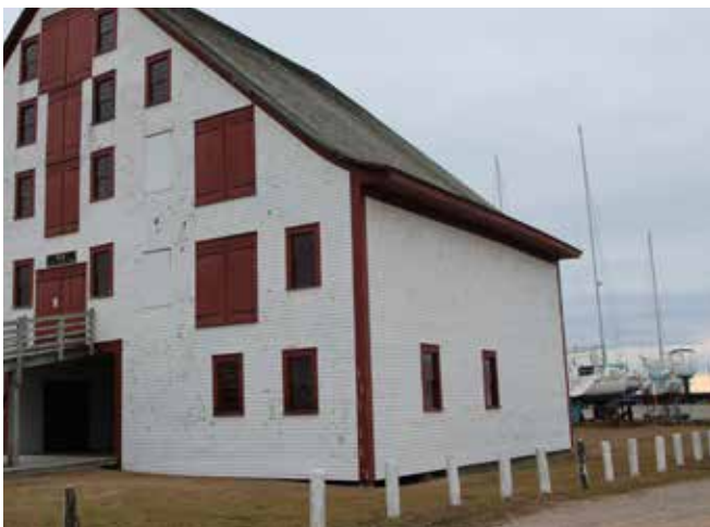
Figure 4 : Façade latérale nord-ouest.
