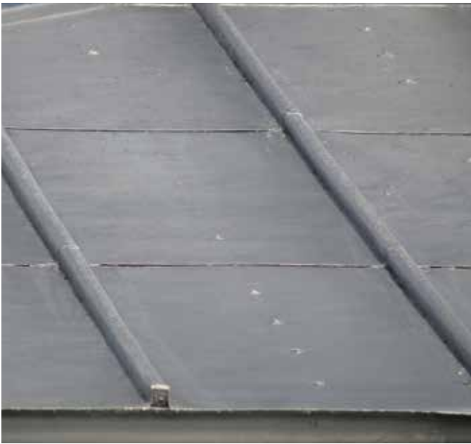
Fig. 69 : La tôle à baguette a été vissée.
