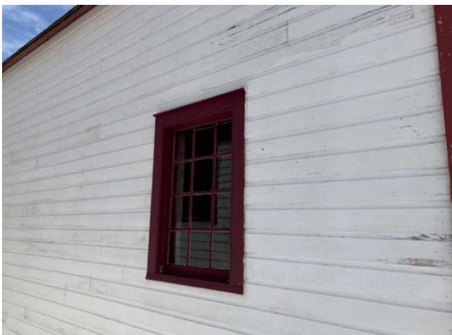
Figure 4 : Façade latérale Nord-ouest.
