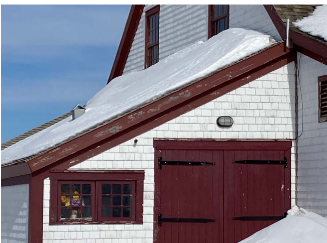
Figure 36 : De façon générale, les larmiers sont en bon état, mais doivent être restaurés et peints puisque la peinture se soulève en plusieurs endroits.
