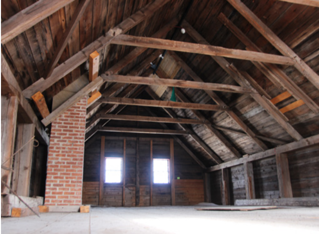
Figure 17 : Les planches du pontage de bois de 25 mm d'épaisseur sont déposées à l'horizontale sur les arbalétriers.
