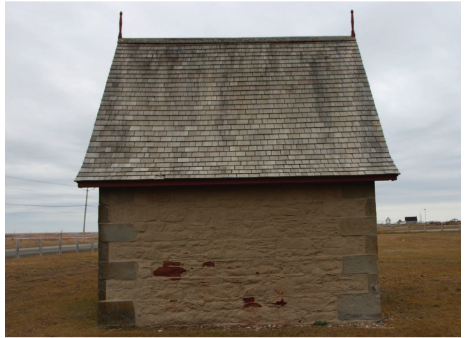
Figure 5 : Façade latérale ouest.
