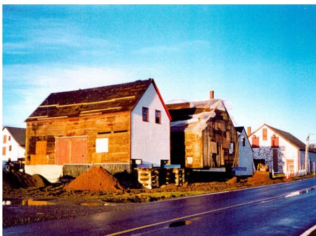
Figure 13 : Lors des travaux de 2003, le bâtiment a été soulevé. Pierre Giroux, expertise archéologique lors des travaux de restauration des cook-rooms.
