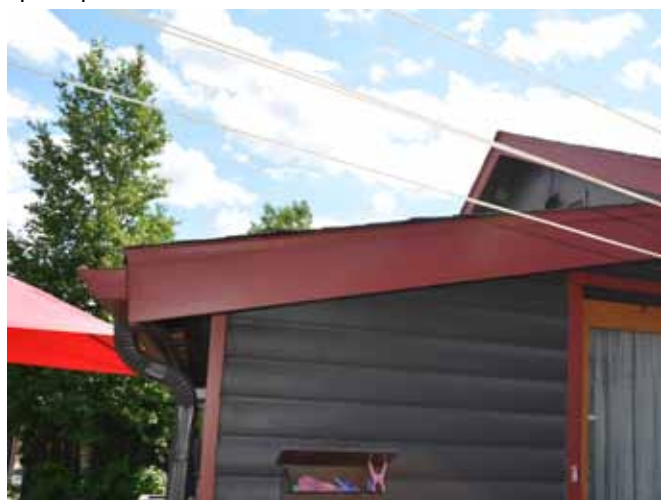
Figure 94 : Comme sur plusieurs maisons, la toiture de l'annexe a été modifiée pour augmenter la hauteur de l'espace habitable à l'intérieur, faisant en sorte que le fascia de la toiture de l'annexe est visiblement plus large.
