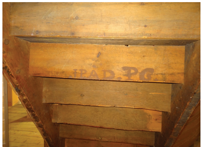
Figure 79 : Des anciennes inscriptions sont visibles à l'endos des marches témoignant que le bois a été récupéré.
