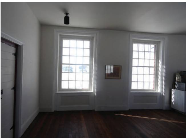
Figure 61 : Des caissons de bois peint sont installés sous les fenêtres.
