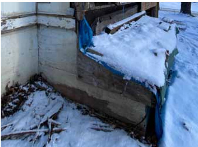
Figure 17 : Le dessus de cette section des fondations est recouvert de planches de contreplaqué recouvertes d'une bâche maintenue en place par des blocs de pierre.
