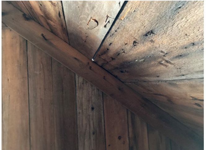
Figure 31 : Les fenêtres de la façade nord ne sont pas étanches et laissent passer la neige.
