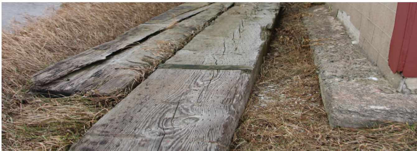
Figure 14 : Sur les façades nord-est et nord-ouest, la semelle de béton des fondations est visible de l'extérieur.
