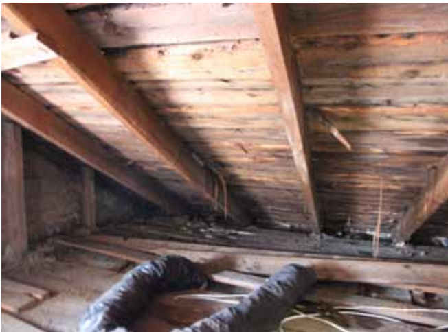
Figure 45 : La structure de toiture est constituée d'un platalage posé sur des chevrons en bois de sciage espacé tous les 2 pi environ.
