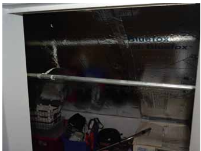
Figure 102 : Ils ont ensuite ajouté, toujours de l'intérieur, une deuxième épaisseur de polystyrène expansé avec un pare-vapeur réfléchissant du côté chaud.
