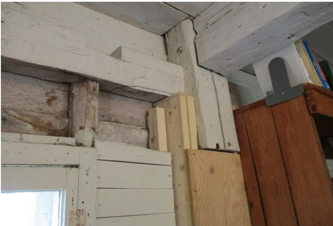
Photo 6: Renfort de bois sur la colonne existante
