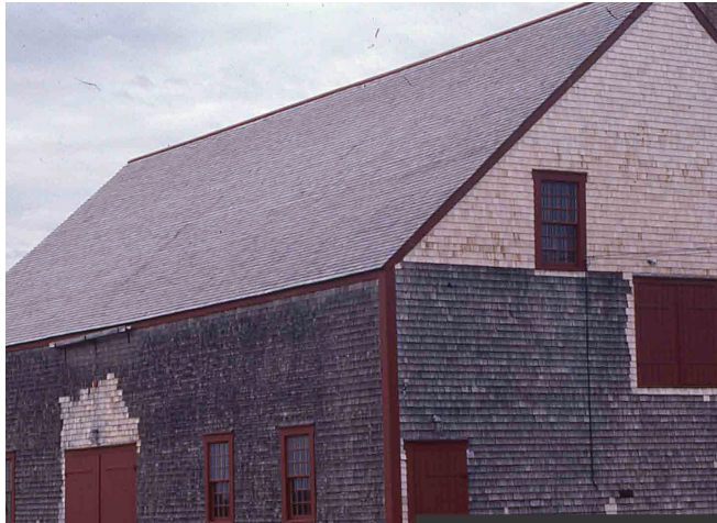
Figure 57 : En 1981, la tôle est retirée et les bardeaux de cèdre sont restaurés.
