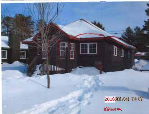
Figure 46 : Formation de petites digues de glace sur les versants avant ouest et latéral sud du 58, rue Marineau en janvier 2018. Photographie transmise par la ville de Val-d'Or.
