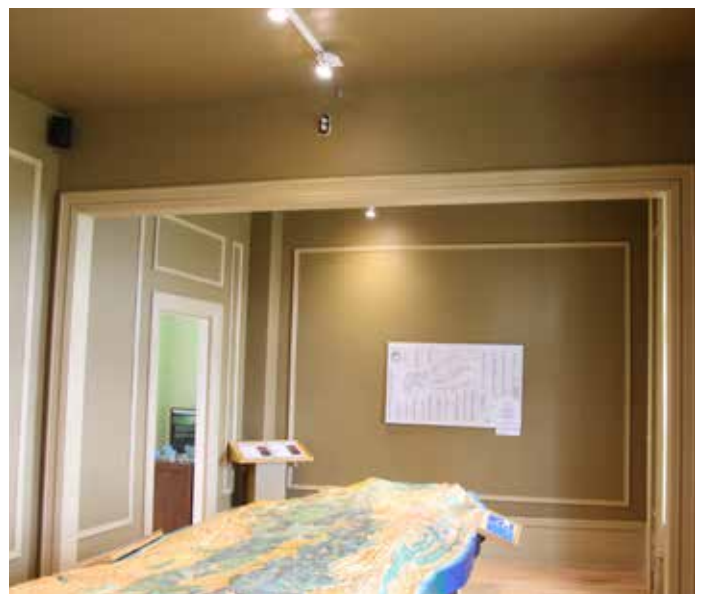
Fig. 78 : Toutes les cloisons intérieures sont en plâtre et en très bon état.
