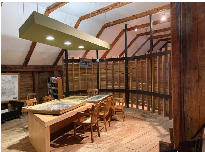
Figure 69 : À l'étage, des écrans composés de lattes de bois soutenues par une structure métallique permettent de séparer les différentes zones de travail.
