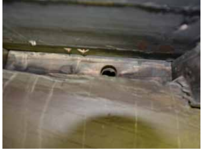
Figure 67 : L'espace entre les chevrons, qui sont à environ 16'' d'entraxe, est ventilé par des trous dans la planche qui ferme cet espace vis-à-vis le sommet des murs extérieurs.
