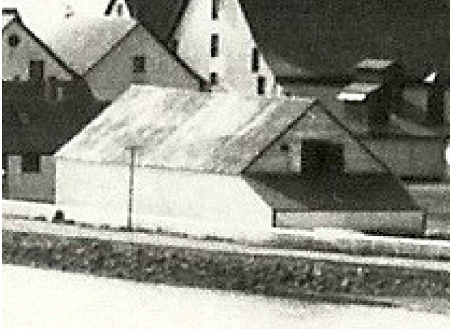
Figure 58 : Les ouvertures de la façade nord ne figurent plus sur les photographies historiques de 1927. Collection du SHNP.
