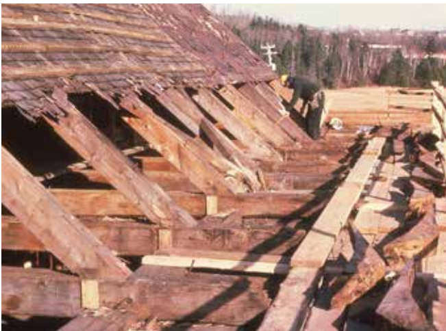
Figure 54 : Certaines planches du platelage ont été remplacées lors des travaux de restauration, mais plusieurs pièces de la charpente sont d'origine. Source: Collection du SHNP. 1981.
