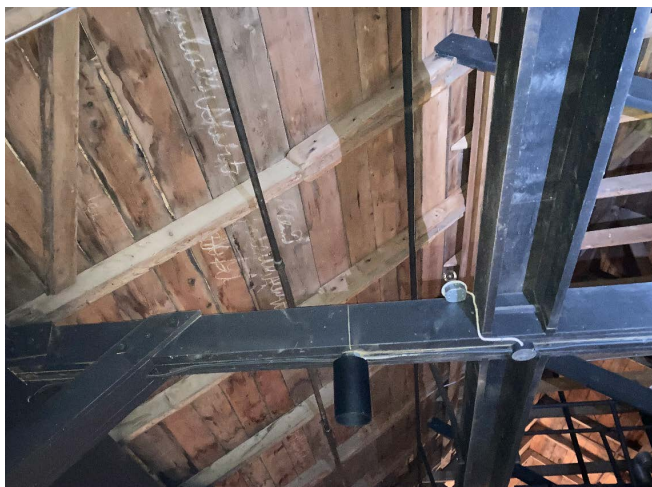
Figure 23 : Les éléments de bois ajoutés sont peints en noir: entrails, poinçons, contre-fiches. Des graffitis sont présents sur le platelage de la toiture.
