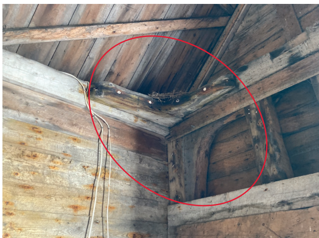
Figure 17 : Des consoles sont présentes à la base de la charpente, dans les coins du bâtiment. La console posée à l'horizontale est un type plus rare.
