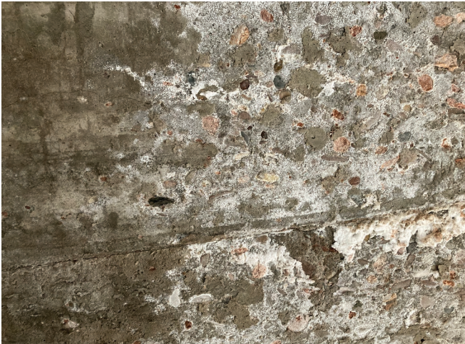
Figure 31 : Des agrégats provenant probablement des environs sont aussi apparents.
