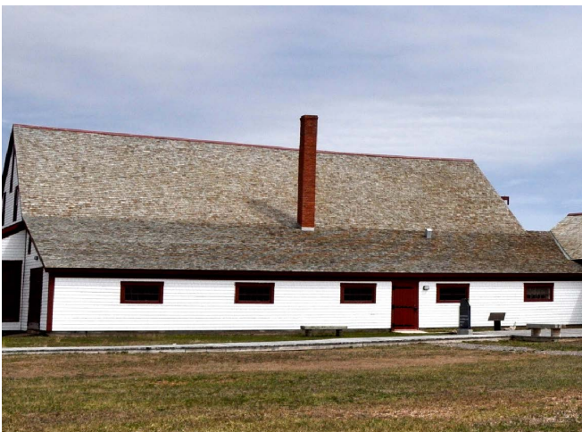
Figure 74 : Le revêtement de toiture a été remplacé en 2005 et les bardeaux laissés à nu ont été fixés avec des clous en acier inoxydable.
