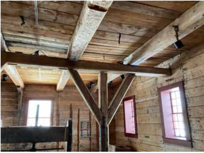
Figure 30 : Les planchers sont composés d'un platelage de bois déposés sur un système de poutres et poutrelles. Des colonnes de bois soutiennent les poutres principales.
