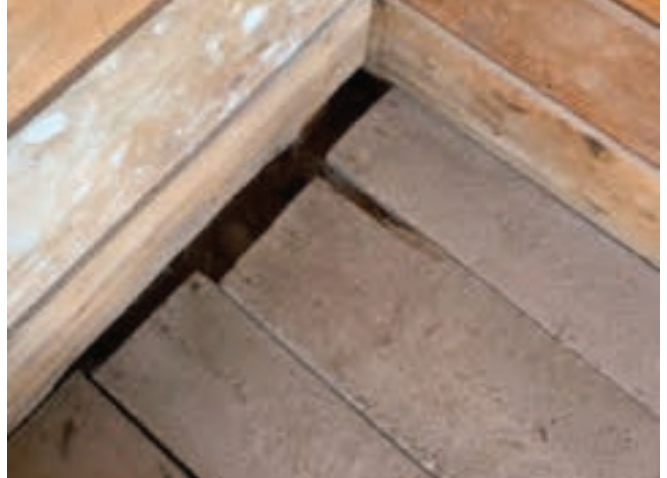
Figure 38 : Le plancher est composé d'un platelage de bois en bon état. Photo transmise par le client.
