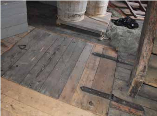
Figure 119 : Des trappes localisées dans les planchers de bois permettaient de faciliter le chargement intérieur.
