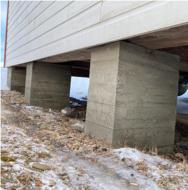
Figure 14 : La tonnellerie est installée sur des fondations en blocs de béton réalisées en 2003.
