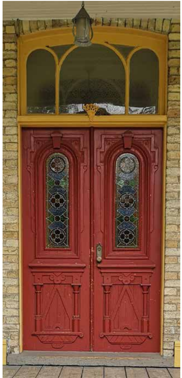
Fig. 59: La porte principale de l'ancien presbytère est une porte double, en bois, peinte en rouge, avec vitraux, caissons et imposte vitrée peinte en jaune.
