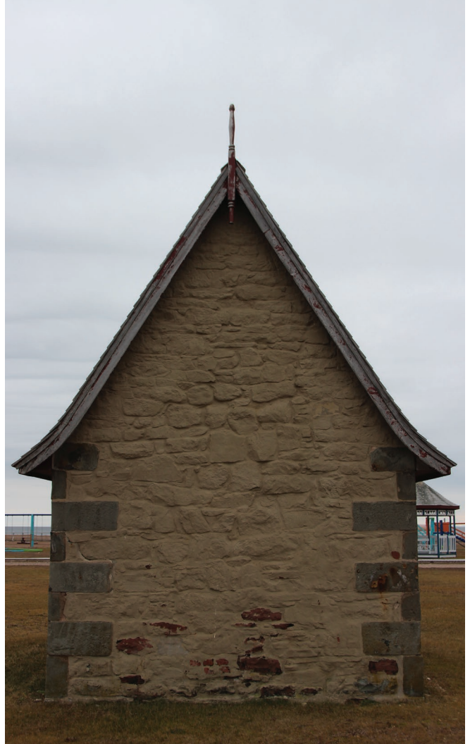
Figure 3 : Façade arrière nord.
