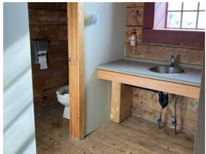
Figure 109 : Dans les salles de toilette, les cloisons sont en gypse.
