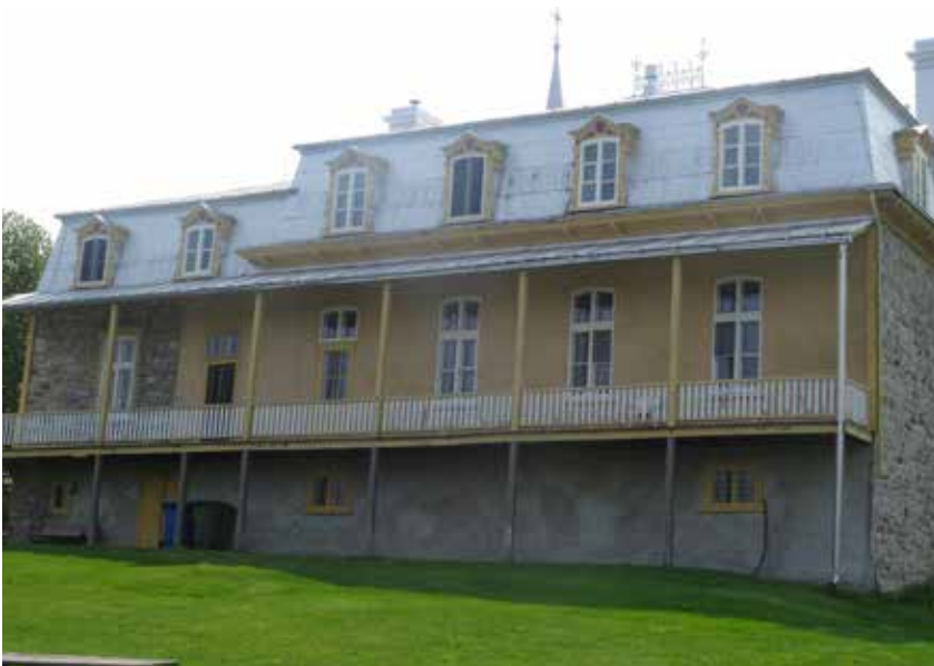
Fig. 44: Les murs latéraux et les murs arrières sont en pierres de grès.
