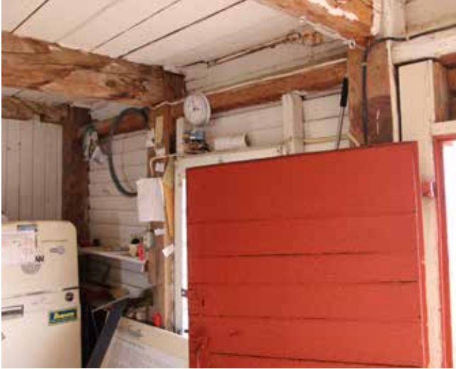
Fig. 54 : Des planches de bois horizontales, posées du côté extérieur, assurent le contreventement de l'ensemble. Voir 2.2.1.2. Sur la façade principale, le revêtement de planches à clin est posé directement sur les colonnes de bois et agit comme contreventement.
