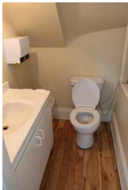
Fig. 85 : L'une des salles de toilette est située au rez-de-chaussée et est accessible à la clientèle.
