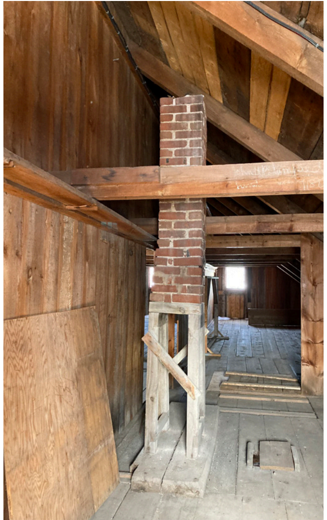
Figure 54 : Une seconde souche de cheminée de briques est installée dans une des pièces de l'étage.
