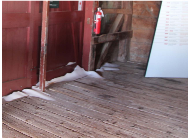
Figure 87 : Les planchers du rez-de-chaussée et de l'étage sont en planches de bois nu. Les planchers sont probablement d'origine. Ils sont en bon état.
