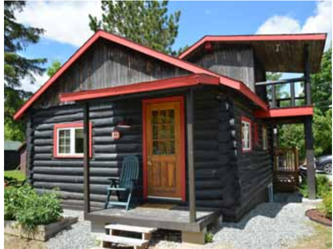
Figure 122 : Il s'agit d'une maison de type C qui a été agrandie par l'ajout d'une grande lucarne avec un balcon couvert.
