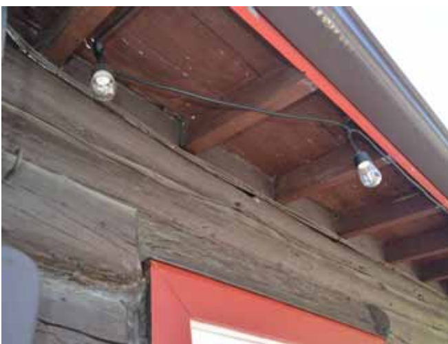
Figure 109 : Sur la moitié avant, qui n'a pas encore été isolée, les soffites d'origine en planches de bois ont été préservés.
