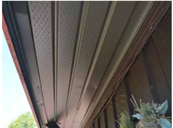
Figure 69 : Du côté sud, les soffites sont recouverts d'aluminium perforé.
