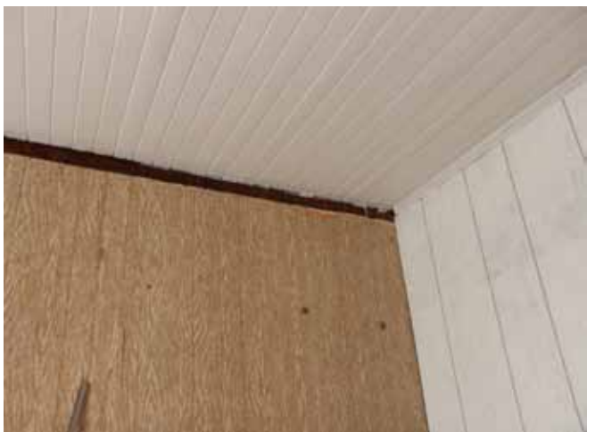
Figure 107 : Les murs des chambres à l'étage sont recouverts de papier peint. Dans une des pièces, le papier peint imitant une finition en bois.
