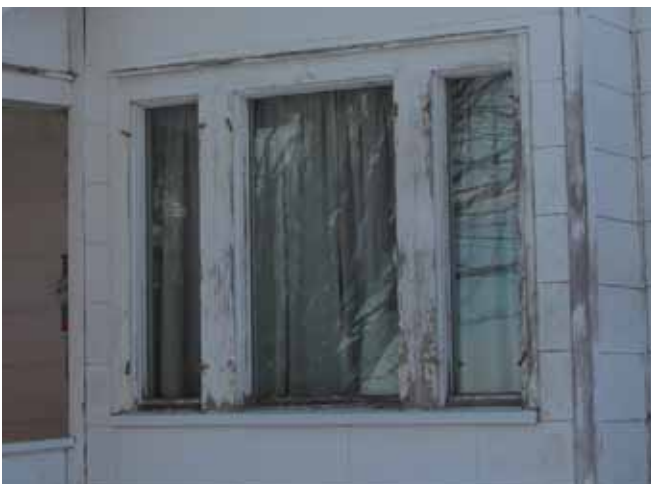
Figure 78 : Au rez-de-chaussée de la façade latérale est se trouve une fenêtre à trois châssis fixes séparés par deux montants.
