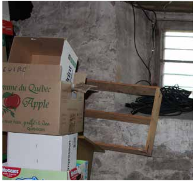
Fig. 8 : Les fondations sont recouvertes partiellement d'enduit, autant à l'intérieur qu'à l'extérieur.
