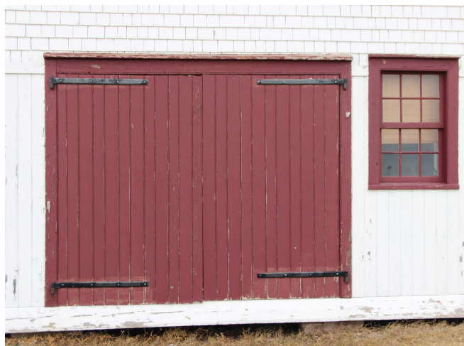
Figure 63 : Le volume principal est percé de deux portes à doubles vantaux en bois: une seconde sur la façade sud.
