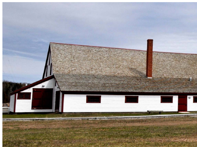
Figure 13 : Après les travaux de restauration de 2006. Collection du SHNP.
