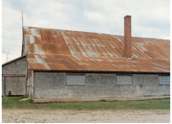
Figure 71 : Les photographies anciennes témoignent qu'avant 1988, au moment de la restauration du bâtiment, la toiture était recouverte de tôles métalliques. Collection du SHNP.
