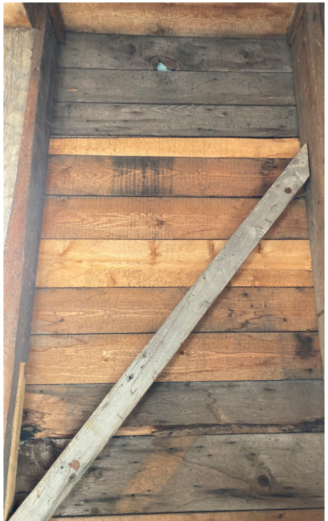
Figure 24 : Certains éléments structuraux ont été remplacés lors des travaux de restauration de 2003.
