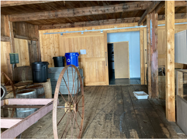
Figure 58 : Des portes intérieures en bois séparent l'espace d'interprétation des espaces privés. Elles sont installées sur un système de rail.
