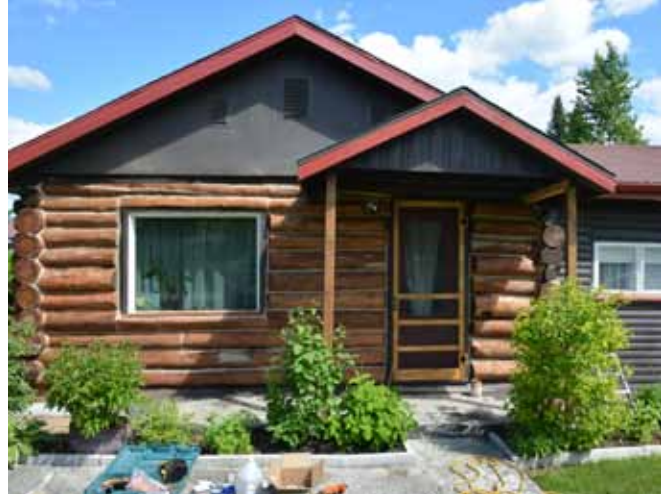
Figure 92 : Il s'agit d'une maison de type C.
