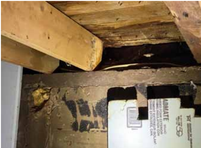
Figure 23 : Les solives sont fixées sur la solive de rive posée sur le sommet des murs de fondation en béton
