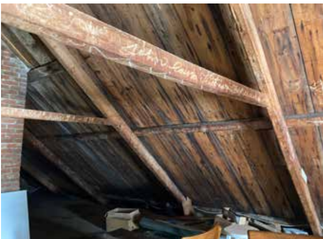
Figure 18 : La charpente de la toiture à deux versants est en bois. La structure, visible de l'intérieur, se compose d'arbalétriers reliés par un entrait.
