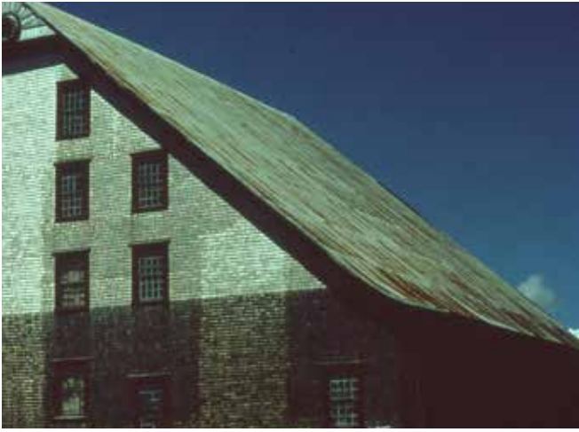
Figure 102 : Dans les années 1970, la toiture est recouverte de tôles métalliques. Source: Collection du SHNP. 1980.
