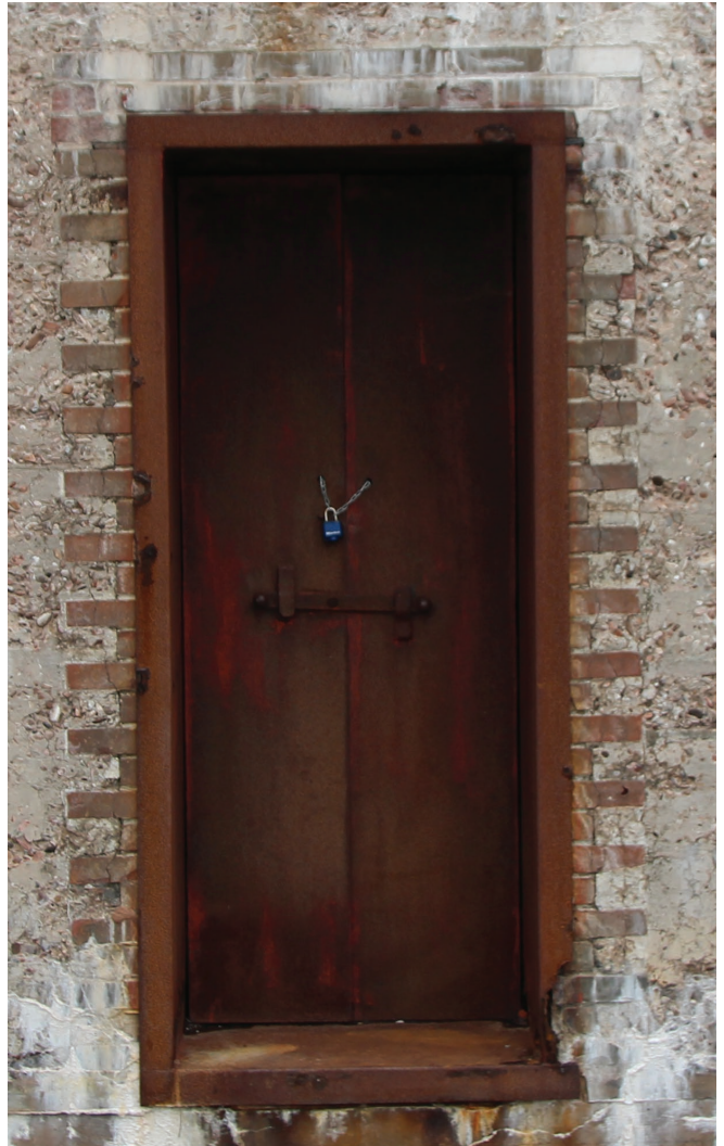
Figure 26 : Le bâtiment possède une porte en métal à double vantail en façade principale sud.
