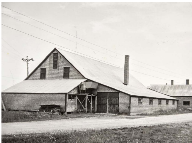
Figure 8 : Cookroom annexé au bâtiment et ajout d'une grande cheminée. Vers 1950. Bibliothèque et archives nationales du Québec.
