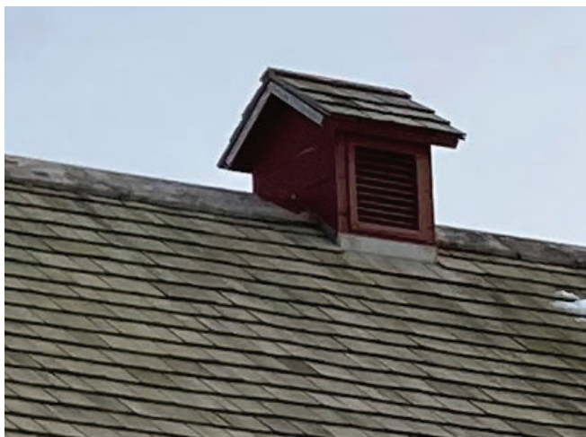
Figure 30 : Aérateur situé sur le faîte du toit en bois peint en rouge. Sa toiture est recouverte de bardeaux de cèdre laissés à nu. La planche faitière en bois est aussi laissée à nu.
