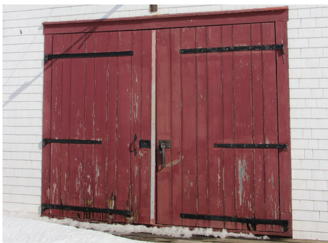
Figure 49 : Les portes principales situées sur la façade sud-ouest sont à doubles vantaux et composées de porte et de contre-portes.
