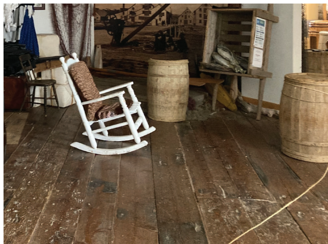
Figure 20 : En général, les planchers sont en bon état.
