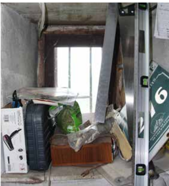
Fig. 50 : L'une des fenêtres du sous-sol ne possède qu'un seul carreau.
