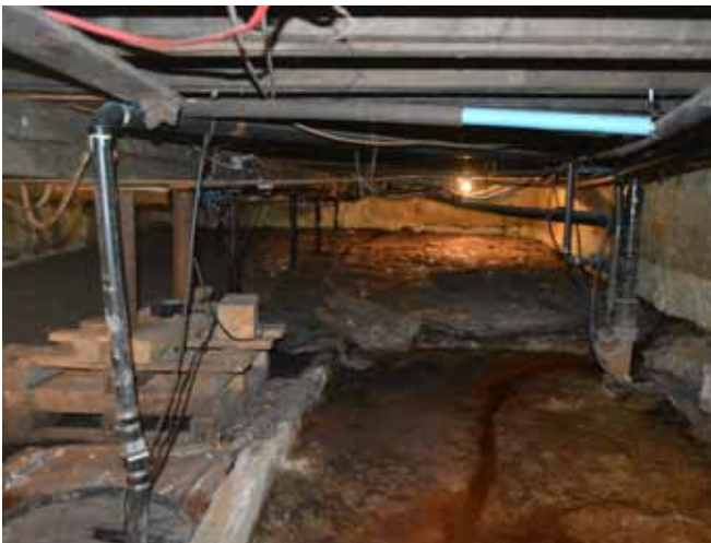
Figure 115 : De l'uréthane a été giclé à l'intérieur du vide sanitaire, recouvrant l'appareillage de maçonnerie ainsi que les extrémités des solives du plancher et la poutre de rive du rez-de-chaussée.
