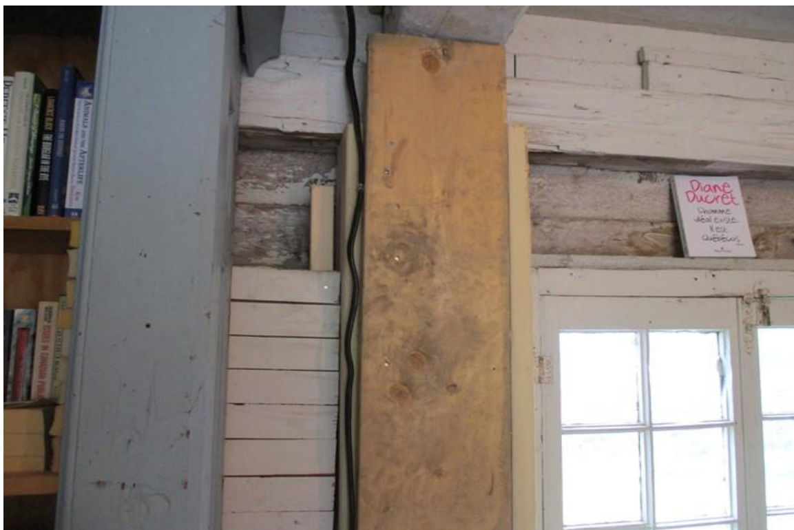
Photo 5: Renfort de bois sur la colonne existante
