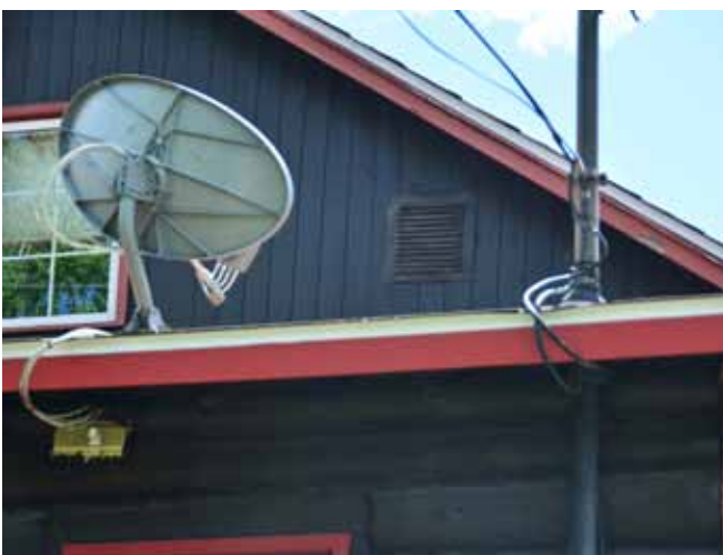
Figure 150 : Des grilles de ventilation ont été aménagées dans les pignons.
