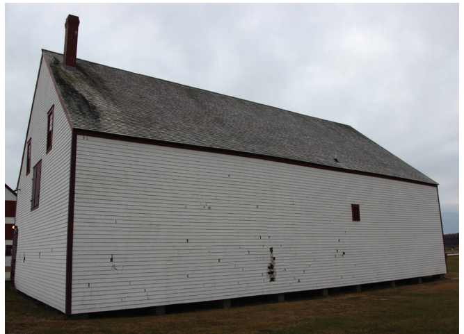
Figure 5 : Façade arrière nord-est.
