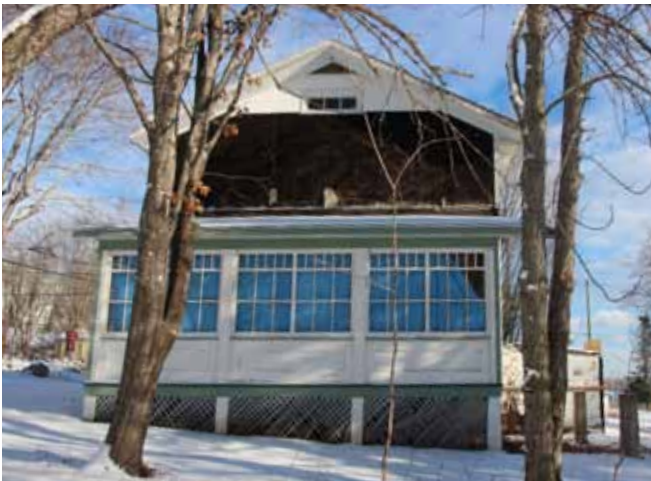
Figure 4 : Façade latérale ouest. Une véranda est contiguë à la façade ouest.
