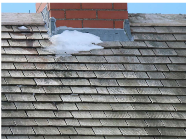
Figure 75 : Le revêtement de bardeaux, généralement en bon état, est aussi recouvert partiellement de mousse.
