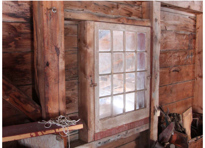
Figure 49 : Le bâtiment est orné de cinq fenêtres situées sur la façade nord du volume principal, visibles depuis l'intérieur de l'appentis.
