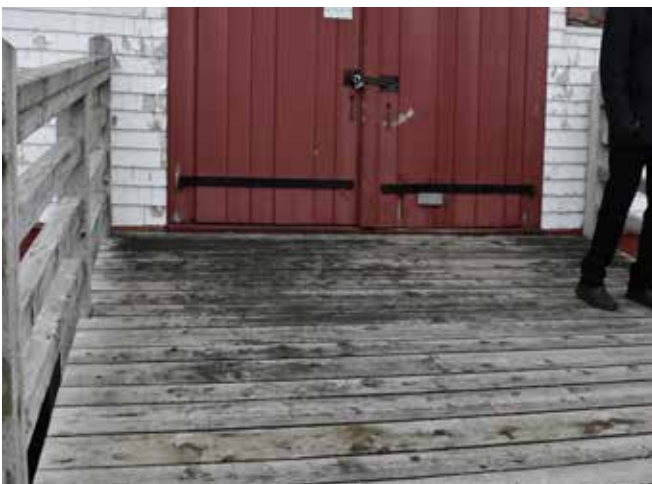
Figure 86 : Les portes sont installées dans les cadre avec un système de grandes pentures en fer forgé retenues sur des gonds.
