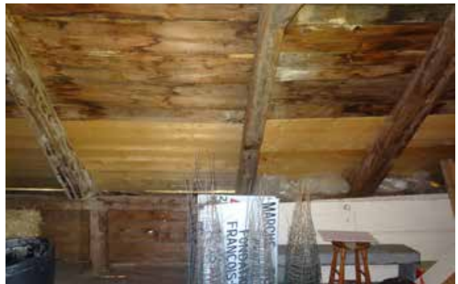
Fig. 51 : Lors de la réfection du versant sud de la toiture, certaines planches du platelage ont été remplacées suite à des infiltrations d'eau dans l'entretoit.
