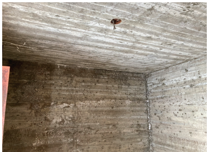
Figure 28 : La finition intérieure du coffre-fort est constituée des murs extérieurs de béton laissé à nu.
