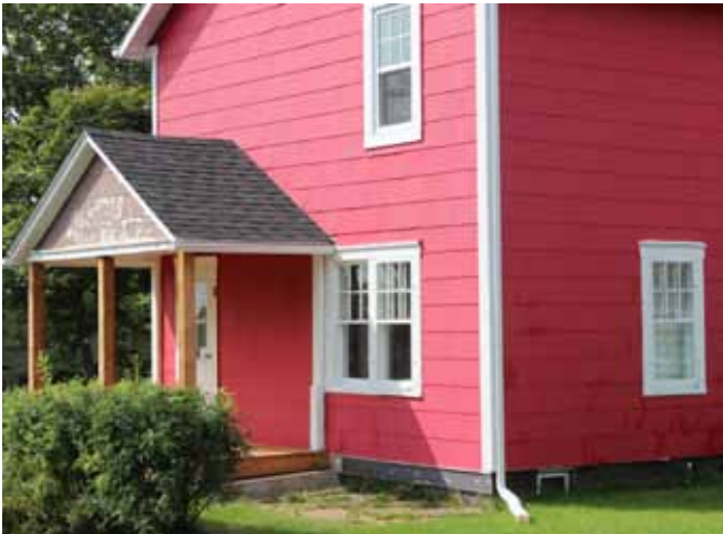
Figure 83 : Elle conserve certaines de ses fenêtres à guillotine en bois d'origine. Le châssis supérieur est divisé en six carreaux, ce qui est courant à cette époque dans l'architecture des communautés anglophones.
