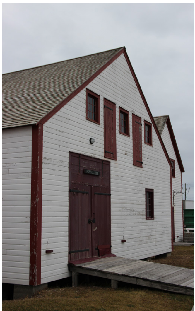
Figure 19 : Rampe en bois nu donne accès au bâtiment.
