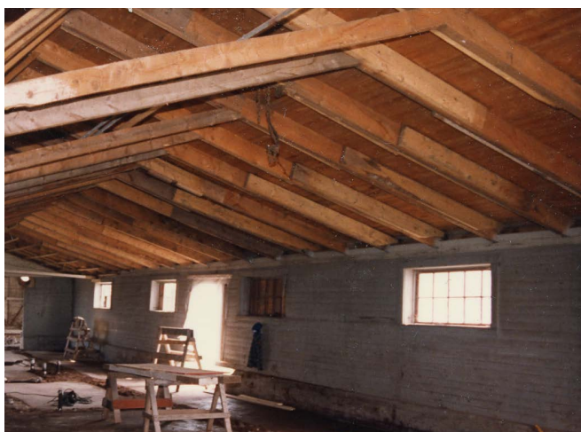
Figure 26 : Charpentes des appentis sud et ouest constituées de platelage de bois déposé sur des chevrons. Travaux de restauration de 1988. Source : Collection du SHNP.
