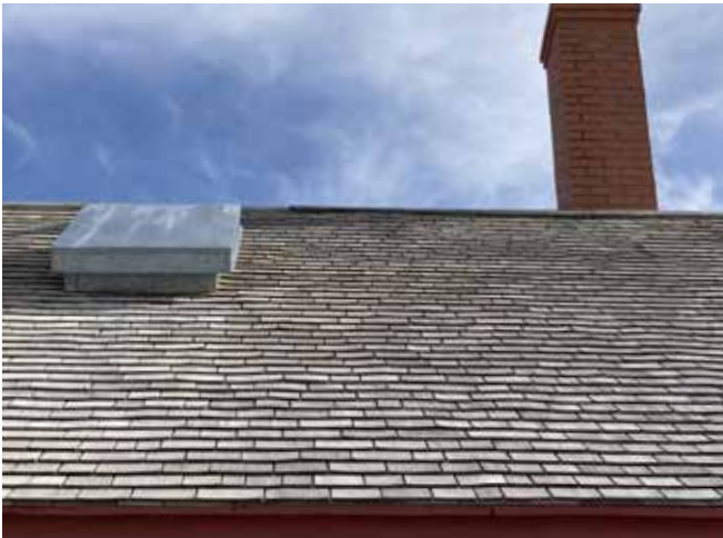
Figure 39 : La toiture est recouverte de bardeaux de cèdre laissés à nu. La planche faîtière de la toiture est aussi en bois laissé à nu.
