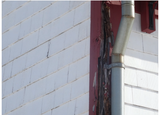
Figure 61 : Les descentes de gouttières sont en acier galvanisé.
