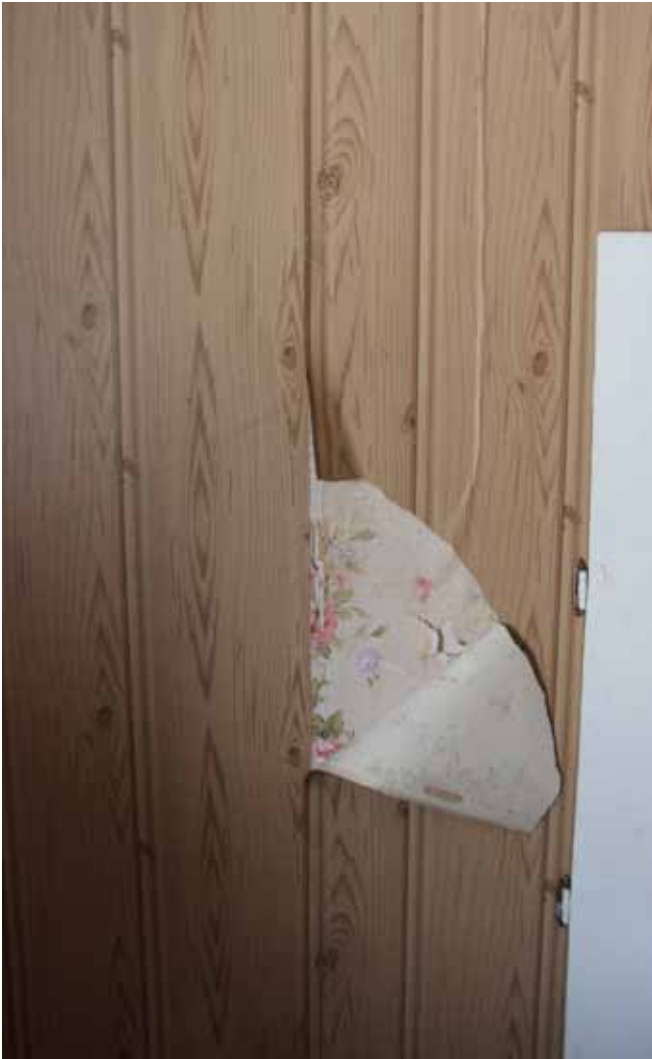
Figure 108 : Dans une des pièces, la dégradation du papier peint imitant le bois permet de voir le papier peint fleuri qui est toujours présent en dessous.
