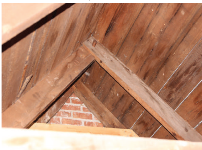
Figure 22 : La charpente est constituée d'arbalétriers en bois reliés en leur sommet par des chevilles de bois.
