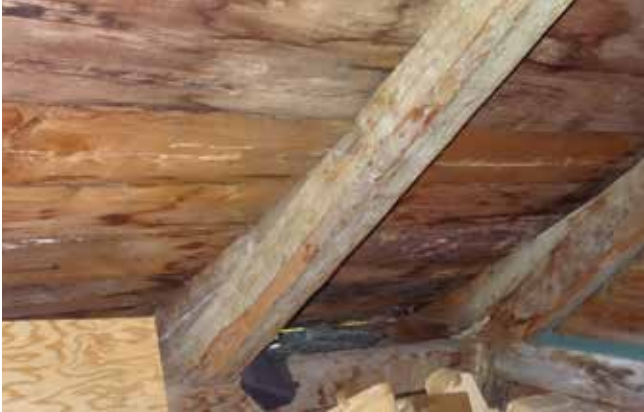
Fig. 48 : Des coyaux sont ajoutés à la base des arbalétriers pour recourber les larmiers.
