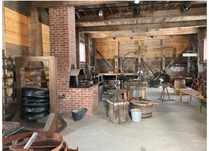
Figure 16 : Une dalle sur sol a été ajoutée au bâtiment lors des travaux de restauration de 2003 selon les plans de Boudreau, Fortier et associés. La dalle est en bon état.
