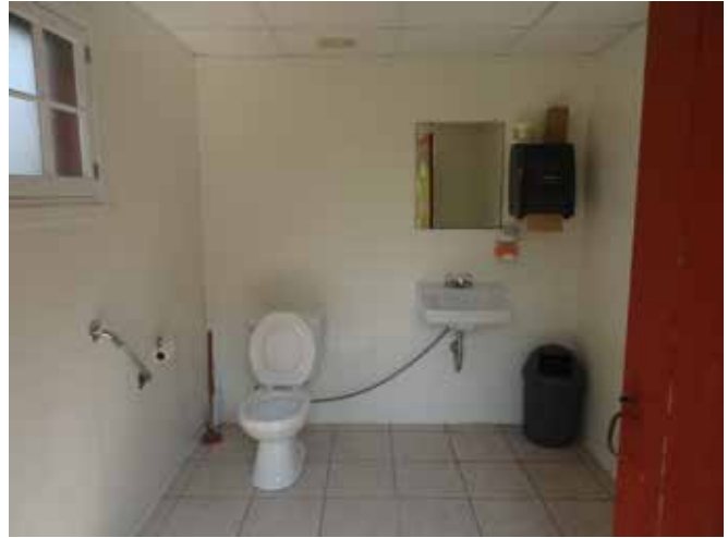
Fig. 67 : Une toilette a été ajoutée au bâtiment dans un appentis ajouté à l'ouest du hangar.
