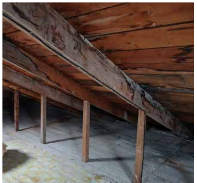
Fig. 39 : La structure de la toiture se compose de solives de bois et d'un platelage en bois.
