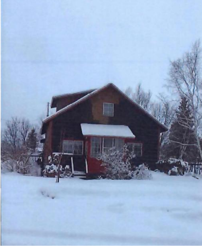
Figure 170 : La façade du 137, avenue Perrault en mars 2022. Photographie transmise par la ville de Val-d'Or.
