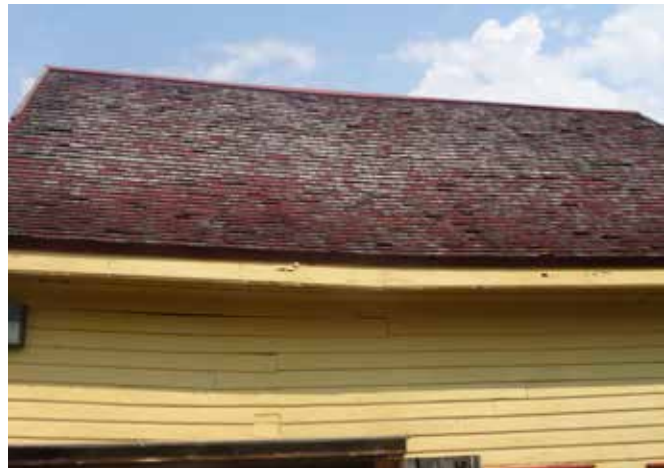
Fig. 57 : Cette opération a engendré des déformations structurales importantes sur la façade: le linteau de la porte s'affaisse entraînant avec lui le mur et le larmier.
