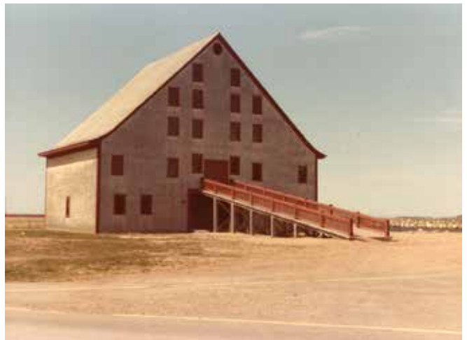
Figure 41 : La rampe a été reconstruite en 1981. Source: Collection du SHNP.
