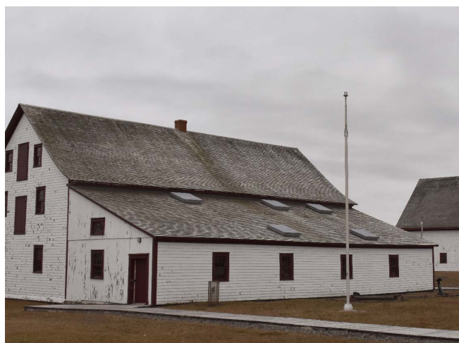
Figure 3 : Façade latérale nord.
