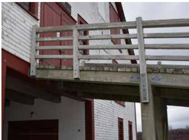
Figure 45 : Les garde-corps de la rampe de chargements sont en bois traité laissé à nu.
