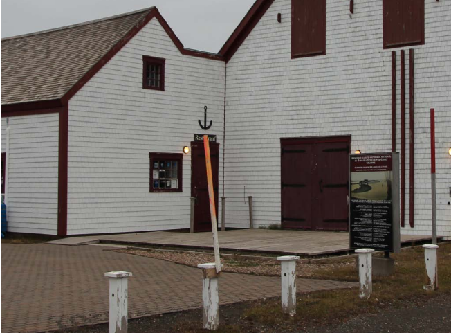
Figure 18 : Une terrasse de bois est aménagée à l'est du bâtiment, à la jonction entre le volume principal et la cookroom.
