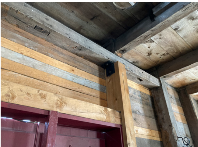
Figure 25 : Certains éléments structuraux ont été remplacés lors des travaux de restauration de 2003.
