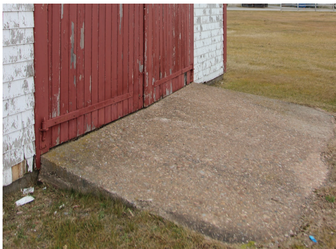
Figure 14 : Une rampe d'accès incliné en béton est située en façade nord.
