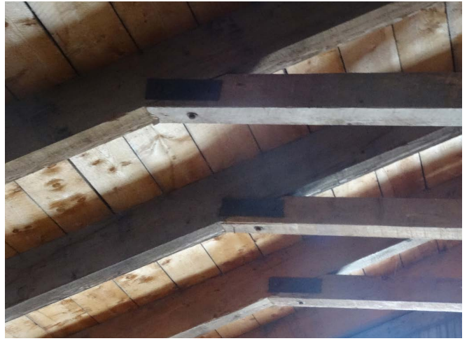
Figure 31 : Des pièces métalliques fixent les entrails aux chevrons.
