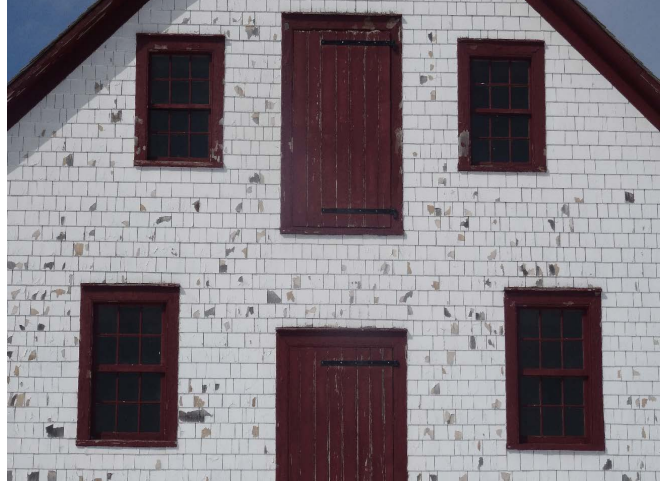
Figure 51 : Le volume principal est percé, sur ses deux façades pignon, de 11 fenêtres fixes à 12 carreaux disposées de façon symétrique de part et d'autre des portes de chargement.
