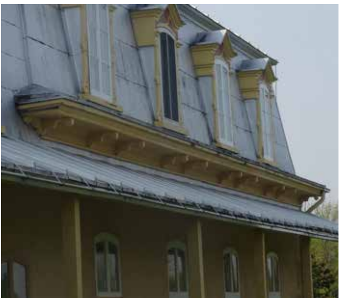
Fig. 38 : Les larmiers de la toiture sont retenus par des consoles de bois peints en jaune.
