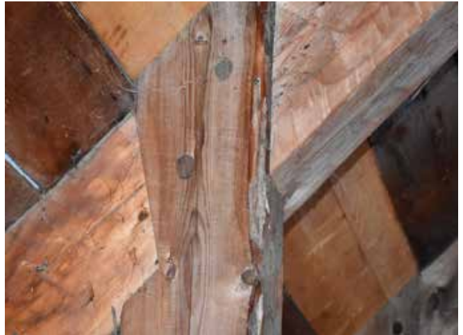
Figure 53 : Les pièces de bois sont assemblées avec des chevilles de bois.
