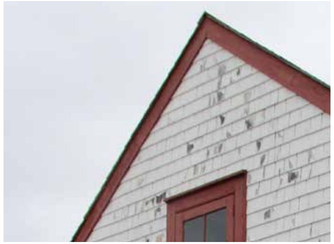
Figure 29 : Les larmiers en bois sont étroits, car le bâtiment n'est pas muni d'avant-toit. Ils sont en bois peint en rouge et en bon état.
