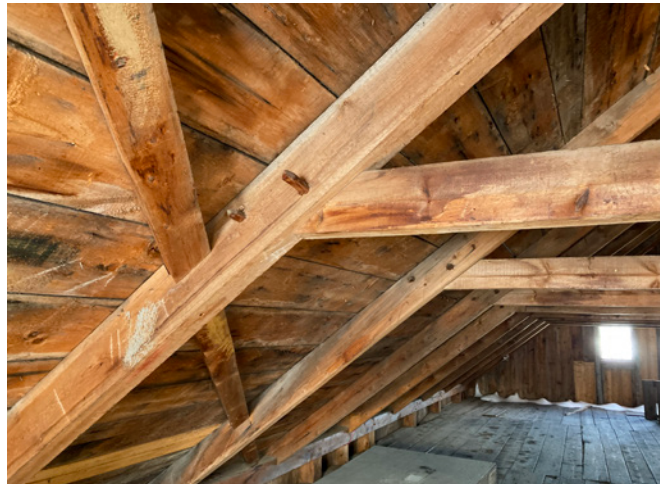
Figure 23 : La charpente est assemblée avec des chevilles de bois.
