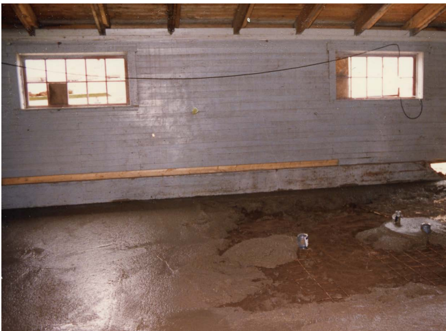
Figure 32 : L'appentis sud était recouvert du côté intérieur d'un platelage de bois peint gris-bleu. Travaux de restauration de 1988. Source : Collection du SHNP.
