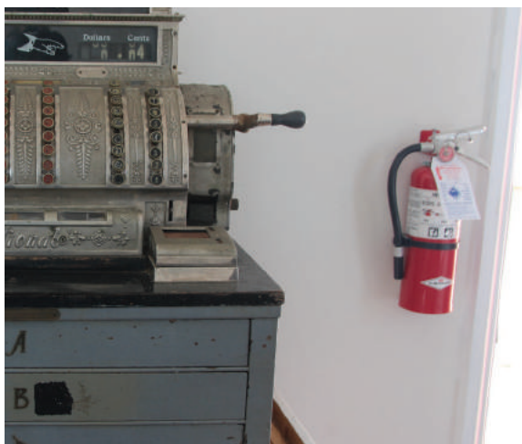
Figure 66 : Un extincteur portatif est disponible à l'intérieur du bâtiment.
