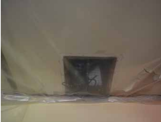
Figure 164 : Des trappes permettent à l'air de circuler entre le rez-de-chaussée de l'appentis et les chambres à l'étage de la maison.
