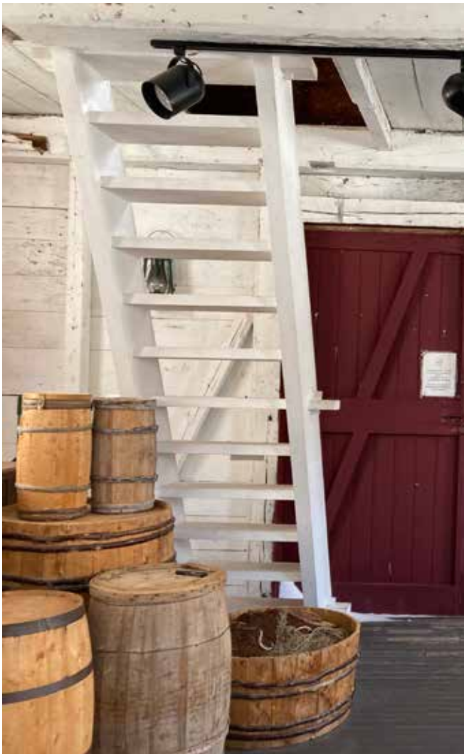
Figure 50 : Un escalier de meunier en bois peint en blanc donne accès à l'étage. Il a été reconstitué lors des travaux de 2005.
