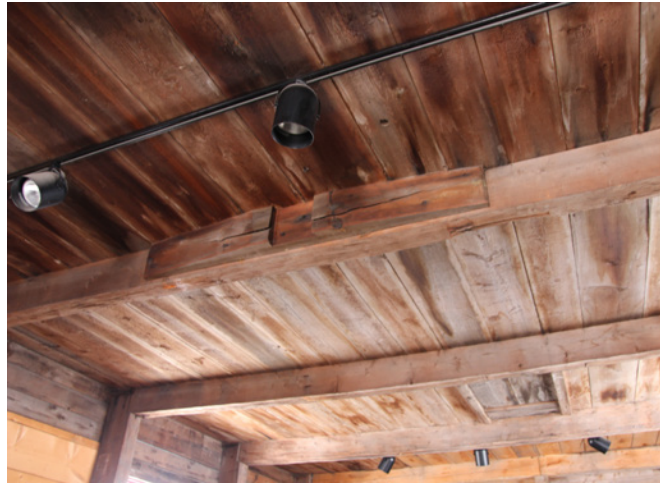
Figure 15 : Le plancher du comble de la forge est constitué de madriers de 38 mm d'épaisseur en sapin ou en épinette emboutetés et déposés sur un système de poutres.
