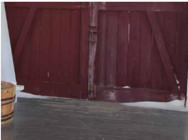
Figure 53 : Le plancher du rez-de-chaussée est recouvert de petites lattes de bois peint posé sur la dalle de béton. La peinture est écaillée près de la porte de la façade sud.
