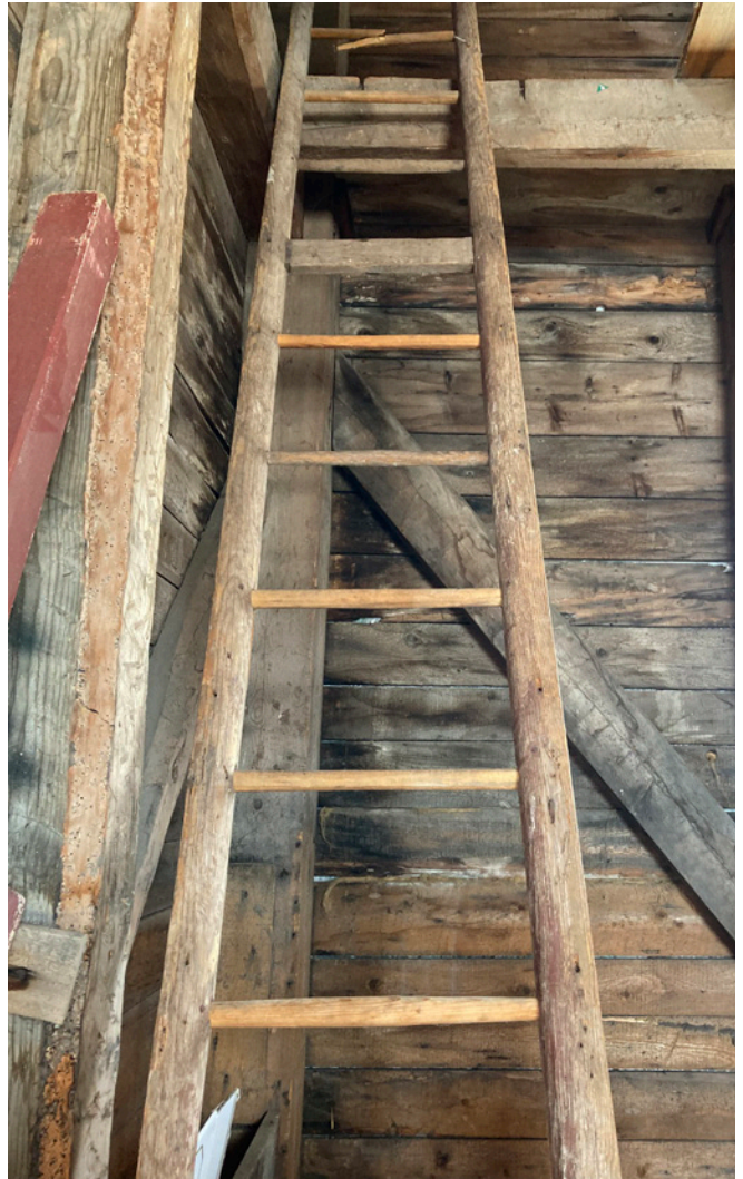
Figure 47 : Une échelle en bois donne accès à l'étage.
