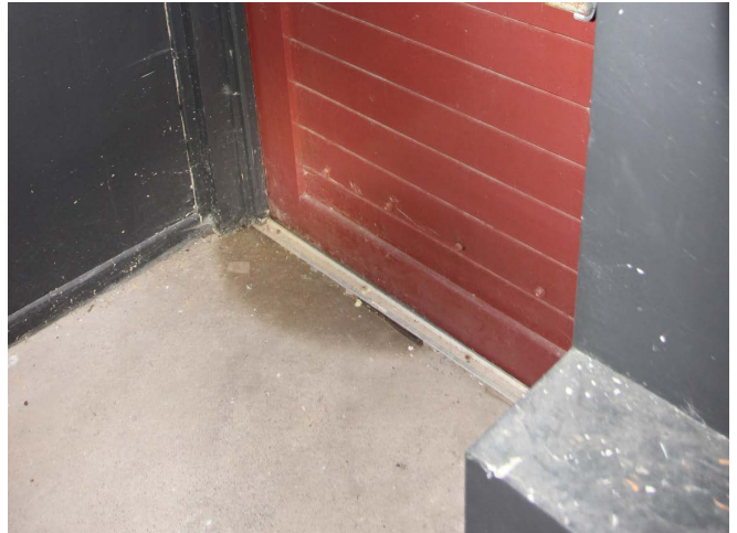
Figure 17 : À l'exception de l'appentis ouest, les planchers du bâtiment sont composés d'une dalle de béton. La dalle de béton semble en bon état.
