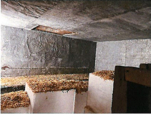
Photo #7 L'intérieur du congélateur semble en bon état.
