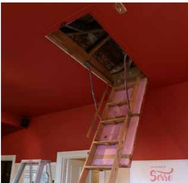
Fig. 77 : L'entretoit est accessible par une trappe d'accès.
