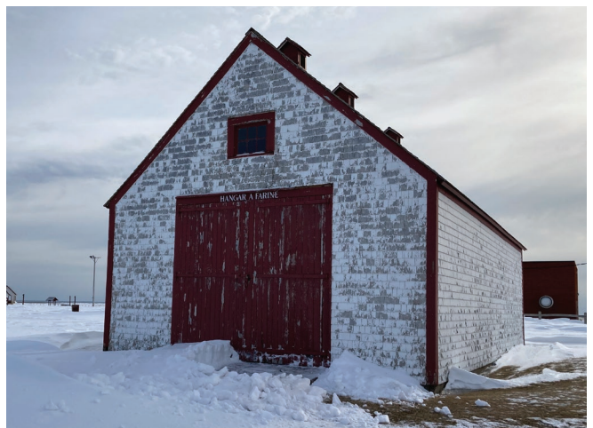
Figure 5 : Façade arrière nord.
