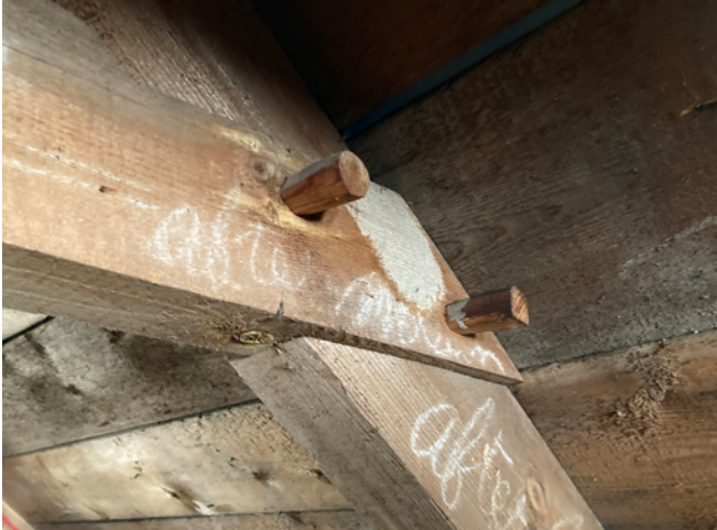
Figure 24 : La charpente est assemblée avec des chevilles de bois. Des graffitis sont visibles sur les faux entrails.
