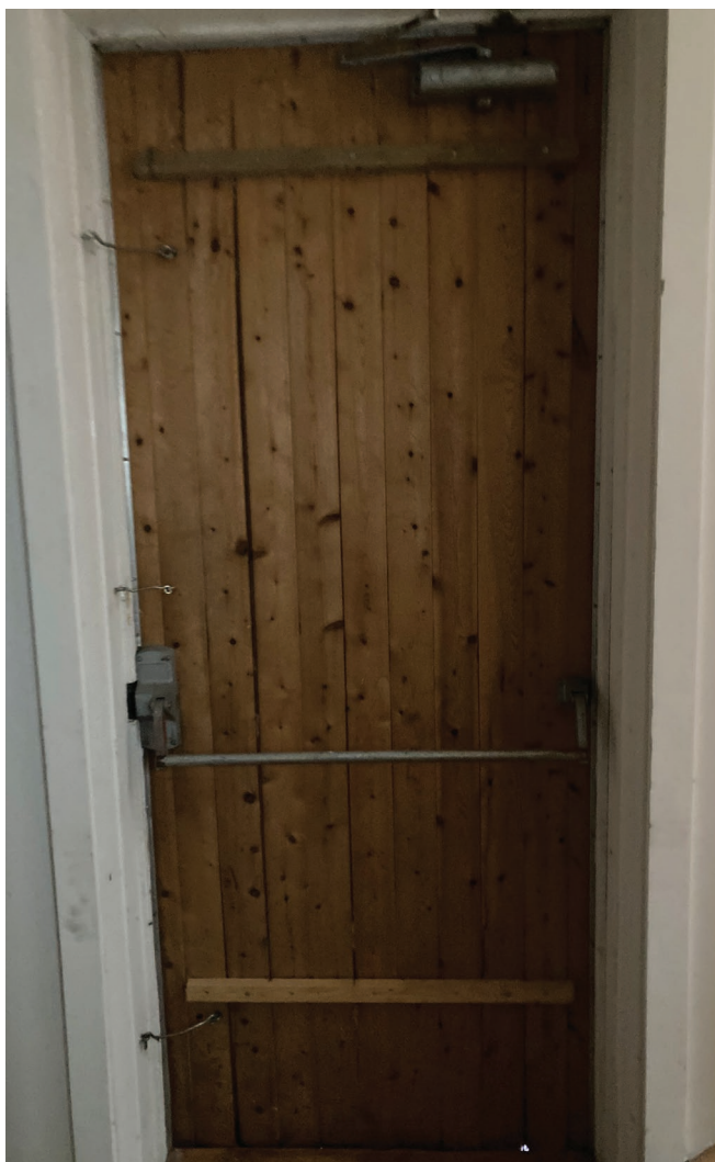
Figure 54 : Du côté intérieur, elle est composée de planches de bois nu. Une barre panique est installée sur la porte.
