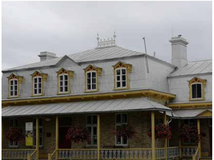
Fig. 76 : Le bâtiment possède deux cheminées. L'une est située sur le côté sud-ouest du bâtiment et l'autre est située entre les deux volumes du bâtiment.
