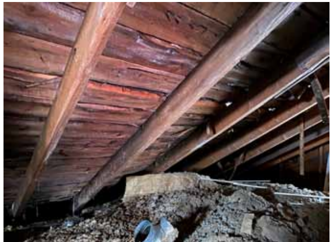
Figure 46 : La structure de toiture est constituée d'un platalage posé sur des chevrons en bois de sciage espacé tous les 2 pi environ.
