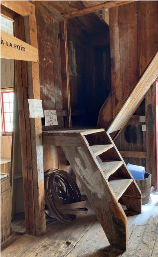
Figure 60 : Un escalier de bois avec un palier donne accès à l'étage.
