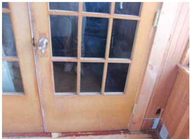
Figure 101 : Le passage entre le corps principal de la maison et la véranda est fermé par une porte vitrée en bois vernir à carreaux à double battants, aussi appelées portes françaises.
