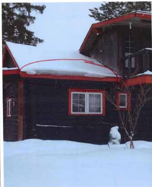
Figure 142 : Formation de digues de glace du côté est en mars 2022. Photographie transmise par la ville de Val-d'Or.
