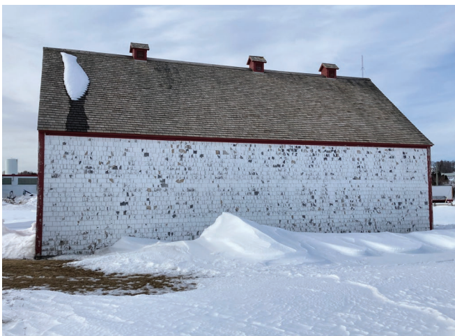
Figure 4 : Façade latérale ouest.
