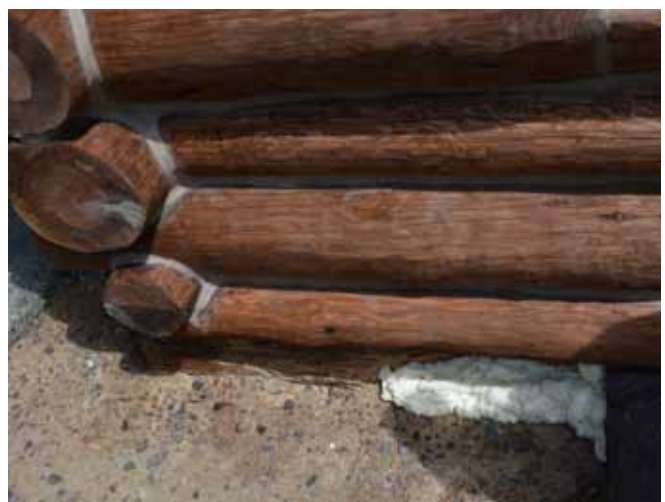
Figure 99 : Ensuite il décape et sable les billots et les traite avec un traitement préteinture Armor All.
