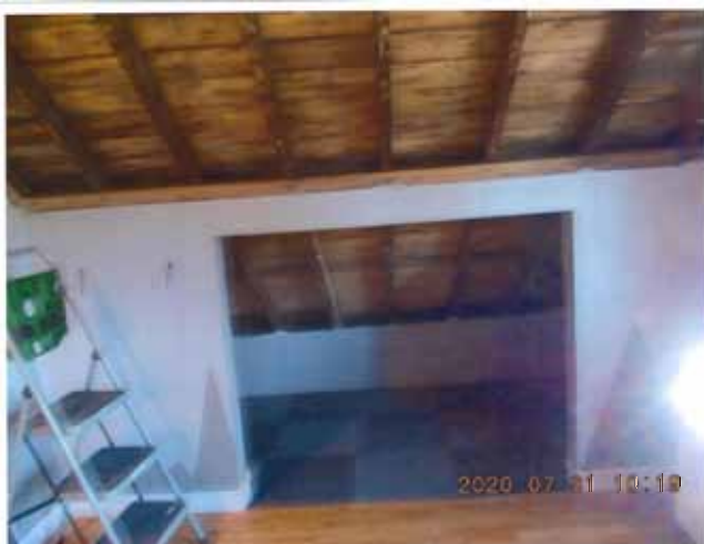
Figure 120 : Photographie des plafonds prises en juillet 2020 avant les travaux d'isolation par l'intérieur. Photographie transmise par la ville de Val-d'Or.
