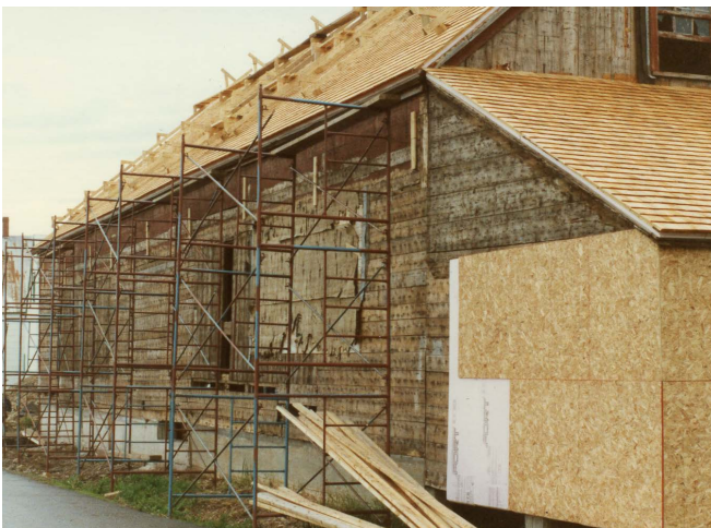
Figure 34 : En 1988, un isolant rigide a été ajouté du côté extérieur du bâtiment. Travaux de restauration de 1988. Source : Collection du SHNP.
