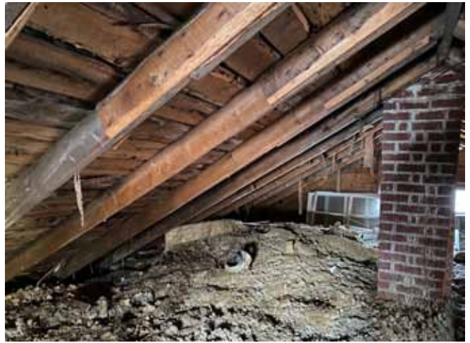
Figure 48 : La structure de toiture est constituée d'un platalage posé sur des chevrons en bois de sciage espacé tous les 2 pi environ.
