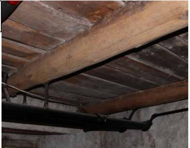
Fig. 20 : Le platelage du plancher est en planches de bois.
