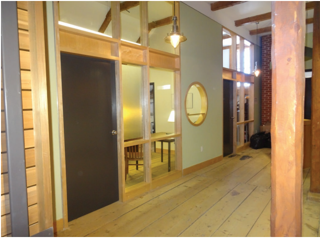
Figure 65 : Les cloisons intérieures à l'étage sont composées de panneaux de gypse peints. Les colonnes en bois équarrées soutenant le bâtiment sont visibles dans les différentes pièces.
