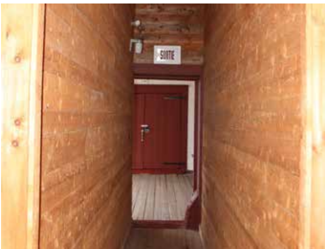
Figure 108 : Les nouvelles cloisons ajoutées au rez-de-chaussée pour l'aménagement de l'escalier d'issue et des sanitaires sont recouvertes de planches de bois nu.
