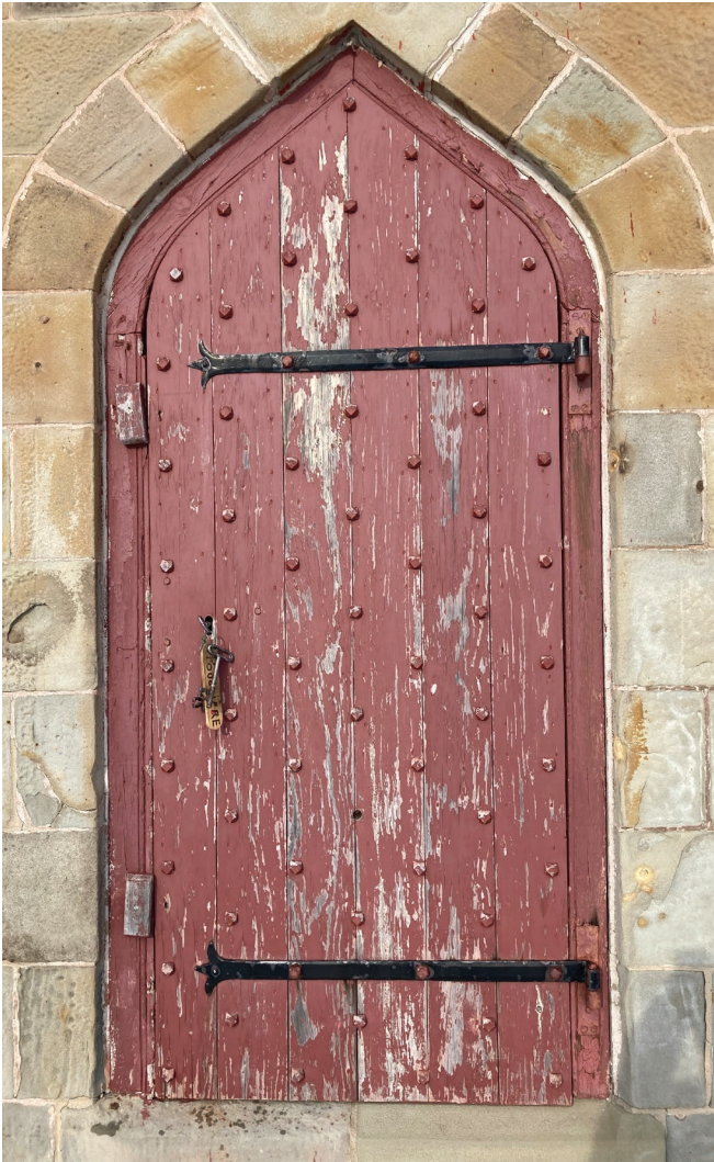
Figure 26 : Le bâtiment est muni d'une porte à arc en accolade, possiblement influencée par l'architecture jersiaise. La porte est en bon état, bien que la peinture s'écaille.
