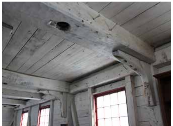
Figure 54 : Les finis de plafond sont composés de la structure exposée et du platelage de bois qui sont en bon état. Au rez-de-chaussée, la finition des surfaces reproduit le chaulage d'origine.
