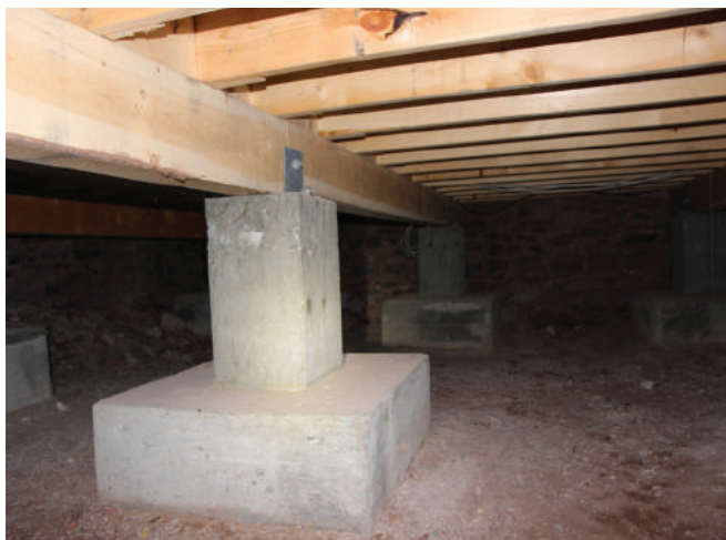
Figure 13 : Le plancher du bâtiment repose sur des piliers de béton.
