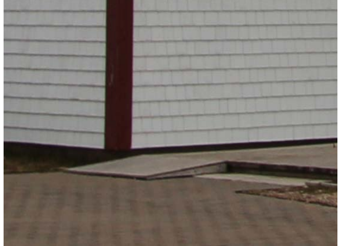
Figure 19 : Un rampe de bois permet d'accéder à la terrasse depuis l'entrée du site en pavé uni.
