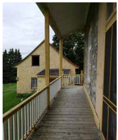
Fig. 27: La galerie à l'arrière possède des garde-corps de type traditionnel en bois.
