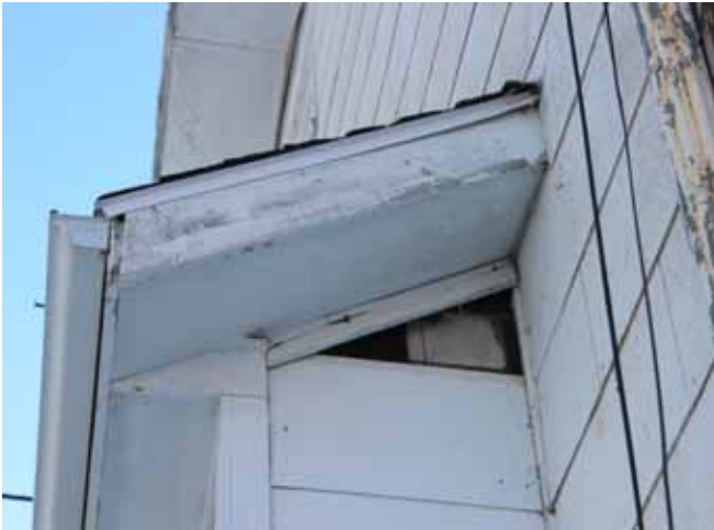
Figure 68 : Les larmiers sont formés de soffites, le revêtement qui recouvre le dessous du larmier, et fascias, la bande verticale bande sous le bord de toit, en bois peint en blanc.
