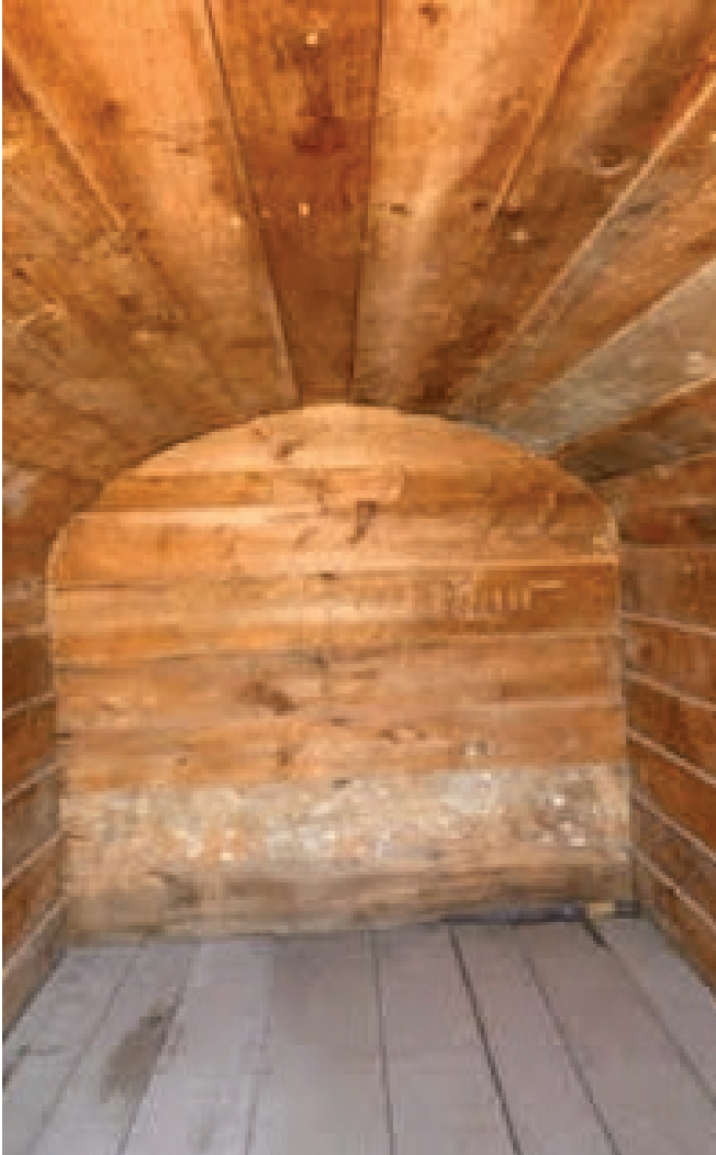
Figure 37 : Le plancher, les murs et la voûte sont recouverts de planches de cèdre généralement en bon état. Photo transmise par le client.
