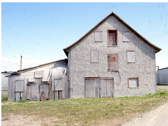
Figure 11 : Avant les travaux de restauration de 1988. Collection du SHNP.
