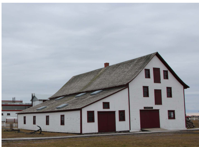
Figure 26 : L'appentis nord est recouvert d'un seul versant adossé au bâtiment principal. Les toitures sont recouvertes de bardeaux de cèdre naturels.
