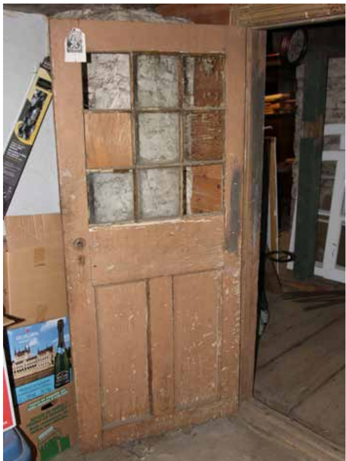
Fig. 83 : Au sous-sol, la porte permettant de traverser de l'extrémité sud-ouest du bâtiment au centre du bâtiment est en bois avec caissons et vitrage composé de divisions à neuf carreaux.
