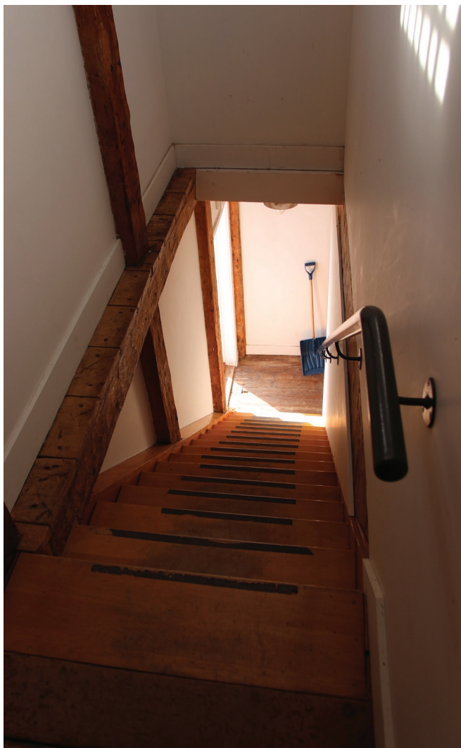
Figure 80 : Deux escaliers d'issue conforme en bois verni avec main-courante métallique ont été ajoutés au bâtiment le long des deux murs pignons.
