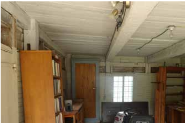
Fig. 64 : Un tendeur métallique a été ajouté sur l'axe nord-sud près de la trappe d'accès au vide sanitaire.
