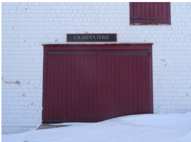
Figure 62 : Le volume principal est percé de deux portes à doubles vantaux en bois: une première sur la façade ouest.
