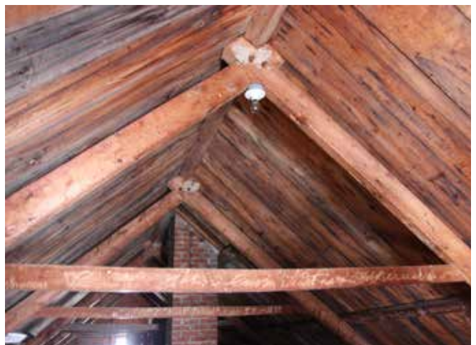
Figure 19 : Le croisement des arbalétriers au faite est tenu par un assemblage à cheville.
