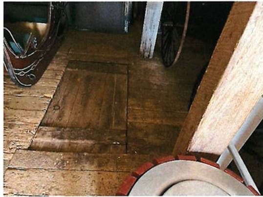
Photo #21 Trappe d'accès menant à l'escalier du niveau 01. La trappe est en bon état.
