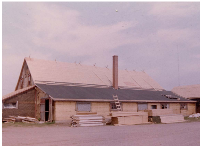
Figure 73 : En 1988, de nouveaux bardeaux de cèdre sont installés sur une membrane. Collection du SHNP.
