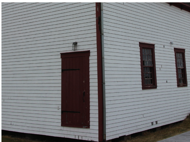
Figure 46 : Une porte simple sur la façade nord donne accès au bâtiment. Elle a été ajoutée lors des travaux de 1980-1981.
