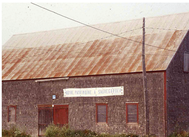
Figure 56 : En 1980, la toiture est recouverte de tôle. Source: Collection du SHNP.
