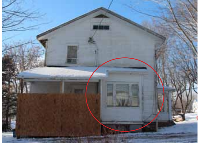
Figure 3 : Façade latérale est. Une petite annexe en saillie est contiguë à la façade est, immédiatement au nord de la galerie.
