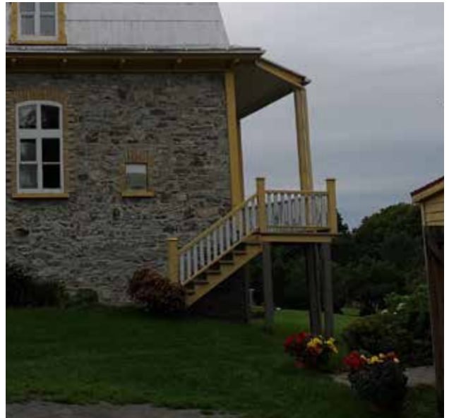
Fig. 33 : La galerie à l'arrière, située sur la façade nord-ouest, est accessible par un escalier situé sur le côté nord-est du bâtiment.
