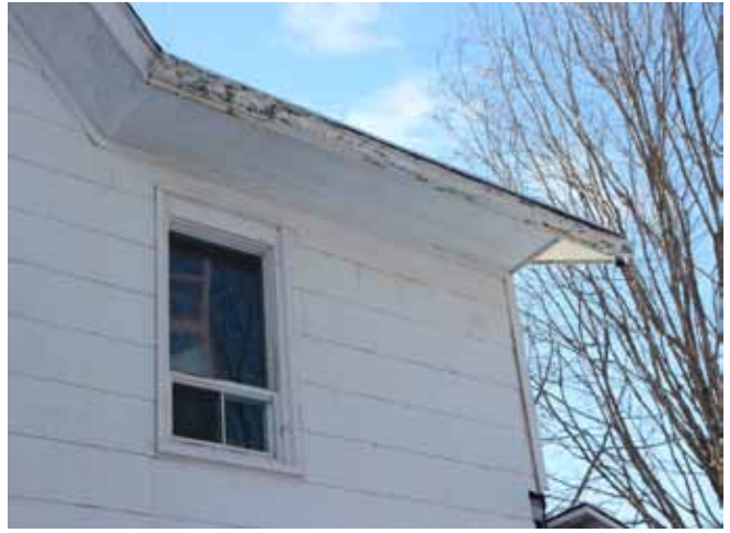
Figure 67 : Les larmiers sont formés de soffites, le revêtement qui recouvre le dessous du larmier, et fascias, la bande verticale bande sous le bord de toit, en bois peint en blanc.
