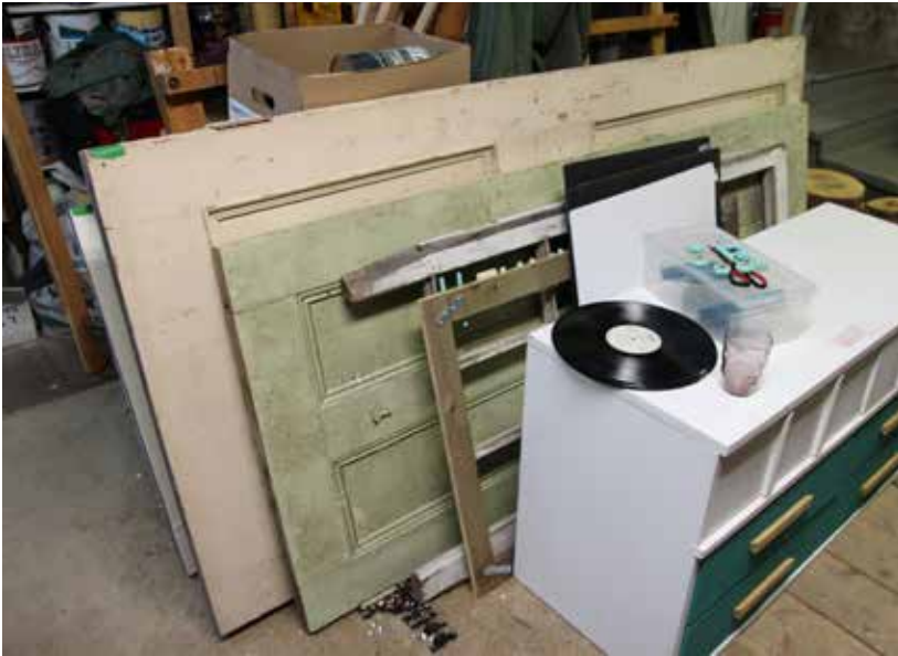
Fig. 63 : À l'arrière, deux portes permettent d'avoir accès à la galerie. Celle menant à l'ancienne cuisine d'été est une porte en bois, sans vitrage, avec caissons et imposte vitrée. L'été, cette porte a été entreposée au sous-sol.
