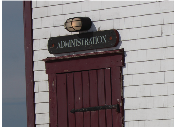
Figure 73 : Un panneau d'identification est installé au-dessus de la porte latérale est. Sur la façade principale, une potence en fer forgé surmonte les portes double (figure 74).
