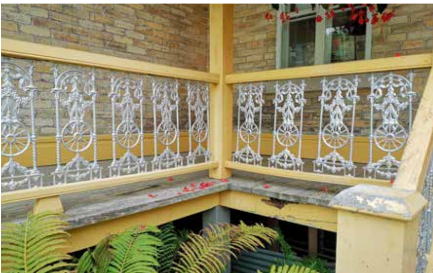
Fig. 26: La galerie à l'avant a des garde-corps en fonte ornementale avec une main courante et une lisse basse en bois. Ces ornements étaient déjà présents sur la galerie de la façade avant en 1888.
