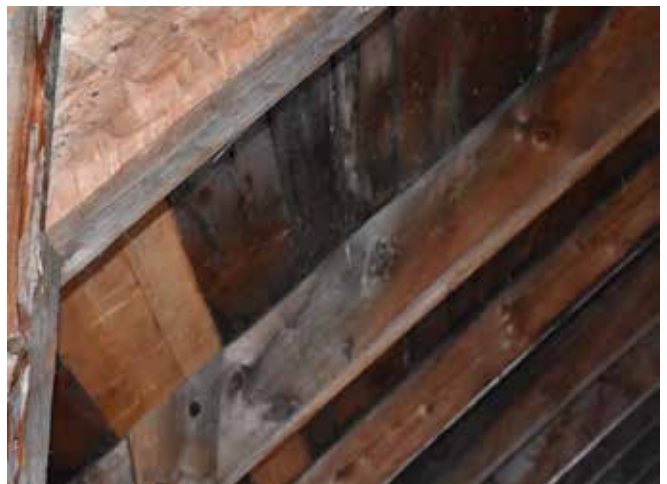
Figure 55 : Certaines planches du platelage ont été remplacées lors des travaux de restauration, mais plusieurs pièces de la charpente sont d'origine.
