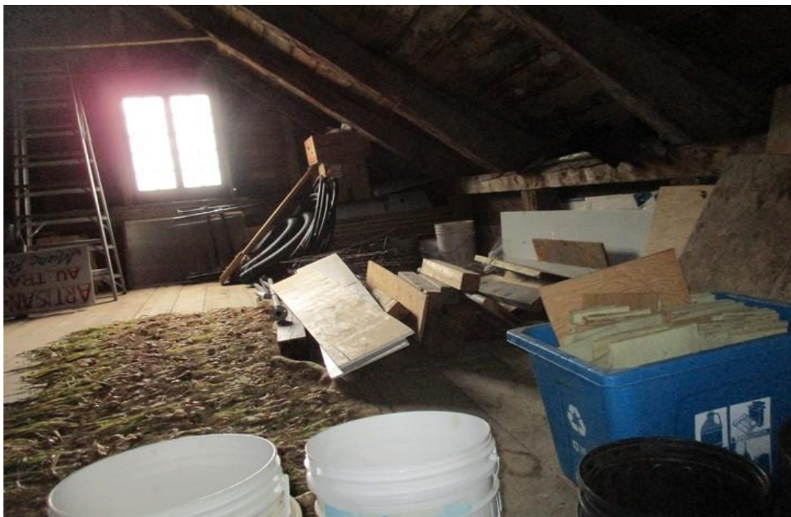
Photo 12: Matériel entreposer dans l'entretoit à enlever
