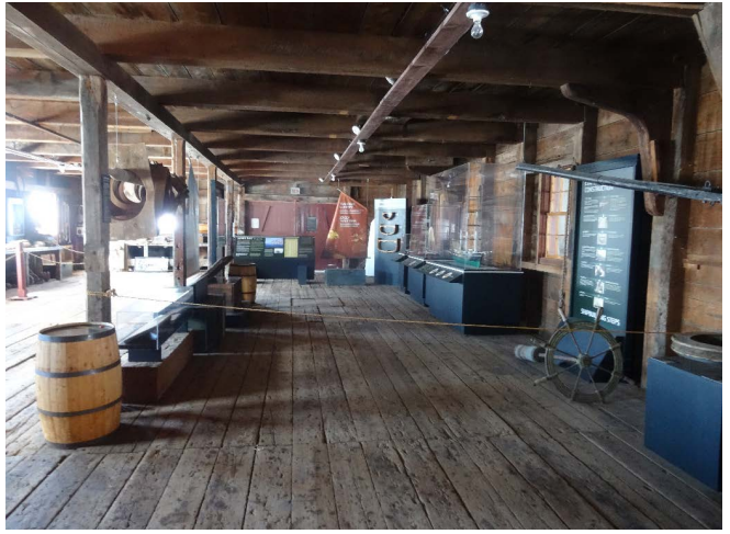
Figure 15 : Le plancher du volume principal est composé d'un platelage de bois déposé sur un système de poutres et poutrelles.
