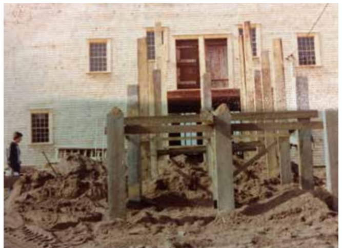
Figure 42 : La rampe a été reconstruite en 1981. Source: Collection du SHNP.
