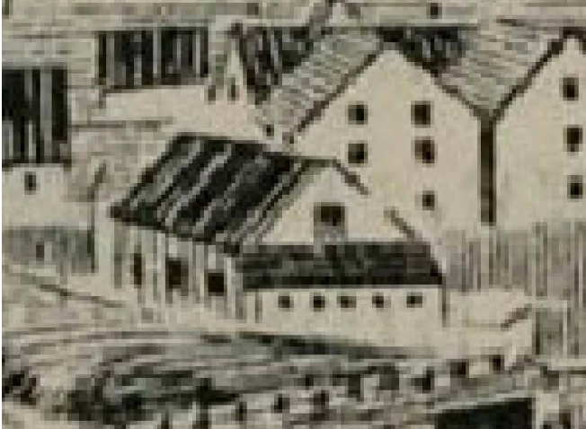
Figure 42 : Sur un dessin de 1901, cinq fenêtres sont représentées sur l'appentis ouest. Collection du SHNP.
