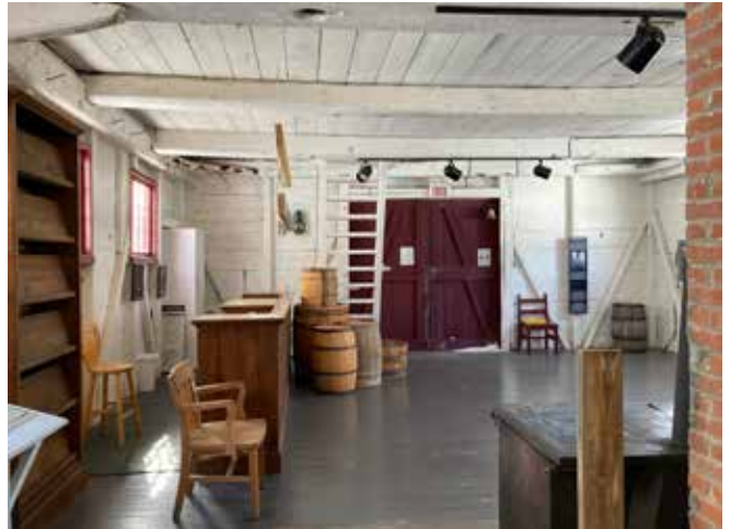
Figure 15 : Le plancher du rez-de-chaussée est recouvert de petites lattes de bois peint posé sur la dalle de béton. La peinture est écaillée près de la porte de la façade sud.
