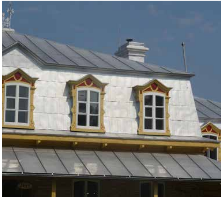
Fig. 68 : La toiture mansardée a un brisis en tôle à la canadienne et un terrasson en tôle à baguette.
