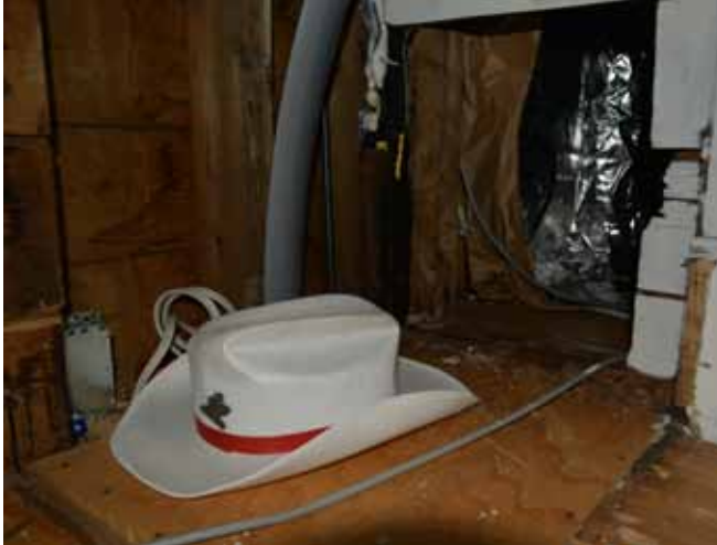
Figure 152 : La face inférieure de la toiture est isolée par des matelas de mousse isolante blanche en polymère avec un pare-vapeur réfléchissant du côté chaud.
