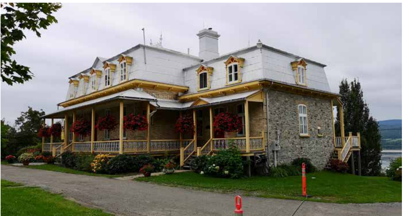
Fig. 6 : Vue du côté est du bâtiment.
