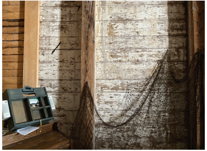
Figure 66 : Sur les murs anciens, des graffitis et le chaulage d'origine sont apparents sur les planches
