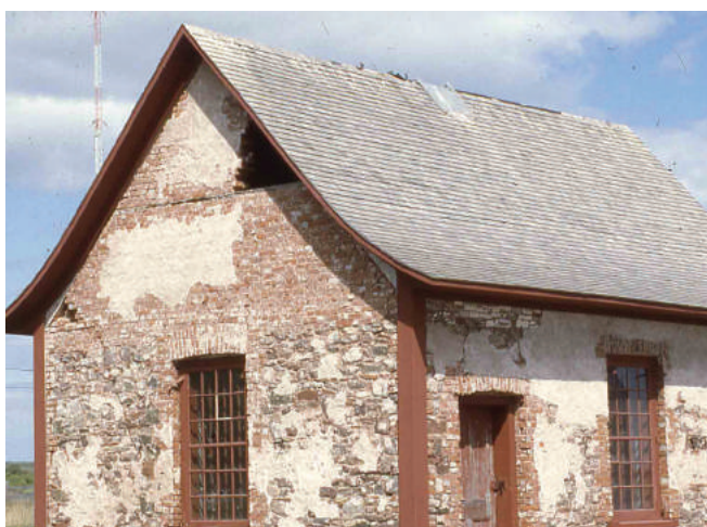
Figure 23 : Les murs sont composés d'un assemblage hétérocyte de pierres et de briques. Source: Collection du SHNP. 1983.
