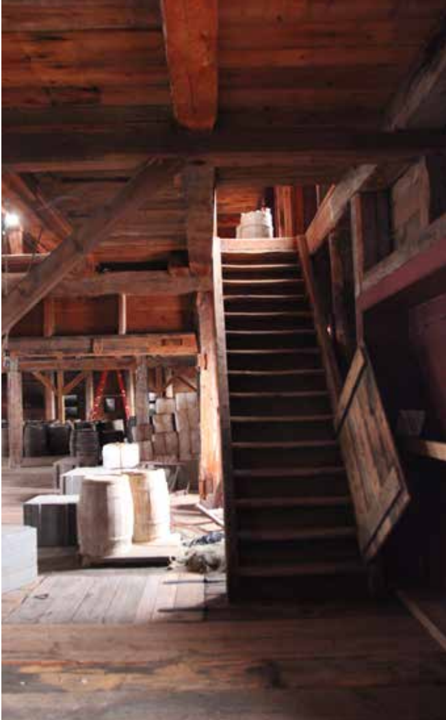
Figure 121 : Des escaliers de meuniers donnent accès aux passerelles situées dans le volume principal.
