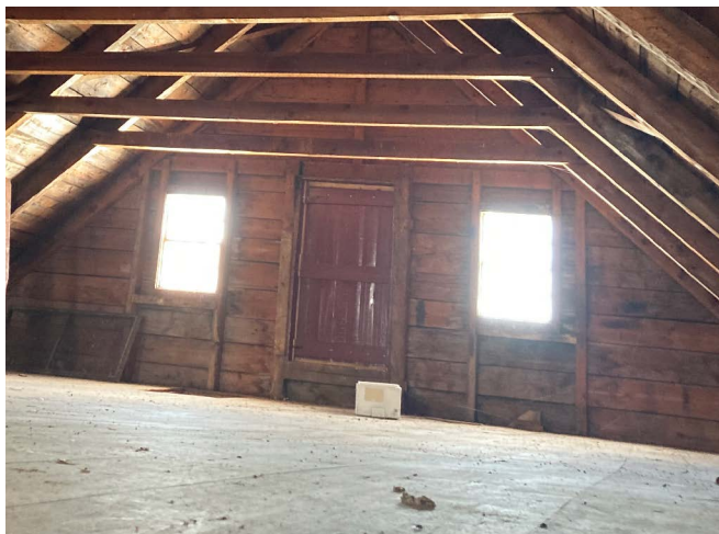
Figure 66 : Deux portes de chargement à simple vantail sont localisées sur chacune des façades pignon du volume principal.
