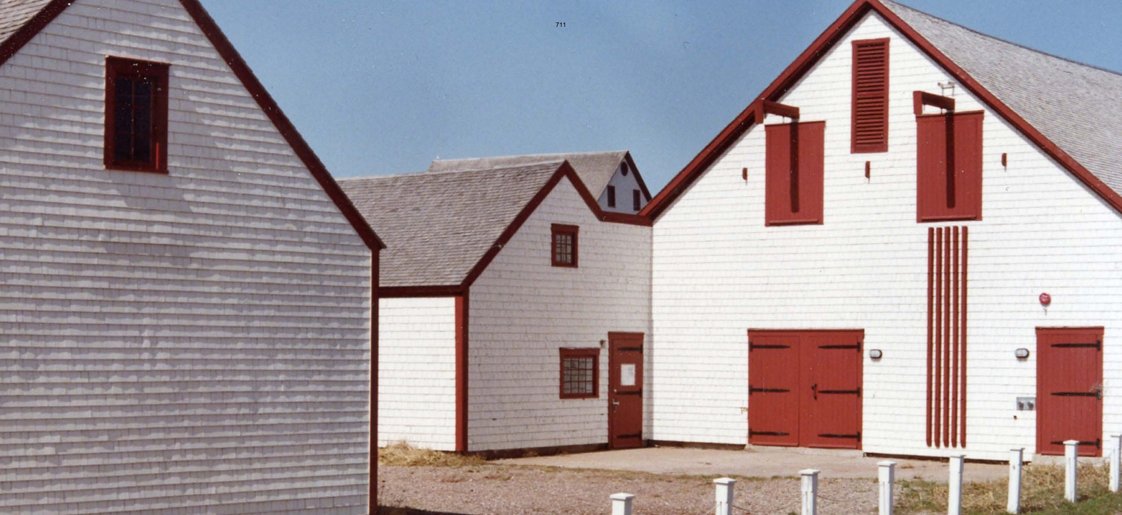
PORTES APRÈS LES TRAVAUX DE RESTAURATION DE 1989. À DROITE, AJOUT DE LA PORTE DONNANT ACCÈS AU SYSTÈME DE GICLEURS. COLLECTION SITE HISTORIQUE NATIONAL DE PASPÉBIAC.
