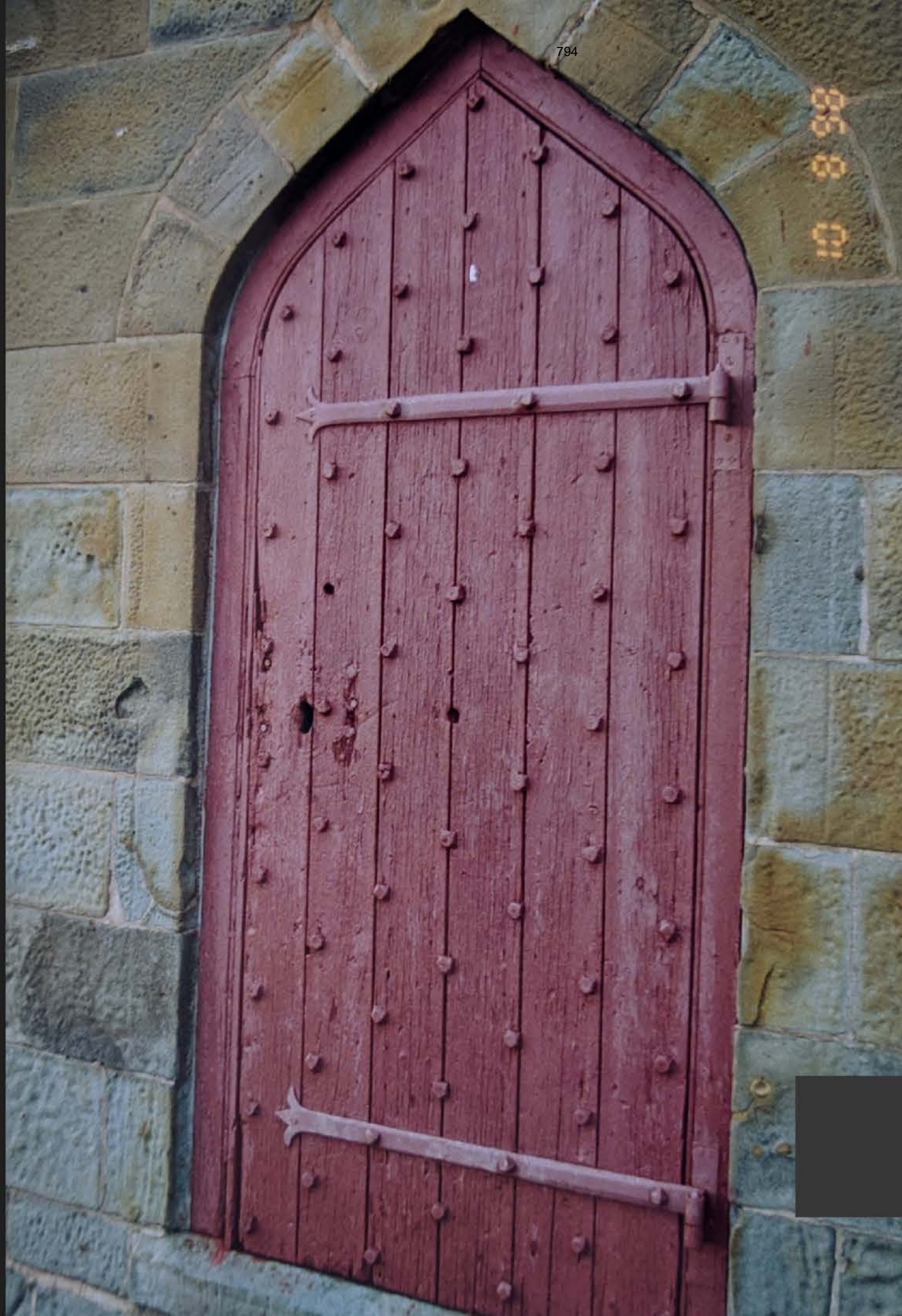
PORTE APRÈS LES TRAVAUX DE 1989. COLLECTION SITE HISTORIQUE NATIONAL DE PASPÉBIAC.
