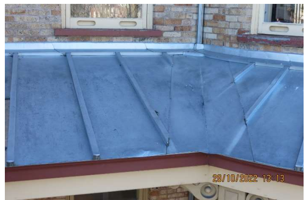
6 Toiture de la galerie côté Est
