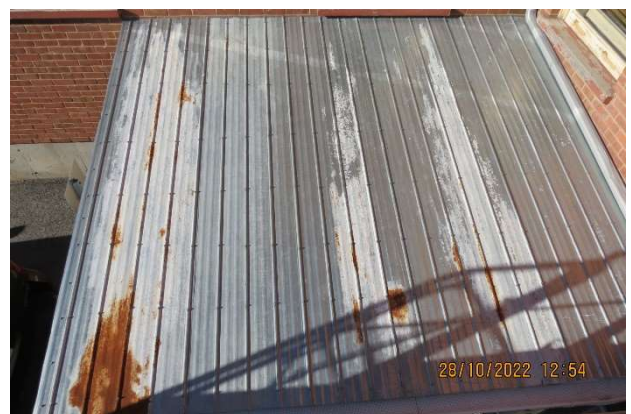
16 Tôle affecté par la rouille
