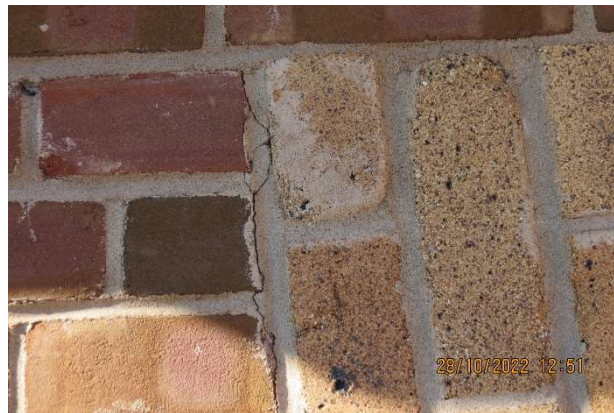
27 Joint de mortier plate-bande
