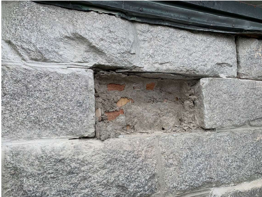
Figure 8 : Ouverture exploratoire Z3-03
