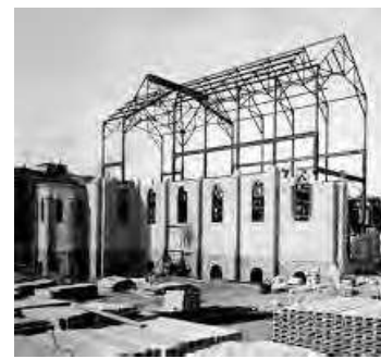
Structure en acier de l'Église du Très-Saint-Sacrement.
