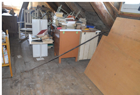
Tirants assurant la stabilité de la charpente, installés aux fermes 3, 5 et 7
