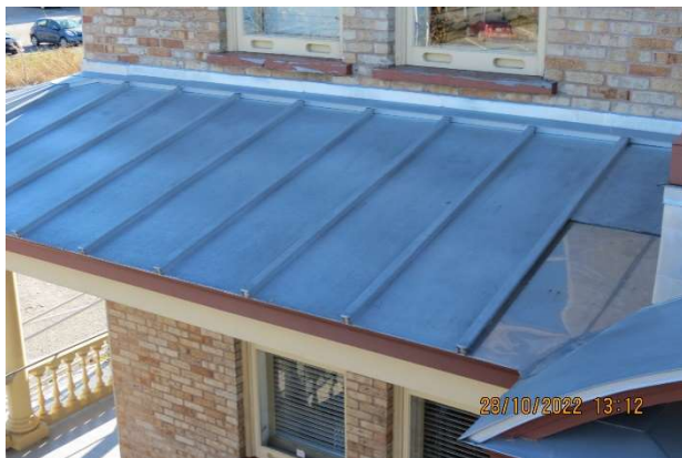
5 Toiture de la galerie
