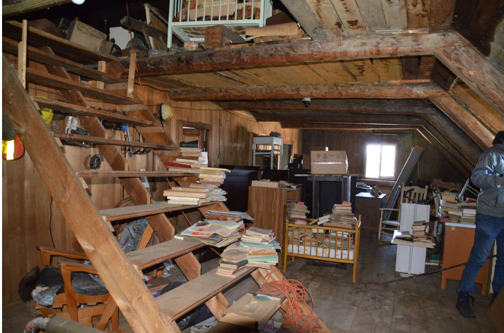
Combles, partie ouverte et non aménagée
