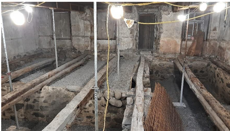
Figure 6. Aperçu de la structure de support des planchers du rez-de-chaussée et de l'étage. Vue vers le nord.
