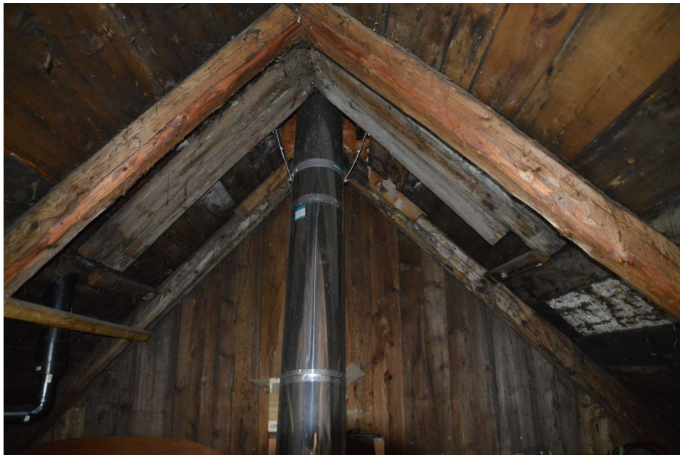
Faîtage des combles : rencontre des chevrons
