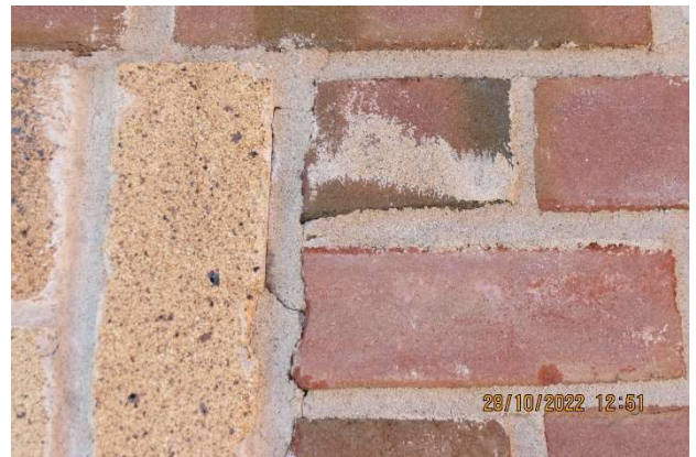
26 Joint de mortier plate-bande
