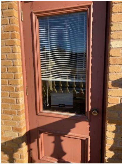
38 Porte du balcon Ouest
