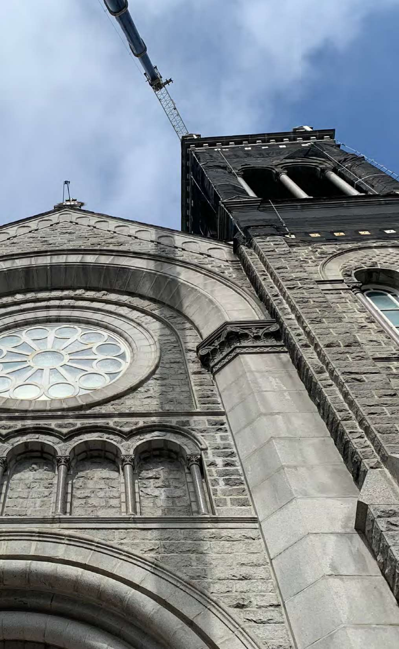
Illustration : Inspection d'une des tours
