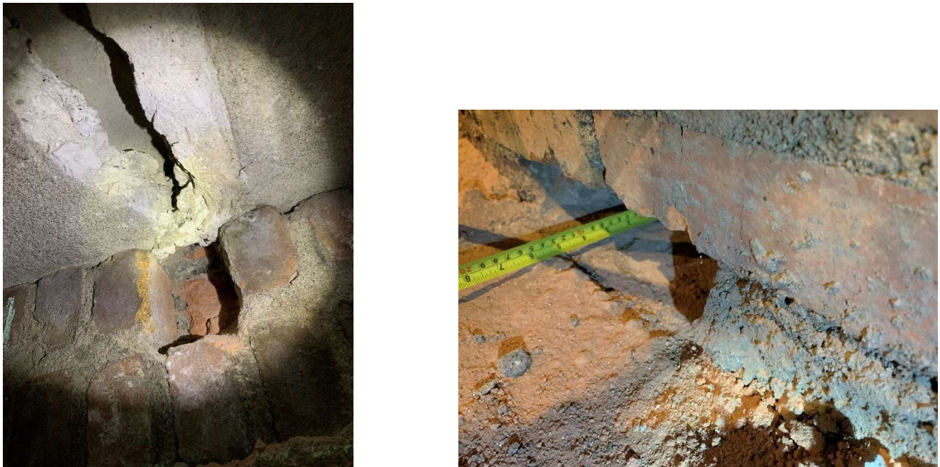
Figure 10 : Ouvertures exploratoires permettant de valider certains enfoncements de dalles préfabriquées
