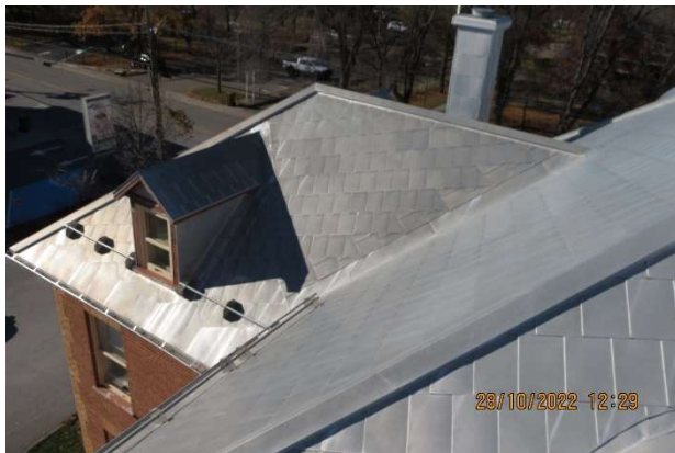
3 Toiture de l'annexe
