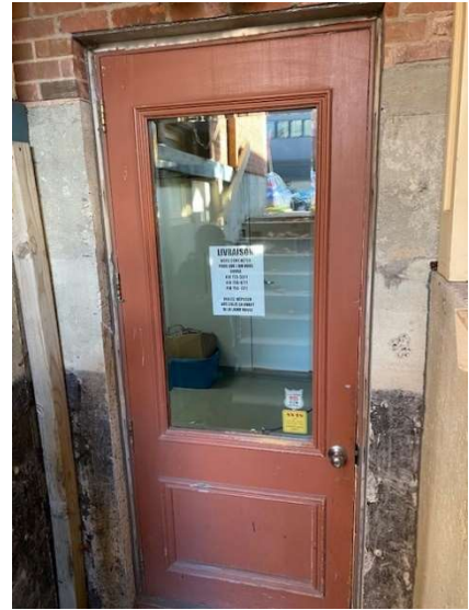
41 Porte d'accès du sous-sol
