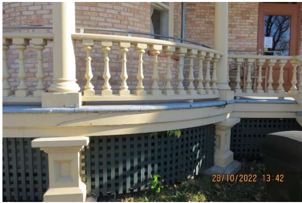
54 État des composants de la galerie (côté Nord)
