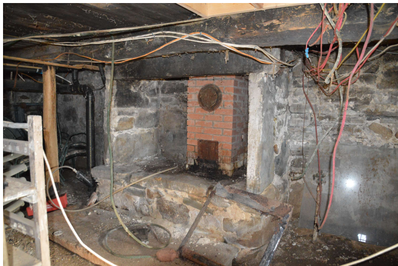
L'âtre du sous-sol hébergeant la cheminée de brique.
