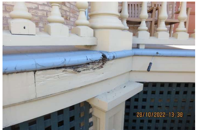
55 Secteur de dommages accrues
