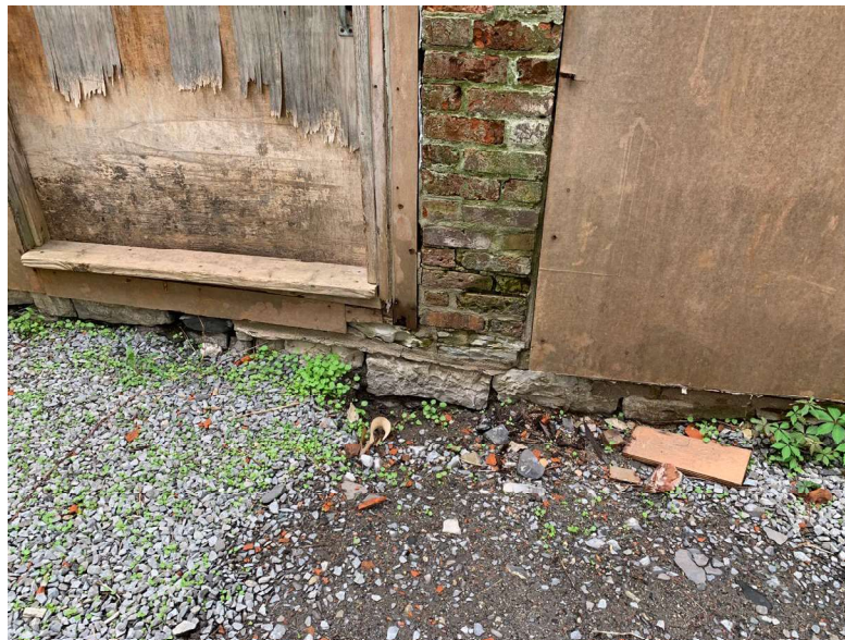
Photo 5 : Fondation du mur nord-est
