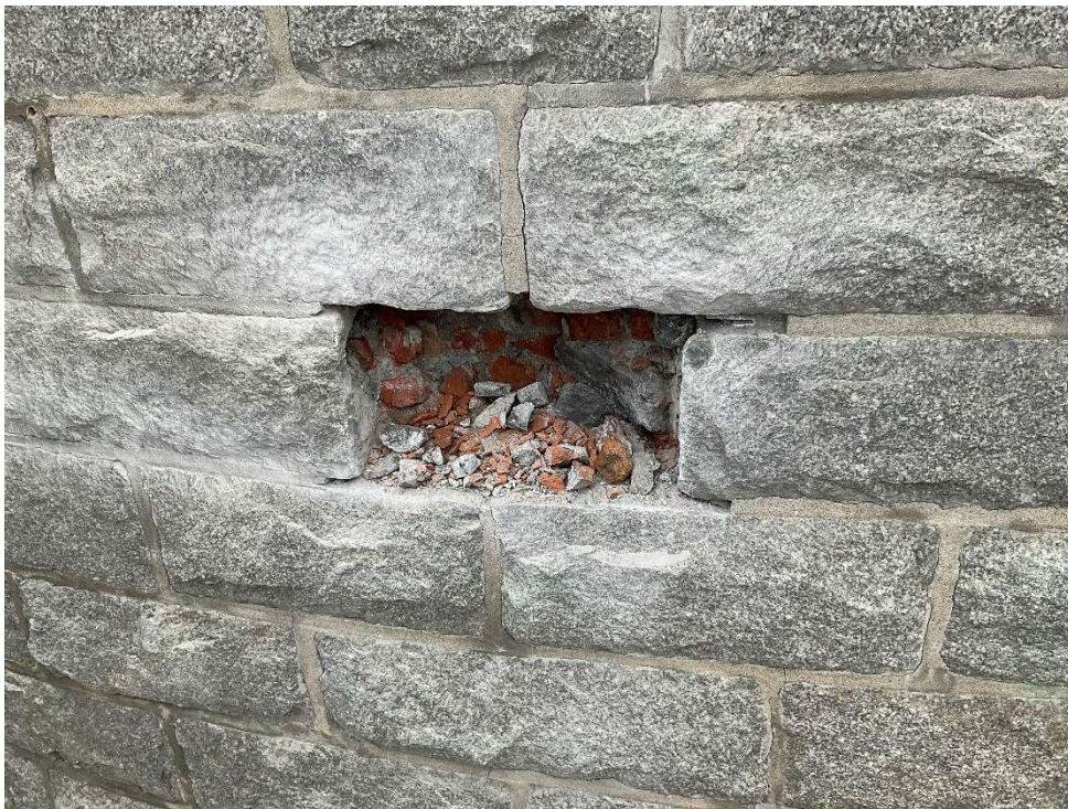
Figure 5 : Ouverture exploratoire Z12-13
