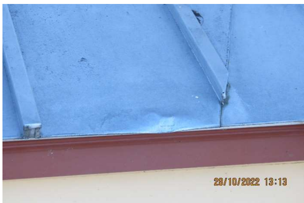
7 Section de la tôle bossée
