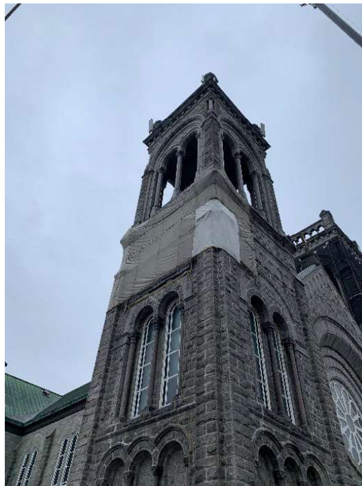
Photo 22 : Toile de protection sur la face ouest du clocher ouest
