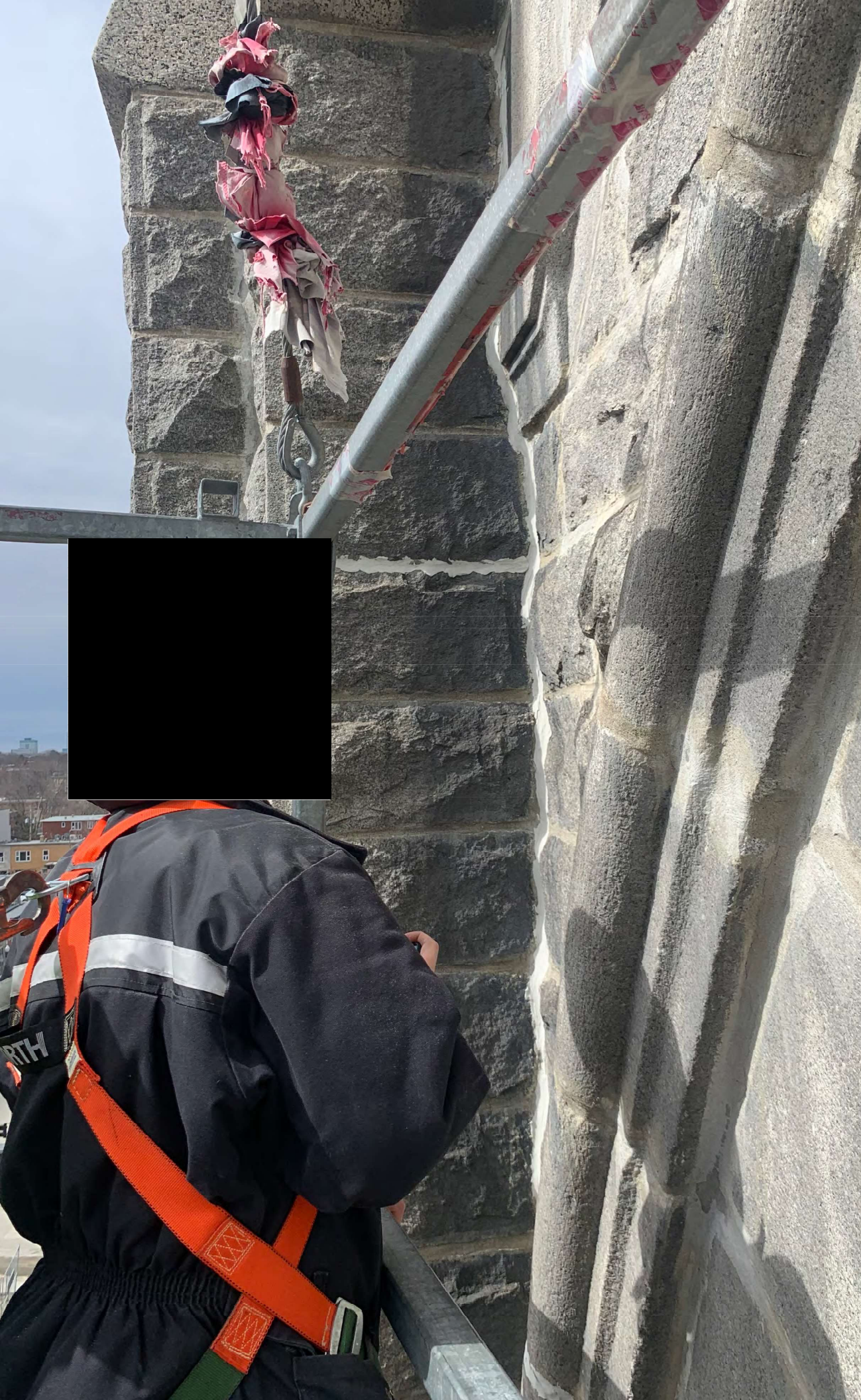
Illustration : Inspection de la façade
