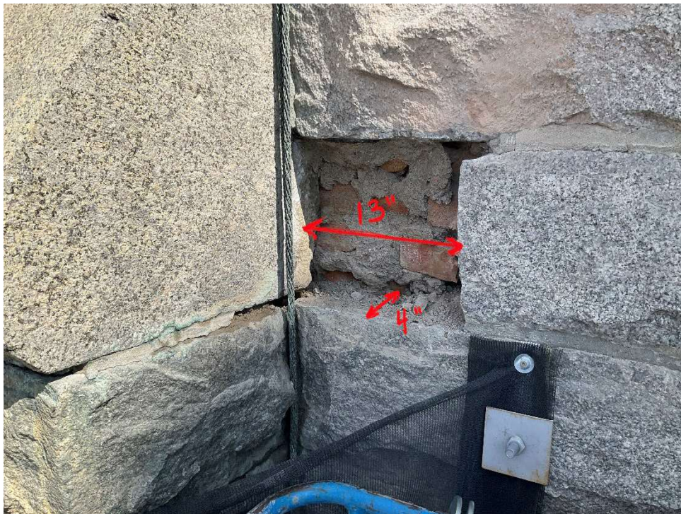
Figure 4 : Ouverture exploratoire Z1-06
