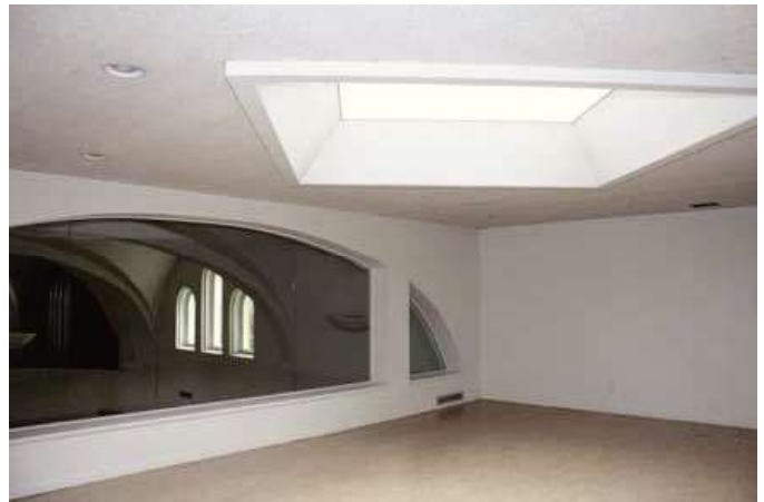
Jubé aménagé dans la partie haute de l'ancien sanctuaire. Le puits de lumière (lanterneau) d'origine a été conservé.
