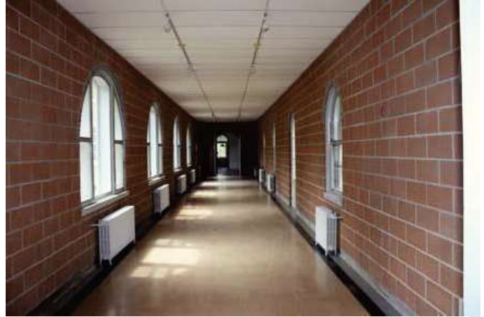
Couloir intérieur du passage couvert. Les murs sont en blocs vulgaires de ciment coloré.
