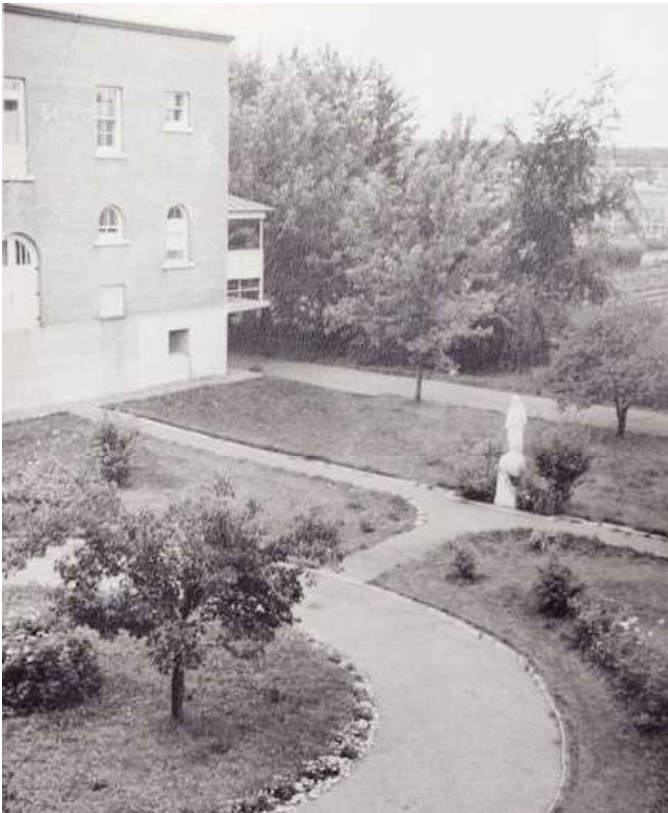
Le préau dans les années 1950 avant la construction de l'aile est et du passage couvert. Source : Archives du diocèse de T.-R.
