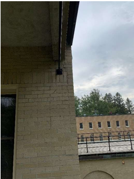
Photos 6A et 7A (2021) : Parement de briques fissuré (à gauche) et réparé à l'aide de scellant (à droite)
