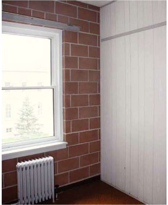
Murs en blocs de ciment et en « préfini » d'une cellule de l'étage de l'aile est.
