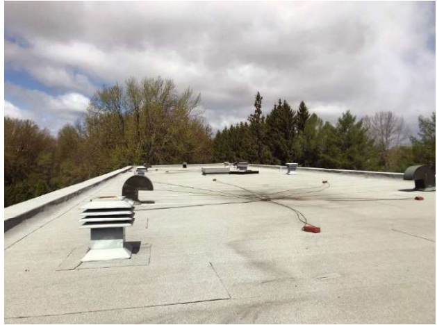
Couverture de l'aile ouest : membrane élastomère récente
