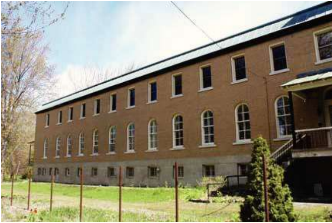
Façade ouest de l'aile ouest érigée en 1950.
