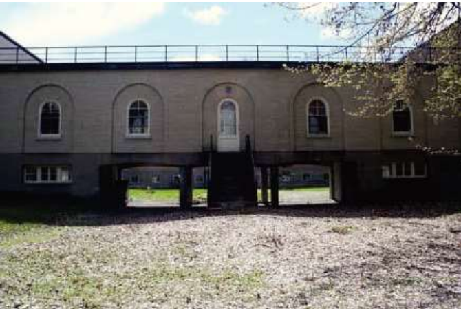
Façade nord du passage couvert.
