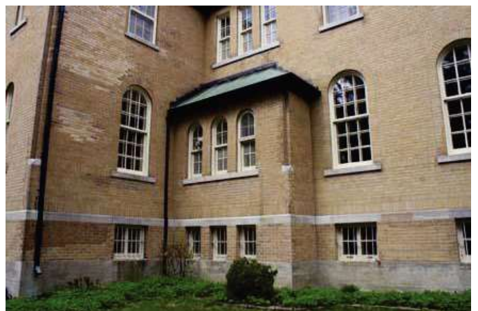
Détail de la façade principale à l'angle de l'avant-corps ouest.
