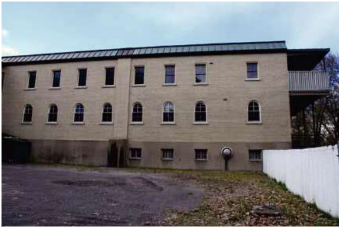
Façade est de l'aile est construite en 1962.
