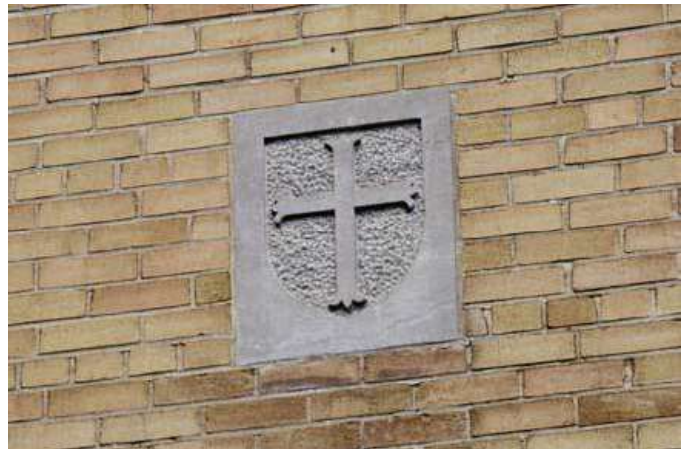
Détail d'un écusson sculpté sur la façade de l'avant-corps est.
