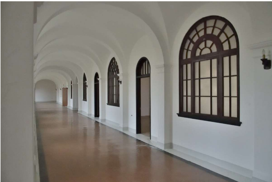
Photo 2020-03 : vue du corridor sud au rez-de chaussée. Finis en bon état, petit bois des ouvertures intérieures intact.
