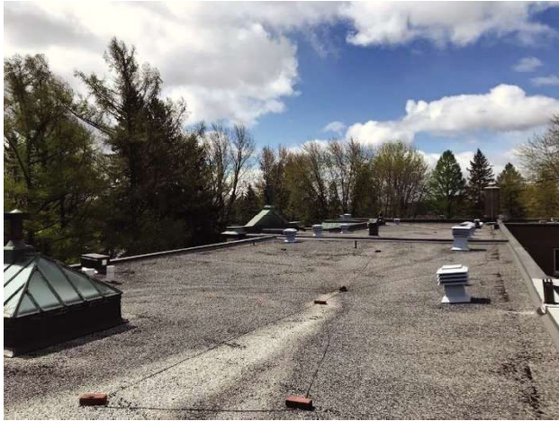
Couverture de l'aile principale en asphalte et gravier
