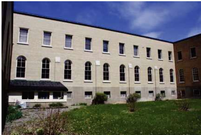
Façade ouest de l'aile est donnant sur le préau.
