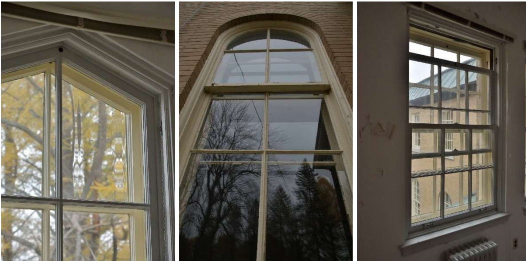
Photos 2020-04 à 06 : fenêtres originales, en très bon état.
