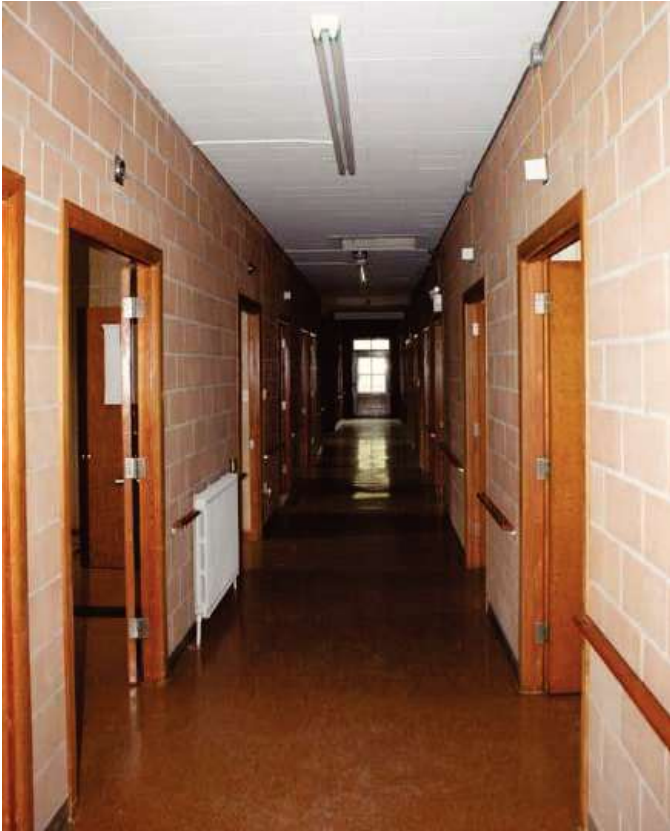
Couloir de l'étage de l'aile dont les murs sont constitués de blocs de ciment coloré.
