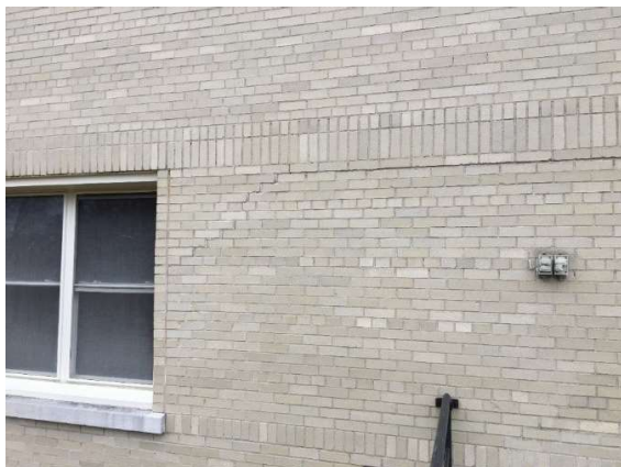
Photo 10 : Fissuration du parement de l'aile « est » (à gauche en 2020 et à droite en 2021)
