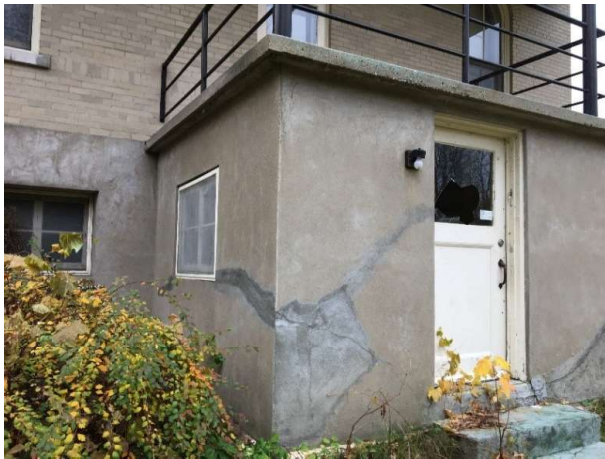
Photo 12 : Fissuration importante de l'accès au sous-sol de l'aile « est », à l'extrémité nord (à gauche en 2020 et à droite en 2021)
