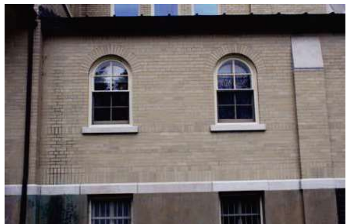
Détail de la façade sud de la chapelle.
