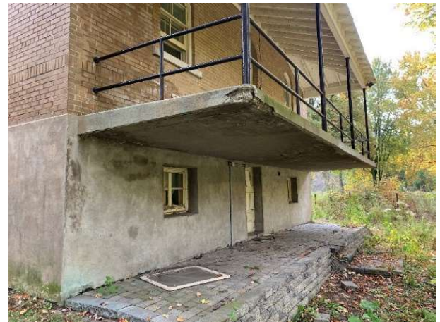
Photo 17 : Délamination du béton du balcon arrière ouest (à gauche en 2020 et à droite en 2021)
