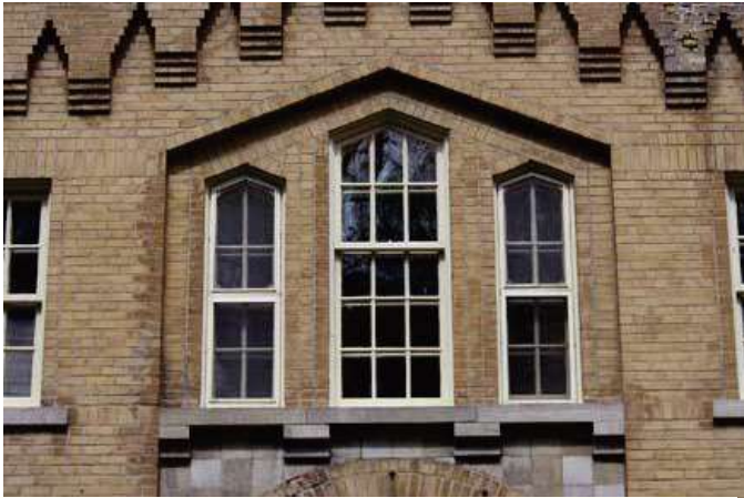
Détail des fenêtres de l'étage de l'avant-corps de l'entrée principale du monastère.
