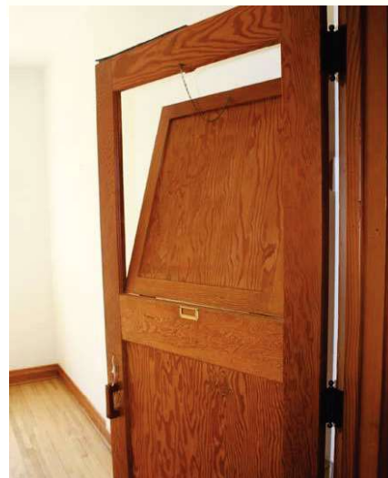
Porte de cellule dotée d'une partie ouvrante à l'étage de l'aile ouest.
