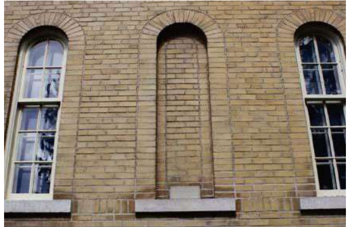
Détail de la façade de l'avant-corps ouest.
