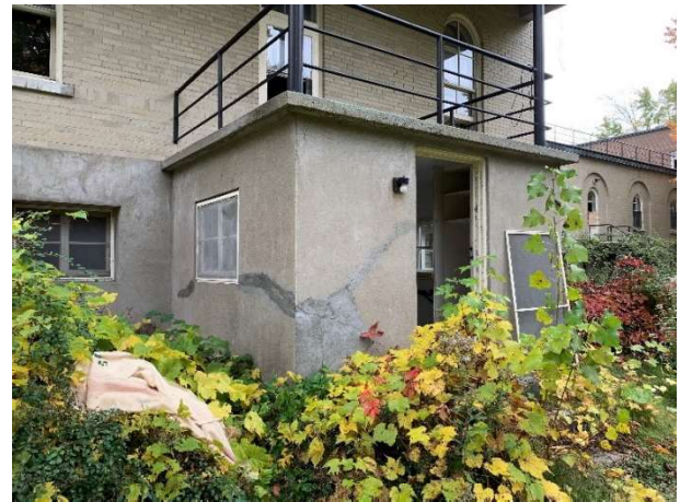
Photo 12 : Fissuration importante de l'accès au sous-sol de l'aile « est », à l'extrémité nord (à gauche en 2020 et à droite en 2021)
