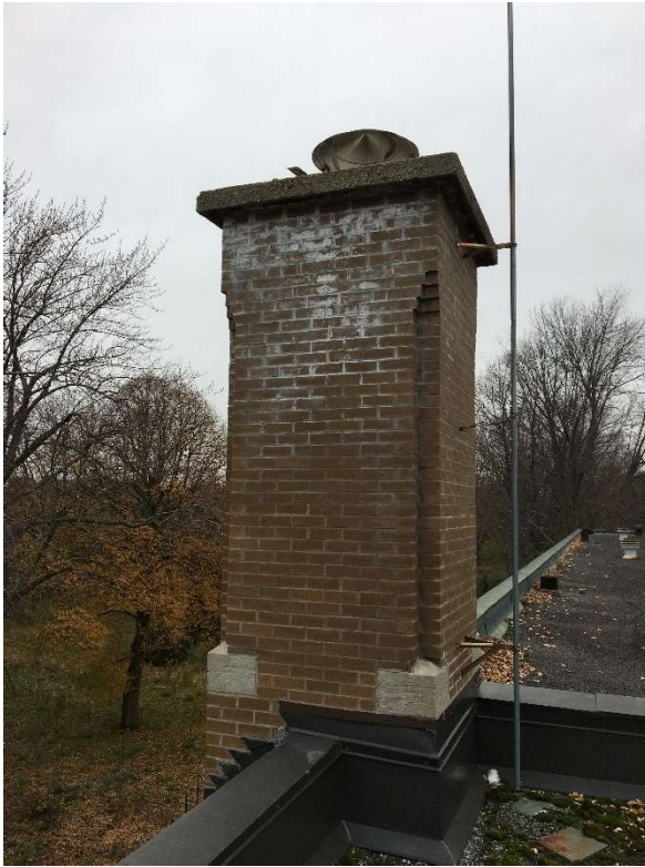
Photo 26 : Efflorescence sur la brique de cheminée (2020 à gauche et 2021 à droite)
