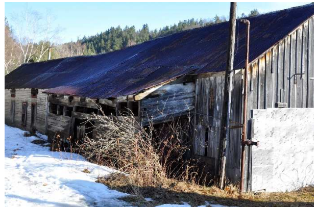
Image 4. Vue du mur gouttereau de la chalouperie-menuiserie, côté terre.
