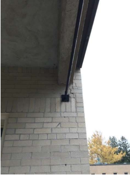
Photos 6 et 7 (2020) : Parement de briques fissuré (à gauche) et réparé à l'aide de scellant (à droite)
