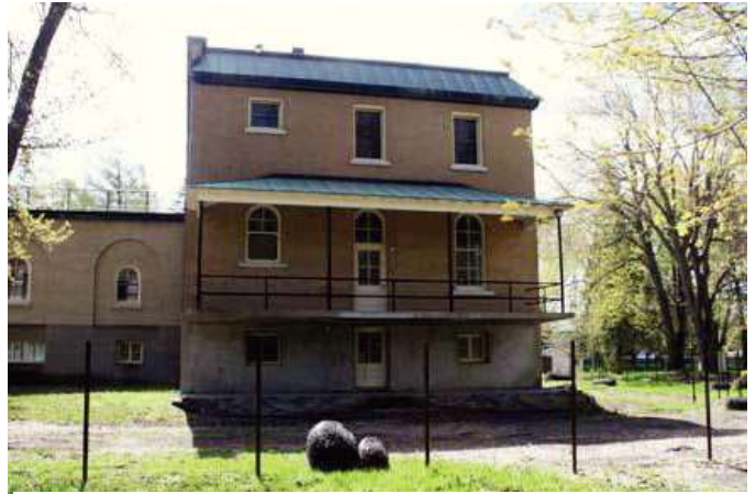
Façade nord de l'aile ouest.
