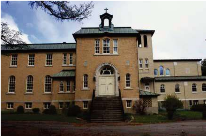
Partie de la façade avant du monastère ajoutée en 1941 pour compléter l'ensemble de l'aile principale du monastère.
