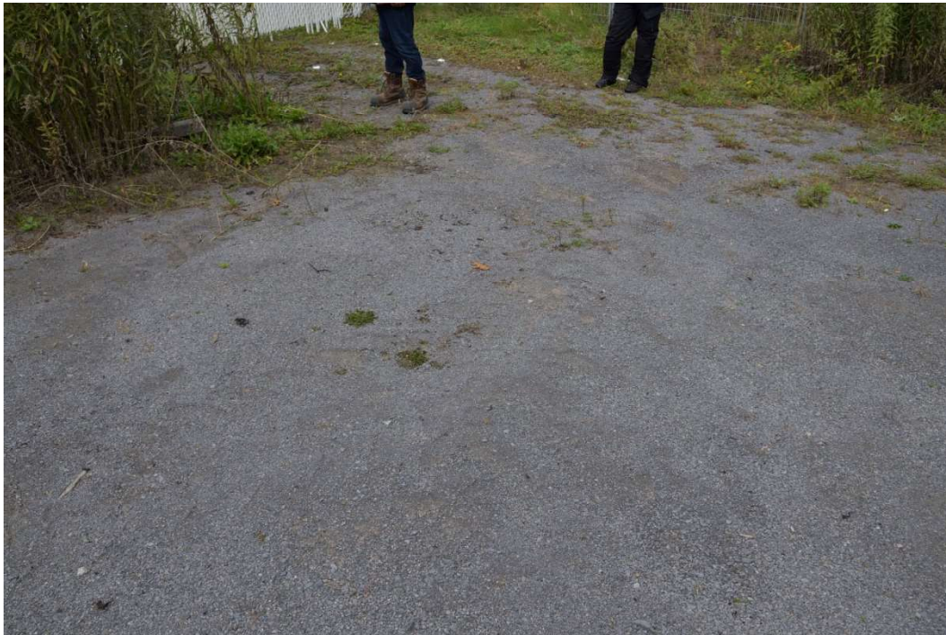
Photo 2021-05 : traces de pneus de machinerie près du coin nord-est, dans un secteur à l'intérieur de l'aire clôturée.
