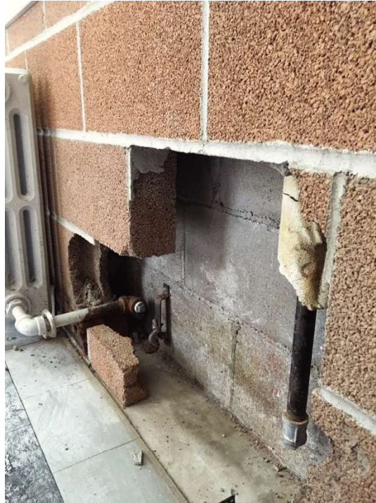
mur de l'aile de 1962 : 2 blocs de béton et un rang de brique à l'extérieur, sans isolation
