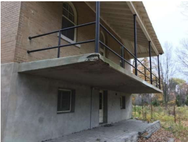
Photo 17 : Délamination du béton du balcon arrière ouest (à gauche en 2020 et à droite en 2021)
