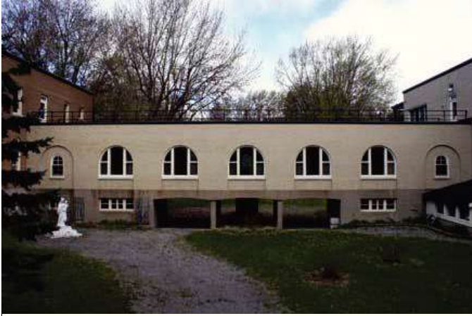
Façade sud du passage couvert donnant sur le préau.
