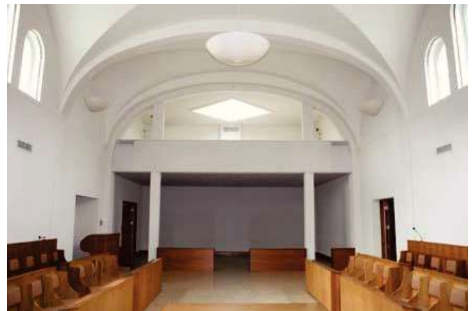
Intérieur de la chapelle actuelle. Vue vers l'ancien sanctuaire où la grille a été supprimée et où un plancher a été ajouté pour créer un jubé. 27.
