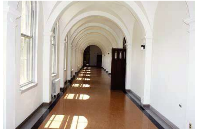
Le couloir voûté du rez-de-chaussée longeant le préau.
