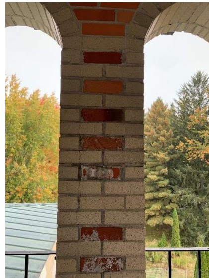
Photo 20 : Dégradation de la maçonnerie des pilastres du clocheton (à gauche en 2020 et à droite en 2021)
