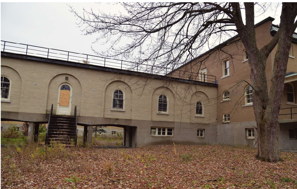
Figure 73. Porte et fenêtre ouvertes à l'arrière, BGLA
