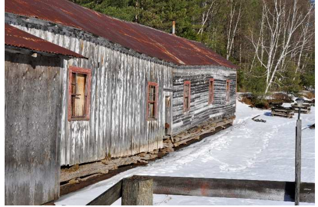
Image 2. Vue du mur gouttereau de la chalouperie-menuiserie, côté baie.
