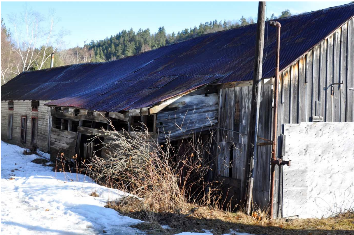
Image 17. Vue montrant l'appentis de la menuiserie (côté terre).
