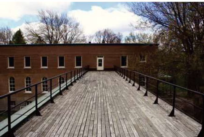
Terrasse aménagée sur le toit du passage couvert et accessible depuis les deux ailes latérales.
