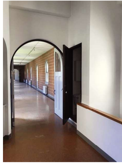
Le « pont » qui boucle le cloître en 1962 : les murs en blocs de béton, le plafond en tuiles acoustiques et les ouvertures aussi larges que hautes rompent l'harmonie et l'unité de cet espace annulaire.
