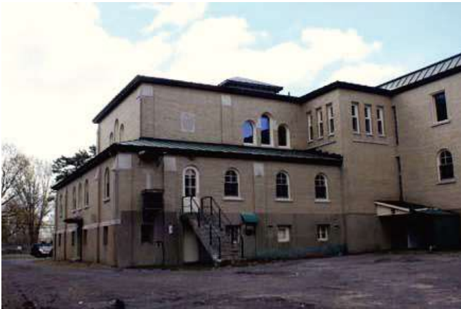
Façade nord de la chapelle construite en 1962.
