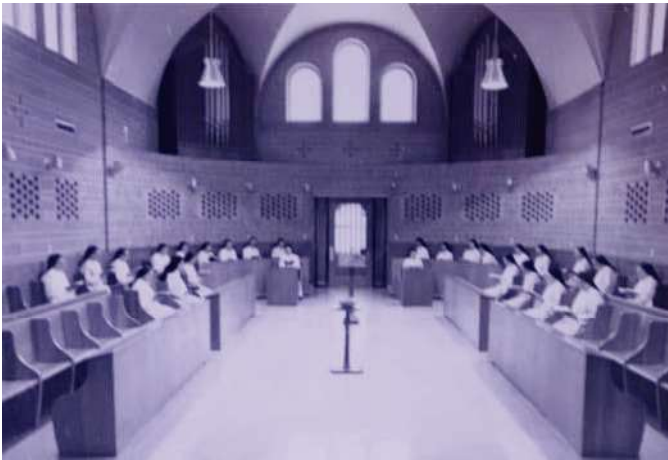
24. Aspect intérieur de la chapelle d'origine (choeur des religieuses) construite en 1962-1963. Les murs étaient alors en blocs de ciment coloré. Source : Archives du Diocèse de Trois-Rivières.
