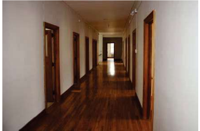
À l'étage, les cellules des religieuses sont distribuées de part et d'autre d'un couloir central. Les planchers sont en bois franc.
