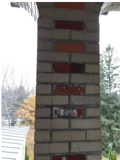
Photo 20 : Dégradation de la maçonnerie des pilastres du clocheton (à gauche en 2020 et à droite en 2021)
