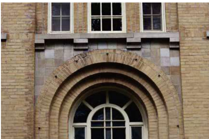
Détail du portail d'entrée principale. Les éléments en pierre seraient en calcaire de Saint-Marc-des-Carières.
