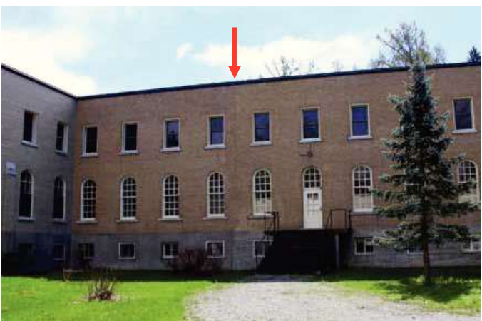
Sur la façade arrière donnant sur le préau, une démarcation subtile (sous la flèche) dans la brique et le béton témoigne de l'agrandissement de 1941.
