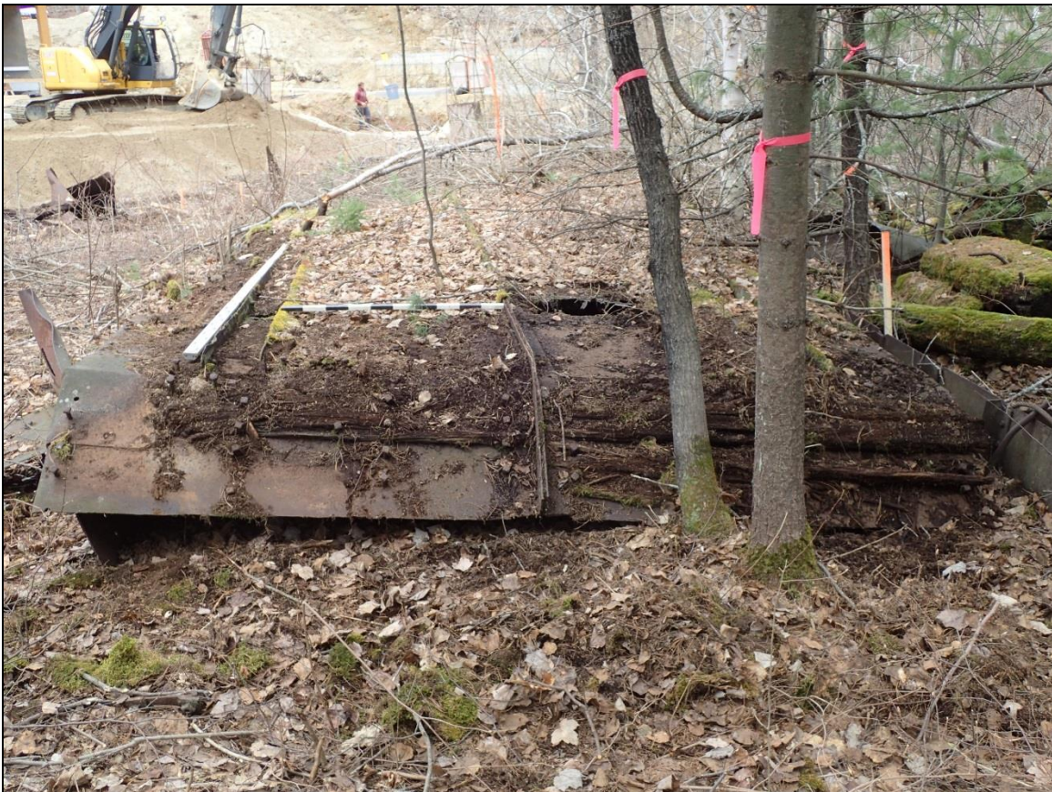
Figure 20 : Vue d'une extrémité partiellement nettoyée du chaland/scow (vues vers le nord; photo P5152806).
