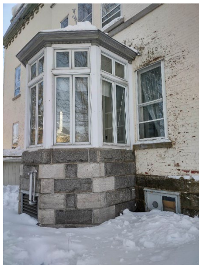
Vue des fondations du solarium
