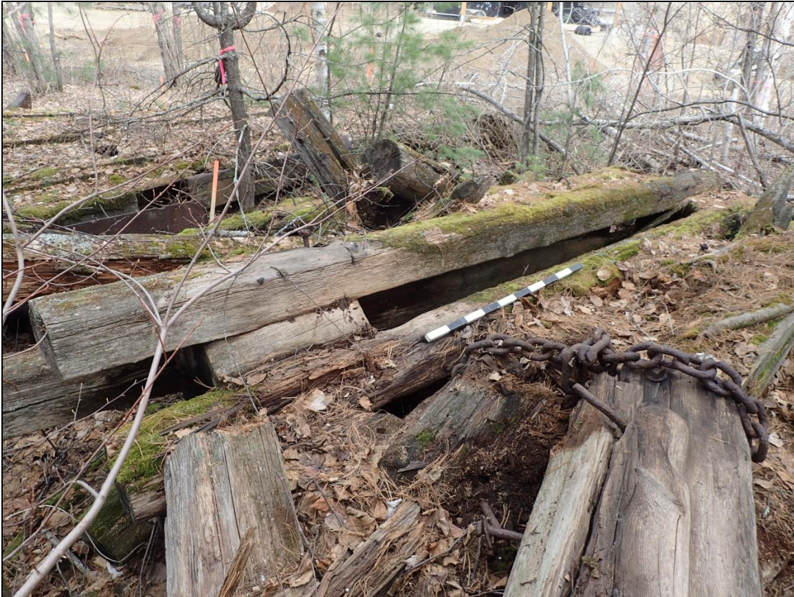
Figure 18 : Vue du premier type d'élément d'estacade gisant au sommet de l'amas de débris. La partie « femelle » se trouve à gauche (vue vers le nord; photo P5152771).
