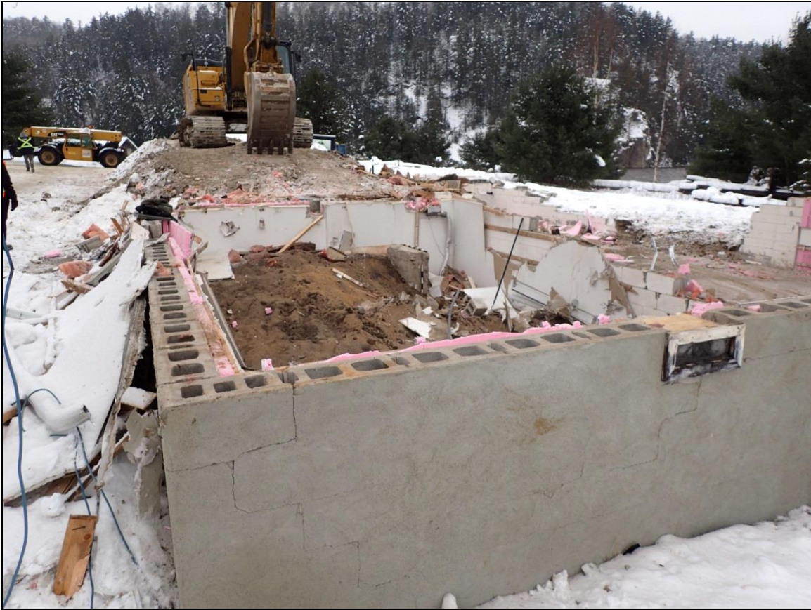
Figure 42 : Vue du vestige 5B200 lors de la démolition du bureau-entrepôt (vue vers le nord-est; photo PC132102).
