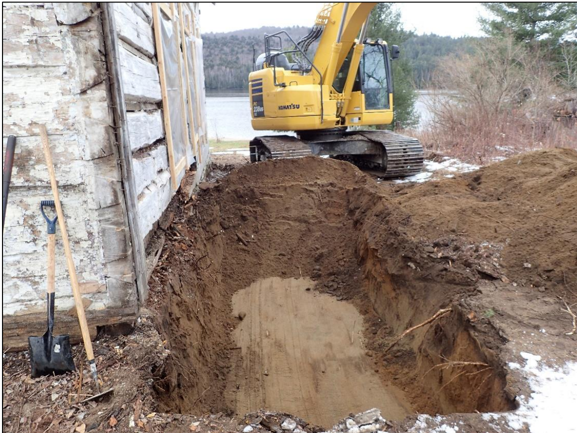
Figure 69 : Tranchée 11B excavée en supervision archéologique le long du mur ouest de l'auberge Jodoin (vue vers le sud; photo #3659).
