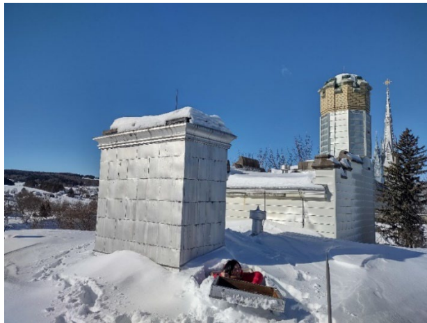
Vue générale de la cheminée centrale
