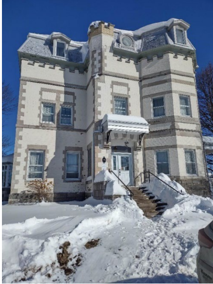
Vue générale de la façade principale
