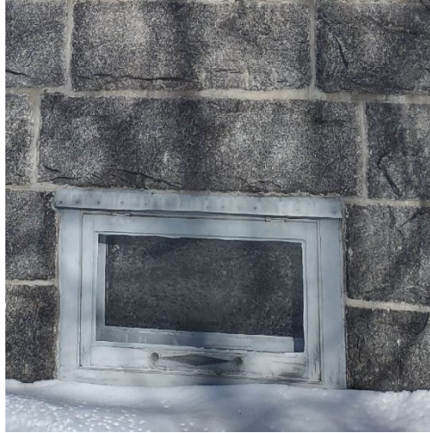
Vue extérieure d'une contrefenêtre au sous-sol
