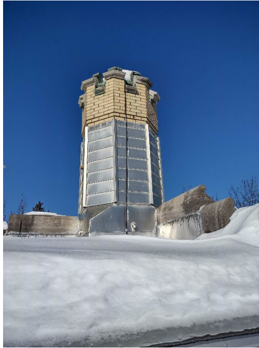
Vue générale de la cheminée ouest
