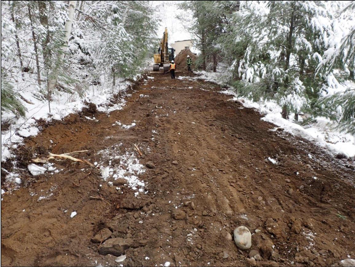
Figure 30 : Sous-opération 2B en fin d'excavation (vue vers le nord; photo PB301999).
