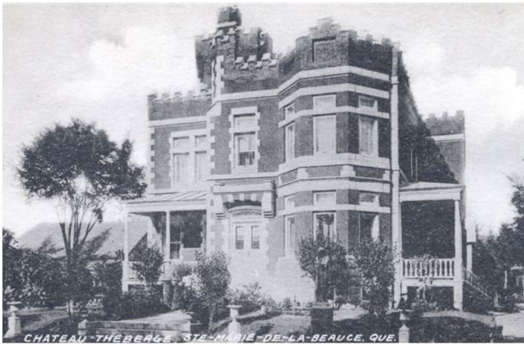
Le château Beauce vers 1930, galerie nord partiellement coupée avant l'ajout de l'étage des mansardes
