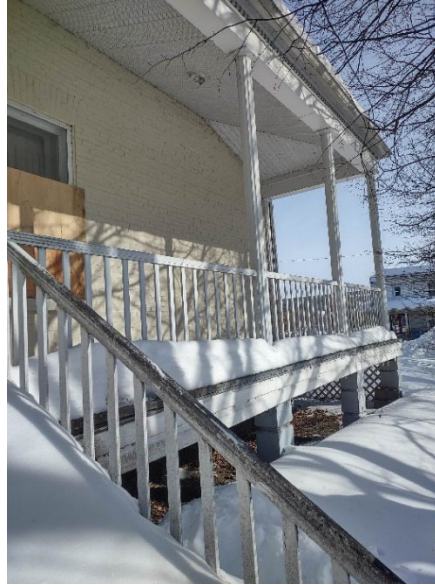
Vue partielle de la galerie
