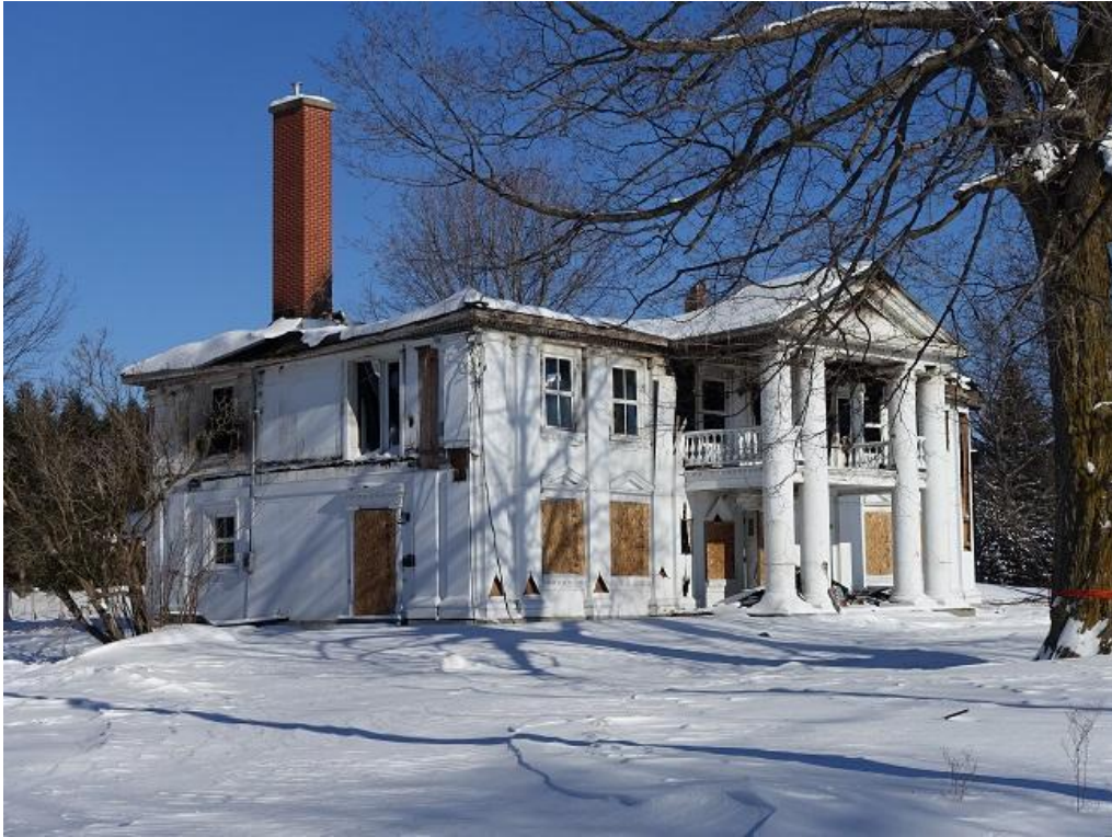
1) Manoir Taschereau après incendie vu de l'ouest.
