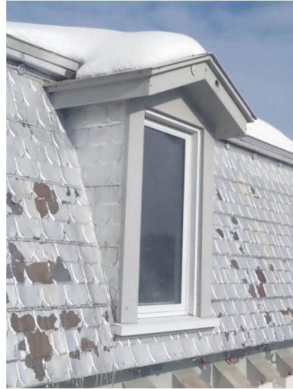
Vue extérieure d'une fenêtre d'une lucarne
