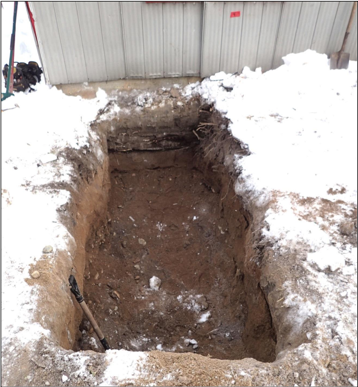
Figure 35 : Vue de la sous-opération 3D (zone 3) (vue vers l'est; photo PC102089).
