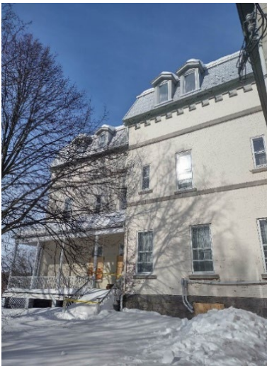
Vue générale de la façade Est
