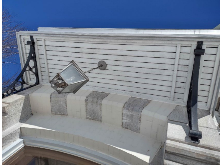
Vue du dessous de la marquise
