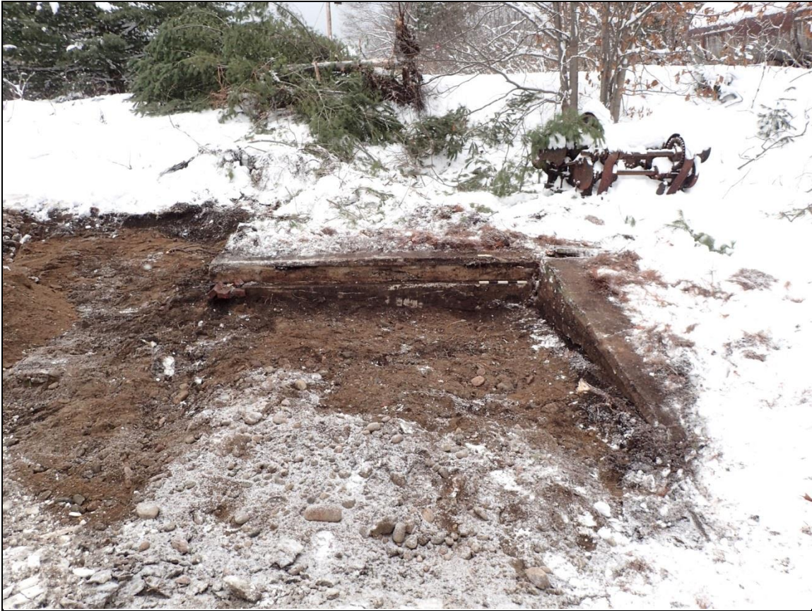
Figure 33 : Vue de la sous-opération 3C et du massif de béton soutenant le treuil à vapeur (zone 3) (vue vers l'ouest; photo PC062060).
