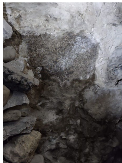
Vue intérieure du mur de fondation
