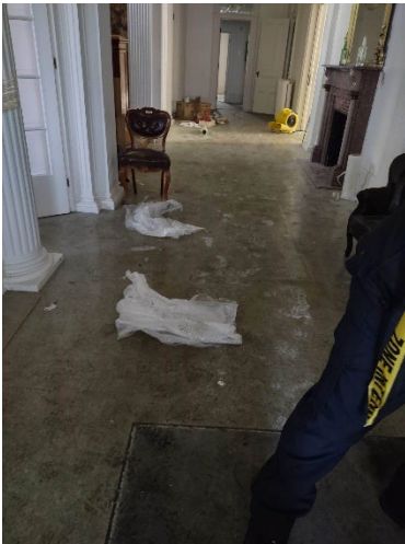
Vue générale du corridor au rdc
