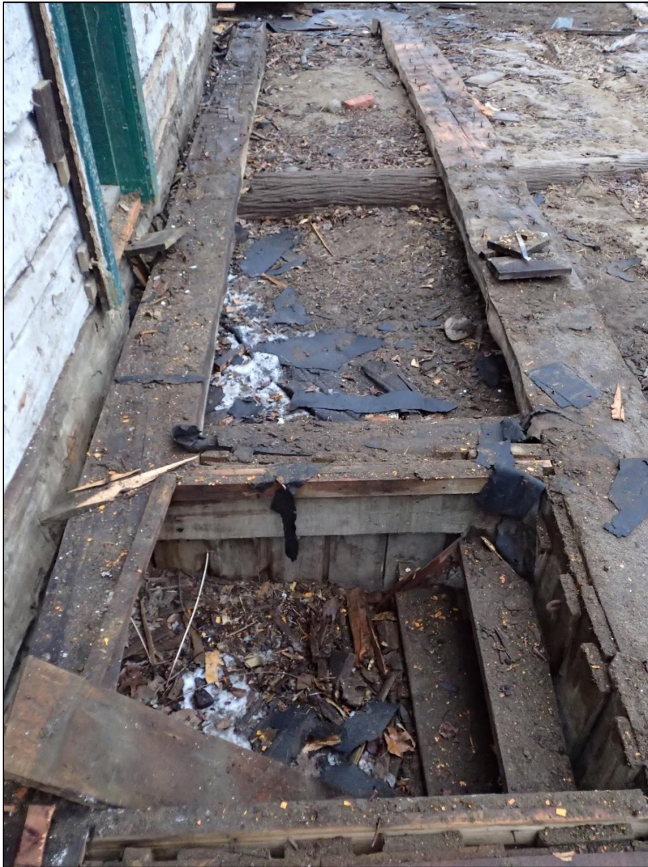
Figure 76 : Caisson en bois avec escalier aménagé sous la première rallonge de l'auberge Jodoin (vue vers l'ouest; photo #3645).
