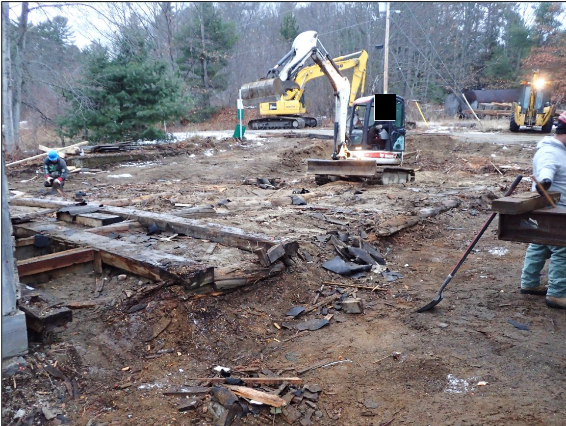
Figure 75 : Fondation de bois sous les rallonges de l'auberge Jodoin pendant qu'elles sont retirées par la machinerie lourde (vue vers le nord-ouest; photo #3639).
