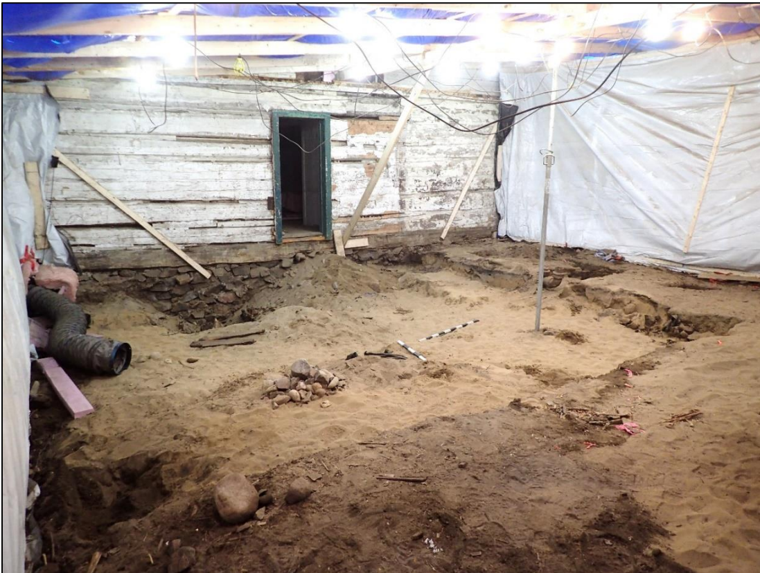
Figure 10 : Vue générale de l'aire nord en fin de fouille (vue vers le sud-ouest; photo #4093).
