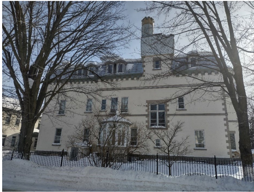
Vue générale de la façade Ouest
