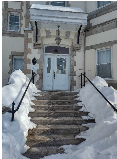
Vue de l'escalier du perron de l'entrée principale
