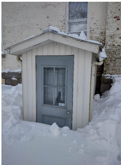
Vue générale de l'accès au sous-sol
