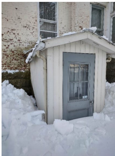
Vue générale de l'accès au sous-sol
