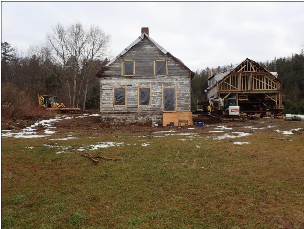
Figure 8 : Vue générale de l'aire sud pendant l'inventaire archéologique. On voit à droite les deux rallonges de l'auberge Jodoin qui ont été déplacées (vue vers le nord; photo #3656).
