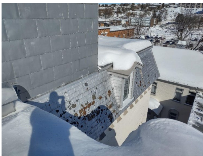
Vue d'une section de toiture en mansarde et exemple de tôle à repeindre
