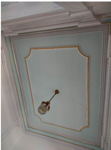
Exemple d'un plafond en plâtre
