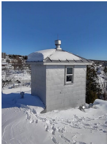
Vue du cabanon d'ascenseur
