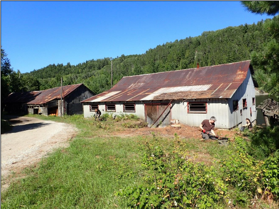
Figure 31 : Vue de la zone 3, ainsi que de l'atelier de mécanique et de forge (à droite) et de l'atelier de menuiserie et chalouperie (à gauche) (vue vers le nord-est; photo P9060041).
