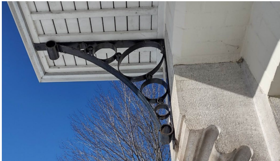
Vue agrandie d'une équerre de la marquise
