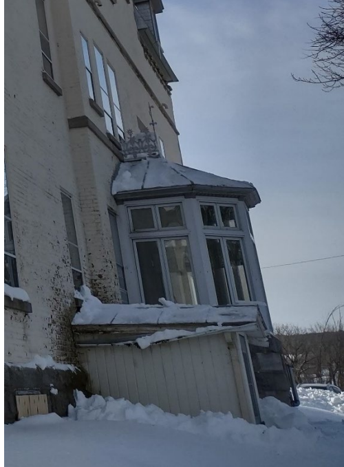
Vue de la toiture du solarium
