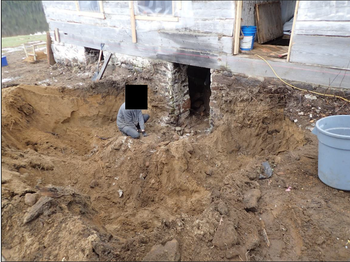
Figure 74 : Détail de la fondation est de l'auberge Jodoin exposée après l'excavation à la pelle mécanique de la tranchée 11B. On voit les restes de l'entrée de cave maçonnée ayant été détruite en notre absence (vue vers le sud-ouest; photo #3667).
