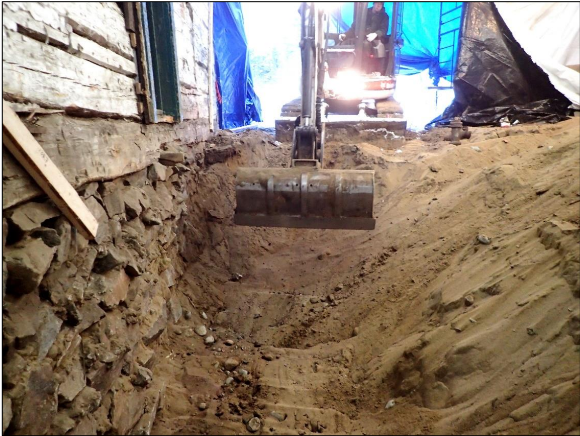
Figure 70 : Tranchée 11B excavée en supervision archéologique le long du mur nord de l'auberge Jodoin, après la fin de la fouille préhistorique (vue vers le sud; photo #3659).
