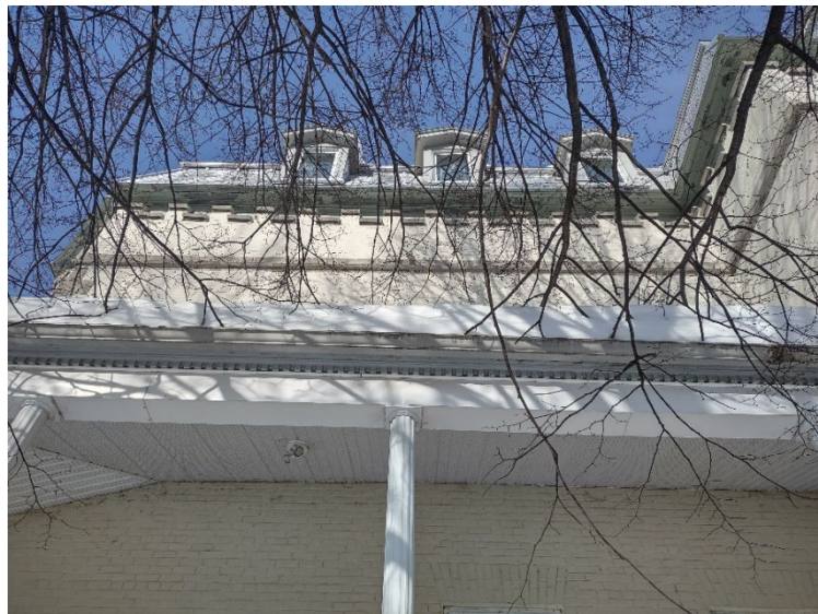
Vue partielle de la toiture de la galerie
