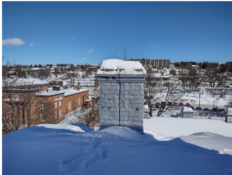
Vue générale de la cheminée nord
