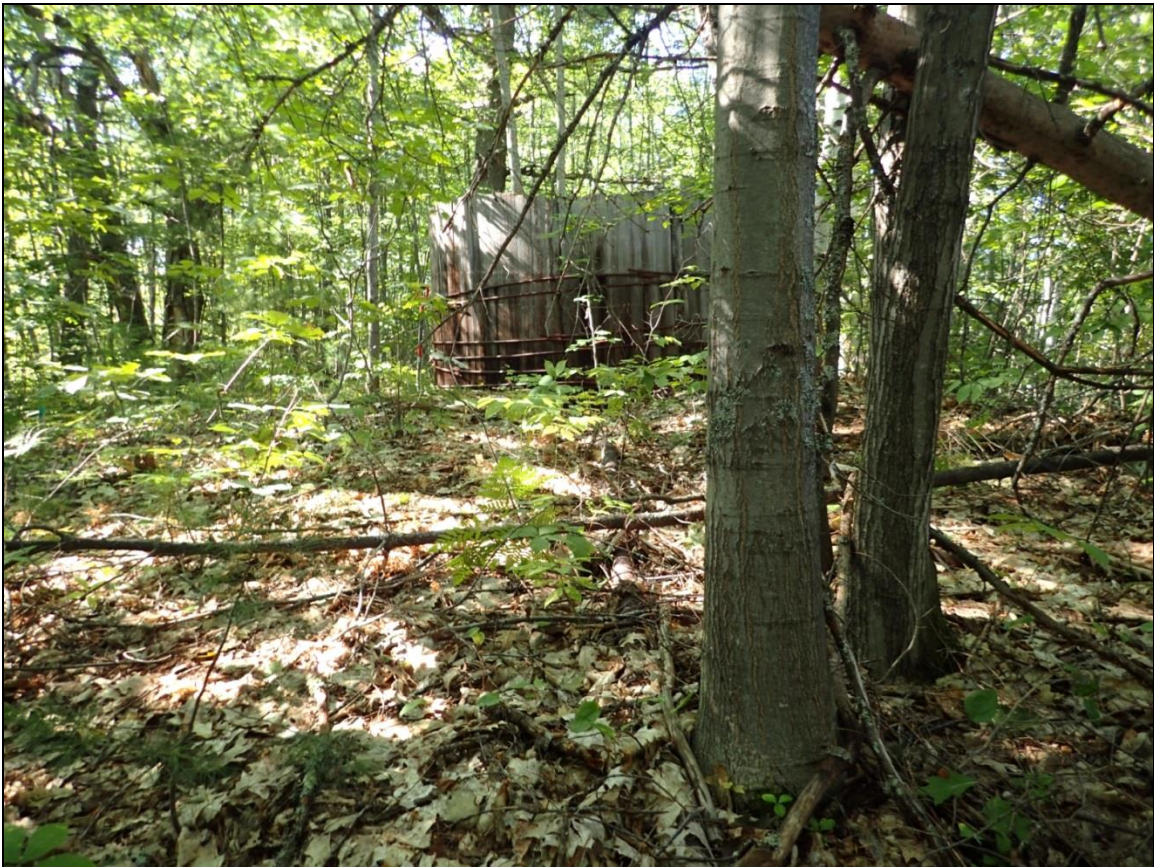
Figure 37 : Vue de la zone 4 avec le château d'eau en arrière-plan (vue vers le nord; photo P9060048).
