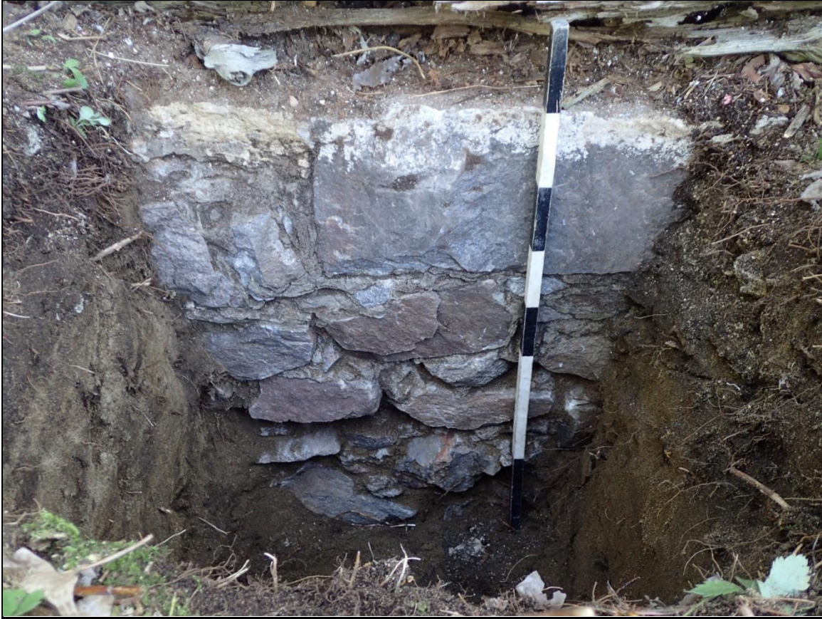
Figure 43 : Fondation de l'auberge Jodoin dans le sondage 166 (vue vers l'ouest; photo P9080081).
