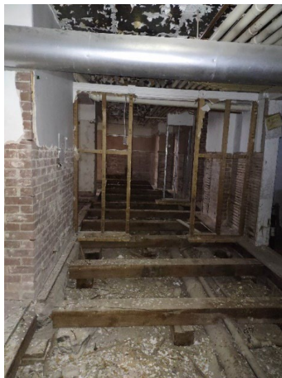
Vue partielle du sous-sol
