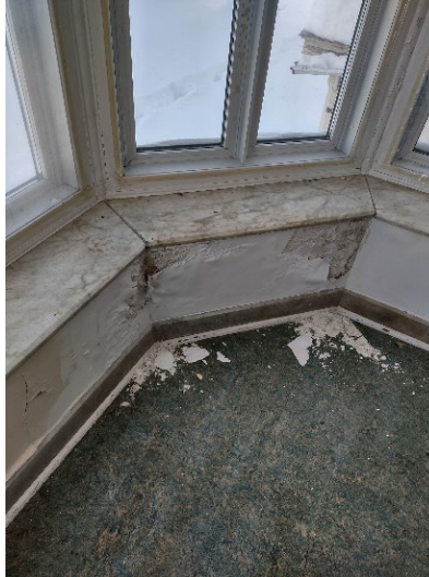
Vue partielle du solarium
