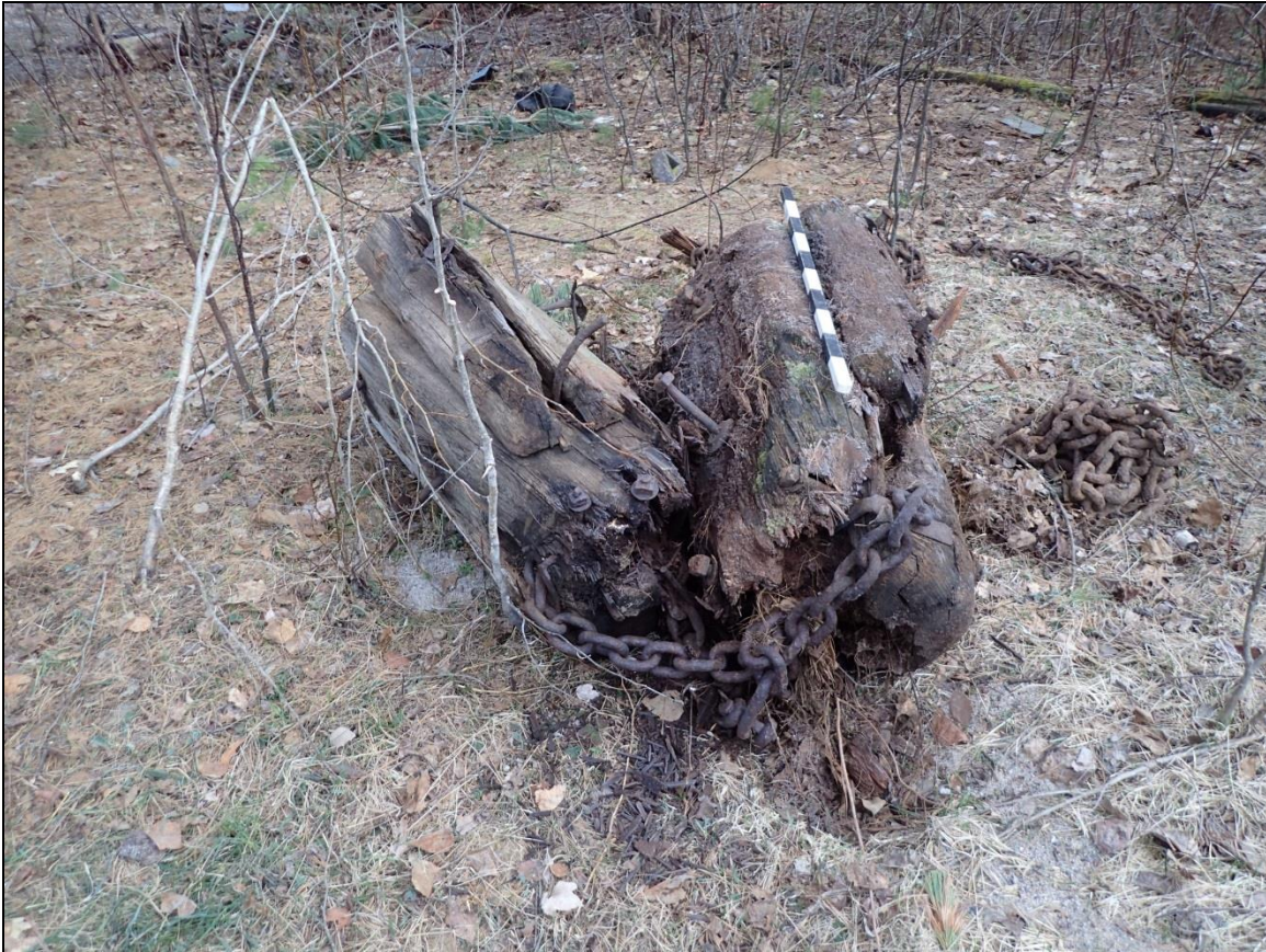
Figure 19 : Deux fragments d'éléments d'estacades du troisième type encore rattachés l'un à l'autre par une chaîne. On voit aussi à côté plusieurs chaînes récupérées de l'amas de débris (vue vers l'est; photo P5162834).
