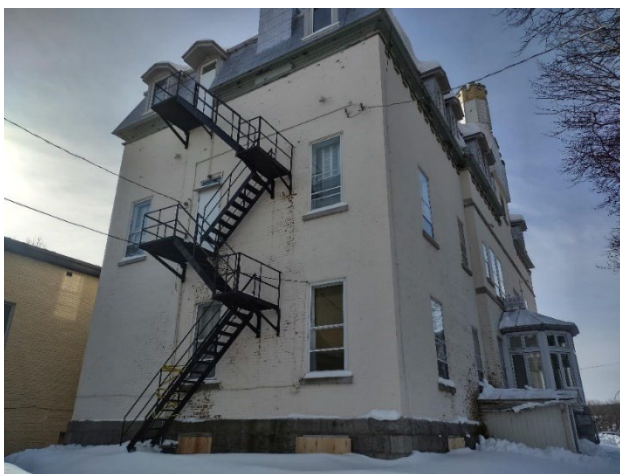
Vue générale de la façade nord
