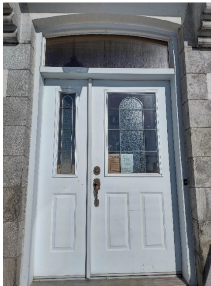
Vue générale de la porte principale
