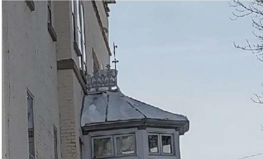
Vue agrandie de la crête de faitage
