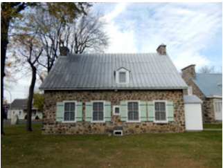
Maison Marie-Rose-Durocher. Vue frontale de la façade arrière
