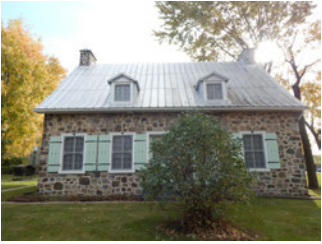
Maison Marie-Rose-Durocher. Vue frontale de la façade
