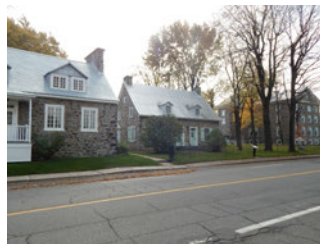
Maison Marie-Rose-Durocher. Vue d'ensemble à l'approche du bâtiment
