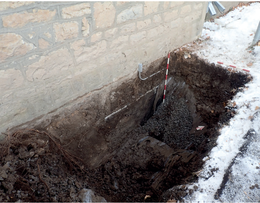
Photo 4.25 remblaiement d'excavation récente (2021) à l'emplacement de la sous-opération 3D, BjFI-3 (PATR22N13-0109).
