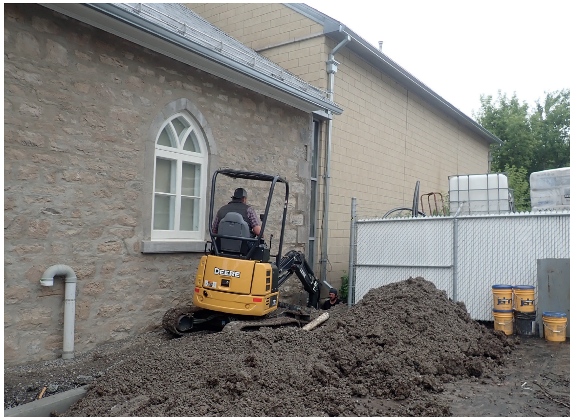
Photo 4.24 Emplacement de la sous- opération 3D, vue vers le nord-ouest, BjFI-3 (PATR22N13-0386).
