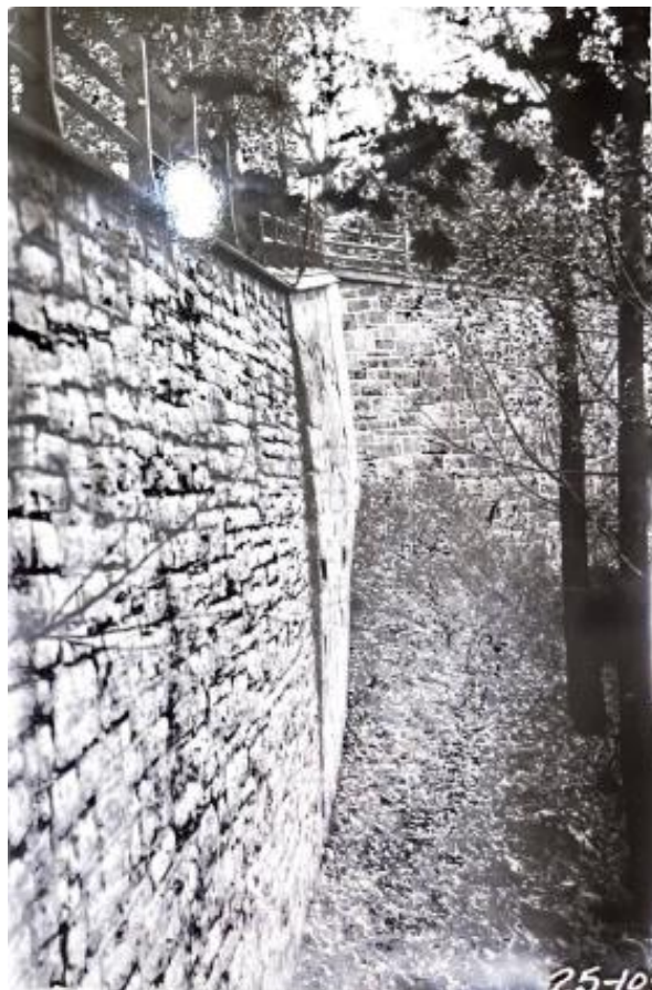
Figure 40 MURS DE SOUTÈNEMENT, RUE MONT-CARMEL, MURS A ET B, 1925 (CENTRE DE DOCUMENTATION DE PARCS CANADA CARTABLE 106/12 COTE IC-105).
