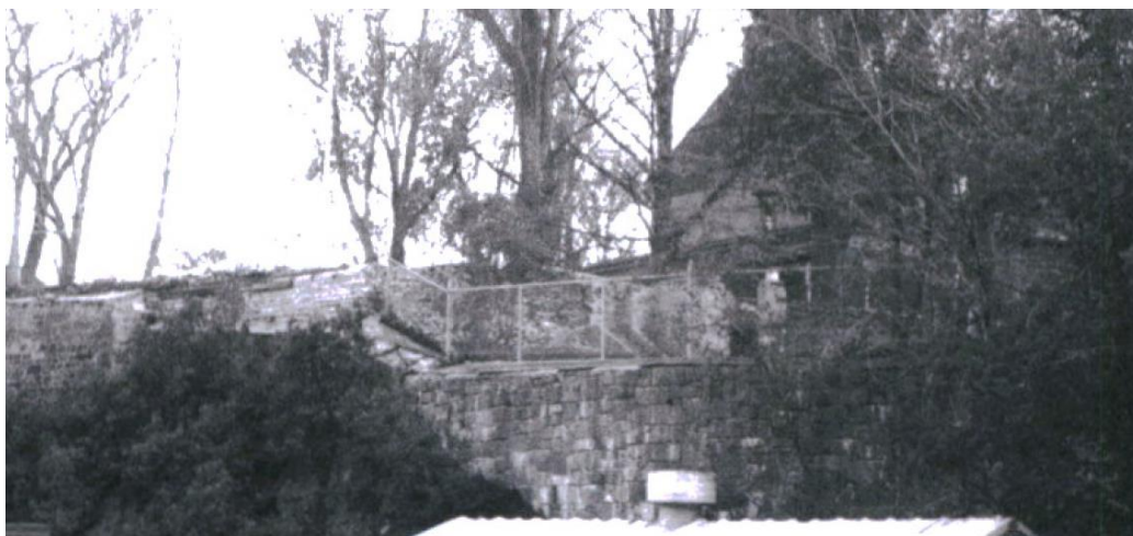
Figure 45 MURS DE SOUTÈNEMENT ET MUR MITOYEN, MURS F, G, H, I, J ET K (MAC, 1970).
