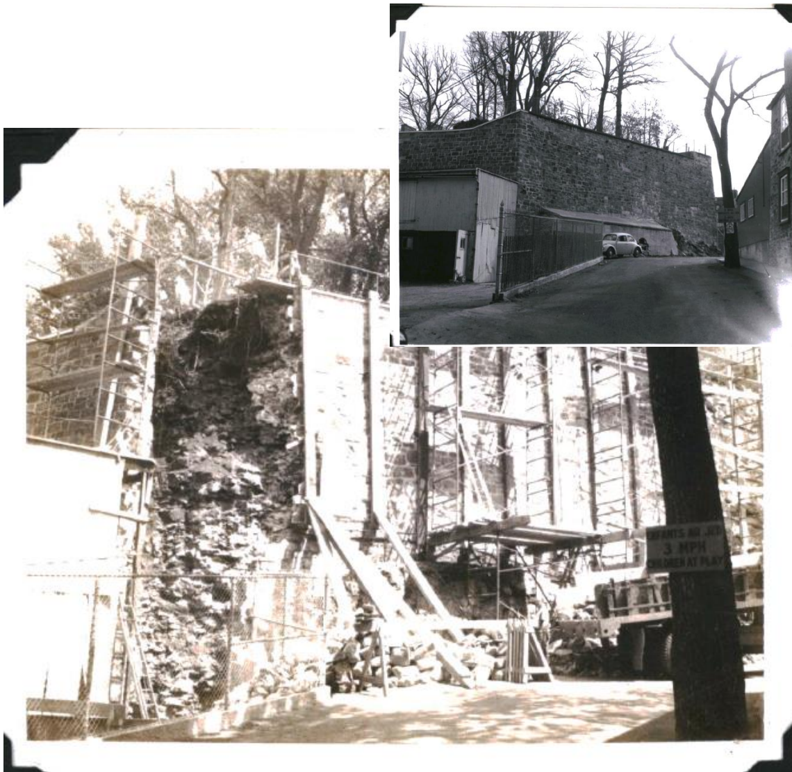
Figure 44 RÉFECTION DES MURS DE SOUTÈNEMENT, MURS D ET E, AVANT ET PENDANT LES TRAVAUX (MAC, 1970).
