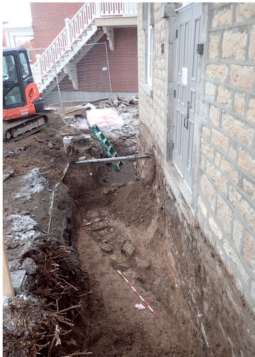
Photo 4.4 Vestige 3B103 situé devant la porte de l'église vue vers l'ouest, BjFI-3 (PATR22N13-0075).
