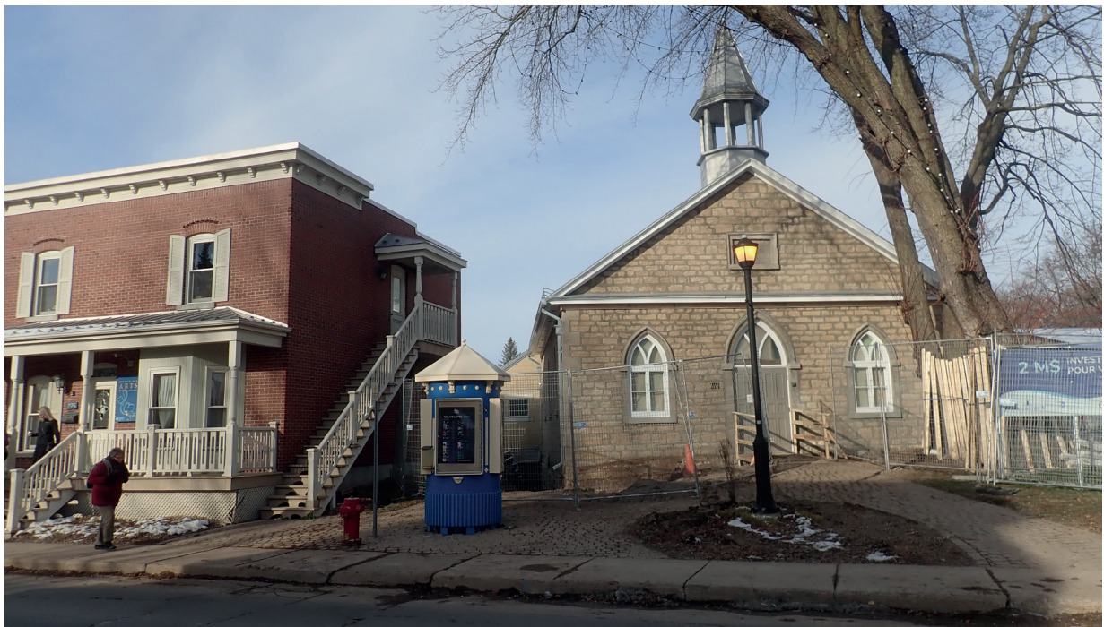
Photo 1.1 Vue générale du chantier autour de l'église et la Maison Lavigne-Richer , BjFI-3 ( PATR22N13-0375 ).
