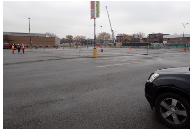
Photo 3.1 Stationnement du centre commercial Le Boulevard au début des travaux. Vue vers le sud-ouest (photo PATR22N20_0002).
