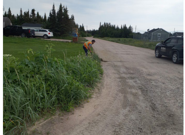
Figure 15 : Secteur 14, section aménagée, vers l'est
