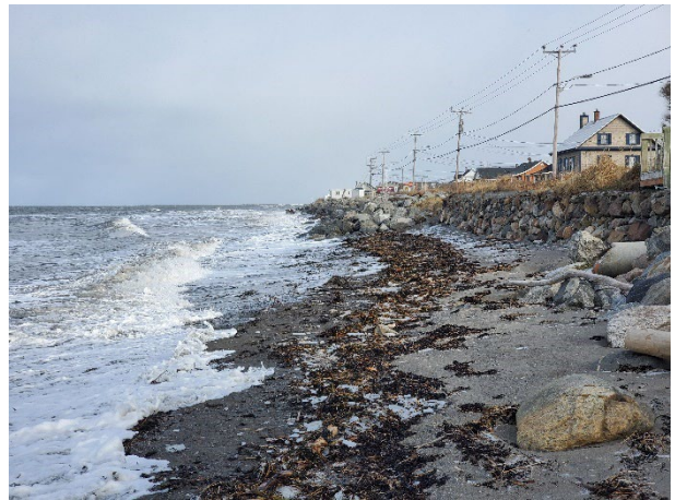
Figure 22 : Zone 18 – vue générale, vers le nord-est
