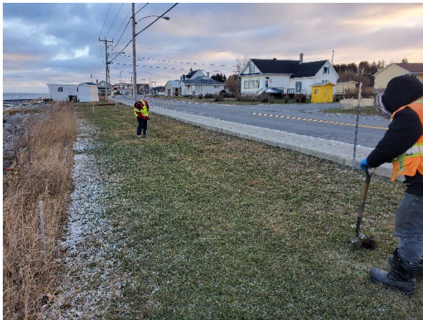
Figure 18 : Zone 13 – vue générale, vers le nord-est
