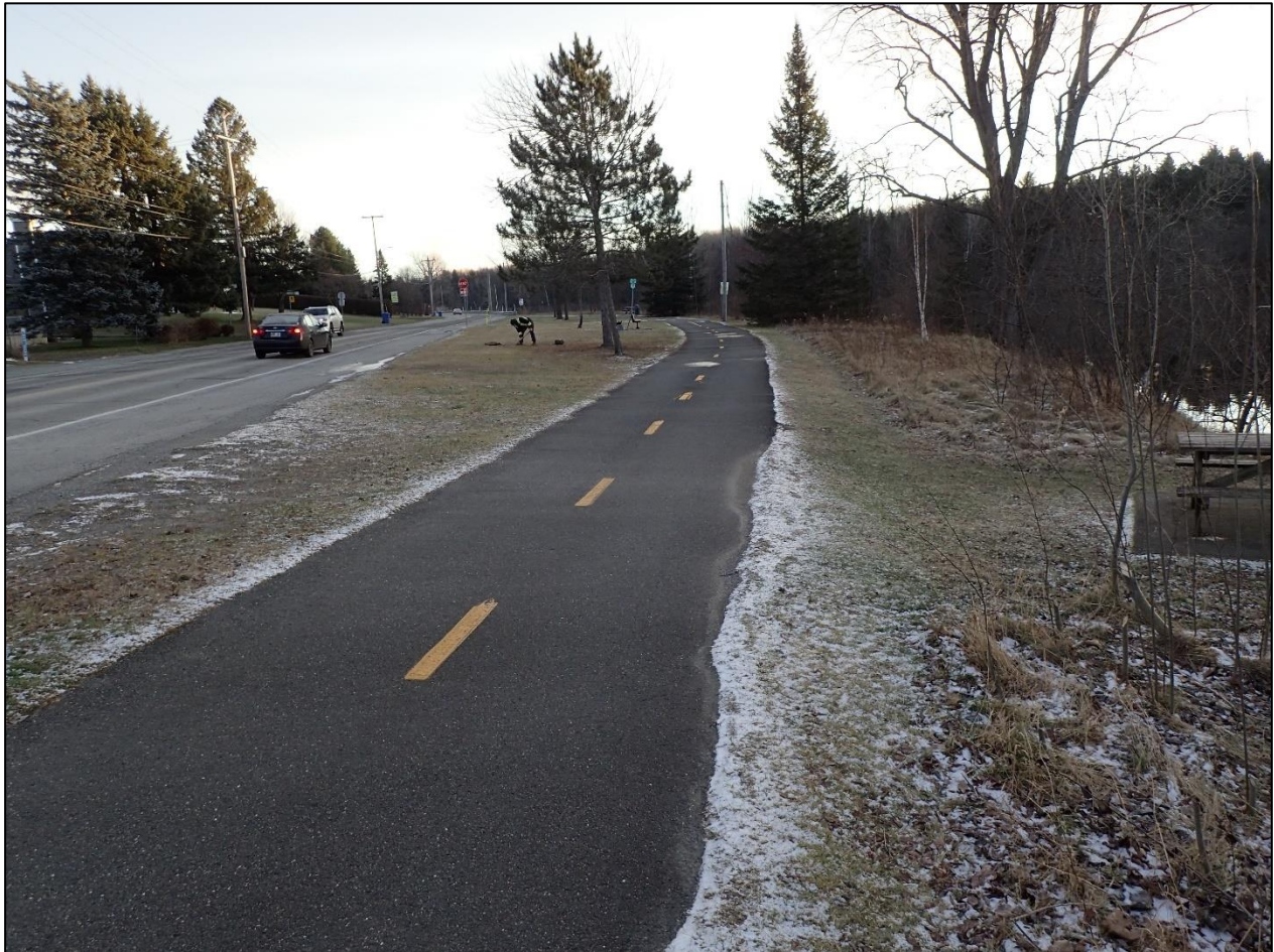
Figure 6 : Vue du secteur 1 depuis son extrémité ouest (photo 4781; vue vers l'est).
