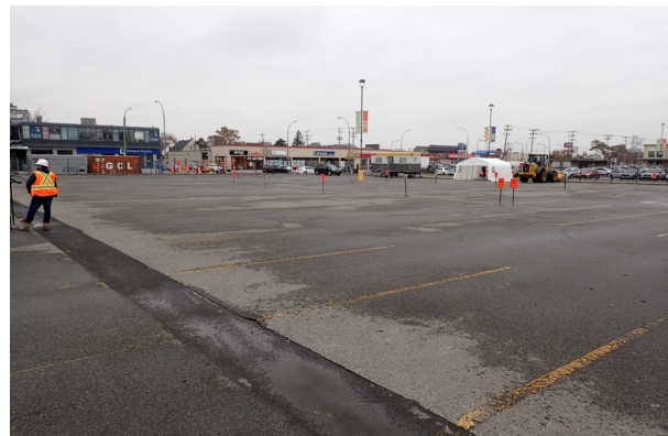
Photo 3.2 Stationnement du centre commercial Le Boulevard au début des travaux. Vue vers le nord-est (photo PATR22N20_0006).
