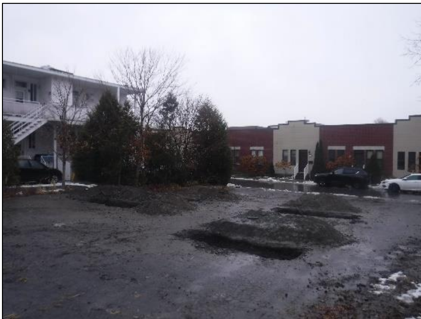
Figure 8 : Sous-opérations 3A, 3B, 3C et 3D à la fin des travaux (photo 1738.jpg)
