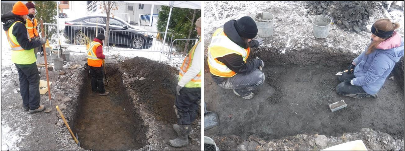
Figure 6 : Fouille manuelle des tranchées
