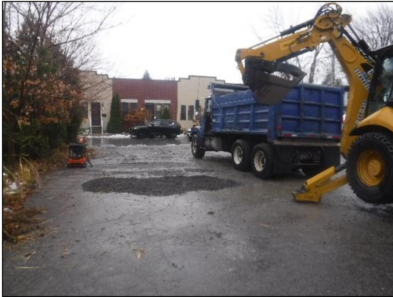
Figure 9 : Remblayage et remise en état du terrain à la fin des travaux (photo 1749.jpg)
