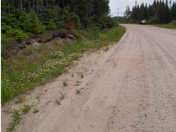
Figure 14 : Secteur 14, section non aménagée avec arasement important, vers le sud
