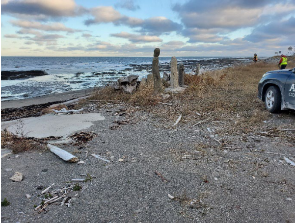
Figure 20: Zone 16 – vue générale, vers le nord-est
