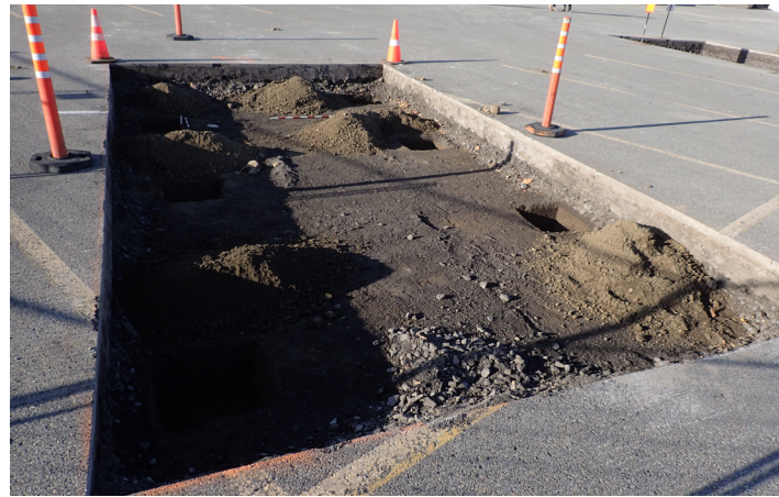
Photo 4.15 Sondages de l'opération 3, vue vers l'ouest (photo PATR22N20_0064).
