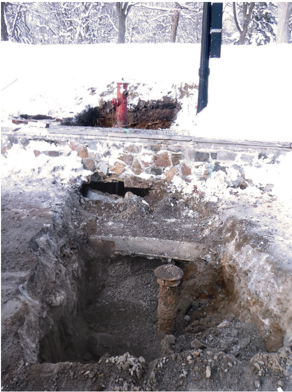
Photo 6 - Tranchées 2A et 2B en fin d'excavation – Vue vers le nord (MTL20-25-08-N2-052)
