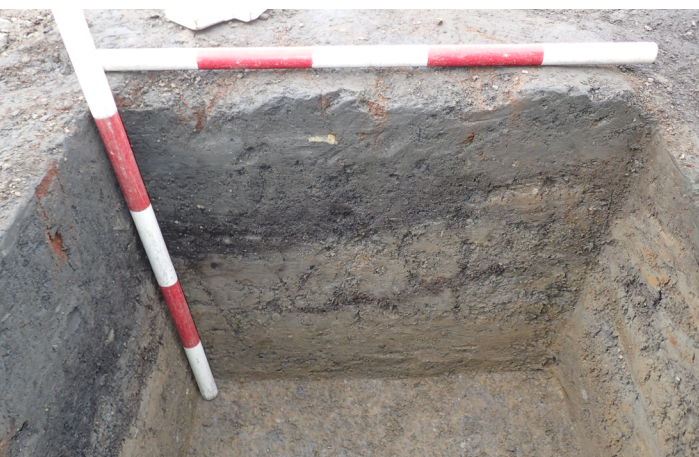
Photo 4.24 Sondage 9E, paroi nord (photo PATR22N20_0165).
