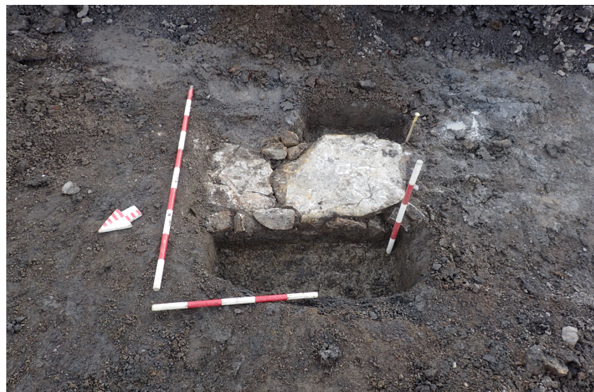
Photo 4.30 Parement nord du vestige 10A100 dans 10K, vue vers le sud (photo PATR22N20_0255).
