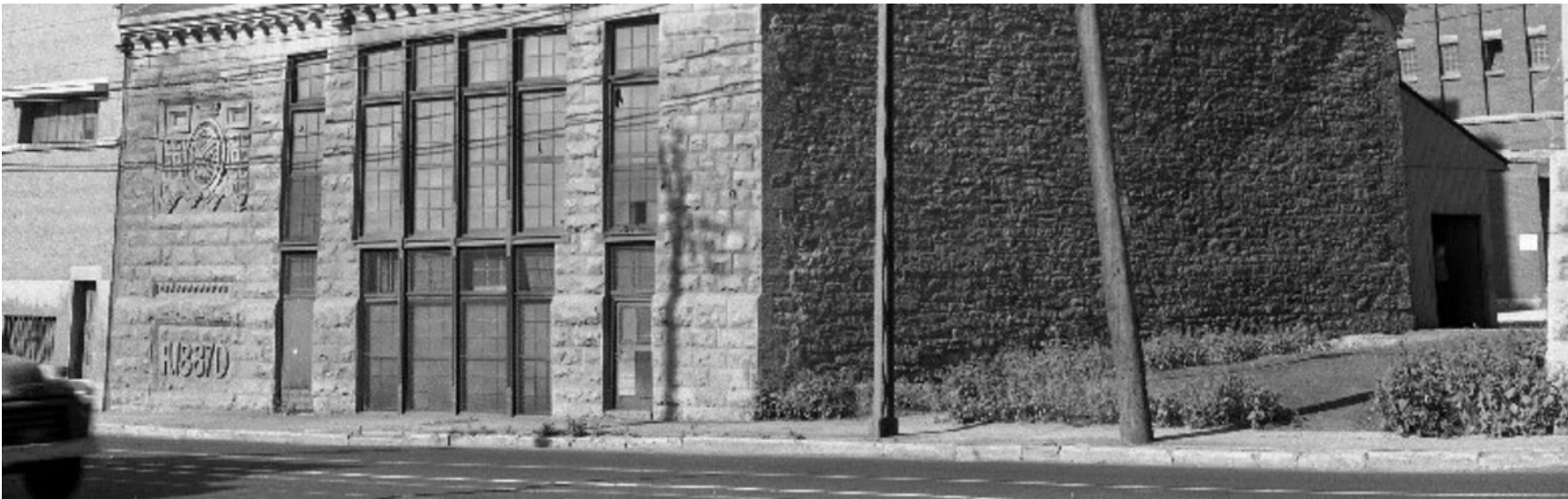
La station de pompage Craig vers 1930. Elle est toujours située sous le pont Jacques-Cartier. Photo: Gracieuseté, AmiEs de la Craig
