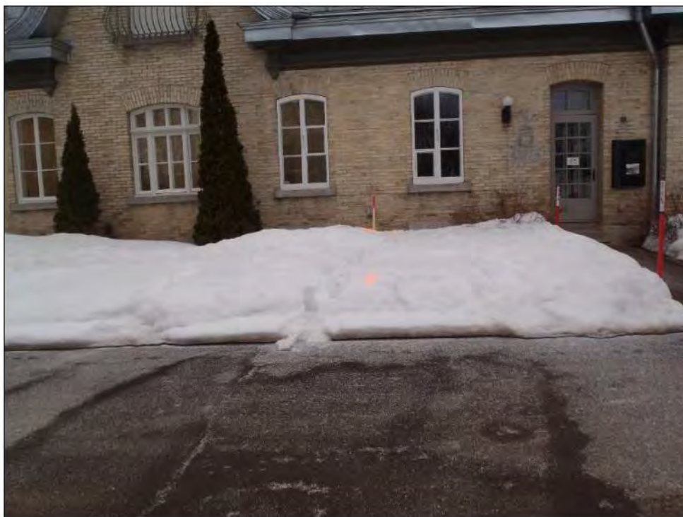
Photo 4. Vue d'ensemble de la sous-opération CeEt-806-24B, vers le nord-ouest (CeEt-806-2023-24-005)
