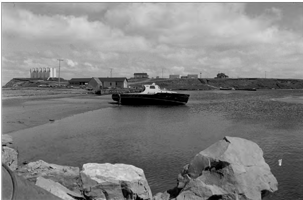
Figure 35. Vue de la partie est de La Grave en 1977 (source : BANQ, 510142).
