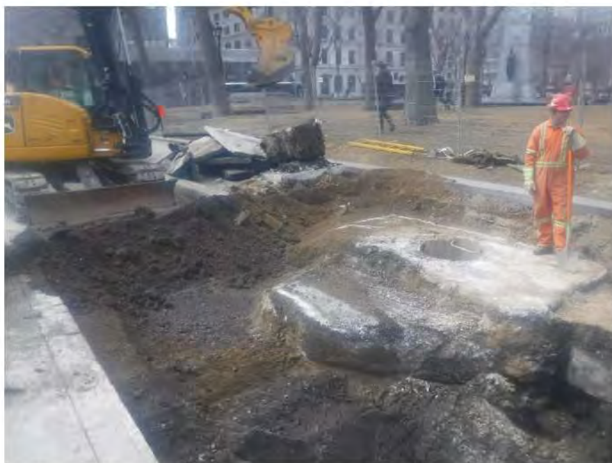
Photo 1. Vue au début des travaux du puits d'accès 7APA5 à reconstruire. Vue vers le nord-ouest (BiFj-37-2023-NUM1-16)
