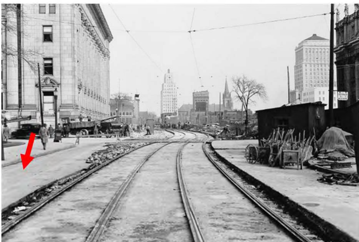
Figure 23. Vue de la pose des nouveaux rails de tramway sur la rue Dorchester, prise en 1931 (Musée Mc Cord MP-1999.6.49) et localisation approximative de l'aire d'intervention (flèche rouge).
