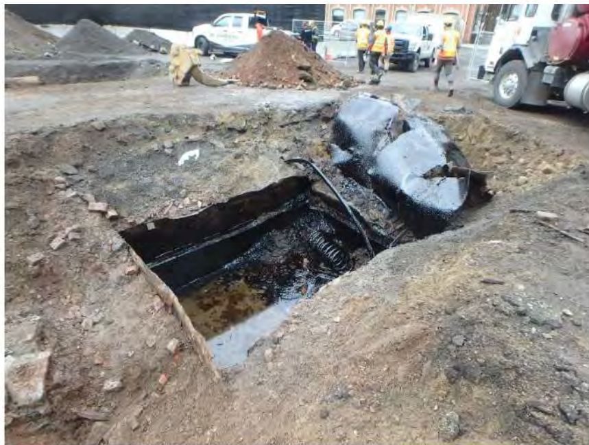
Photo 17. Vue vers le nord-ouest d'un réservoir de combustible de soute dans la sous-opération CeEt-821-2A (CeEt-821-23-NUM1-9)
