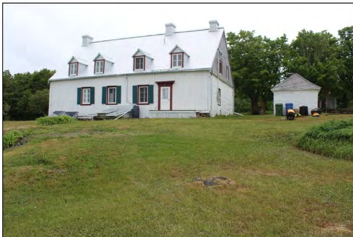
Photo 14 : Vue générale de l'arrière de la maison Casault (opération 3). Vue vers le nord. (TE-1053-102)
