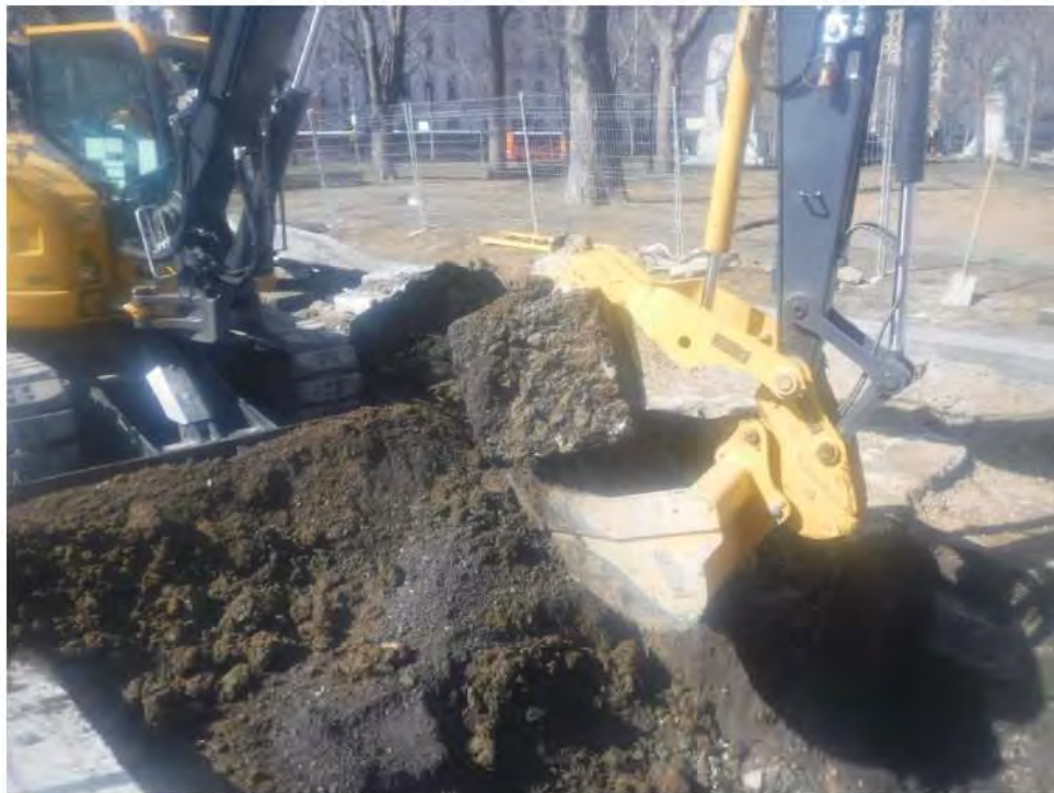
Photo 16. Vue d'une base de lampadaire (34A2) désaffectée en cours de démantèlement. Vue vers le nord-ouest (Bifj-37-2023-NUM1-11)
