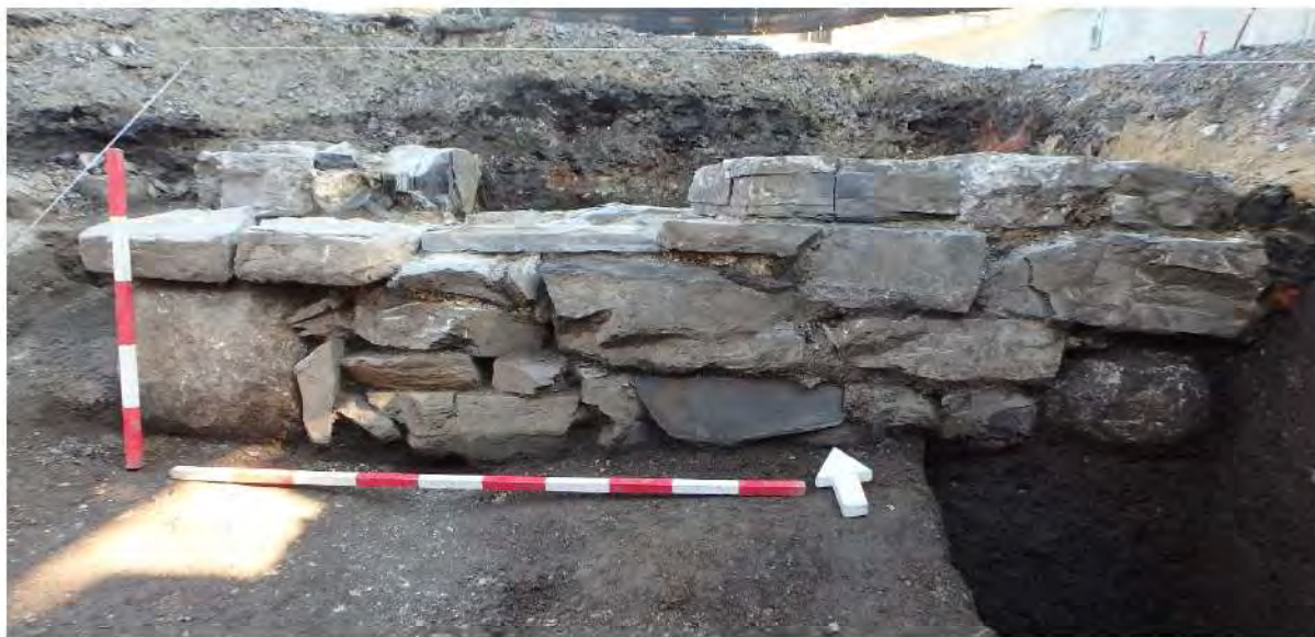
Photo 50. Vue vers le nord du parement sud du vestige CeEt-833-2A6 (CeEt-833-23- NUM2-92)
