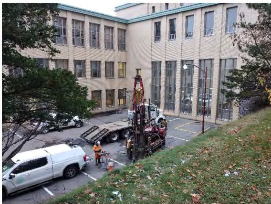
Photo 1. Vue générale du stationnement sud-ouest et forage 2L en cours de réalisation, vers le nord-est (MTL23-04-05-2-NUM1-73).
