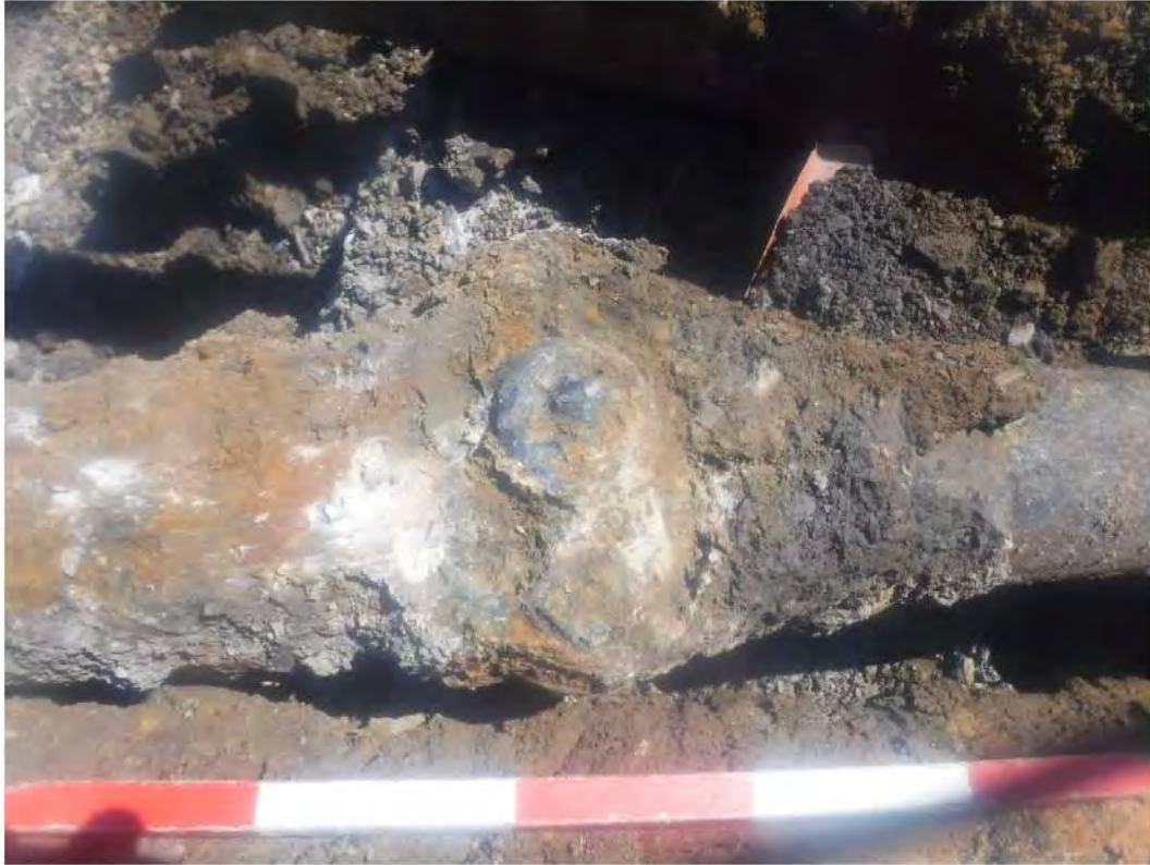
Photo 18. Vue détaillée de la conduite de gaz abandonnée après son démantèlement (34A5) (BiFi-37-2023-NUM1-30)
