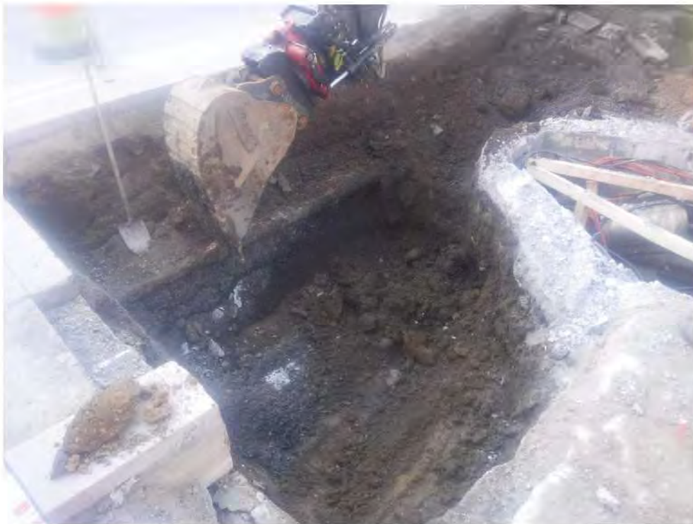
Photo 17. Vue de la conduite de gaz abandonnée (34A5) en cours de dégagement mécanique. Vue vers le sud-ouest (Bifj-37-2023-NUM1-25)
