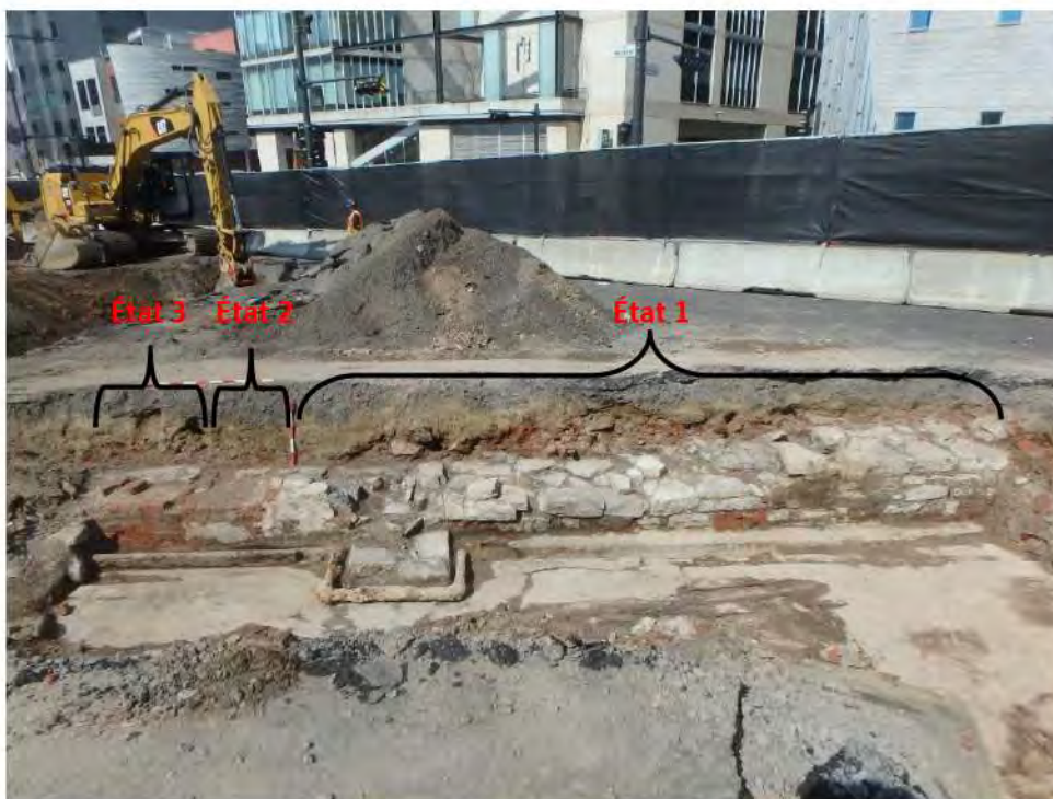
Photo 8. Vue vers le nord-est des murs 4B14 et 4B15, ainsi que du tuyau 4B12 et de la dalle de béton 4B13 (CeEt-820-23-NUM1-17)
