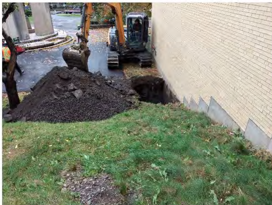
Photo 7. Localisation de la tranchée d'exploration 2A, vue vers le nord (MTL23-04-05-2-NUM1-21).
