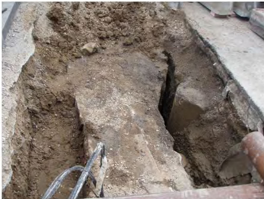
Photo 19. Vue des massifs de béton 34A3 et 34A4 avant leur démolition et du puisard de trottoir abandonné 34A11 avant son démantèlement. Vue vers l'est-sud-est (BiFj-37-2023-NUM3-67).
