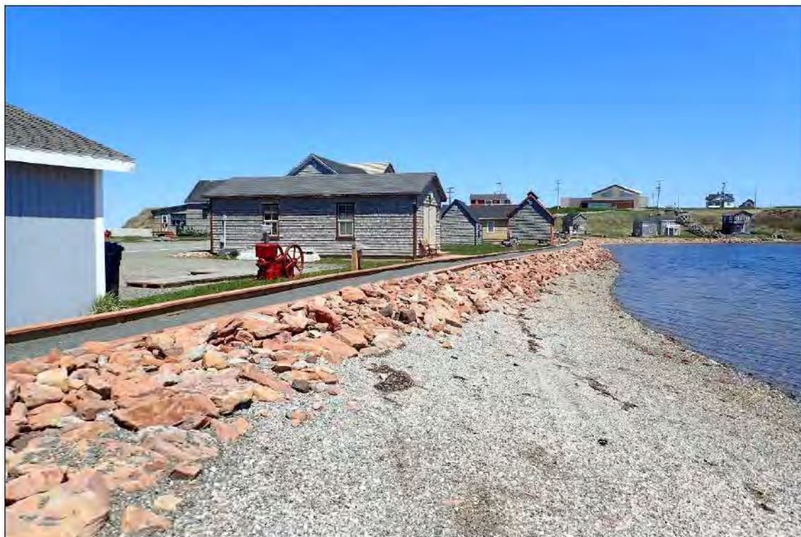
Figure 15. Sentier du côté est de la sous-opération 4A, vers l'est (photo P5230097).
