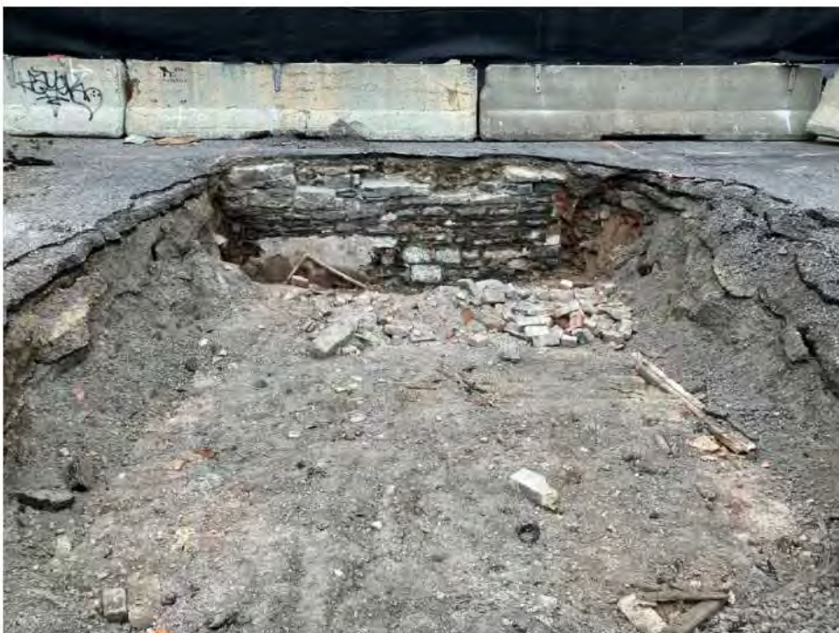
Photo 31. Vue vers le sud de la sous-opération CeEt-826-2B (CeEt-826-23-NUM3-5)
