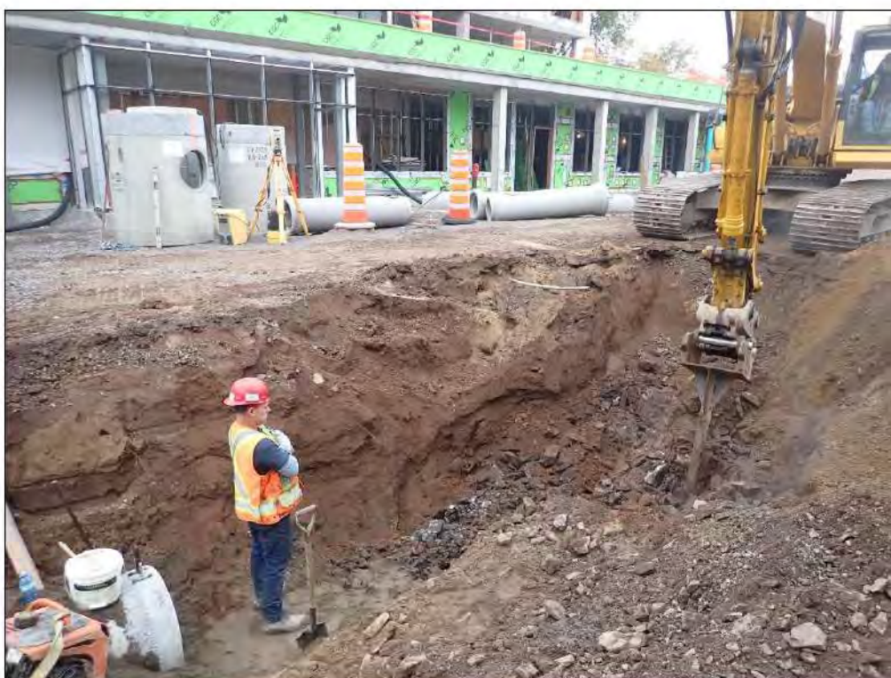
Figure 11. Excavations en cours de la sous-opération 1F et sols en place, vers le nord-est (photo 180008).
