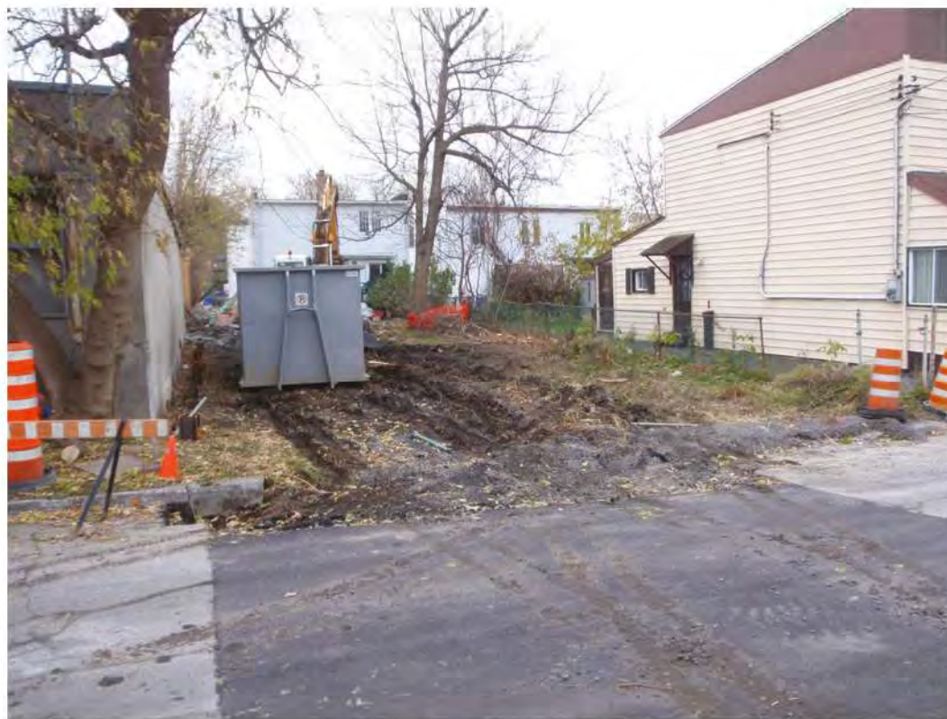
Photo 1.1 Vue générale du 17B Saint-Joachim avant les travaux d'excavation PCS10, OP8_N1_0024, Archéotec inc.
