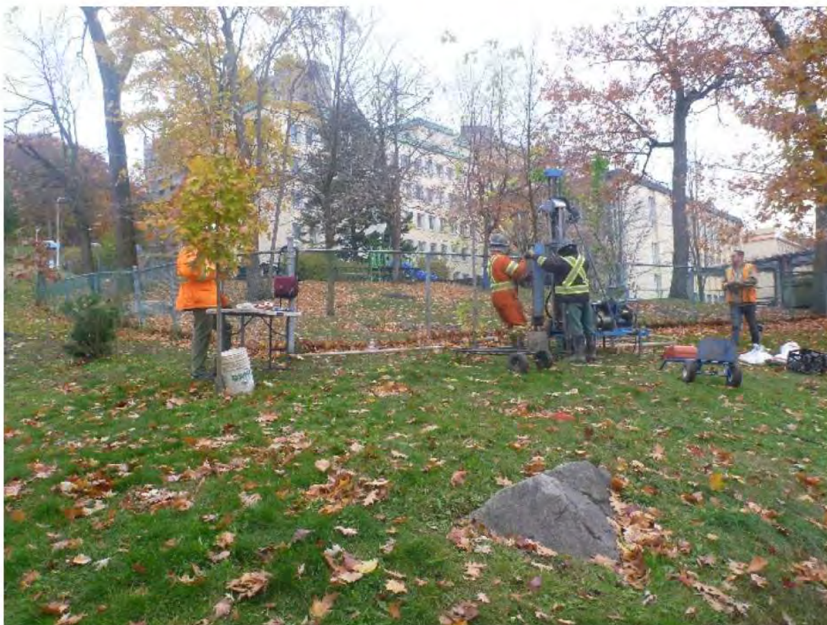
Photo 9. Vue générale du stationnement sud-ouest et forage 2S en cours de réalisation, vers le sud-ouest (MTL23-04-05-2-NUM2-04)
