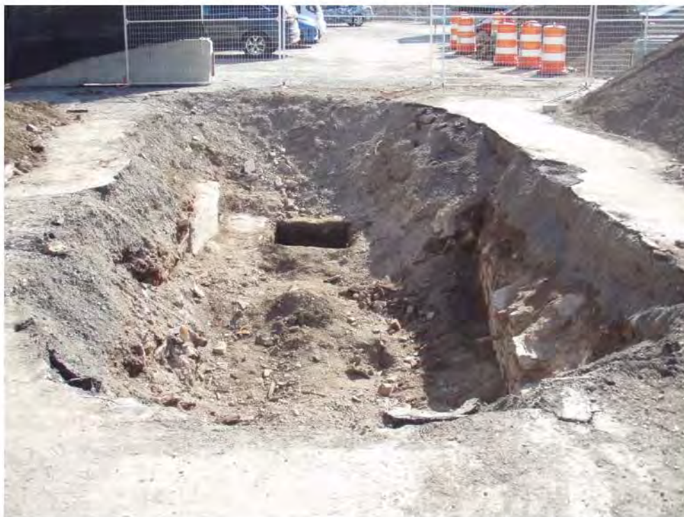
Photo 61. Vue d'ensemble vers le nord-est des sous-opérations IMM2123-1A, 2A et 2B (IMM2123-23-NUM1-46)
