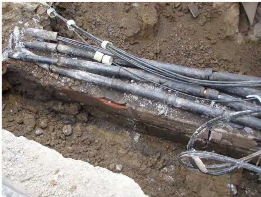
Photo 20. Vue du massif en terre cuite (34A12) avant sa démolition. Vue vers le sud-est (BiFj-37-2023-NUM3-83)
