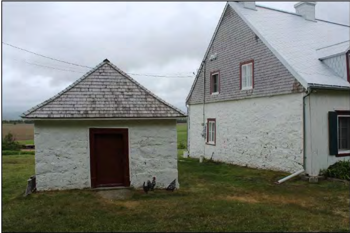
Photo 18 : Laiterie Casault, située à l'est de la maison. Opération 5. Vue vers le sud. (TE-1053-122)
