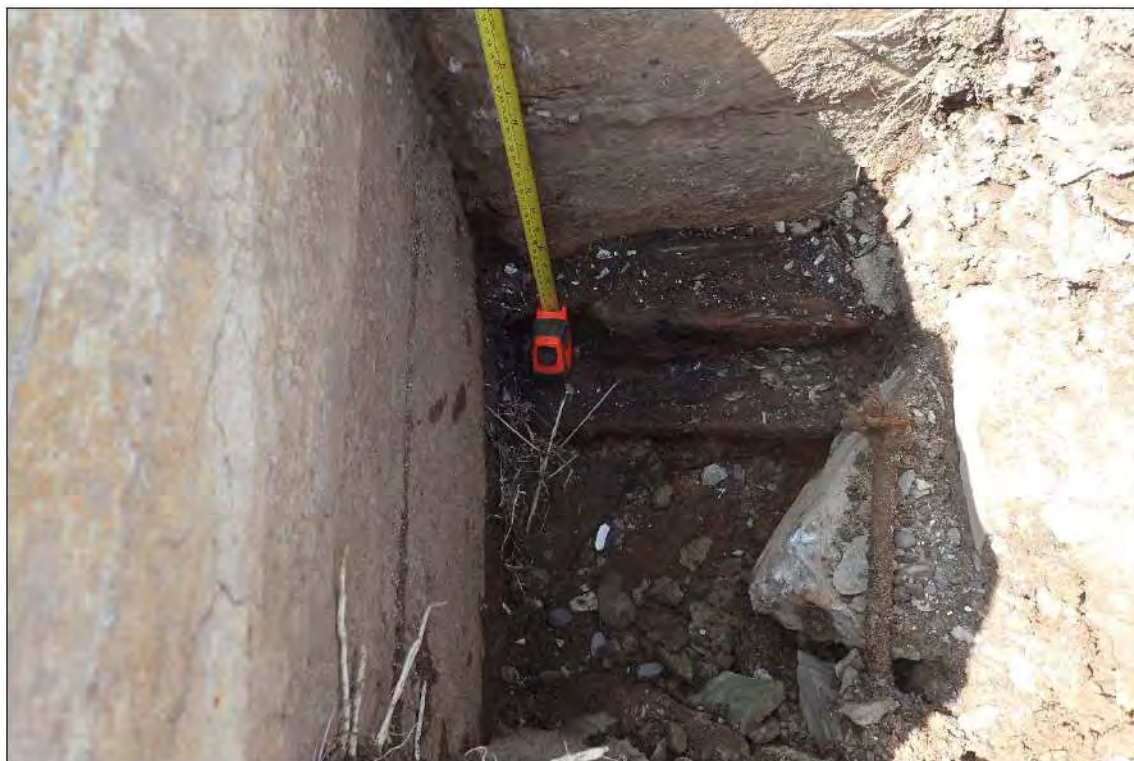
Figure 29. Bois au fond du sondage 4A87, vers le nord (photo P5240118).
