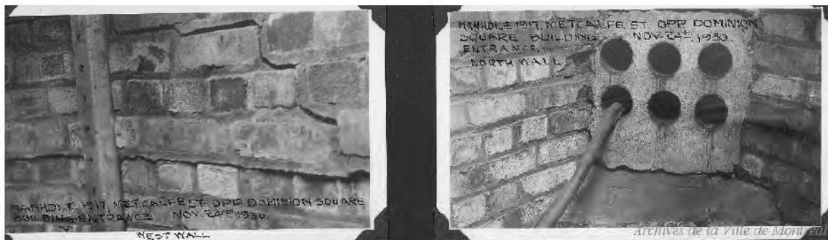
Figure 22. Photos de l'intérieur d'un puits d'accès en brique de la rue Metcalfe en face du square Dominion, prises le 24 novembre 1930 (AVM CA M001 VM098-Y-01-D03-P034)
