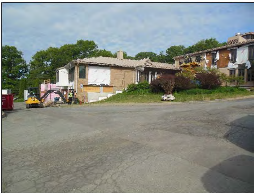
Figure 7. Vue des sous-opérations 1C et 1D avant excavations, vers le nord-ouest (photo 3002).
