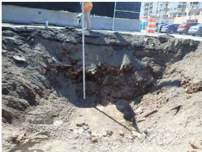
Photo 32. Vue vers l'ouest de la paroi ouest de la sous-opération CeEt-826-2B (CeEt-826-23-NUM2-1)
