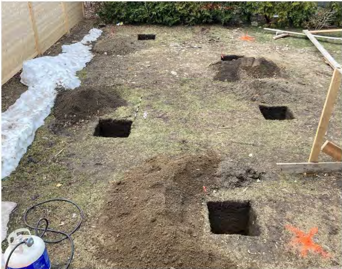
Photo 3. Sous-opération 1A à 1E, vue vers le nord (23-PATA-02_NUM1-4343).
