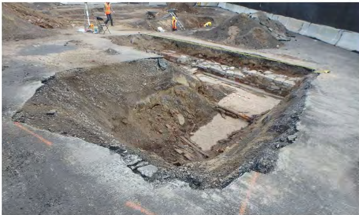
Photo 4. Vue d'ensemble vers le nord-ouest de la sous-opération CeEt-820-4B (CeEt-820-23-NUM1-30)
