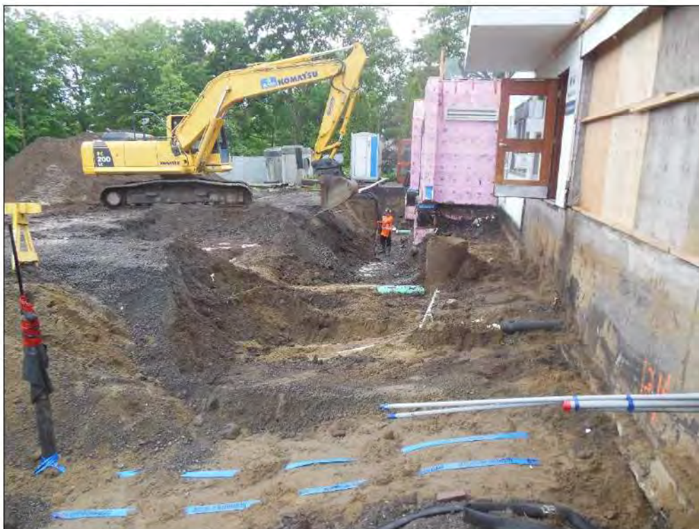
Figure 10. Les nombreuses infrastructures mises au jour dans la sous-opération 1E, vers l'ouest (photo 3068).
