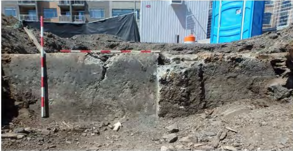
Photo 37. Vue vers le nord du parement sud du vestige CeEt-830-2A1 (CeEt-830-23-NUM2-162)
