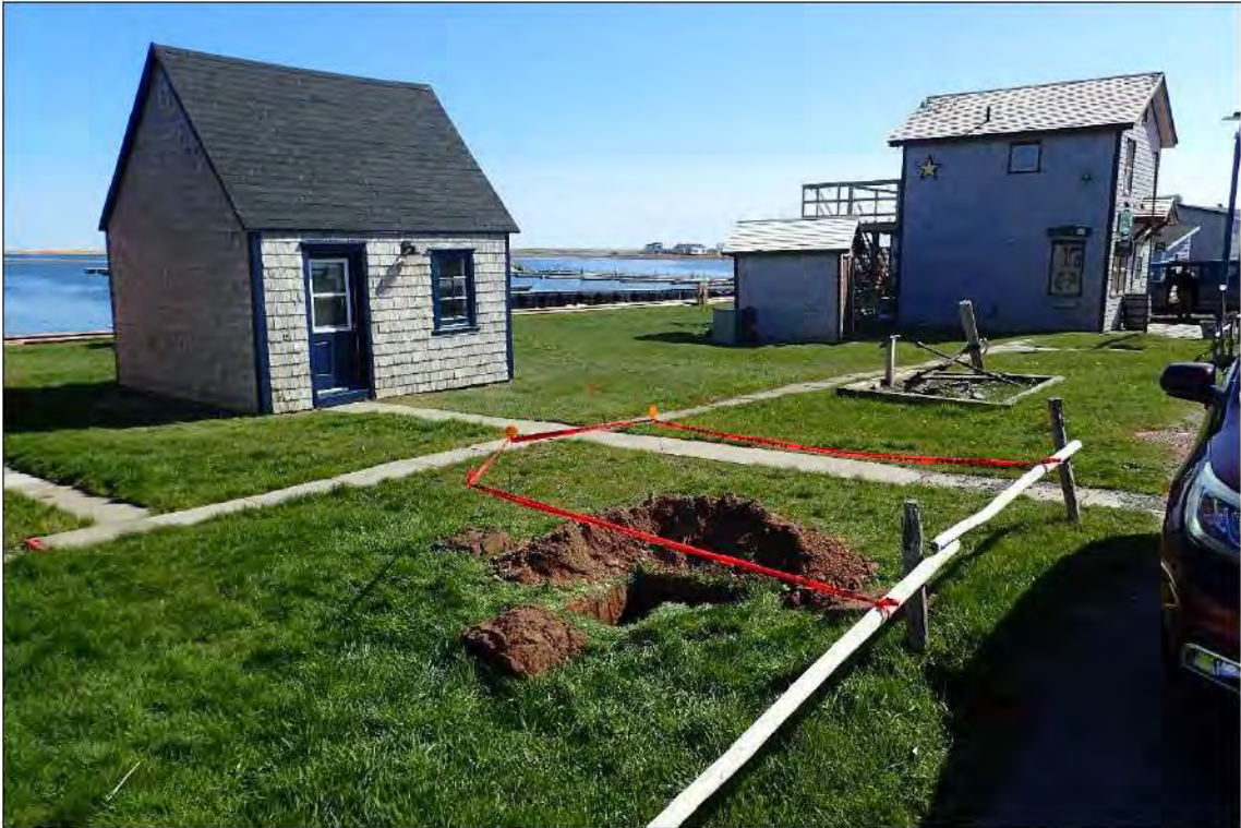
Figure 31. Localisation du sondage 4A348, vers le sud-ouest (photo P5230103).
