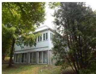
Maison Paul-Émile-Borduas. Vue arrière en angle
