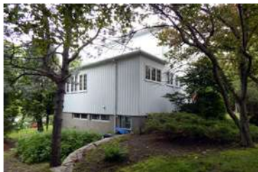
Maison Paul-Émile-Borduas. Vue d'angle
