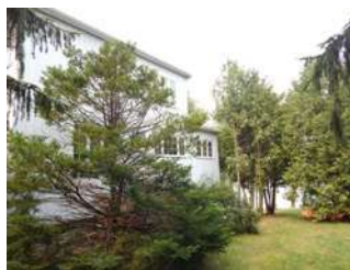
Maison Paul-Émile-Borduas. Vue d'angle
