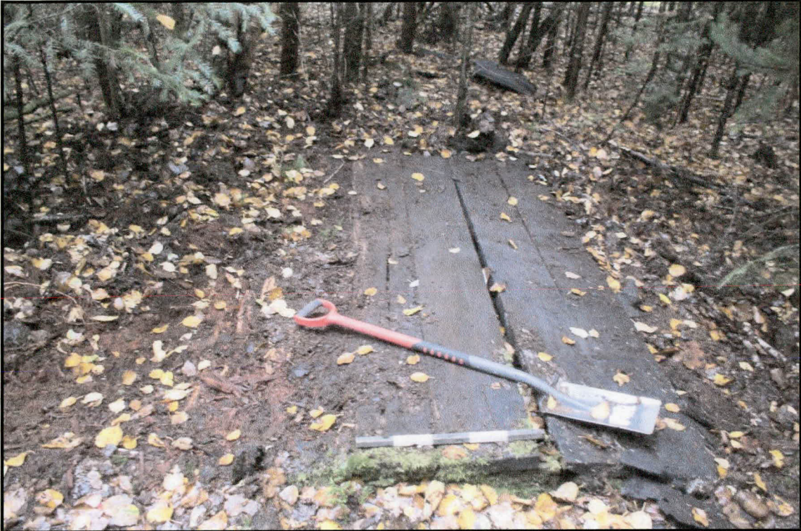
Photo 3 Secteur 2, plancher/mur (structure 2), chaînage 7+040, direction ouest
