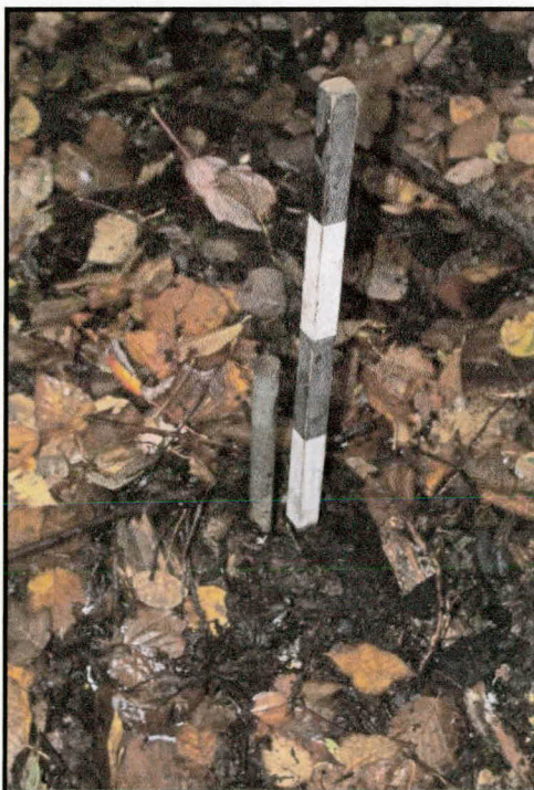
Photo 2 Secteur 2, tige de retour à la terre, chaînage 7+040, direction sud
