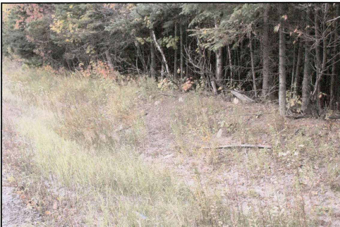
Photo 5 Secteur 2, remblai de la route 117, côté nord, entre les chaînages 6+840 et 7+100, direction ouest
