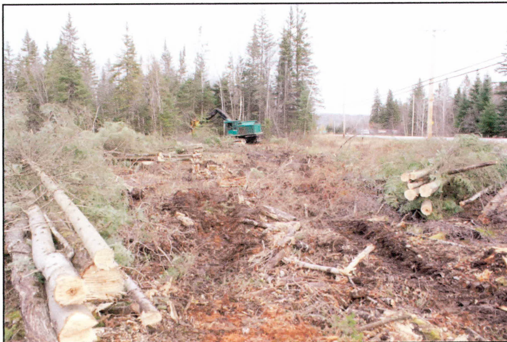
Photo 2 Projet 154-86-0721; travaux de déboisement, secteur 2 (montée de la route 321/Montée Bellerive), côté ouest, direction nord.
