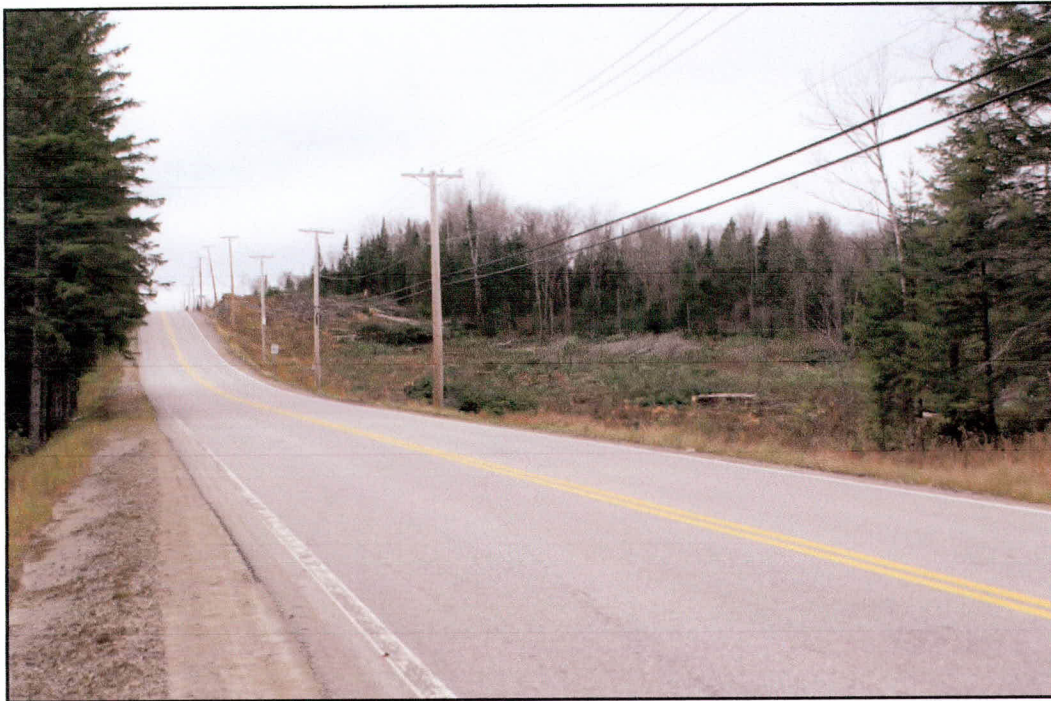
Photo 1 Projet 154-86-0721; travaux de déboisement, secteur 2 (montée de la route 321/Montée Bellerive), direction sud.
