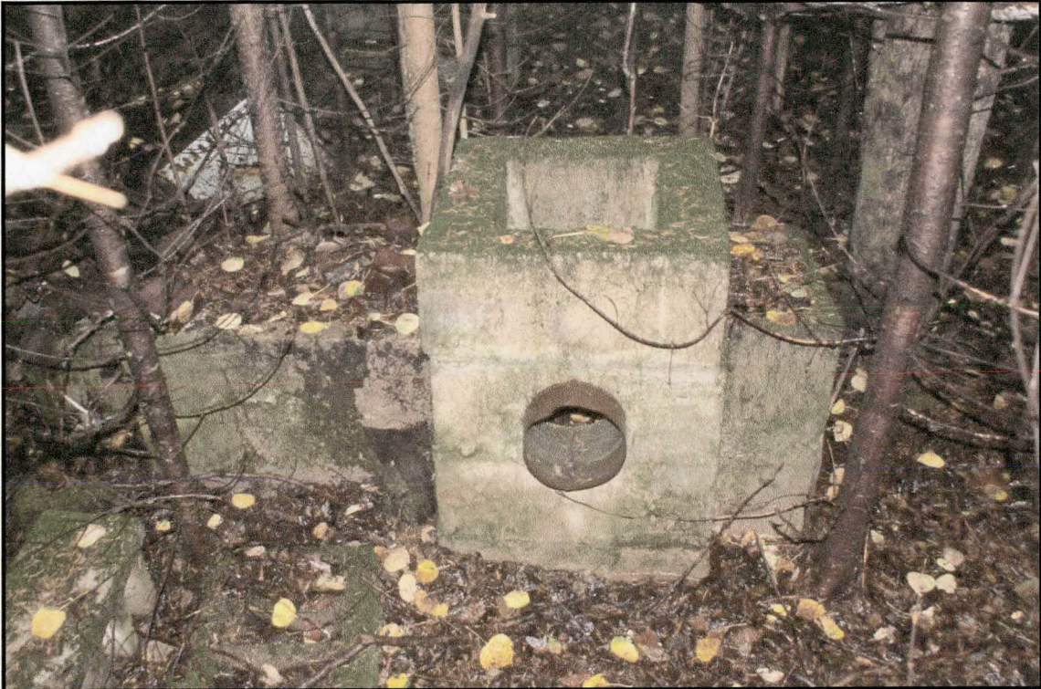
Photo 9 Secteur 9, structure 3, massif bétonné, base de cheminée, chaînage 4+920, direction est.
