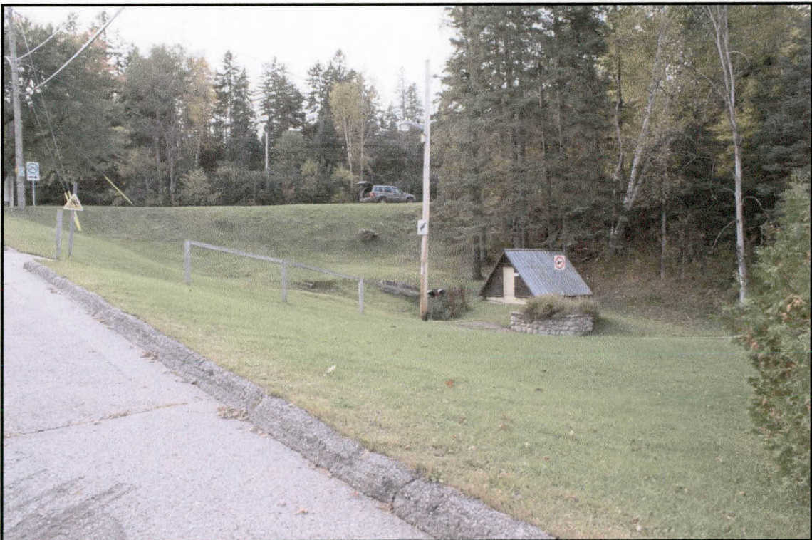
Photo 20 Secteur 4, partie sud/ouest de l'emprise, rue Marois (milieu), chaînage 1+100, direction nord
