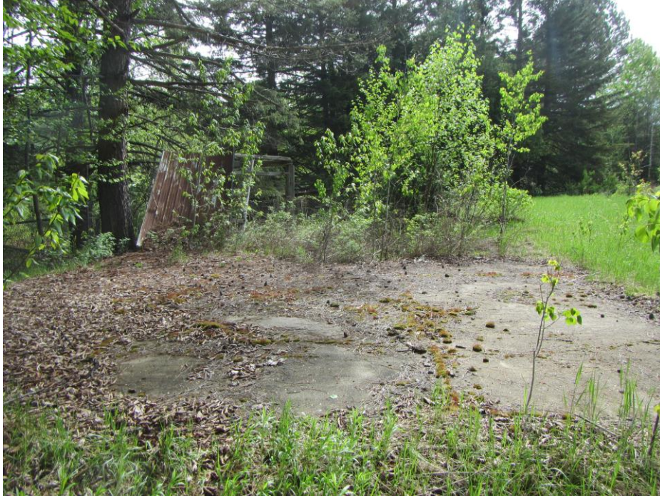
Photo 11 : Projet 3113-20-FA03, zone 4-3 - Vue rapprochée du plancher de ciment à la limite nord avec les vestiges d'une dépendance en bois avec toit de métal (22-AECO-01-EP-17)
