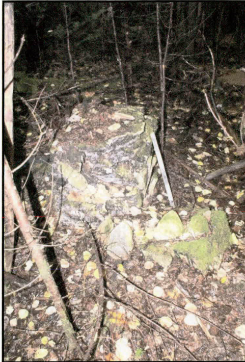
Photo 7 Secteur 3, structure 3, massif bétonné avec l'intérieur en pierre, chaînage 4+960, direction ouest
