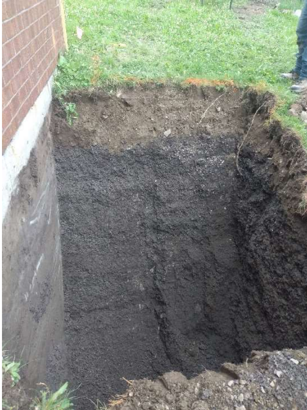
Photo 7. Paroi est de la sous-opération 1J à la fin de l'excavation, vue vers l'est (MTL23-04-05-1-NUM1-107).
