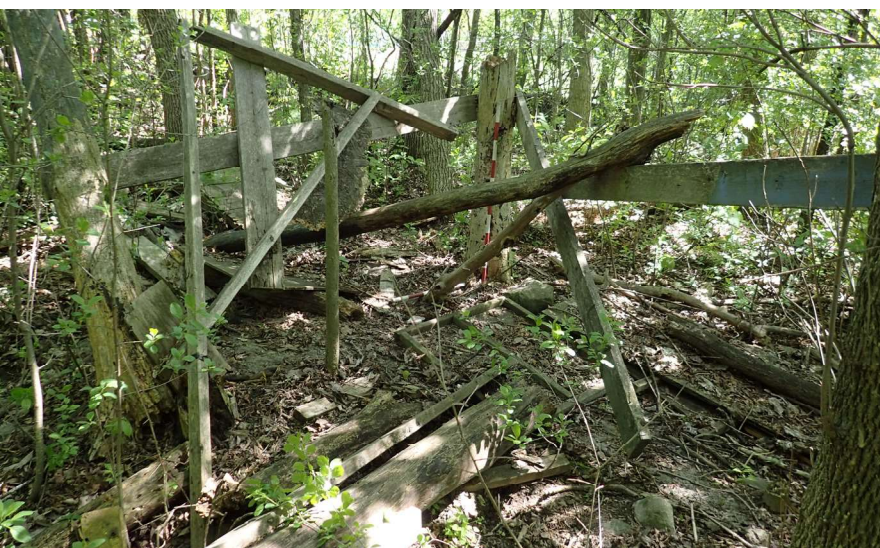
Photo 4.20 Parc Couvrette (LVL23-22), vue générale d'une cabane perchée abandonnée (photo PATR23N04_0131).
