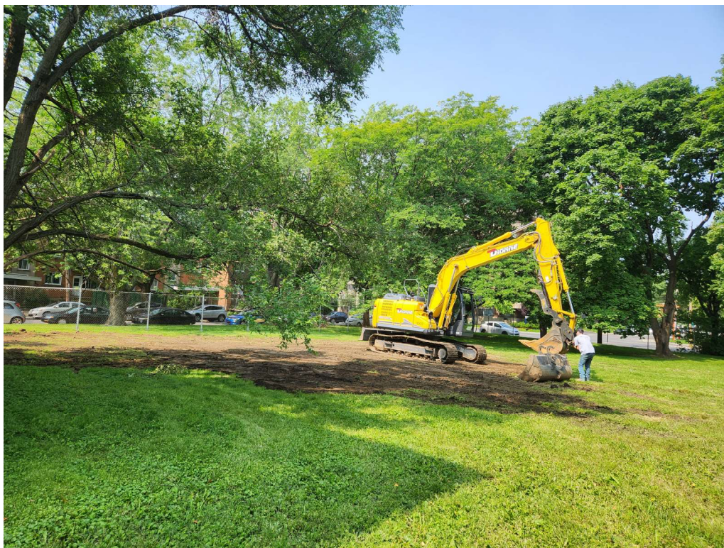
Photo 3.3 Sous-opération 1A, remblayage terminé, vue vers l'ouest HRI23_JF1_054, Archéotec 2023
