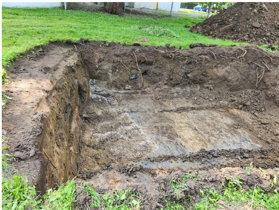
Photo 4.1 Sous-opération 1A à la fin de l'excavation HRI23_JF3_002, Archéotec 2023
