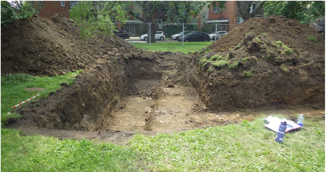
Photo 3.2 Sous-opération 1A, à la fin de l'intervention, vue vers le sud-ouest HRI23_JF2_2315, Archéotec 2023
