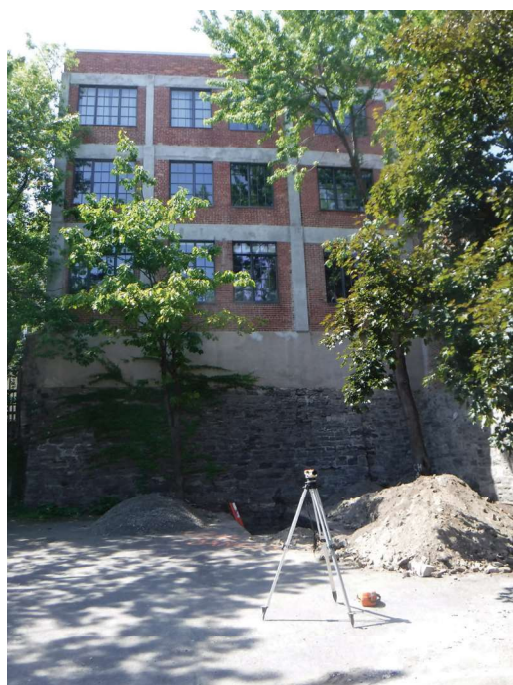
Photo 7 - Sous-opération 1C – Vue générale du mur de propriété en pierre et de l'entrepôt en brique et en ciment érigé entre 1920 et 1940 – Vue vers le nord (MTL23-25-02-N1-39)
