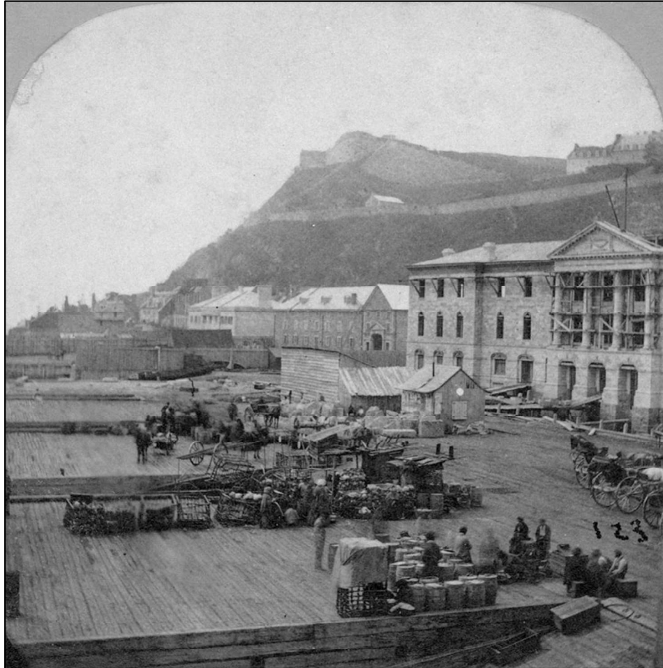
Figure 27. Photographie du marché Champlain possiblement prise à l'été 1858 vers la fin de sa construction. On peut constater l'aménagement des pontons/quais de bois qui s'allongent vers le fleuve Saint-Laurent en face du marché (Library and Archives Canada, Champlain Market Hall near completion. Lower town market place near dock. Citadel in upper background, ca. 1859, numéro de boîte 50187, pièce no 10, id 3222979, Barnum Photographe)
