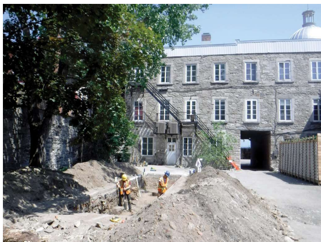
Photo 1 - Sous-opération 1A — Réalisation des relevés planimétriques — Vue vers le sud (MTL23-25-2-N1_41)
