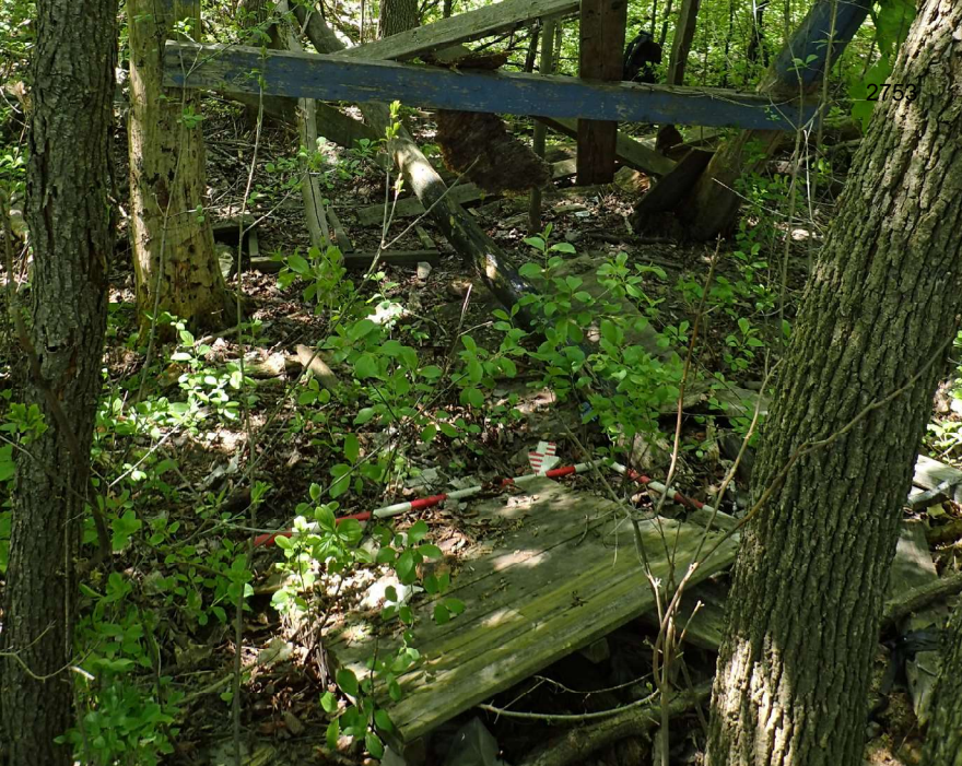
Photo 4.19 Parc Couvrette (LVL23-22), vue générale d'une cabane perchée abandonnée (photo PATR23N04_0135).
