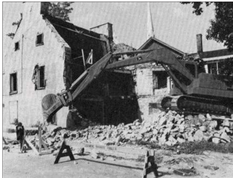
Figure 4.9 : Démolition de la rallonge arrière de la Maison-Rollin Brais (photo Pierre Duquet, Renaud et Kirjan 1977).
