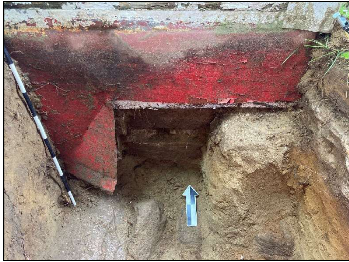
Photo 9. Sous-opération 2D, paroi nord. Aperçu du recouvrement de tôle peinte en rouge recouvrant l'extérieur des murs de fondation (Photo 23-PATA-08-NUM1-4823).
