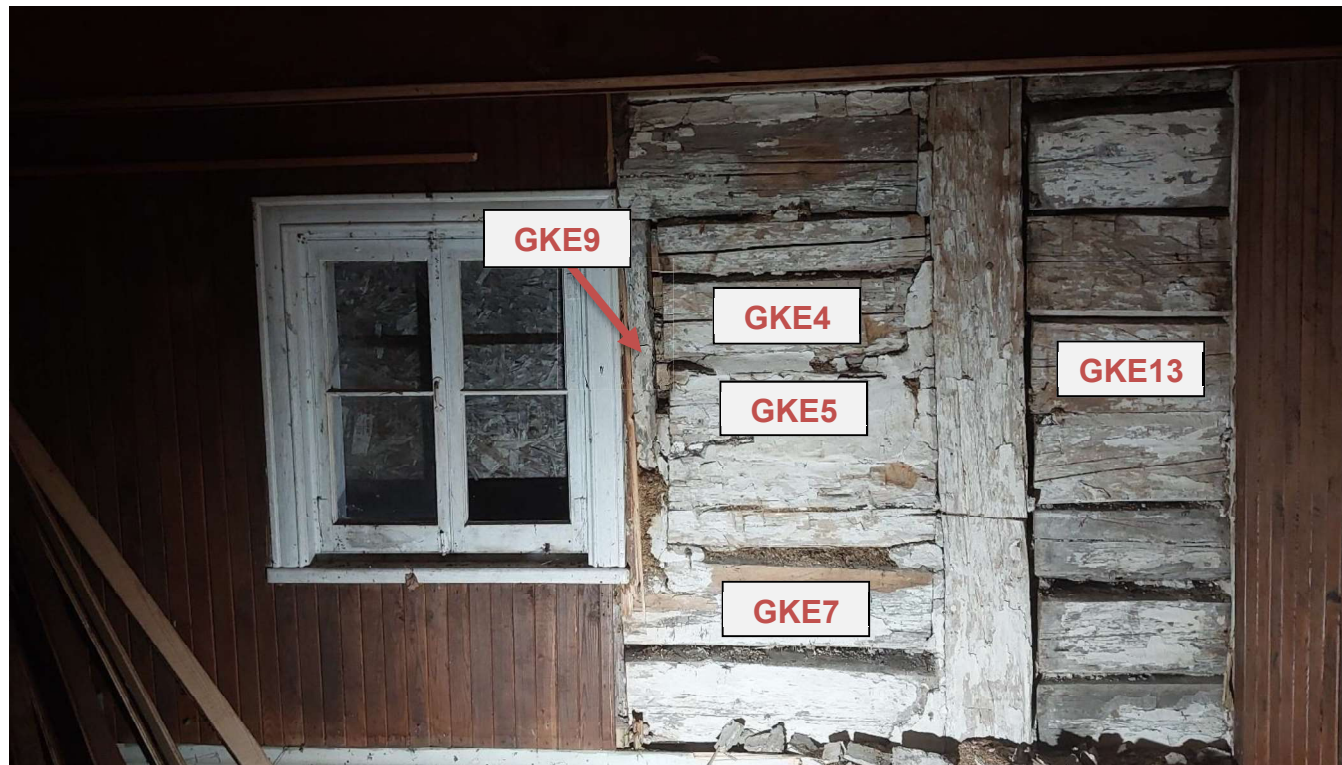
Figure 7. Maison Gaffney-Kennedy. Localisation des pièces prélevées sur le mur intérieur ouest.
