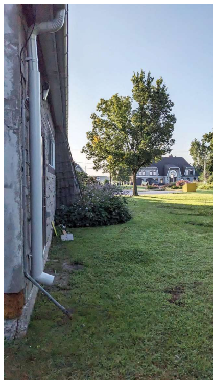
Photo 3 - Le côté ouest du bâtiment, avant le début des travaux dans la sous-opération 30A – Vue vers le sud-est (LVL-23-10-N1-012)
