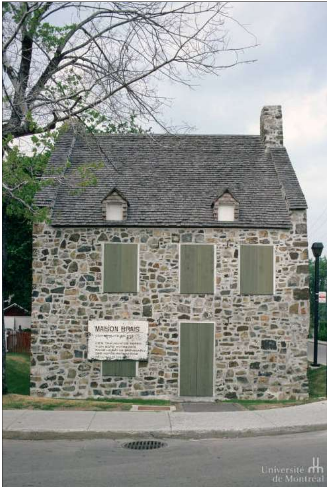
Figure 4.10 : La Maison Rollin-Brais durant les travaux de restauration. Photographie de Pierre-Richard Bisson, 22 juillet 1979. PB28014, Don de la succession Pierre-Richard Bisson. Collection Images d'aménagement © 2004 Direction des bibliothèques, Université de Montréal.
