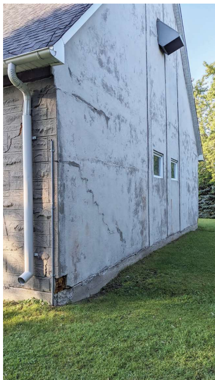
Photo 2 - La façade arrière du bâtiment, avant le début des travaux dans la sous-opération 30B – Vue vers le sud-ouest (LVL-23-10-N1-008)
