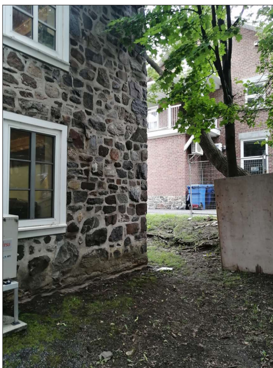
Figure 6.5 : Vue générale du coin de la maison Rollin-Brais pointant vers le nord géographique et partie du mur nord-est. Vue vers l'ouest. BjFj-6-2023-N1-09.
