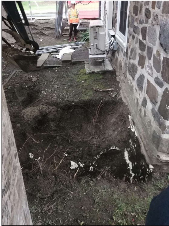
Figure 6.6 : Vue générale de la sous-opération 3B et du polyuréthane contre le mur de fondation. Vue vers le sud-est. BjFj-6-2023-N1-19.
