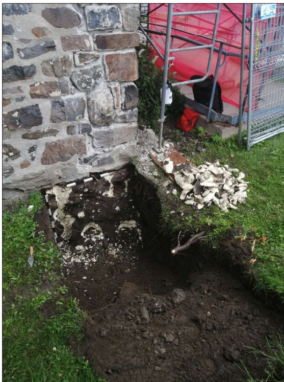
Figure 6.2 : Fondation du mur nord-ouest de la Maison Rollin-Brais, couvert de polyuréthane. Vue vers le sud-est. BjFj-6-2023-N1-18.
