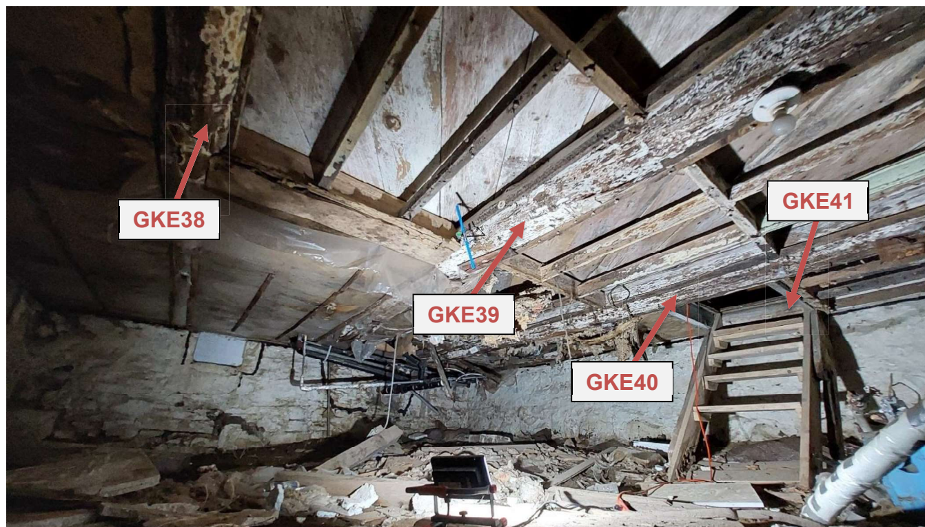
Figure 6. Maison Gaffney-Kennedy. Localisation et identification des poutres soutenant le rez-de-chaussée.
