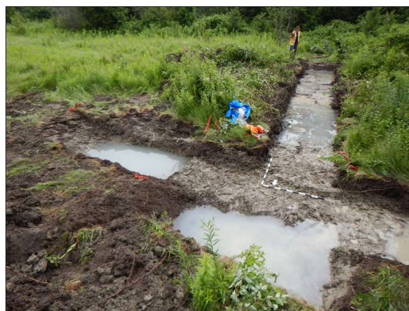
Figure 66 : Vue générale de la sous-opération 2G. Vers le sud, DbEr-1-23-N1-064
