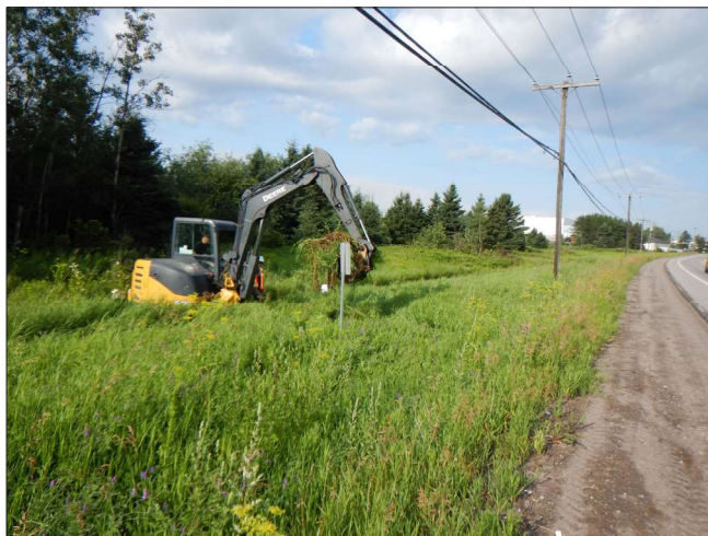
Figure 41 : Localisation de la sous-opération 2A, en début d'excavation. Vers le sud-ouest, DbEr-1-23-N1-004
