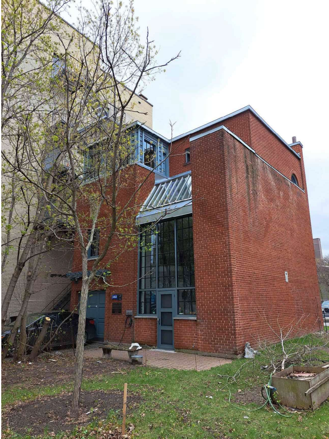
Photo 1. Studio Ernest-Cormier, vue vers le sud-ouest. (Photo L. Bolduc)
