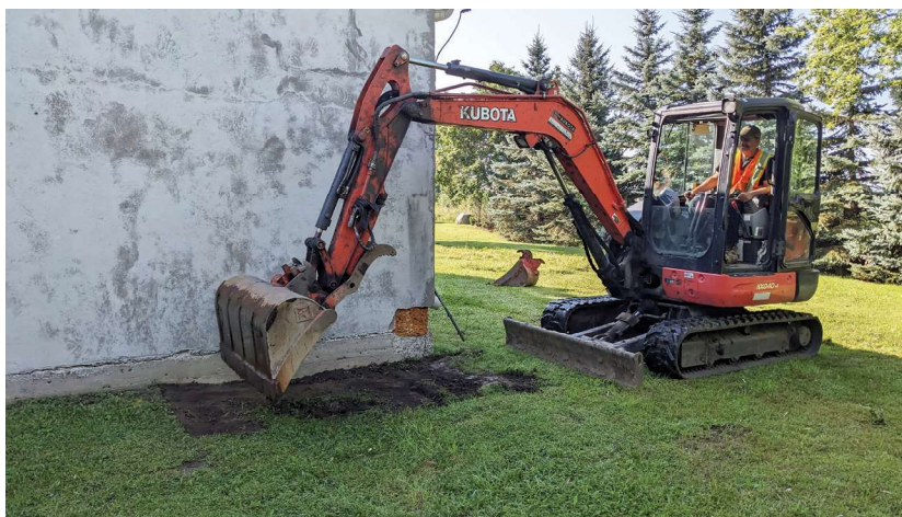
Photo 4 - Le début des travaux d'excavation dans la sous-opération 30A – Vue vers le sud (LVL-23-10-N1-014)
