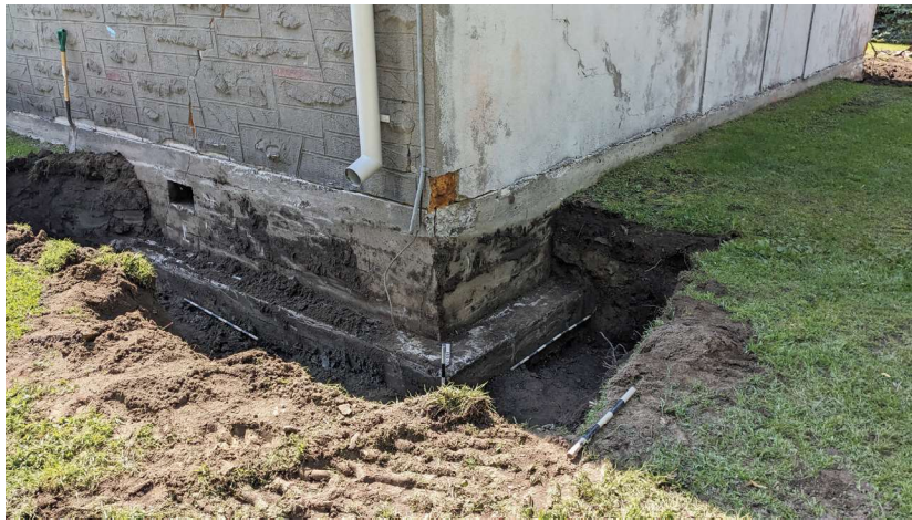
Photo 6 - Le coin de la fondation dégagé au niveau de la sous-opération 30B. Vue vers le sud (LVL-23-10-N1-045)
