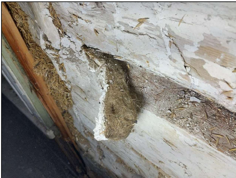
Figure 4. Maison Gaffney-Kennedy, mur ouest. Détail des matières assurant le jointage et le revêtement intérieur des madriers: filasse de lin (avant-plan), joints de mortier de chaux et surface des madriers blanchie à la chaux. On aperçoit à l'arrière-plan des enveloppes d'avoine, témoignant de l'entreposage de céréales à l'étage.
