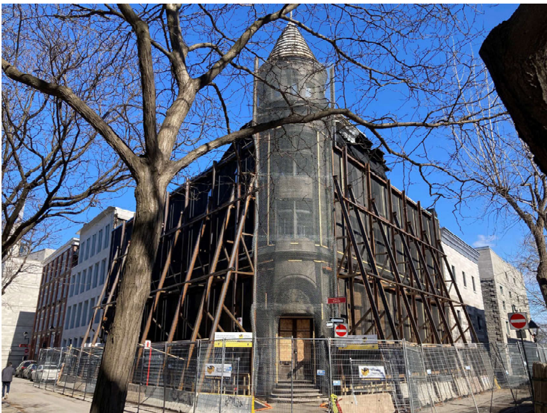
2. Vue du coin de l'édifice.
