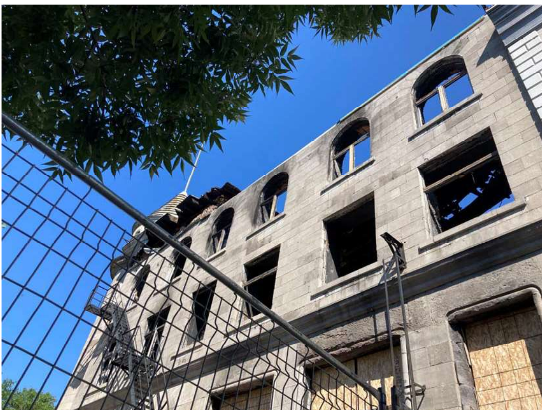
3. Vue du haut du mur côté rue du Port. On y voit une seule ouverture sans fenêtre et la section de membrane installée.
