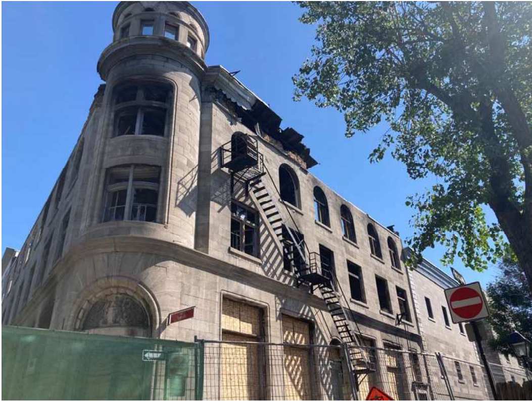
1. Vue de la façade côté rue du Port. On voit une petite section de membrane installée sur le dessus du mur à l'extrémité sud.
