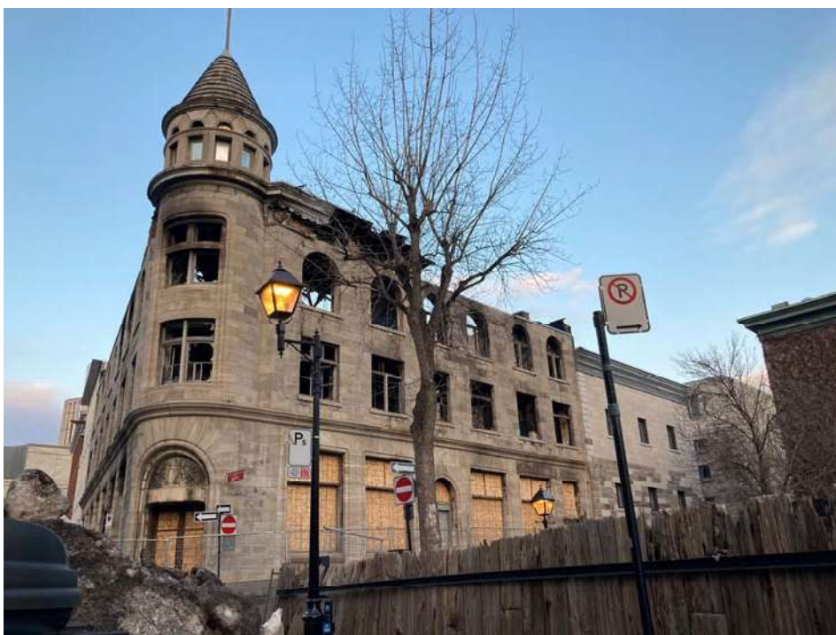
3. Vue de la façade côté rue du Port.
