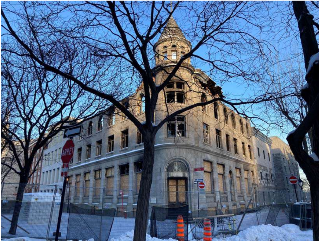
2. Vue du coin de l'édifice.
