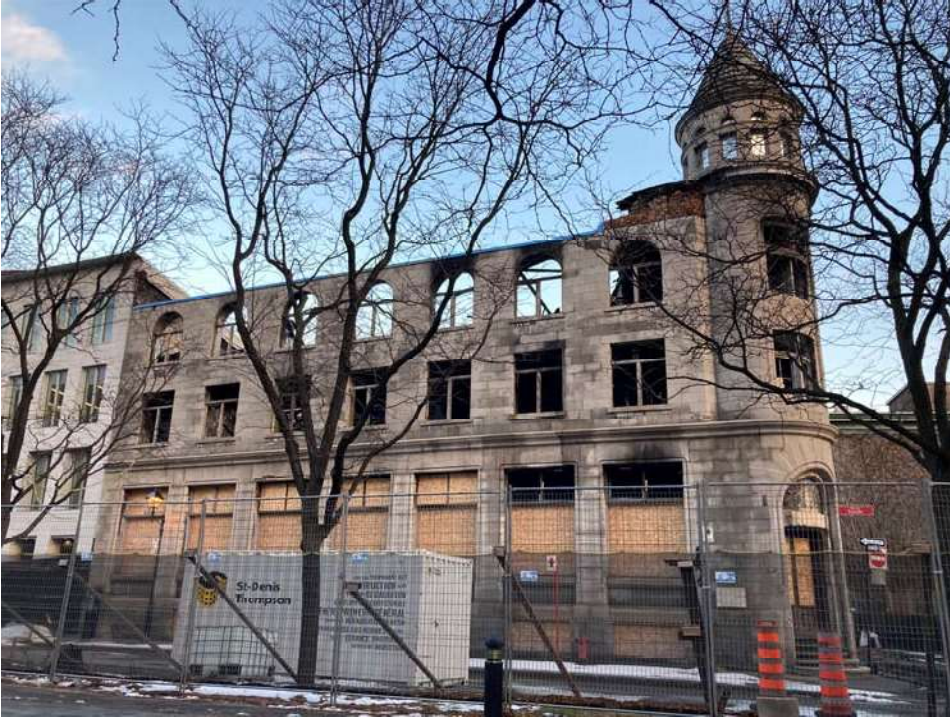
1. Vue de la façade côté Place D'Youville. On voit le conteneur de l'entrepreneur.
