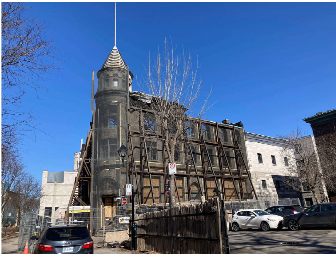
1. Vue de la façade côté rue du Port
