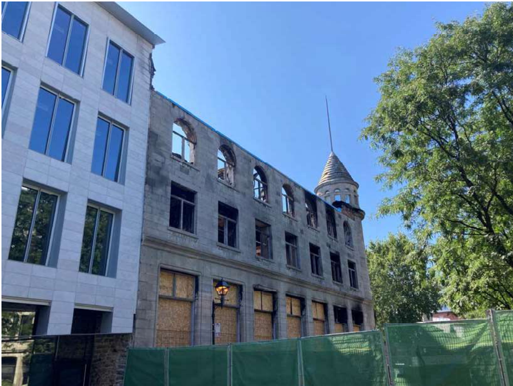
2. Vue de la façade du côté de la Place D'Youville. Presque toute la surface du dessus du mur a été recouverte de la membrane.
