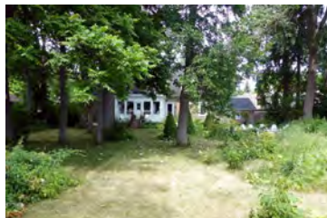
Maison de Beaufort. Vue générale arrière
