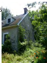
Maison de Beaufort. Vue latérale
