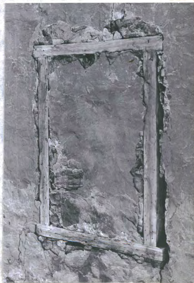
Pignon Ouest I.B.C.77.2089.I3 A ( 35)
