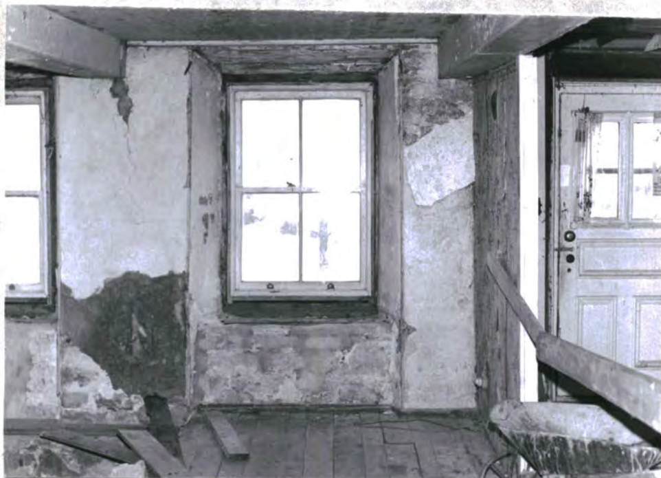
Intérieur côté sud Photo I.B.C. 77.2089.25A ( 35 )
