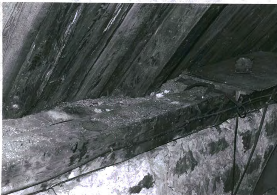
Sablière côté sud Photo I.B.C. 77.2088.17A.
