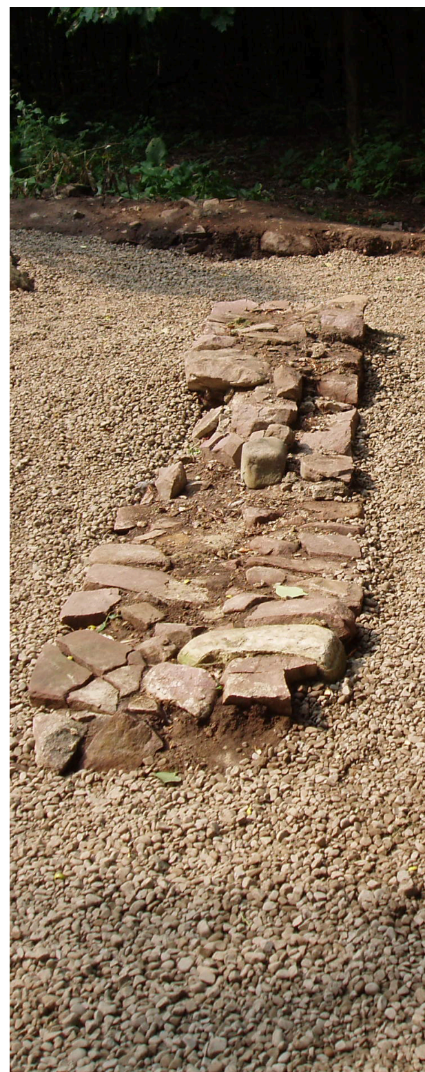
Le mur nord en 2007 (vue vers l'ouest)
