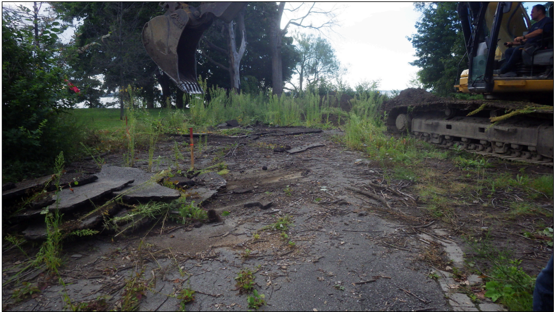
Photo 4.1 Sous-opération 1A, état des lieux avant l'excavation, vue vers sud Archéotec 2023, PCS23_PV1_008
