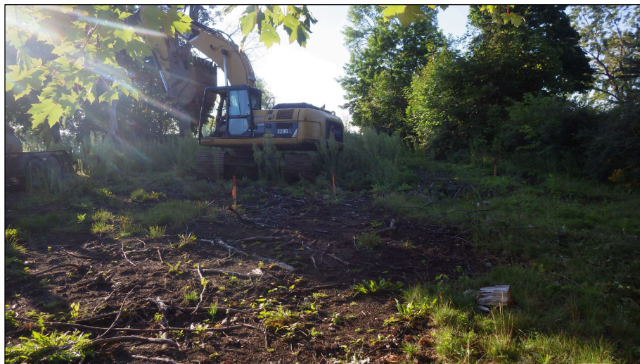
Photo 4.5 Sous-opération 1B, état des lieux avant l'excavation, vue vers le sud Archéotec 2023, PCS23_PV1_002
