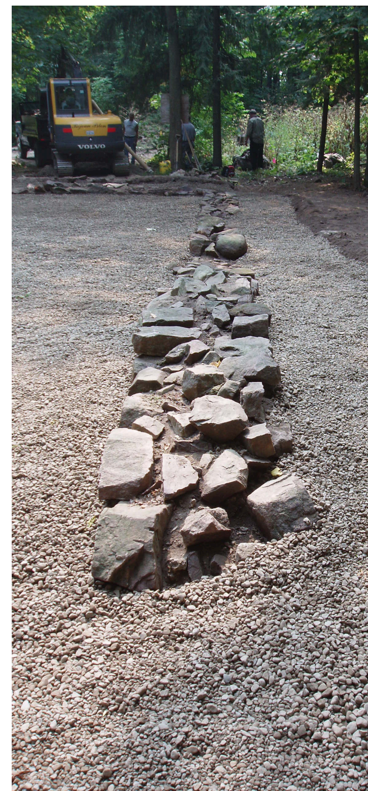
Le mur ouest en 2007 (vue vers le sud)
