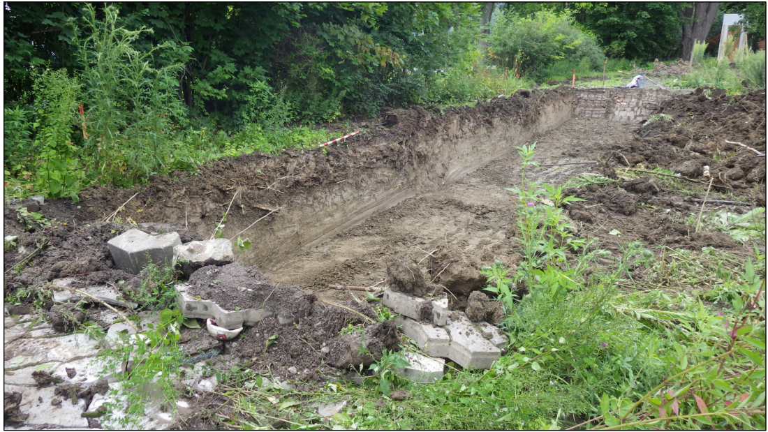
Photo 4.7 Sous-opération 1B, fin de l'excavation, vue vers le nord-ouest Archéotec 2023, PCS23_PV1_017
