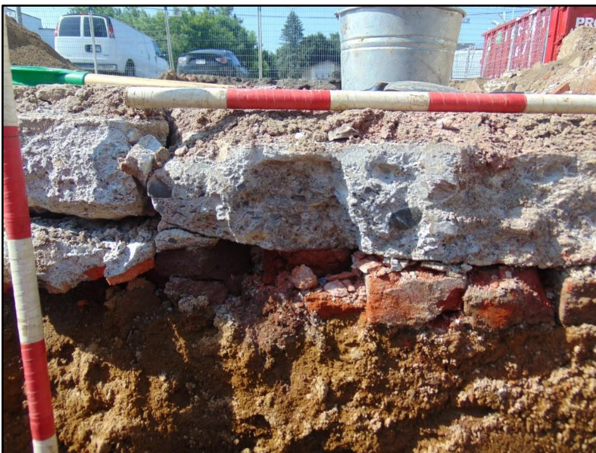
Figure 29 : Assise en briques sous le plancher en béton de l'académie Saint-Michel.
