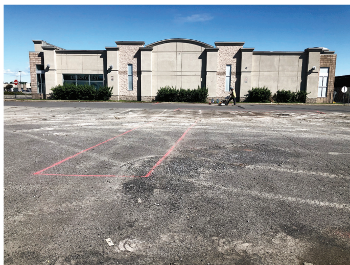
Photo 1 - Sous-opération BiFl-12-6C — Marquage au sol de la sous-opération 6C, avant le sciage de l'asphalte et l'excavation mécanique — Vue vers le nord (BiFl-12-23-N1-002)
