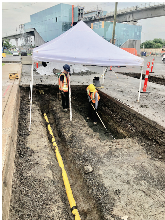
Photo 4 - Sous-opération BiFl-12-6B — Conduite de gaz et paroi nord de la tranchée 6A, gare du REM en arrière-plan — Vue vers l'est (BiFl-12-23-N1-039)
