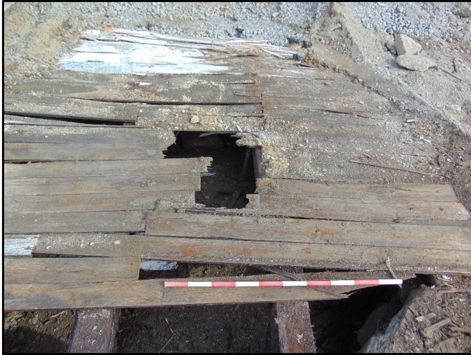
Figure 50 : Poutres soutenant les planches du coffrage de la dalle de béton, en avant-plan.
