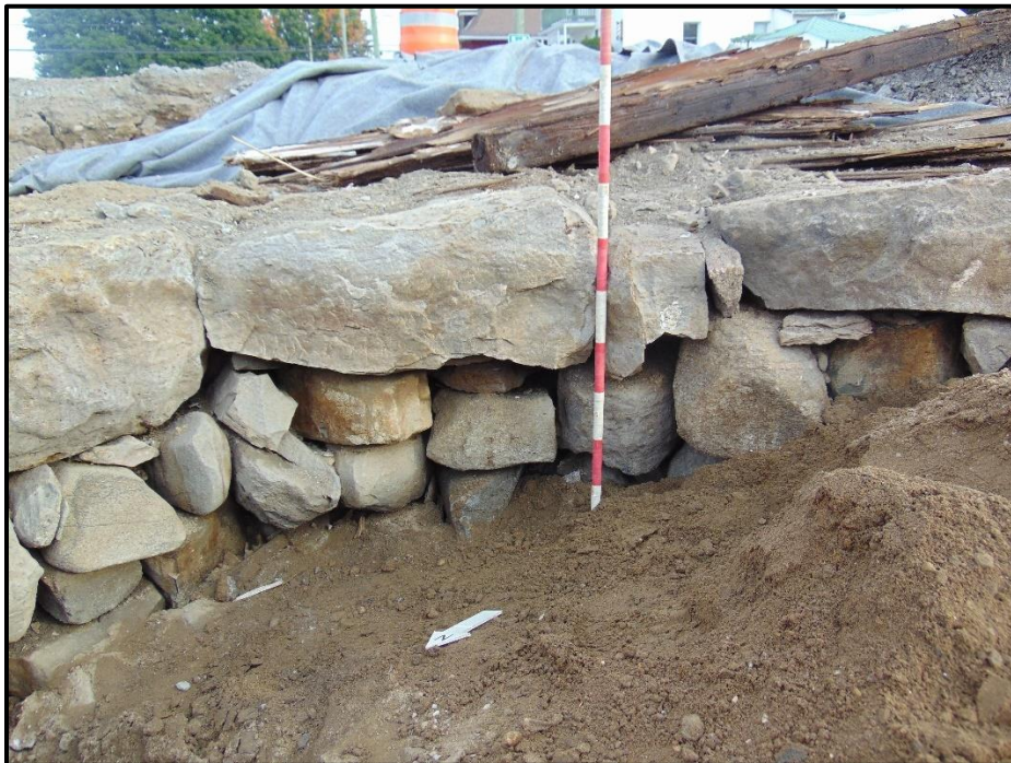
Figure 54 : structure conique (ST-12) sous les planches du coffrage.
