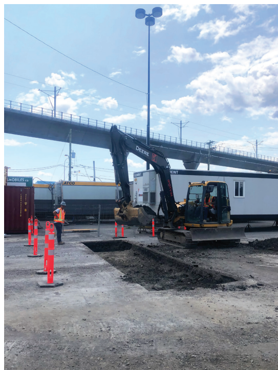
Photo 11 - Sous-opération BiFl-12-6C — Remblaiement de la tranchée 6C ; section aérienne du REM de l'Ouest (BiFl-12-23-N1-023)
