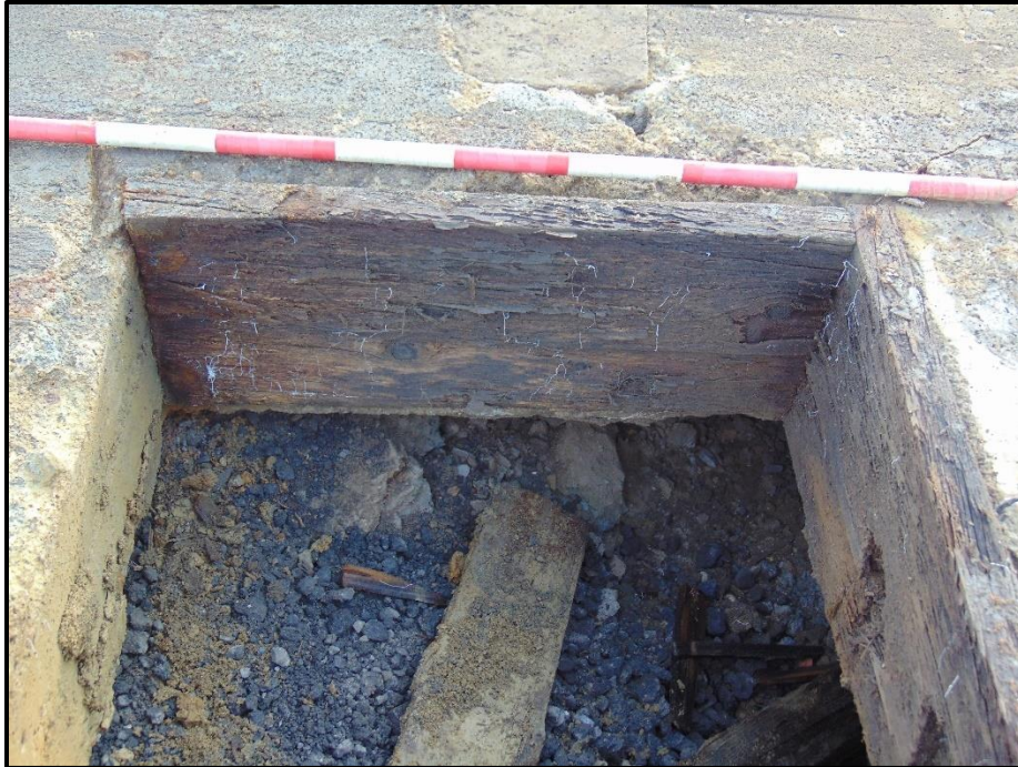
Figure 46 : Cadre de bois servant de coffrage au trou carré de la dalle et de support au couvercle de métal. Cette photo a été prise après que la dalle a été basculée.
