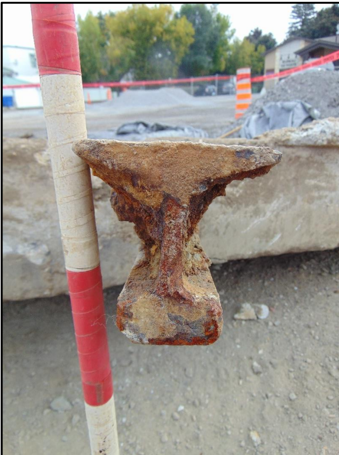
Figure 45 : Plan rapproché sur le rail de chemin de fer qui jaillit de la dalle de béton.
