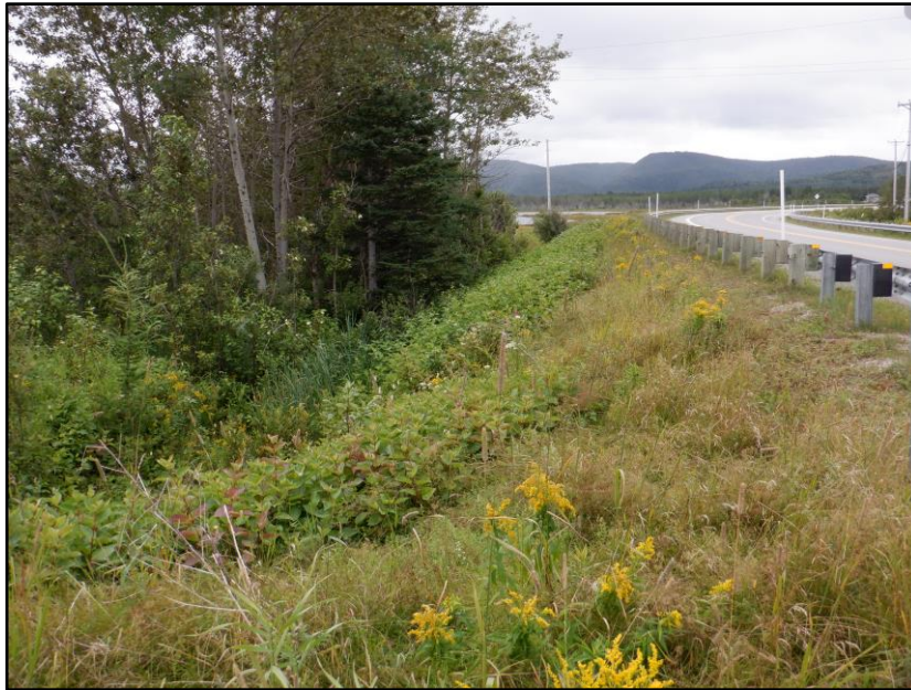
Figure 16 : Vue générale des aménagements (talus et fossé) en bordure de la route 132 du côté sud. Zone d'exclusion. (cliché 154-10-0479_007)
