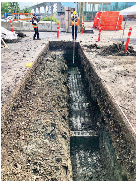
Photo 10 - Sous-opération BiFl-12-6B — Base de la tranchée exploratoire 6B montrant la dalle de béton et l'amorce de mur composée de parpaings de béton alvéolés — Vue vers l'est (BiFl-12-23-N1-049)
