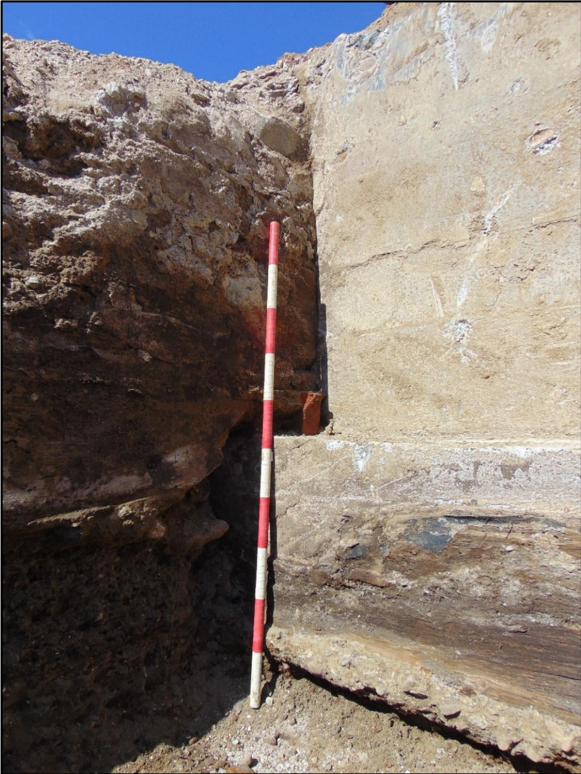
Figure 40 : Paroi ouest de A11. Mur de ST-11 et les lots sous-jacents.
