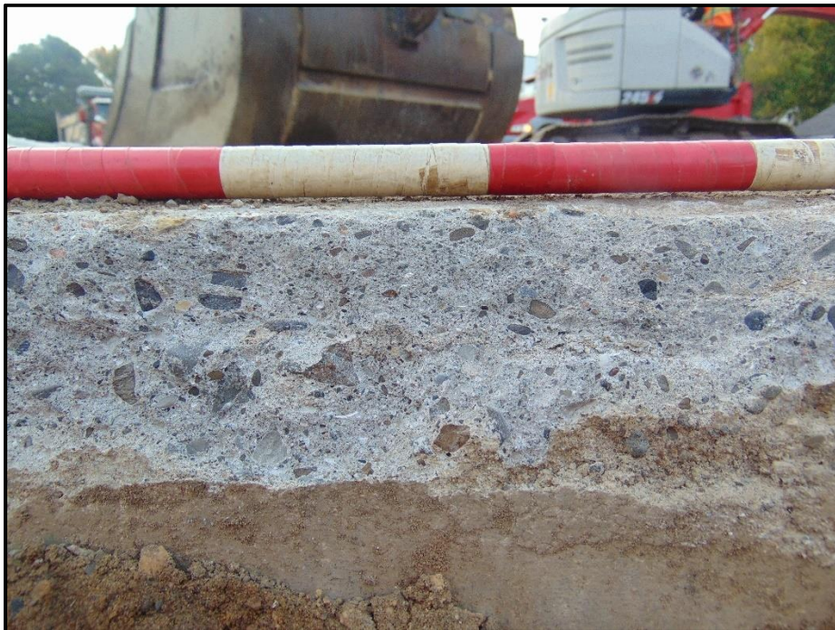
Figure 43 : Composition du béton composant la dalle de béton de la structure 12.
