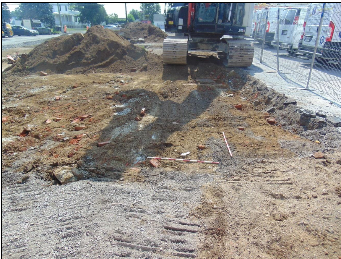
Figure 33 : Excavation de la tranchée 10C. On observe la couche supérieure, composée de sable brun foncé. On voit également la clôture de chantier (à droite) qui sépare les opérations 10 et 11.
