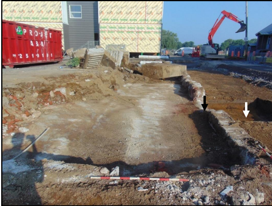
Figure 27 : Opération 10A à l'arrivée de l'archéologue. La structure 2 était parfaitement dégagée. La flèche blanche indique l'emplacement du petit escalier en béton observé par l'opérateur de la pelle. La flèche noire montre l'emplacement présumé de la porte.
